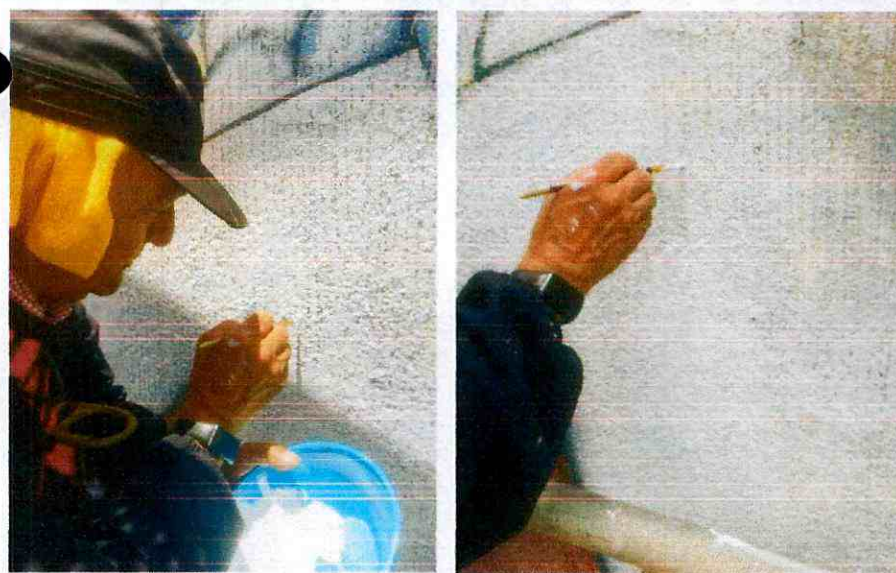
Fotografía 26, 27, 28, 29, 30 y 31 Relleno de grietas y fisuras.
