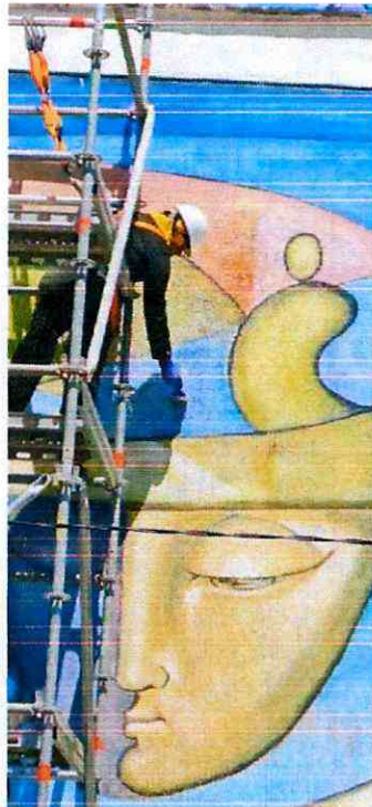
Fotografía 5, 6, 7, 8, 9, 10 y 11 Proceso de limpieza superficial en seco y eliminación de manchas
