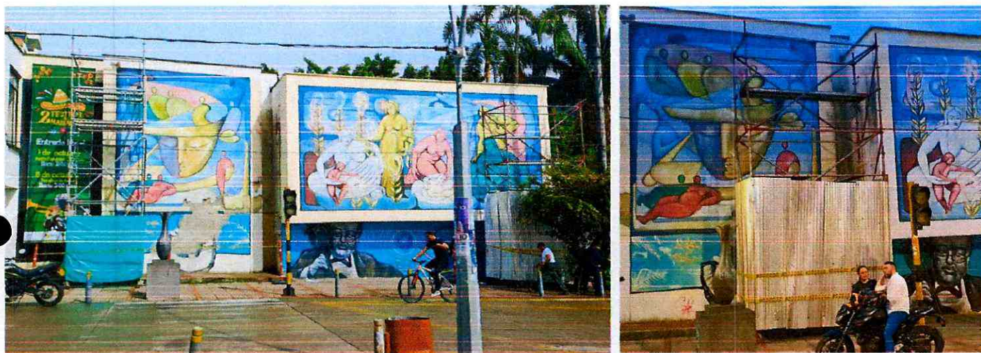
Fotografía, 1 y 2 Proceso de armado e instalación de andamio certificado
