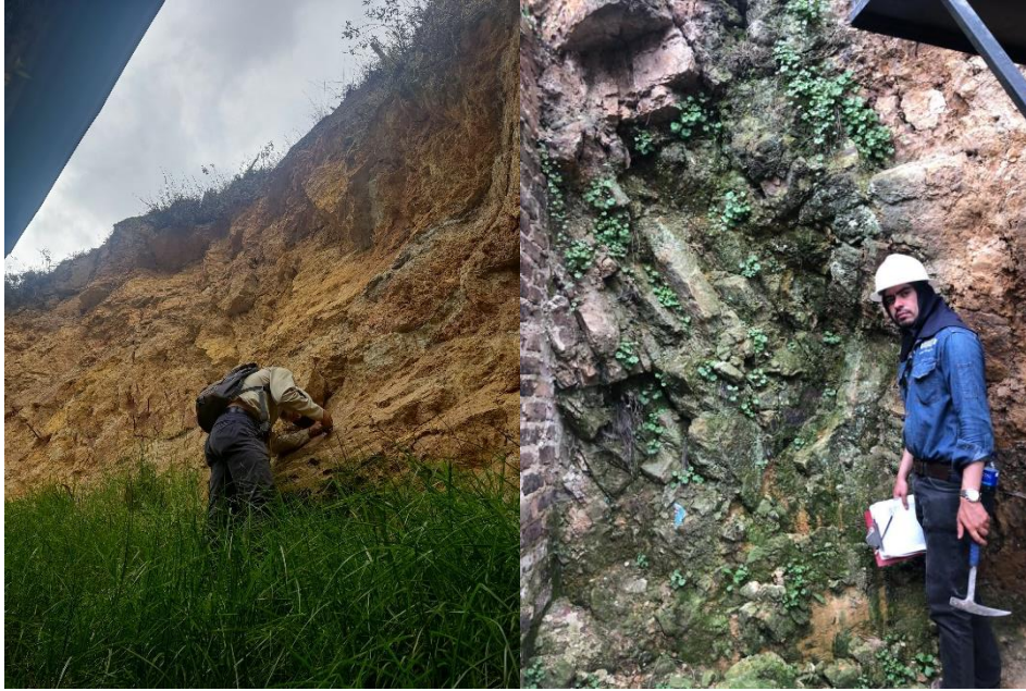
Fotografías 7 y 8. A la izquierda, exploración y reconocimiento de zona donde se presentó caída de bloques, a la derecha, pie del talud que presenta humedad media.
