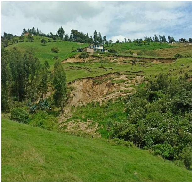
Fotografía 7 y 8. Deslizamiento sobre la vía, por el corte del talud.
