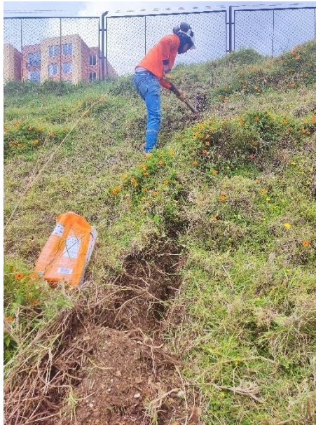
Fotografías 5, 6, 7, 8, 9 . Registro fotográfico de pruebas de exploración del macizo rocoso utilizando equipo por el método de percusión en el área del proyecto y visualización de perfil rocoso.
