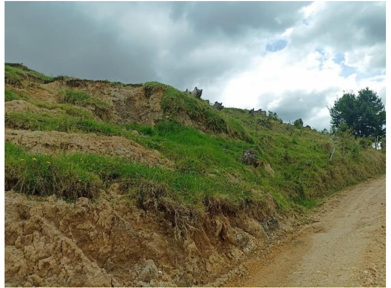
Fotografía 7 y 8. Deslizamiento sobre la vía, por el corte del talud.
