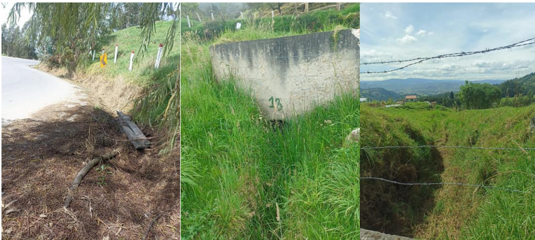
Fotografía 1, 2 y 3. Cunetas de la vía que conecta los municipios de Duitama y Charalá.
