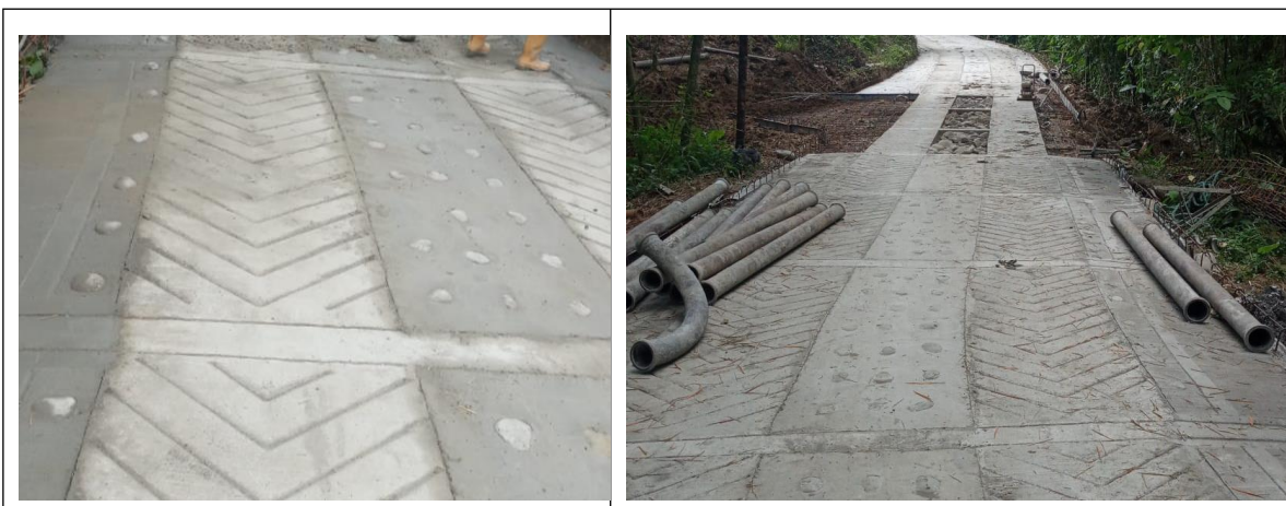
Ilustración No.3 Recorrido de obra.
