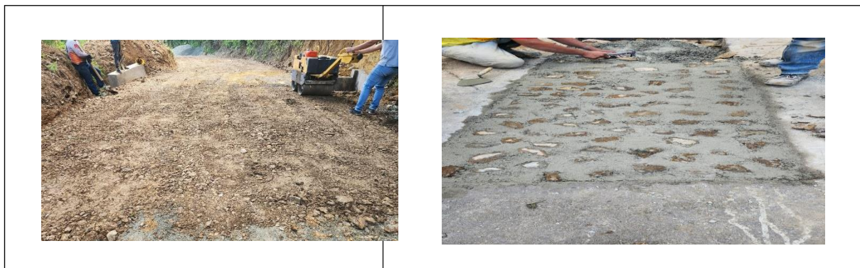
Ilustración No.9 recorrido de obra.
