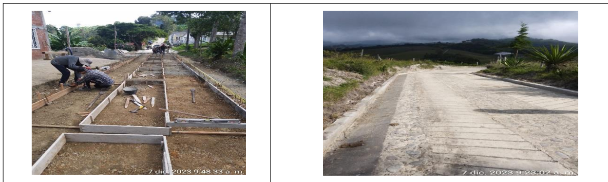
Ilustración No.6 Recorrido de obra.
