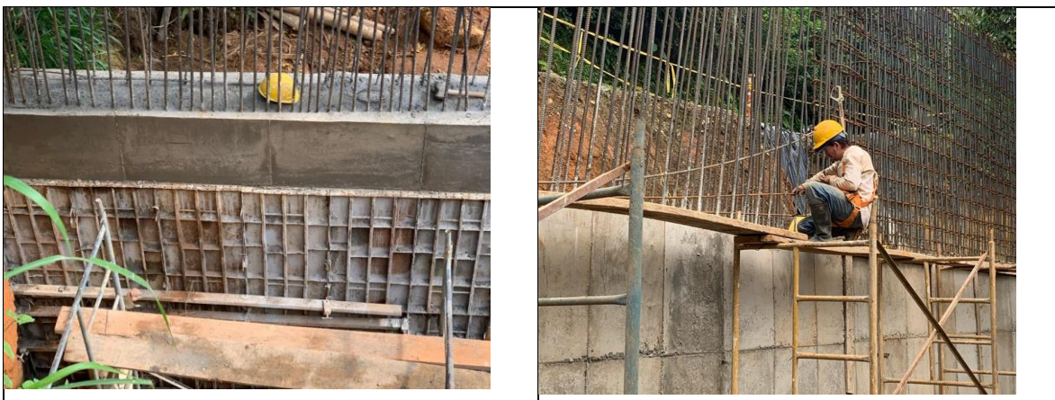
Ilustración No.1 Recorrido de obra en Caicedonia
