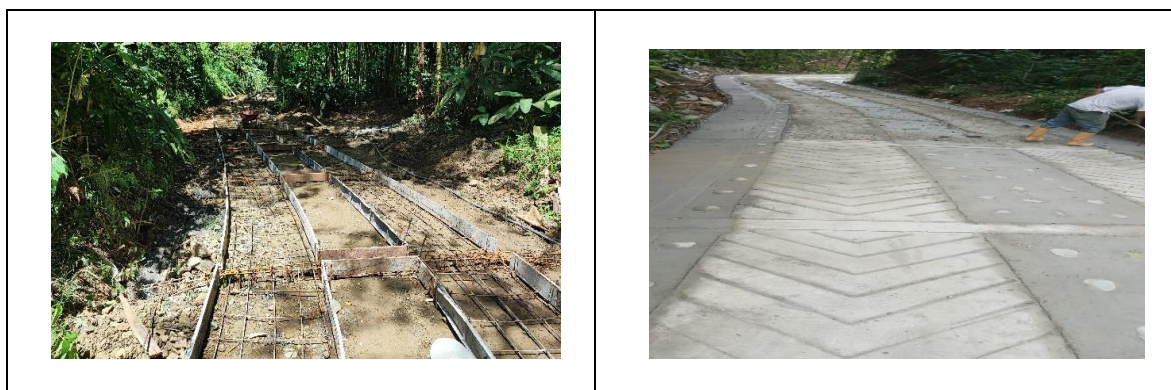
Ilustración No. 2 Recorrido de obra en La Unión
