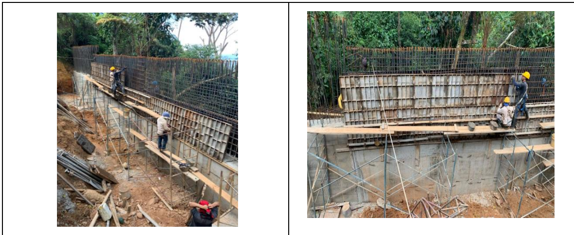
Ilustración No. 1 Recorrido de obra en Caicedonia
