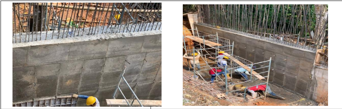
Ilustración No.2 Recorrido de obra
