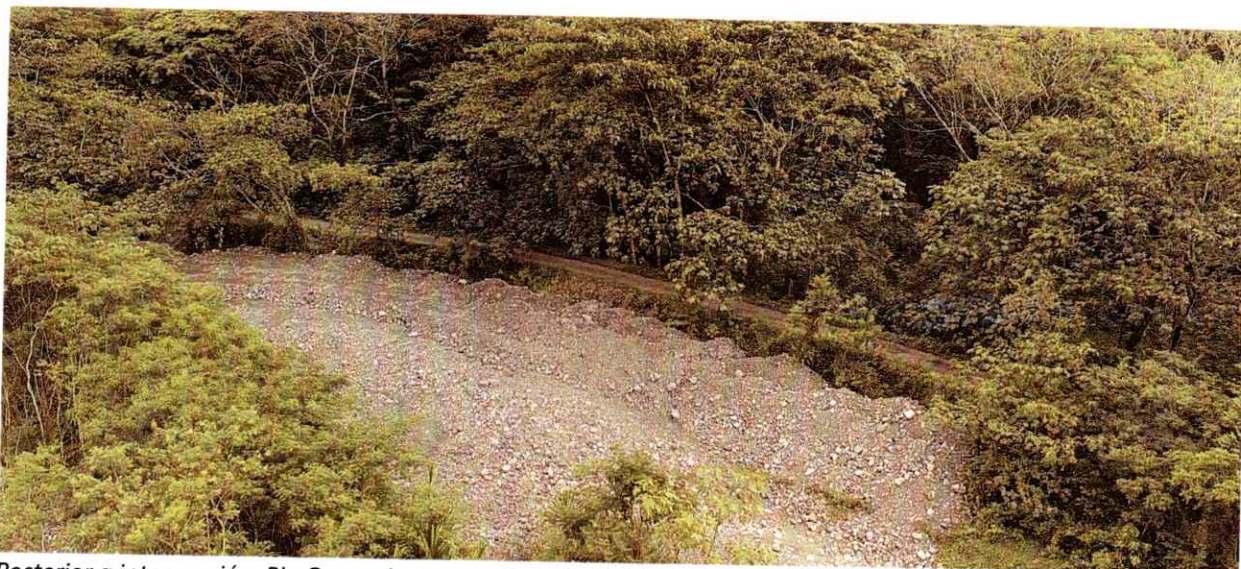
Posterior a intervención, Río Guacavia, Inspección De Guacavia
