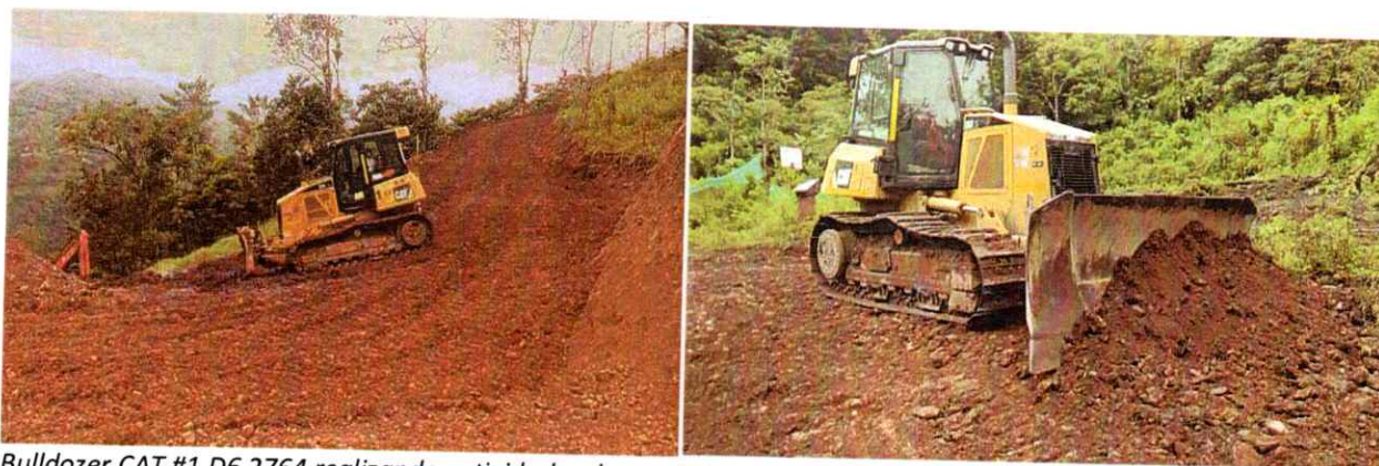
Bulldozer CAT #1 D6 2764 realizando actividades de movimiento de material y conformación de vía
