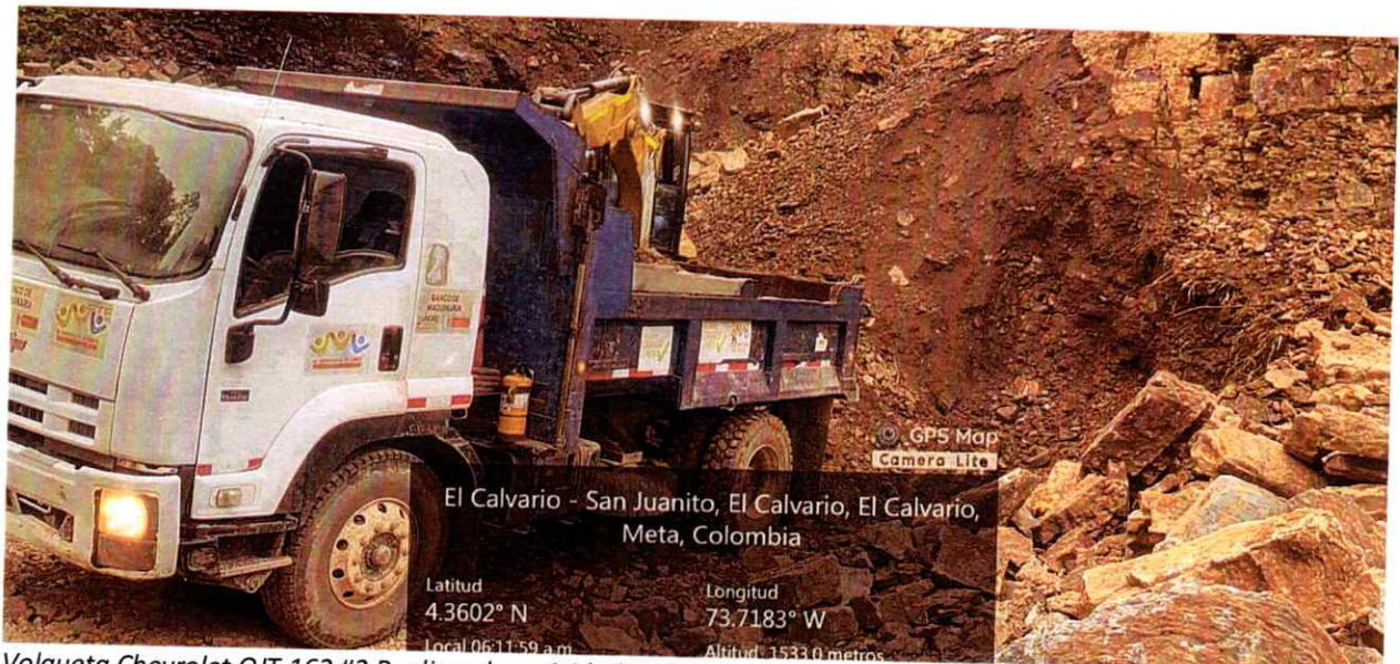
Volqueta Chevrolet OJT 162 #2 Realizando actividades de cargue, transporte y descargue de material
