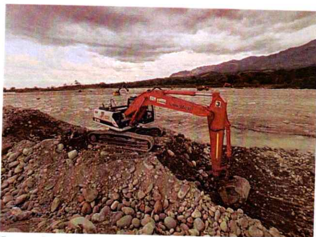
Excavadora Link Belt 2183 #3 realizando actividades de cargue de material y conformación de jarillón
