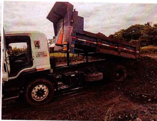
Volqueta chevrolet OJT 164 #4 Realizando actividades de transporte y descargue de material para conformación de jarillón
