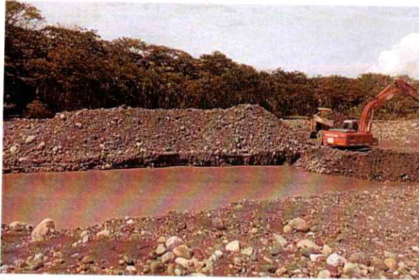
Excavadora Hitachi 200 #1 realizando actividades de canalización y cargue de material
