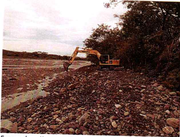
Excavadora Komatsu PC 210LC #1 realizando actividades de cargue y extendido de material
