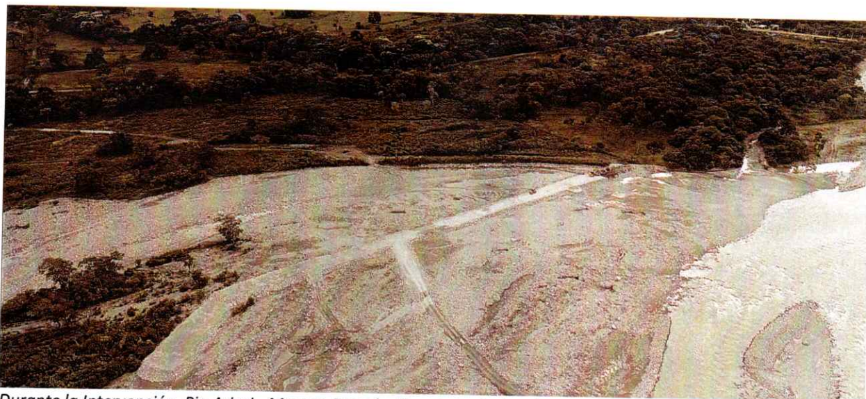
Durante la Intervención, Rio Ariari - Margen Derecha Puente La Amistad
