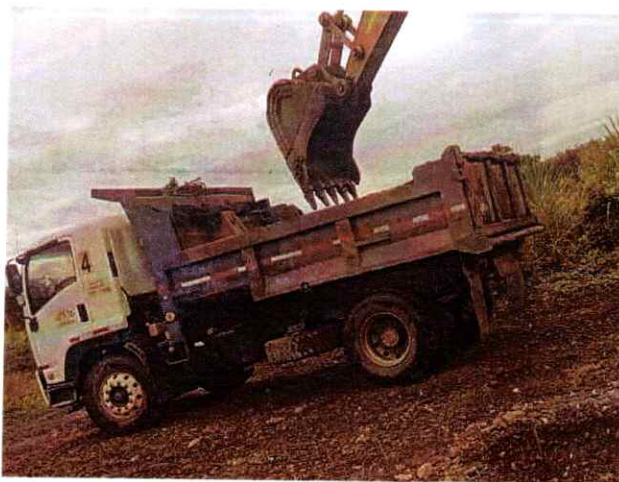
Volqueta chevrolet OJT 164 #4 Realizando actividades de transporte y descargue de material para conformación de jarillón
