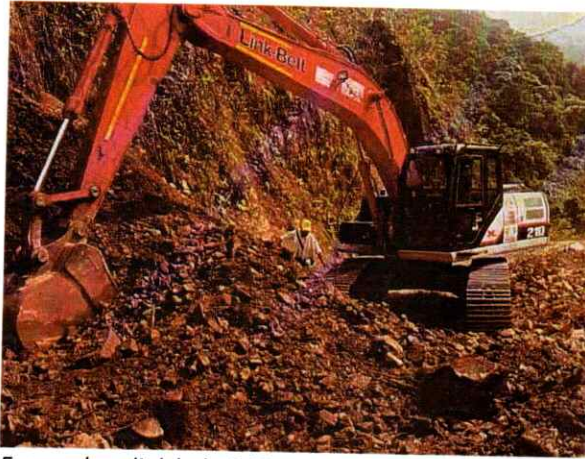
Excavadora link belt 2181 #1 realizando actividades de limpieza de derrumbes y recuperación de la bancada
