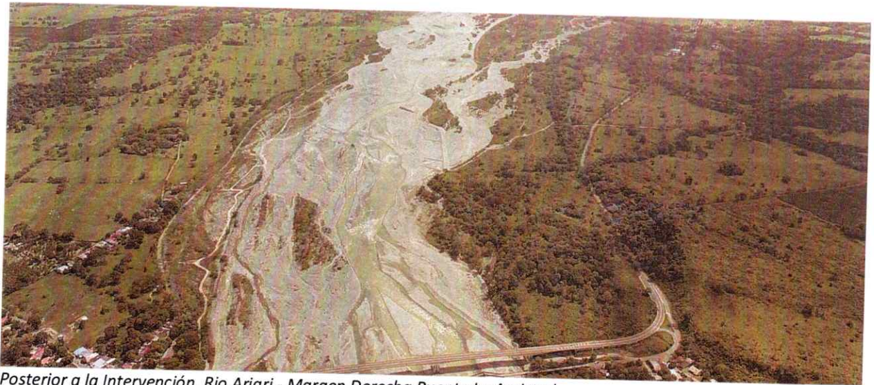
Posterior a la Intervención, Rio Ariari - Margen Derecha Puente La Amistad
