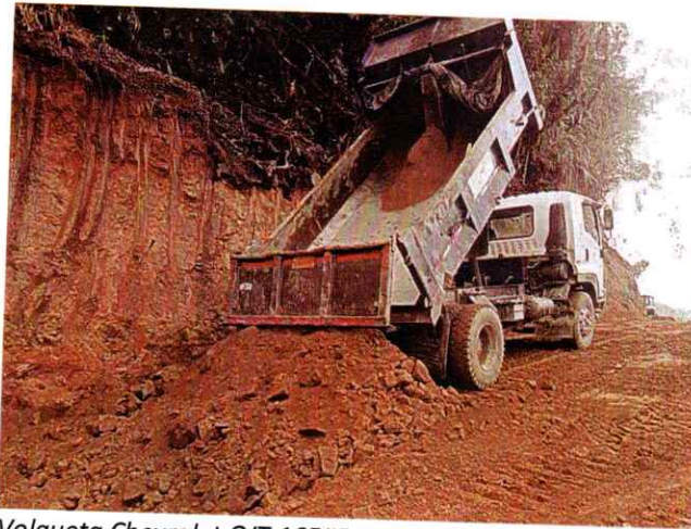
Volqueta Chevrolet OJT 165#5 realizando labores de cargue y descargue de material para conformación de la vía
