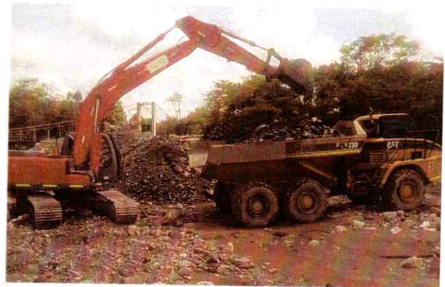
Excavadora Hitachi 200 #1 realizando actividades de canalización y cargue de material
