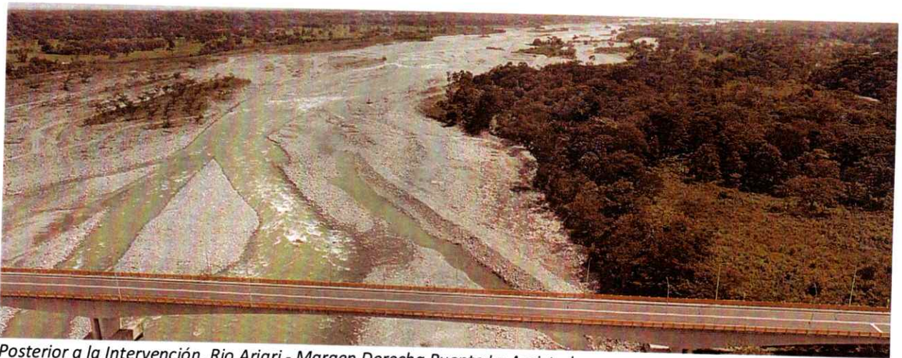
Posterior a la Intervención, Rio Ariari - Margen Derecha Puente La Amistad
