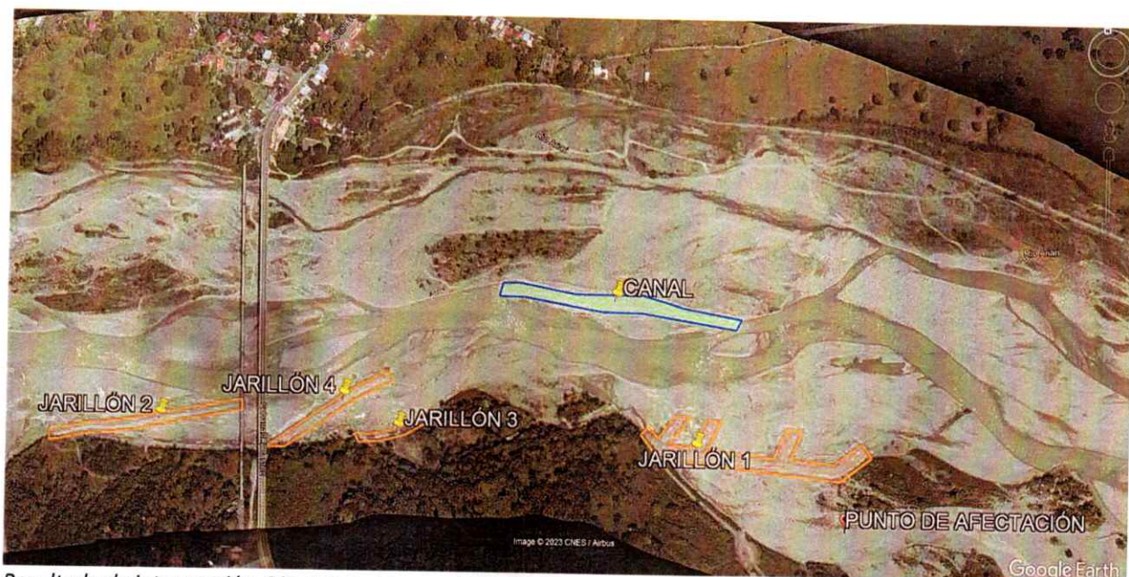
Resultado de intervención, Rio Ariari - Margen Derecha Puente La Amistad
