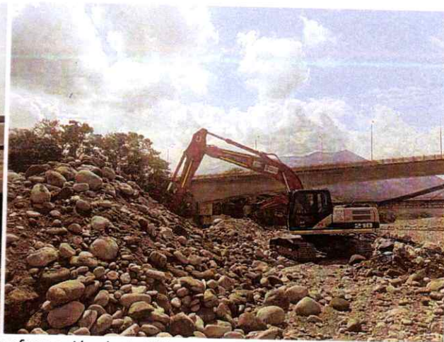
Excavadora Link Belt 2179 #4 realizando actividades de conformación de Jarillón
