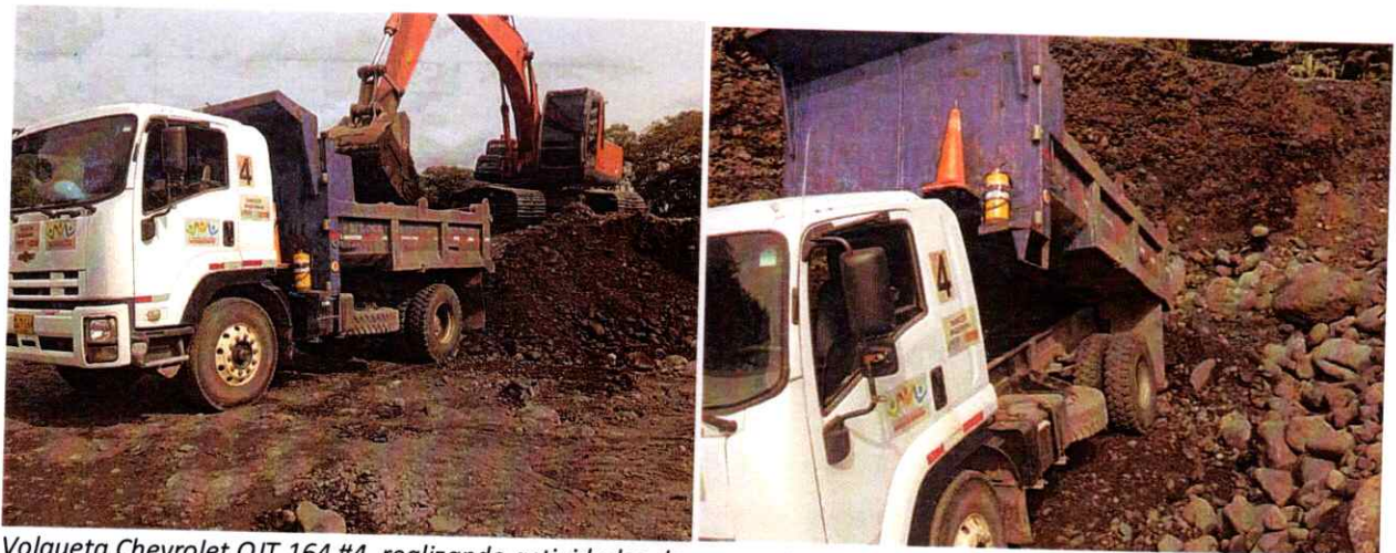
Volqueta Chevrolet OJT 164 #4, realizando actividades de cargue, transporte y descargue de material
