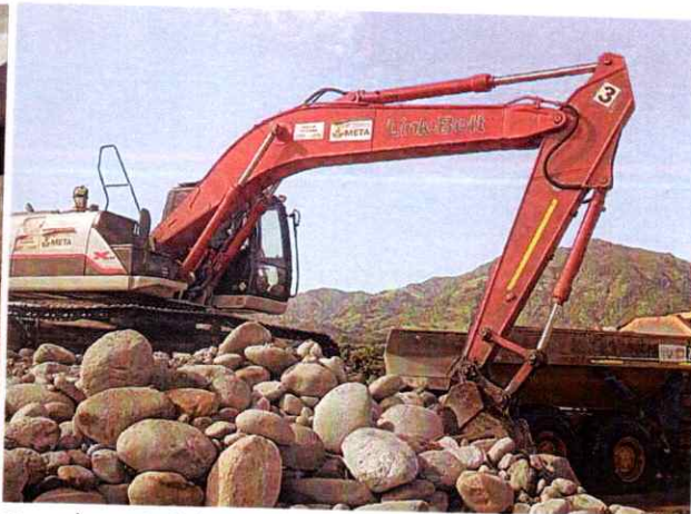
Excavadora Link Belt 2183 #3 realizando actividades de cargue de material y conformación de jarillón
