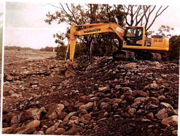
Excavadora Komatsu PC 210LC #1 realizando actividades de extendido de material para conformación de Jarillón
