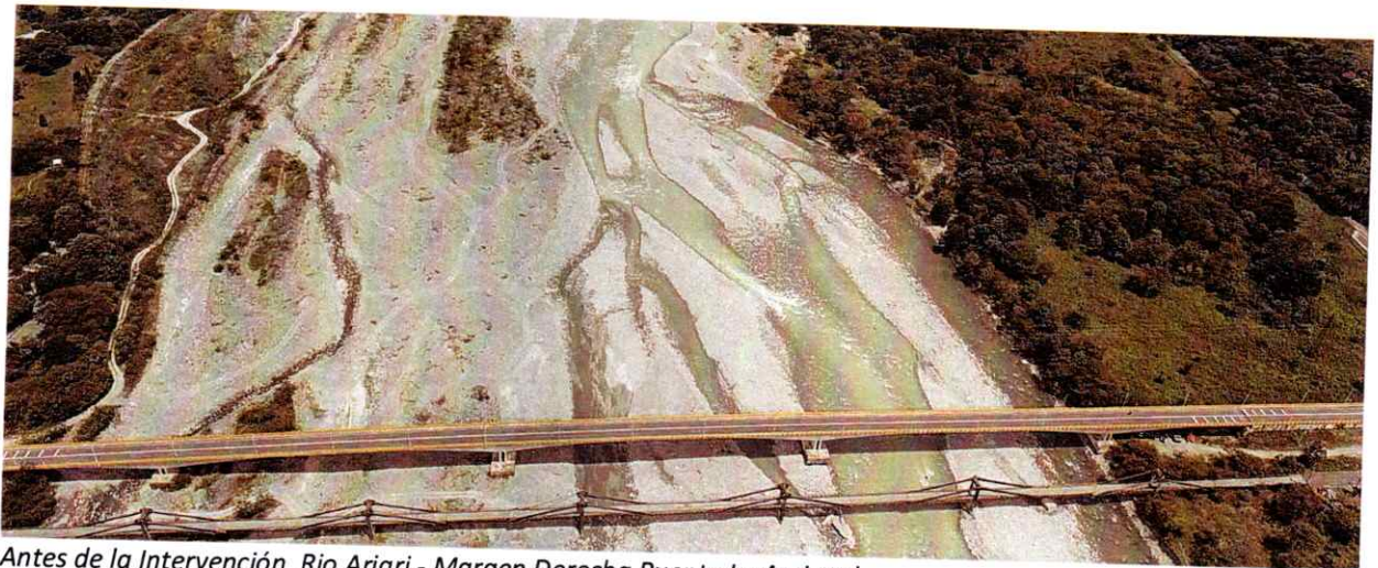
Antes de la Intervención, Rio Ariari - Margen Derecha Puente La Amistad
