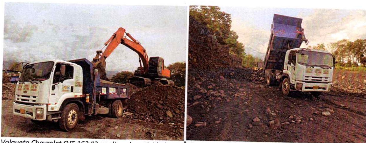
Volqueta Chevrolet OJT 162 #2, realizando actividades de cargue, transporte y descargue de material
