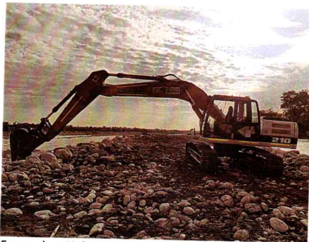
Excavadora Link Belt 2179 #4 realizando actividades de conformación de Jarillón
