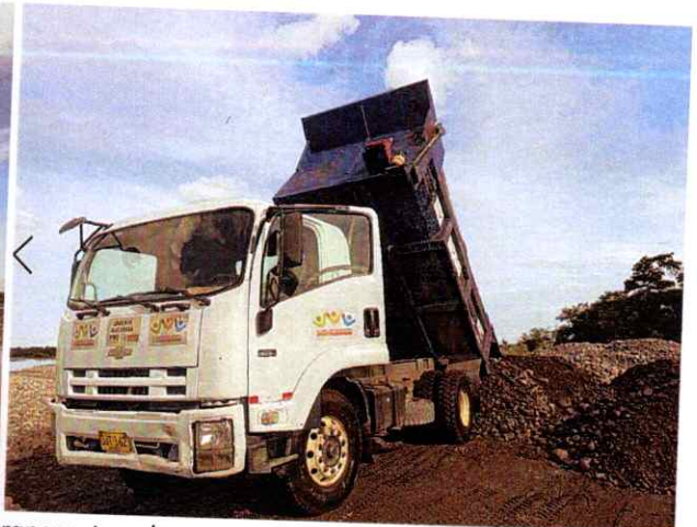
Volqueta chevrolet OJT 162 #2 Realizando actividades de transporte y descargue de material para conformación de jarillón
