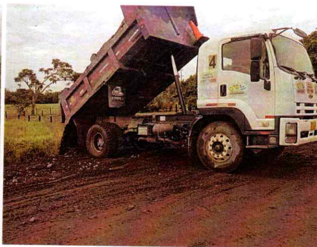
Volqueta chevrolet OJT 164 #4 Realizando actividades de transporte y descargue de material para conformación de jarillón
