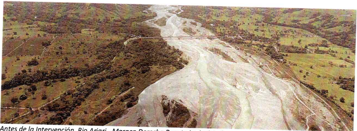
Antes de la Intervención, Rio Ariari - Margen Derecha Puente La Amistad
