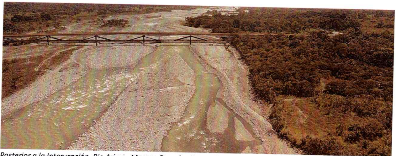
Posterior a la Intervención, Rio Ariari - Margen Derecha Puente La Amistad
