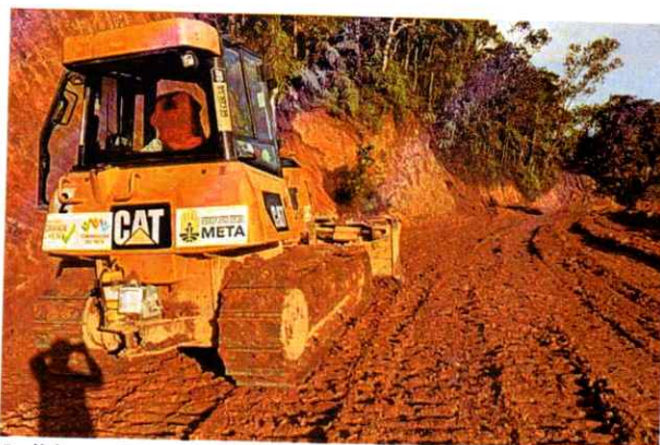
Bulldozer CAT #2 D6 2765 realizando extendido de material
