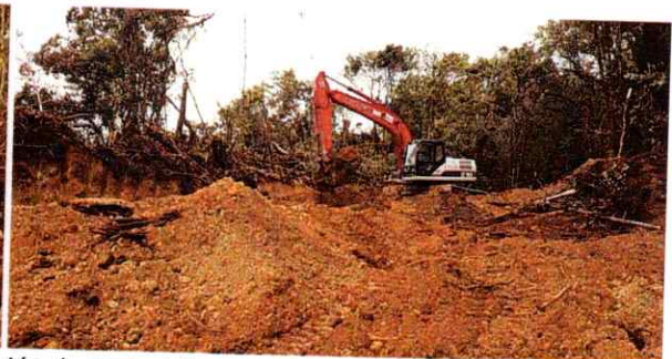
Excavadora link belt 2182 #2 extendiendo material para la conformación de vía
