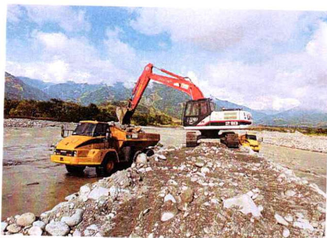
Excavadora Link Belt 2183 #3 realizando actividades de cargue de material y conformación de jarillón
