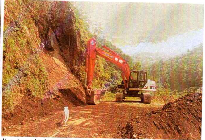
Excavadora link belt 2181 #1 realizando actividades de limpieza de derrumbes y recuperación de la bancada
