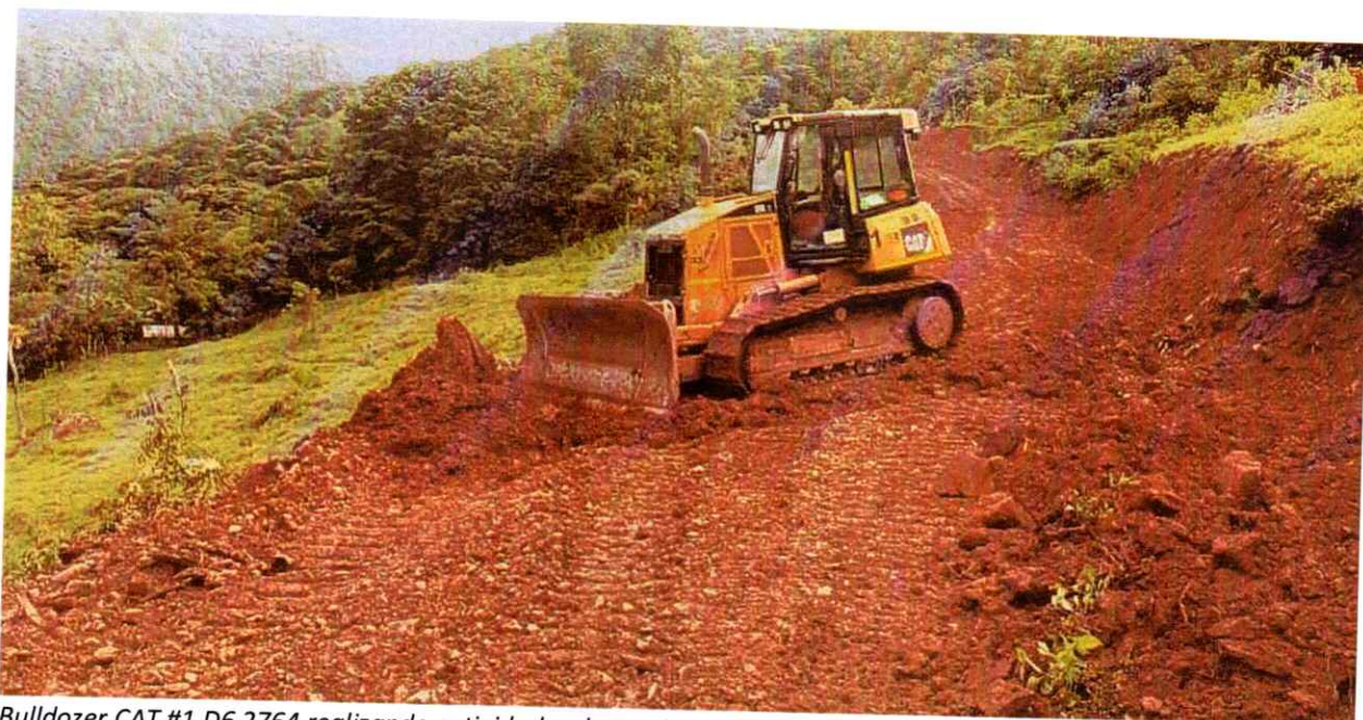
Bulldozer CAT #1 D6 2764 realizando actividades de movimiento de material y conformación de vía
