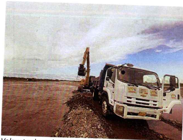
Volqueta chevrolet OJT 162 #2 Realizando actividades de transporte y descargue de material para conformación de jarillón
