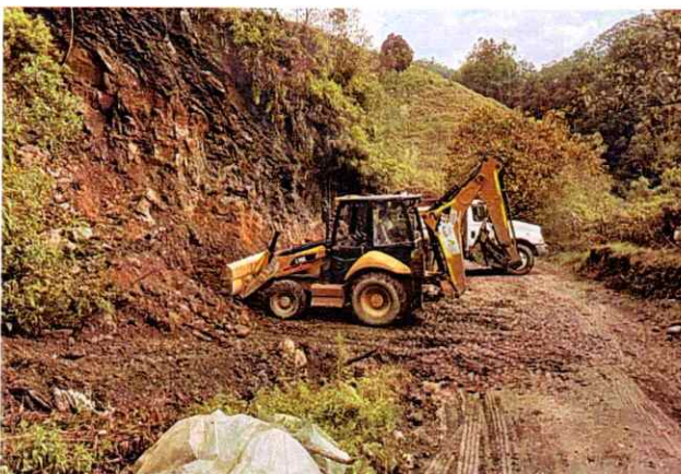
Retroexcavadora 416E realizando actividades de remoción de derrumbes
