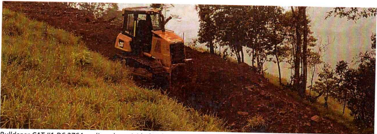
Bulldozer CAT #1 D6 2764 realizando actividades de movimiento de material y conformación de vía
