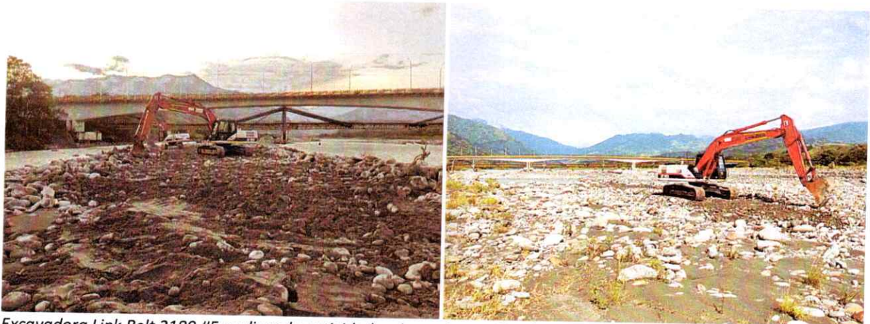
Excavadora Link Belt 2180 #5 realizando actividades de conformación de carreteable
