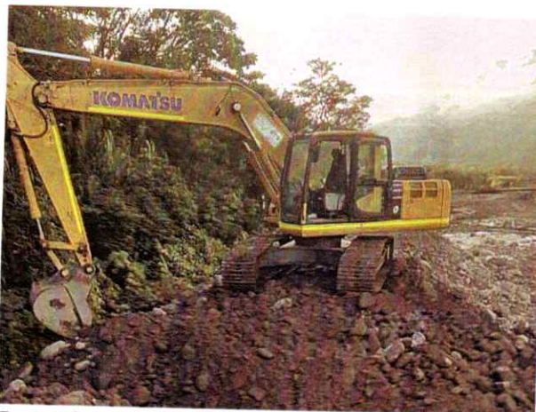
Excavadora Komatsu PC 210LC #1 realizando actividades de extendido de material para conformación de Jarillón
