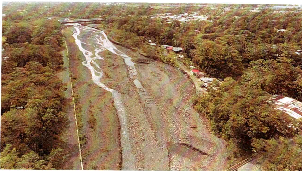
Posterior a la intervención, Restrepo, Entre Puentes – Rio Upin
