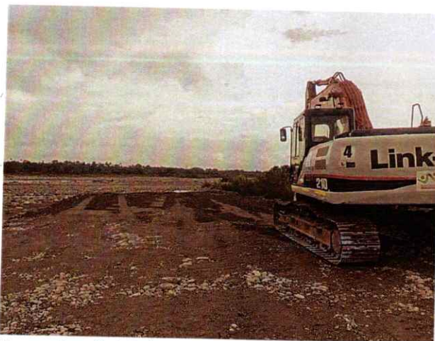
Excavadora Link Belt 2179 #4 realizando actividades de conformación de Jarillón
