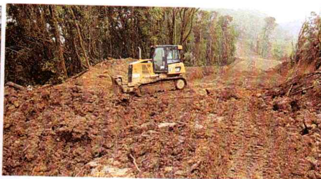
Bulldozer CAT #2 D6 2765 realizando movimiento de material de derrumbes
