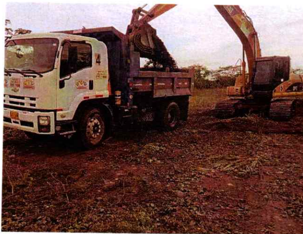
Volqueta chevrolet OJT 164 #4 Realizando actividades de transporte y descargue de material para conformación de jarillón
