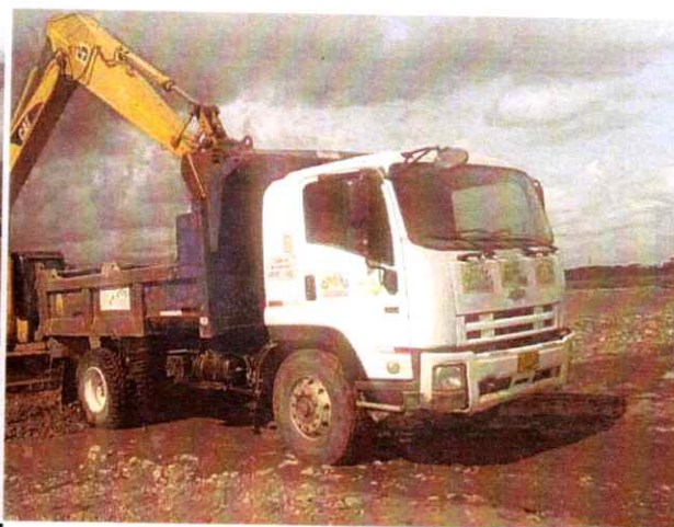
Volqueta chevrolet OJT 163 #3 Realizando actividades de transporte y descargue de material para conformación de jarillón
