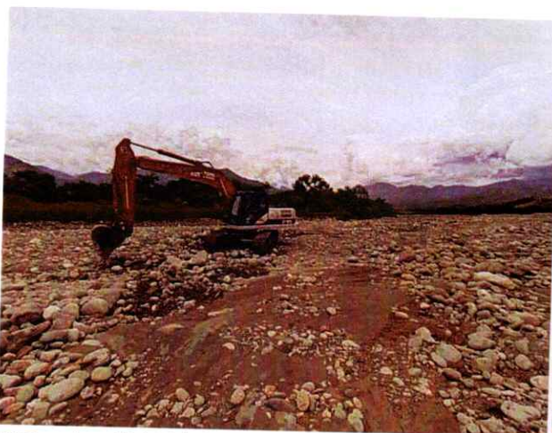
Excavadora Link Belt 2183 #3 realizando actividades de cargue de material y conformación de Jarillón
