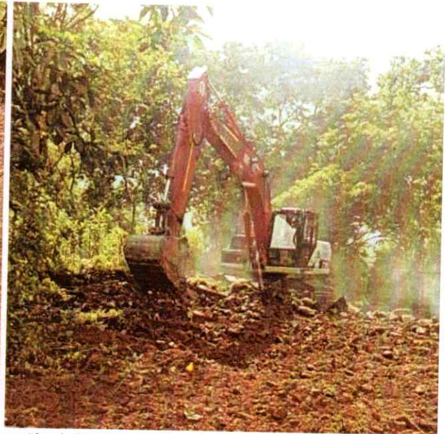
Excavadora link belt#1 extendiendo material para conformación de la vía y realizando limpieza de la vía
