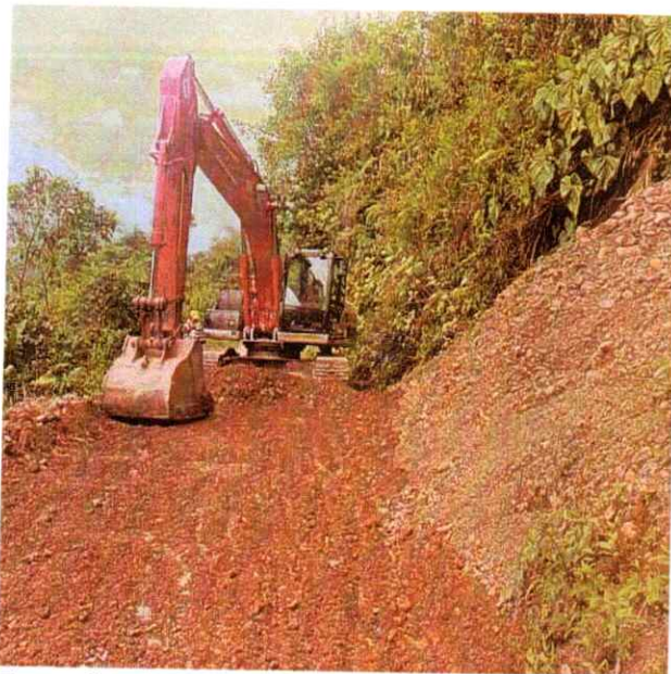
Excavadora link belt#1 extendiendo material para conformación de la vía y realizando limpieza de la vía
