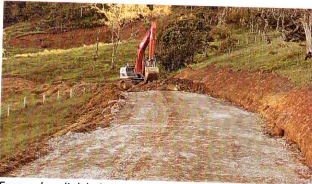
Excavadora link belt 2182 #2 extendiendo material para la conformación de vía
