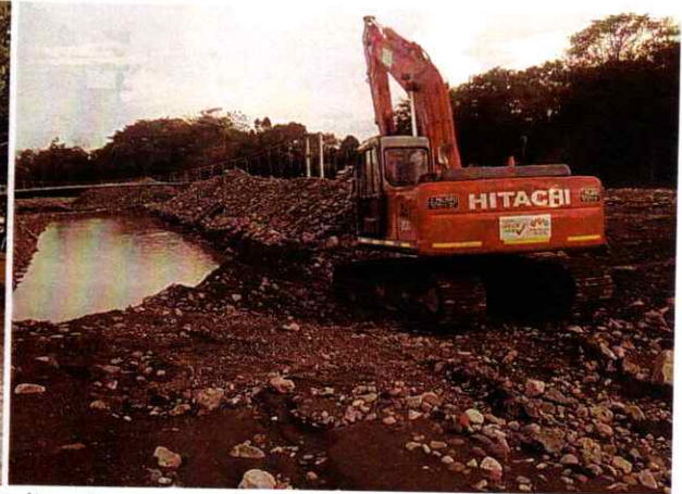
Excavadora Hitachi 200 #1 realizando actividades de canalización y cargue de material
