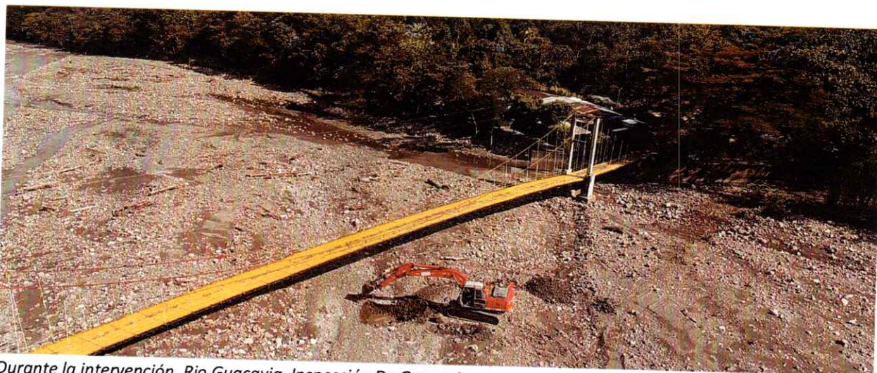
Durante la intervención, Rio Guacavia, Inspección De Guacavia
