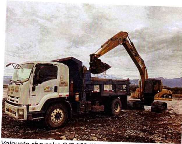
Volqueta chevrolet OJT 162 #2 Realizando actividades de transporte y descargue de material para conformación de jarillón
