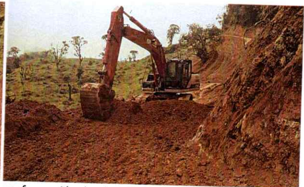
Excavadora link belt 2182 #2 realizando labores de recuperación de la bancada
