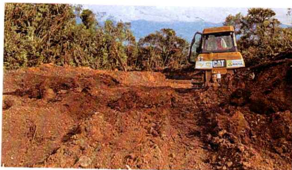
Bulldozer CAT #2 D6 2765 realizando movimiento de material de derrumbes
