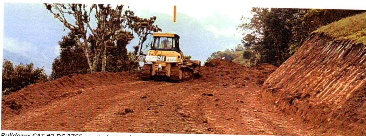
Bulldozer CAT #2 D6 2765 movimientos de material y conformación de la vía
