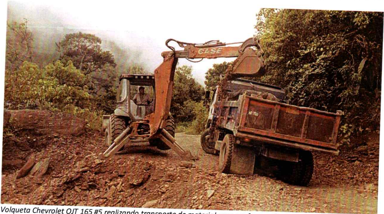
Volqueta Chevrolet OJT 165#5 realizando labores de cargue y descargue de material para conformación de la vía
