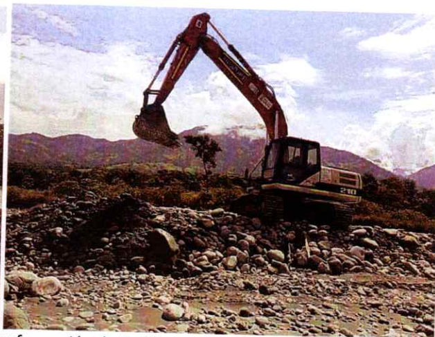
Excavadora Link Belt 2179 #4 realizando actividades de conformación de Jarillón
