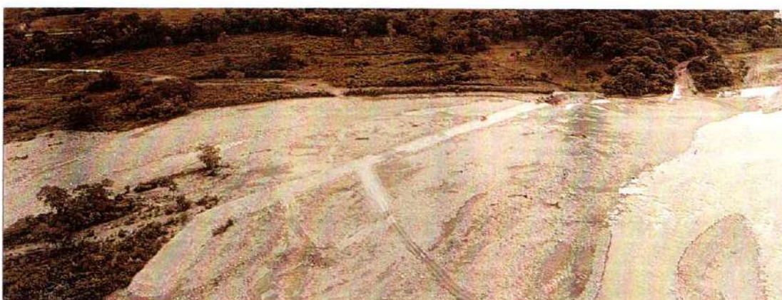
Imagen 506. Durante la Intervención, Rio Ariari - Margen Derecha Puente La Amistad
