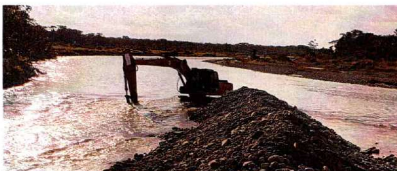
Imagen 438. Excavadora Hitachi 200 #4 realizando actividades de conformación de jarillón
