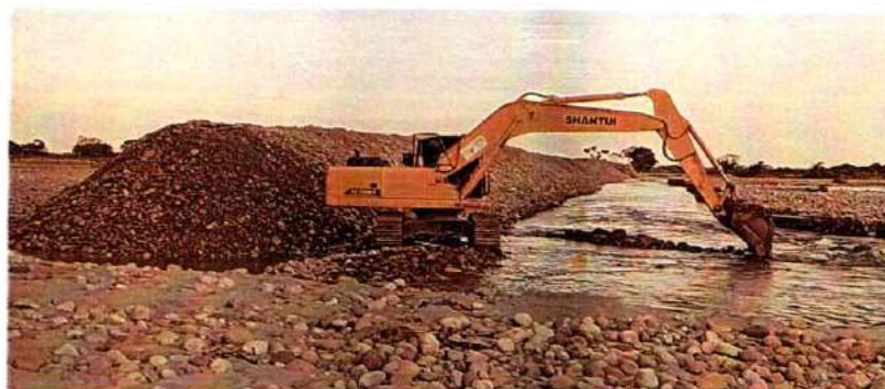
Imagen 607. Excavadora Shantui 220 #5 realizando actividades de excavación y conformación de jarillón
