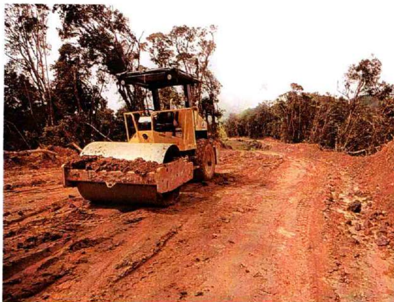
Imagen 634. Vibro compactador dynapac #1 realizando labores de compactación a la vía
