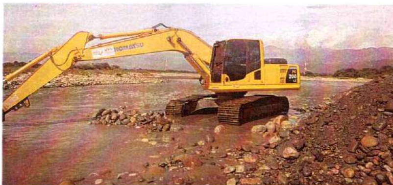
Imagen 482. Excavadora Orugada Komatsu PC200LC - 8 #3 realizando actividades de canalización
