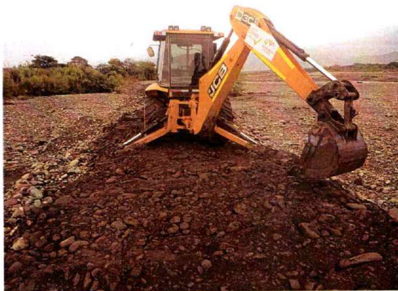
Imagen 313. Retroexcavadora JCB 3C realizando actividades de extendido de material para conformación de Jarillón
