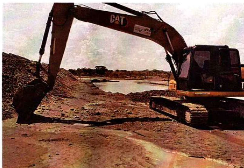
Imagen 590. Excavadora Caterpillar 320D #7 realizando actividades de canalización
