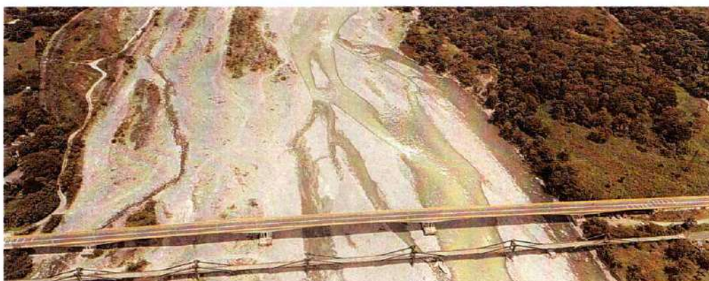
Imagen 504. Antes de la Intervención, Rio Ariari - Margen Derecha Puente La Amistad
