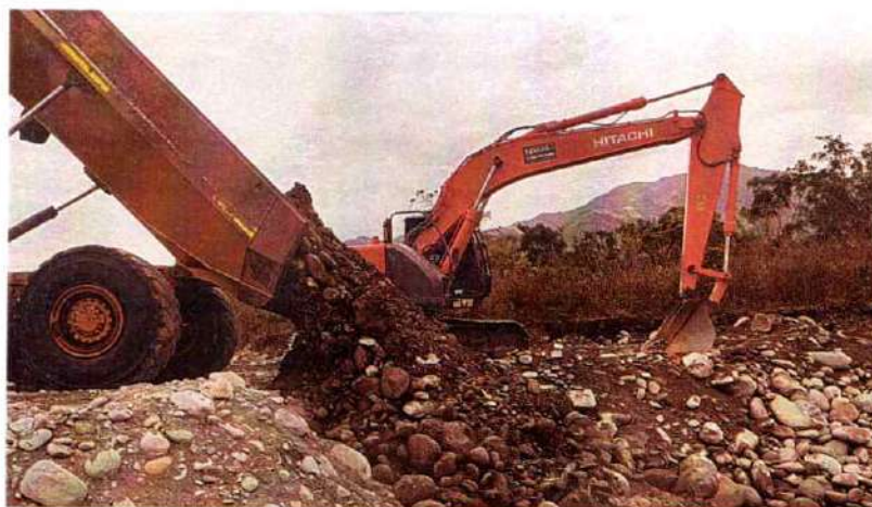
Imagen 517. Excavadora Hitachi 225 realizando actividades de canalización y conformación de jarillón
