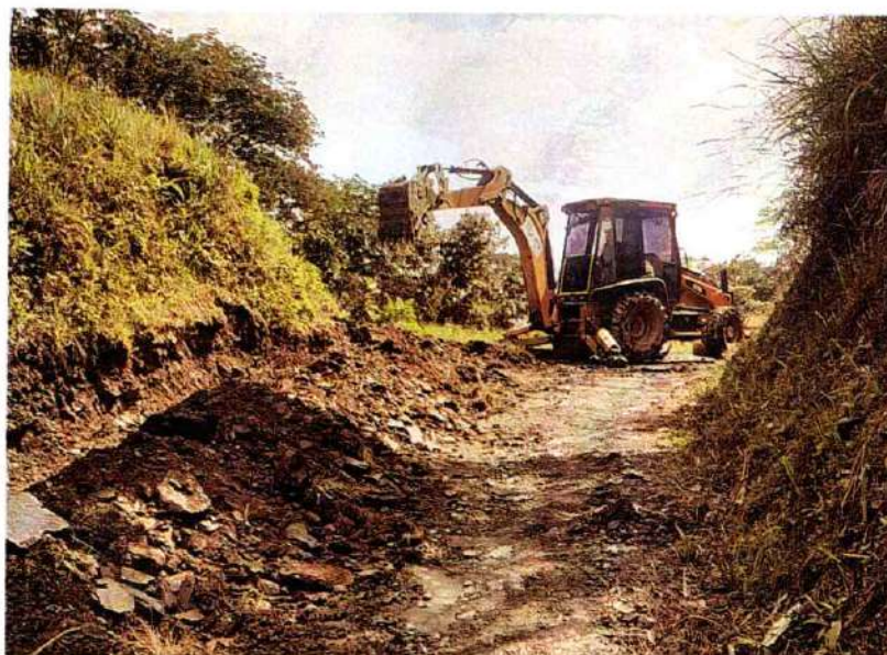
Imagen 498. Retroexcavadora Caterpillar 420D realizando actividades de mejoramiento de vía y limpieza de derribes
