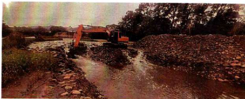
Imagen 414. Excavadora Hitachi 200 #2 realizando actividades de canalización y conformación de Jarillón
