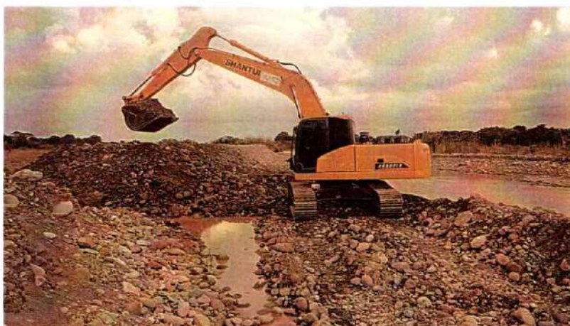
Imagen 541. Excavadora Shantui 220LC #4 realizando actividades de excavación y conformación de Jarillón y espolones
