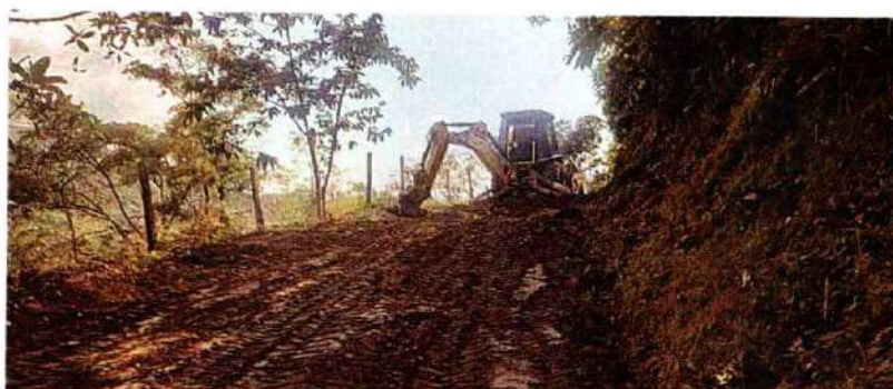
Imagen 500. Retroexcavadora Caterpillar 420D realizando actividades de mejoramiento de vía y limpieza de derribes
