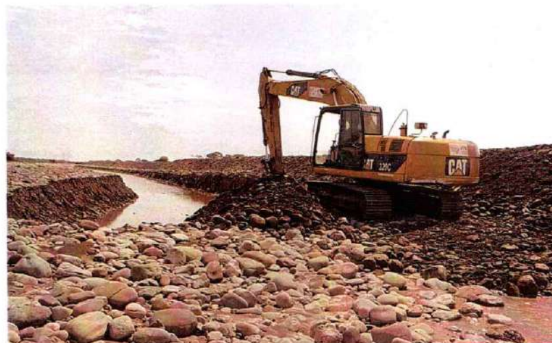
Imagen 321. Excavadora Caterpillar 320C #6 realizando excavación de canal
