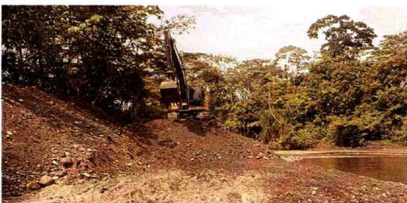
Imagen 450. Excavadora Jhon Deere 210LC #2 realizando actividades de canalización
