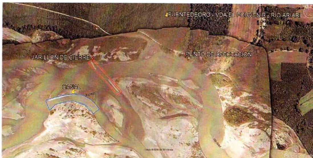
Imagen 595. Intervención realizada, Fuente De Oro – Río Ariari, Vereda El Porvenir-Parte Baja
