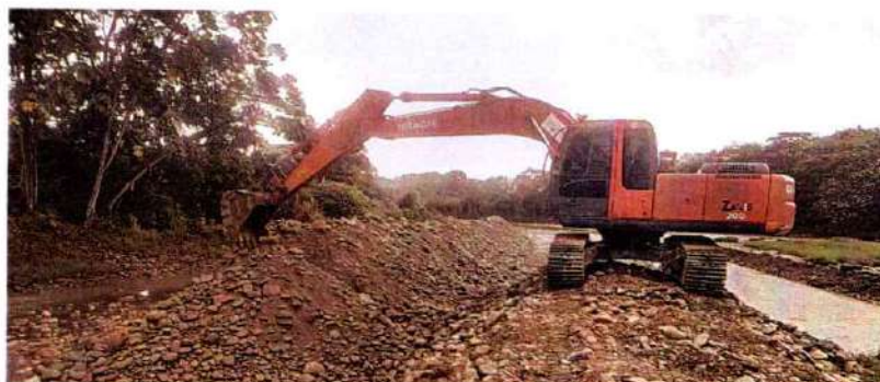
Imagen 415. Excavadora Hitachi 200 #2 realizando actividades de canalización y conformación de Jarillón
