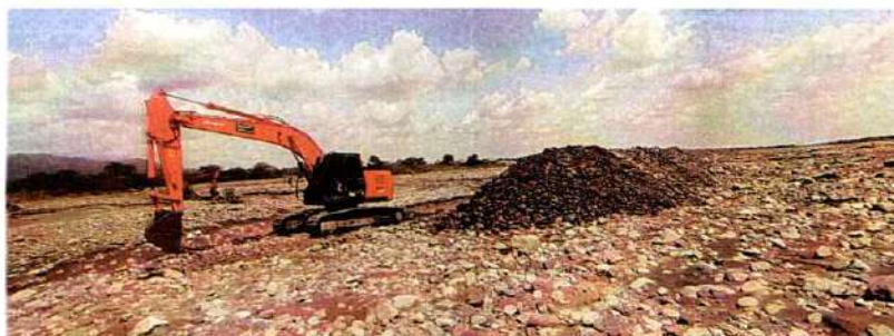
Imagen 456. Excavadora Hitachi 225 #5 realizando actividades de canalización
