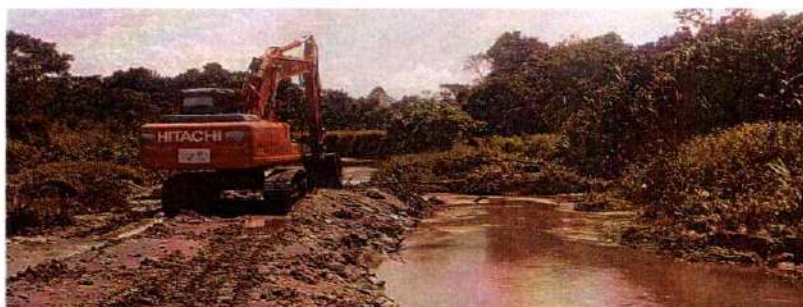
Imagen 437. Excavadora Hitachi 200 #4 realizando actividades de conformación de jarillón
