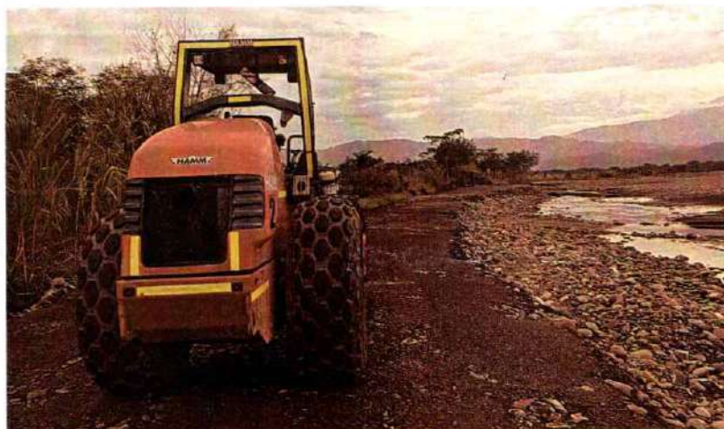
Imagen 314. Vibrocompactador Hamm #2 realizando actividades de compactación de jarillón
