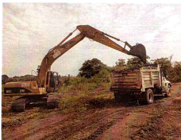
Imagen 360. Volqueta COG 789 Realizando actividades de transporte de material.
