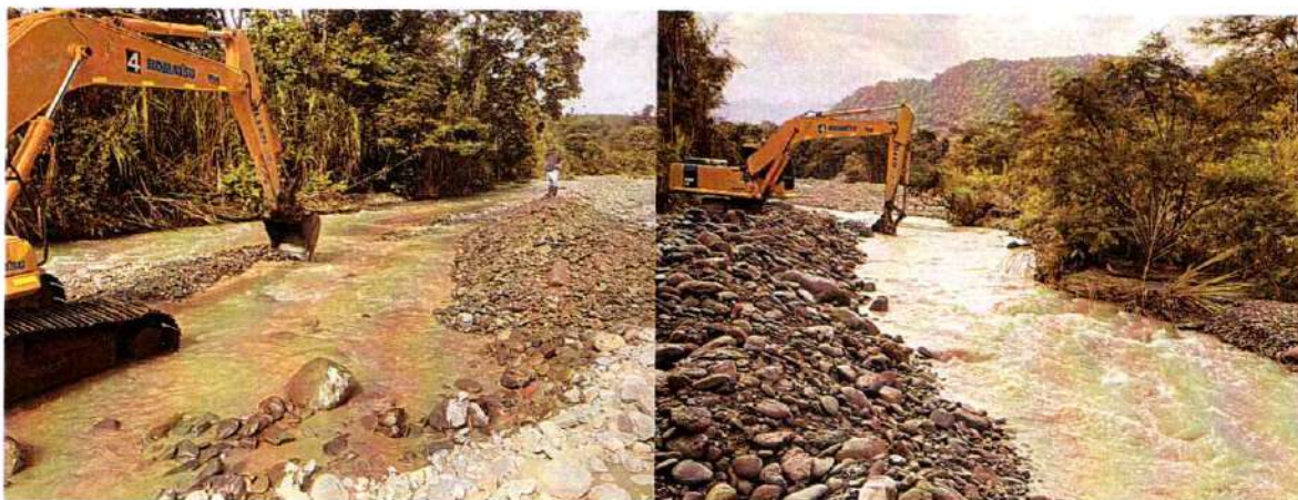
Imagen 548. Excavadora Komatsu #6 realizando actividades de excavación y conformación de jarillón
