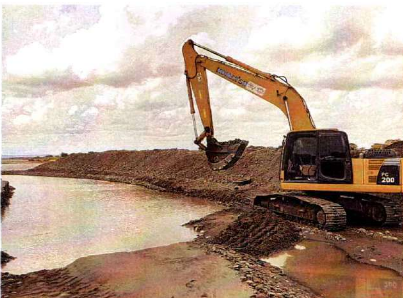
Imagen 603. Excavadora Komatsu PC200 #5 realizando actividades de canalización y conformación de cierre
