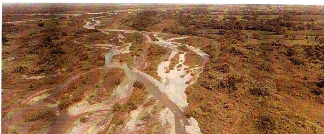
Imagen 537. Intervención realizada, El Castillo – Vereda La Unión, Río Guape – Jarillón #1
