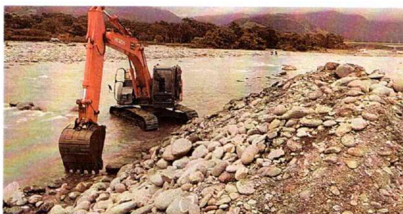
Imagen 518. Excavadora Hitachi 225 realizando actividades de canalización y conformación de jarillón
