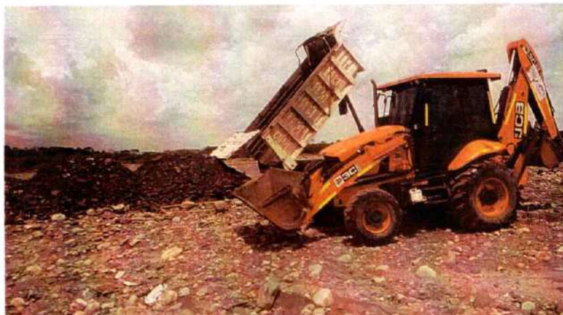
Imagen 312. Retroexcavadora JCB 3C realizando actividades de extendido de material para conformación de Jarillón
