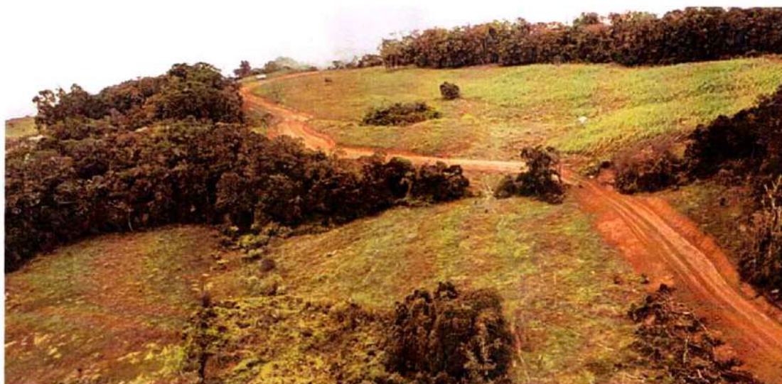
Imagen 611. Avance de la rehabilitación de la vía El Clavario - Monfort
