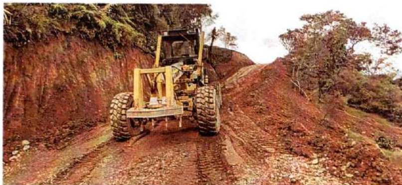
Imagen 636. Motoniveladora champion #4 realizando labores de extendido de material
