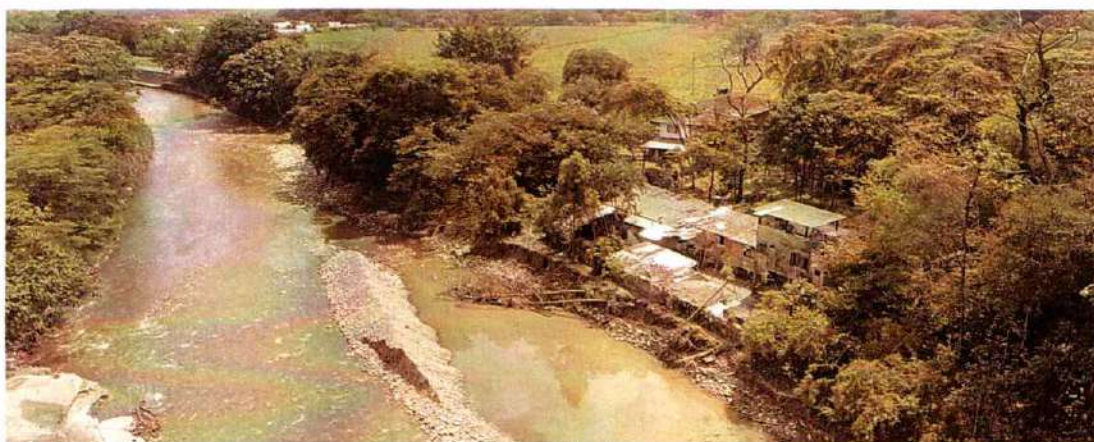
Imagen 375. Previo a la intervención, Villavicencio – Juan Pablo II, Rio Ocoa
