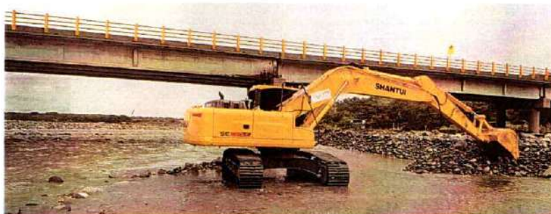
Imagen 466. Excavadora Shantui 220LC #1 realizando actividades de canalización y conformación de Jarillón
