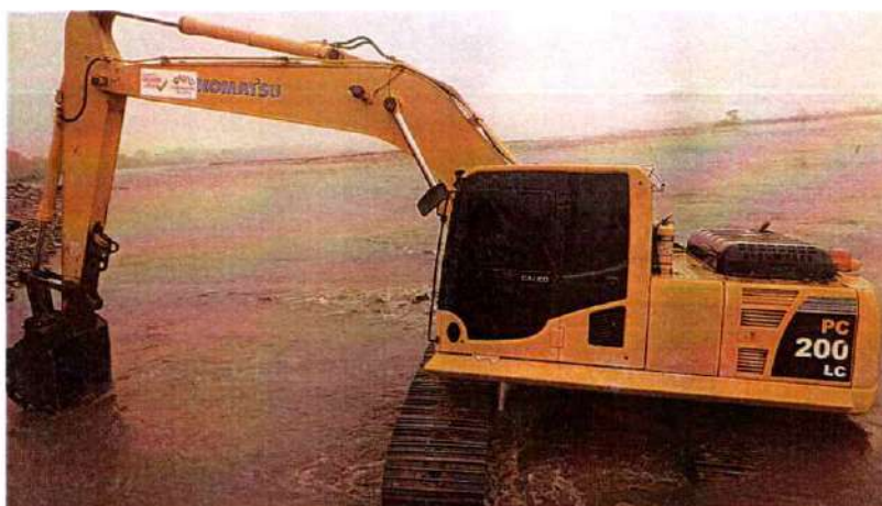
Imagen 485. Excavadora Orugada Komatsu PC200LC - 8 #3 realizando actividades de canalización
