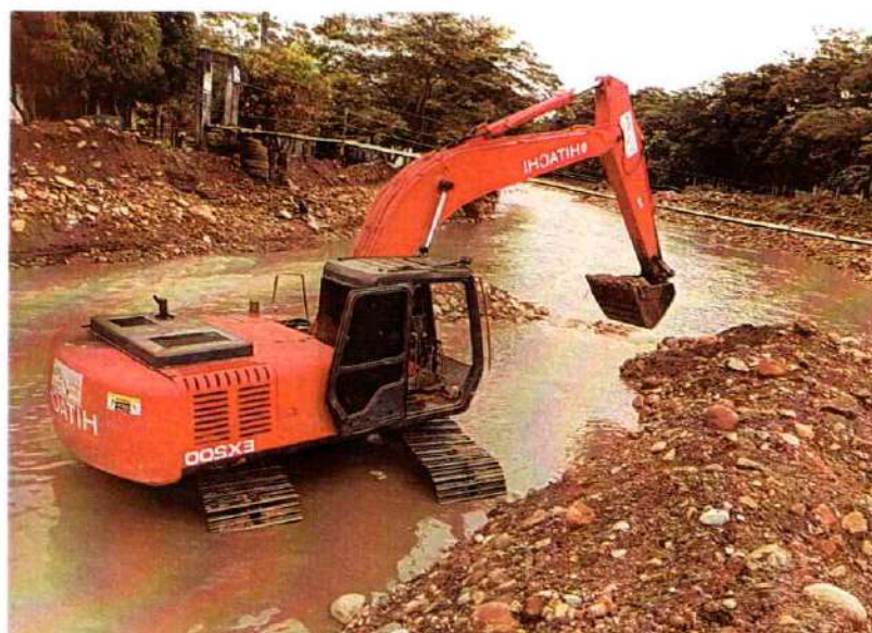
Imagen 403. Excavadora Hitachi 200 #3 realizando actividades de canalización y conformación de Jarillón
