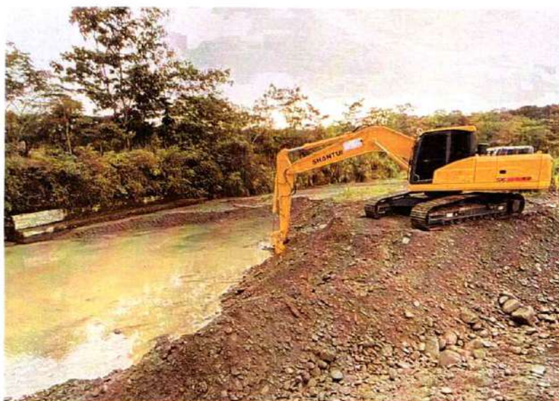
Imagen 557. Excavadora Shantui 220LC #2 realizando actividades de canalización y conformación de jarillón
