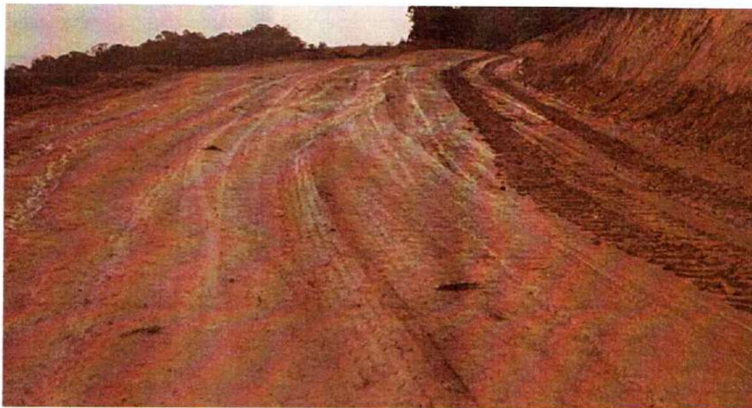
Imagen 609. Avance de la rehabilitación de la vía El Clavario - Monfort
