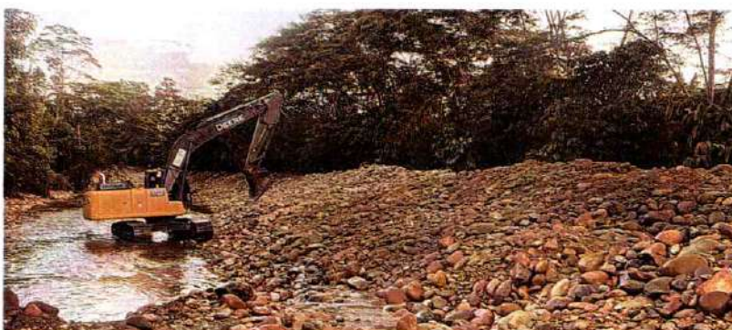
Imagen 449. Excavadora Jhon Deere 210LC #2 realizando actividades de canalización
