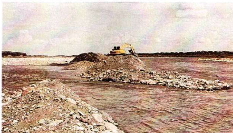
Imagen 484. Excavadora Orugada Komatsu PC200LC - 8 #3 realizando actividades de canalización
