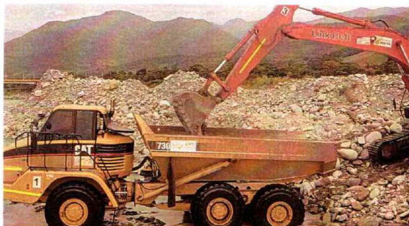
Imagen 521. Dumper Caterpillar 730 #1 realizando actividades de transporte y descargue de material
