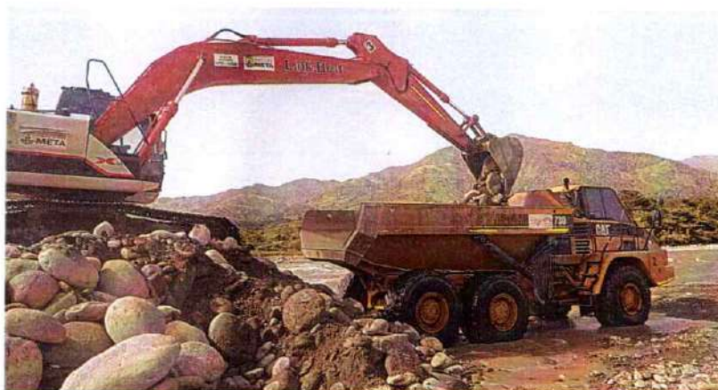
Imagen 525. Dumper Caterpillar 730 #2 realizando actividades de transporte y descargue de material
