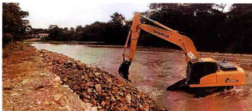
Imagen 426. Excavadora Shantui 220 #5 realizando actividades de canalización y conformación de jarillón
