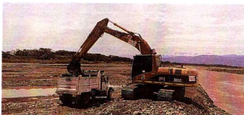
Imagen 357. Excavadora Caterpillar 320CL #5 realizando actividades de canalización y cargue de volquetas
