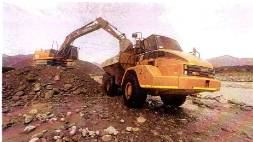
Imagen 526. Dumper Caterpillar 730 #2 realizando actividades de transporte y descargue de material
