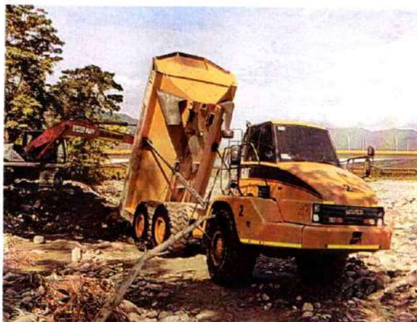
Imagen 527. Dumper Caterpillar 730 #2 realizando actividades de transporte y descargue de material
