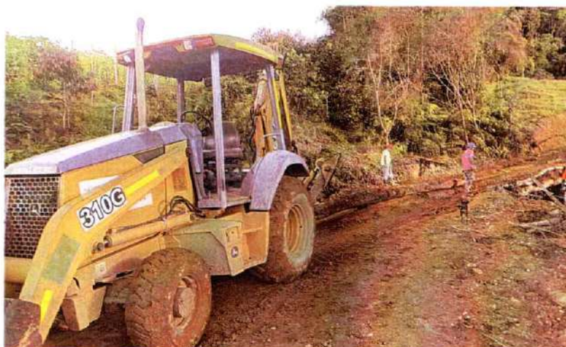
Imagen 628. Retroexcavadora John deere 310G realizando actividades de remoción de material y conformación de vía
