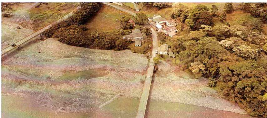
Imagen 464. Posterior a la intervención, Villavicencio, Entre Puentes – Río Guayuriba
