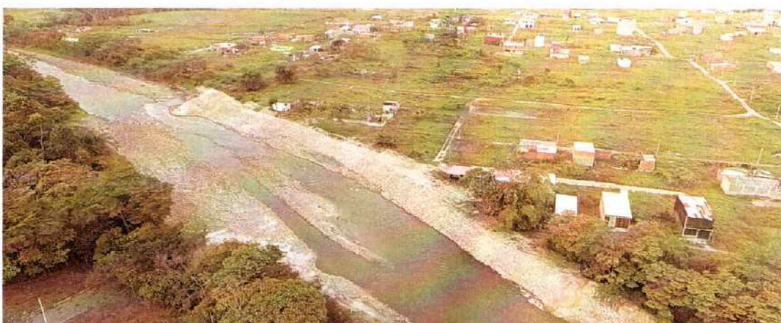
Imagen 424. Posterior a la intervención, Villavicencio – Villa Isabela II, Rio Ocoa
