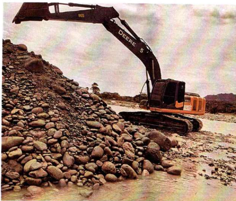
Imagen 515. Excavadora Jhon Deere 200LC realizando actividades de canalización y conformación de Jarillón
