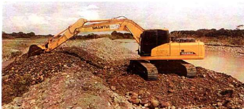
Imagen 542. Excavadora Shantui 220LC #4 realizando actividades de excavación y conformación de Jarillón y espolones
