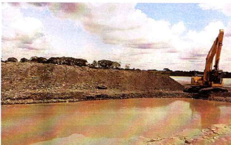
Imagen 602. Excavadora Komatsu PC200 #5 realizando actividades de canalización y conformación de cierre
