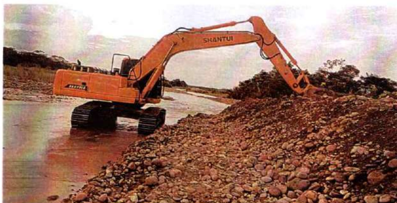
Imagen 539. Excavadora Shantui 220LC #4 realizando actividades de excavación y conformación de Jarillón y espolones
