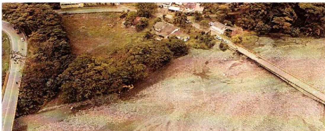
Imagen 461. Intervención en proceso, Villavicencio, Entre Puentes – Río Guayuriba
