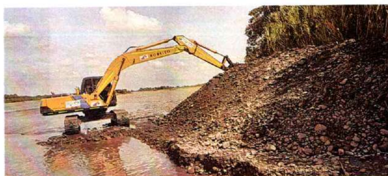
Imagen 332. Excavadora Kobelco SK200 #1 realizando actividades de conformación de jarillón
