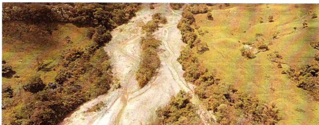
Imagen 547. Intervención realizada, El Castillo – Medellín Del Ariari, Rio Cumaral
