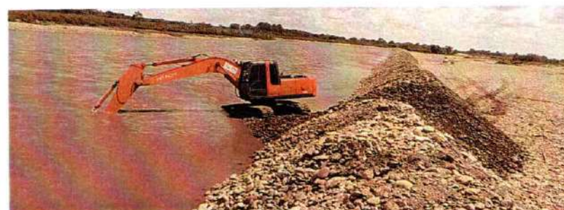
Imagen 337. Excavadora Hitachi Zaxis 200 #2 realizando actividades de conformación de jarillón
