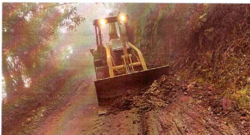
Imagen 627. Retroexcavadora John deere 310G realizando actividades de remoción de material y conformación de vía
