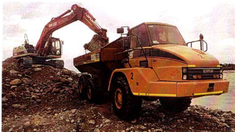
Imagen 524. Dumper Caterpillar 730 #2 realizando actividades de transporte y descargue de material
