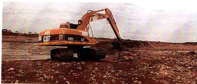
Imagen 355. Excavadora Caterpillar 320CL #5 realizando actividades de canalización y cargue de volquetas
