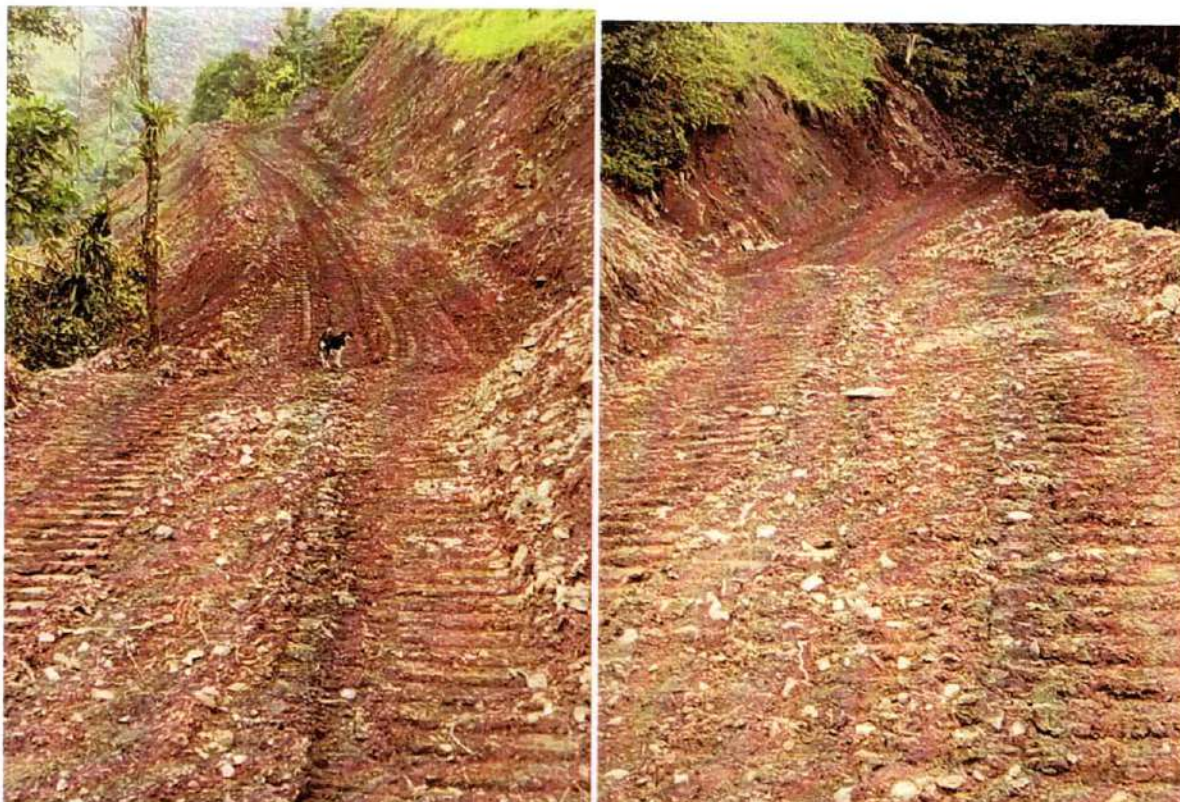
Imagen 610. Avance de la rehabilitación de la vía El Clavario - Monfort
