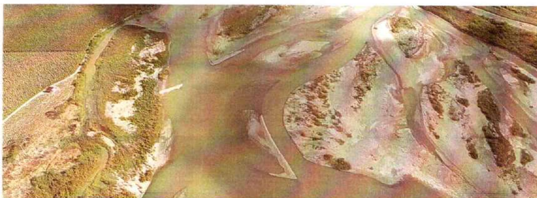
Imagen 599. Posterior a la intervención, Fuente De Oro – Rio Ariari, Vereda El Porvenir-Parte Baja
