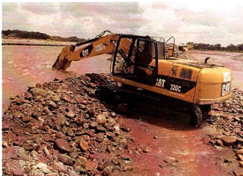
Imagen 323. Excavadora Caterpillar 320C #6 realizando excavación de canal
