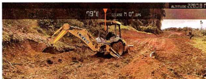
Imagen 629. Retroexcavadora John deere 310G realizando actividades de remoción de material y conformación de vía
