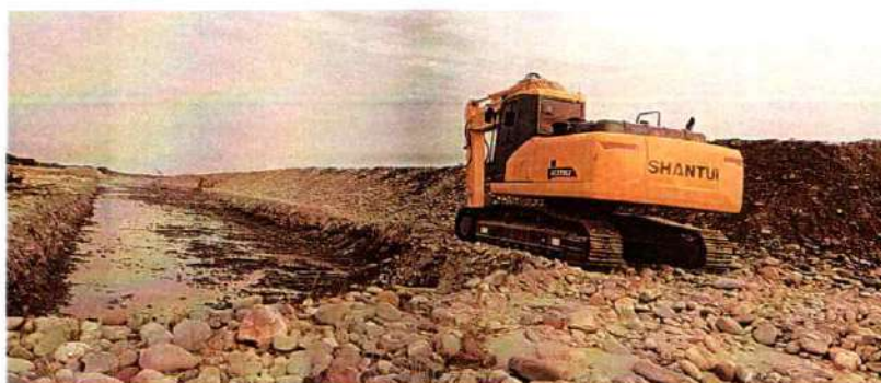
Imagen 580. Excavadora Shantui 220LC #4 realizando actividades de canalización
