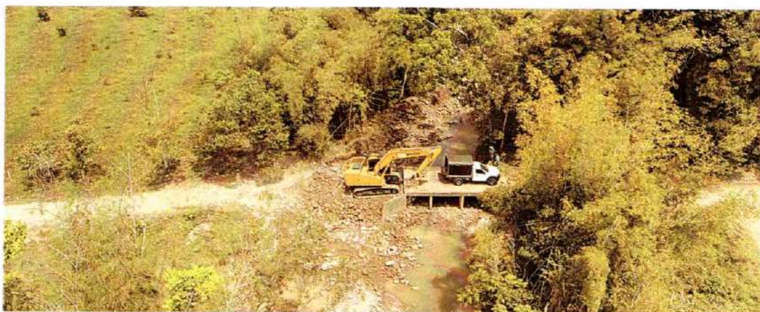
Imagen 563. Previo a la Intervención, Mesetas – Vereda Las Flores, Caño Sucio
