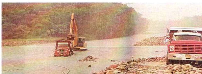
Imagen 427. Excavadora Shantui 220 #5 realizando actividades de canalización y conformación de jarillón
