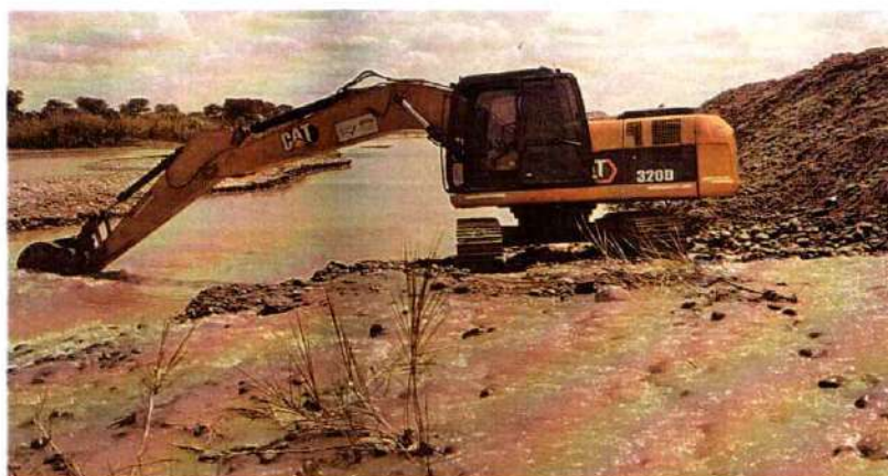
Imagen 591. Excavadora Caterpillar 320D #7 realizando actividades de canalización
