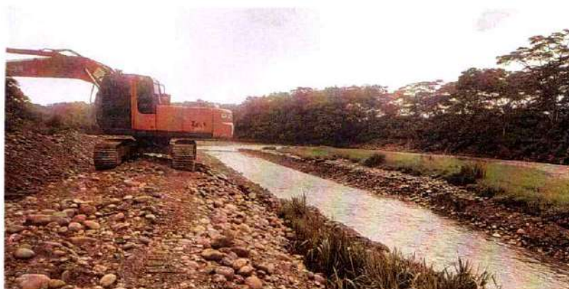
Imagen 416. Excavadora Hitachi 200 #2 realizando actividades de canalización y conformación de Jarillón
