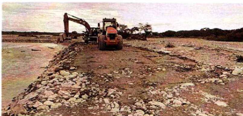
Imagen 529. Vibrocompactador Hamm #3 realizando actividades de compactación de jarillón
