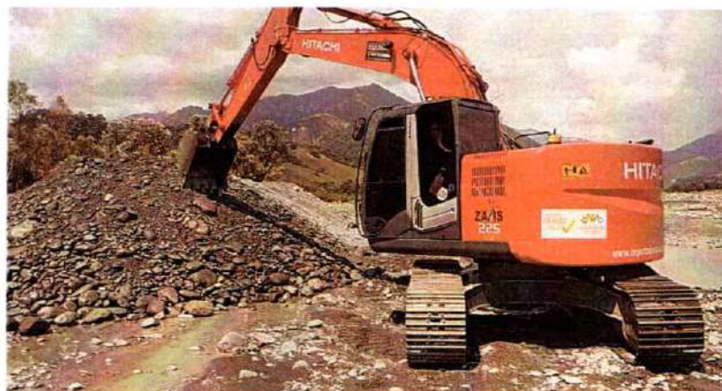
Imagen 516. Excavadora Hitachi 225 realizando actividades de canalización y conformación de jarillón
