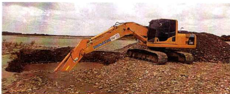
Imagen 601. Excavadora Komatsu PC200 #5 realizando actividades de canalización y conformación de cierre
