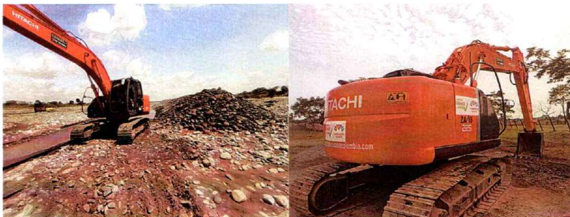
Imagen 457. Excavadora Hitachi 225 #5 realizando actividades de canalización
