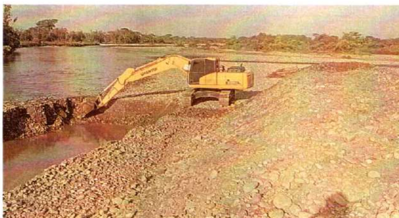
Imagen 605. Excavadora Shantui 220 #5 realizando actividades de excavación y conformación de jarillón
