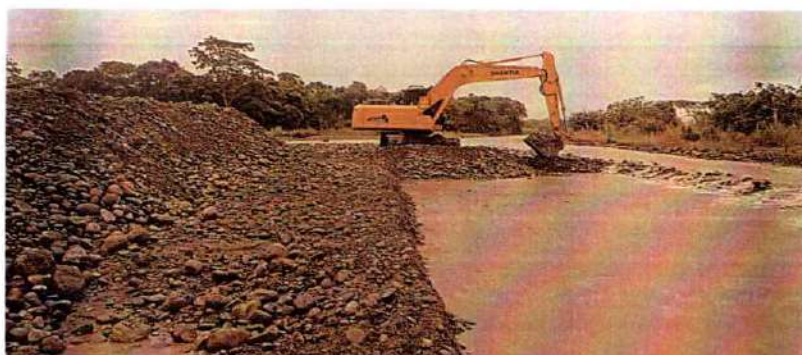
Imagen 540. Excavadora Shantui 220LC #4 realizando actividades de excavación y conformación de Jarillón y espolones
