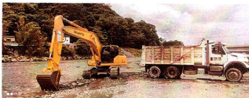
Imagen 469. Excavadora Shantui 220LC #1 realizando actividades de canalización y conformación de Jarillón
