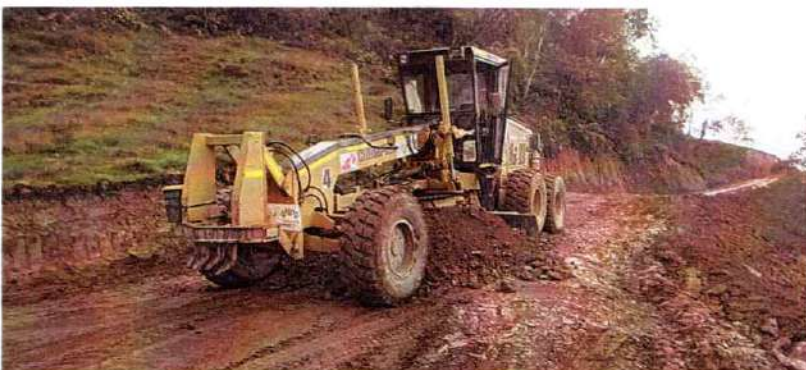
Imagen 638. Motoniveladora champion #4 realizando labores de extendido de material
