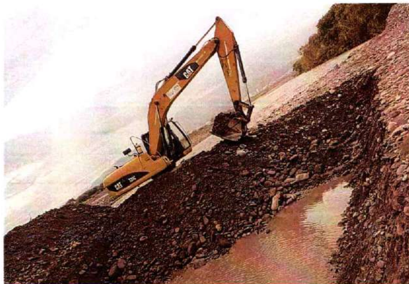
Imagen 320. Excavadora Caterpillar 320C #6 realizando excavación de canal
