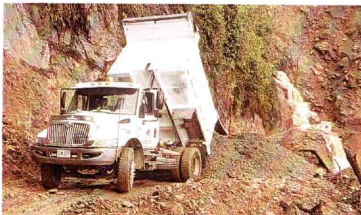
Imagen 614. Volqueta UZN 327 realizando actividades de cargue y transporte de material
