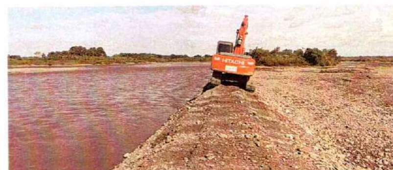
Imagen 338. Excavadora Hitachi Zaxis 200 #2 realizando actividades de conformación de jarillón
