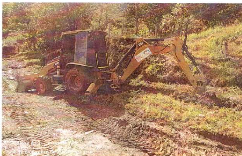
Imagen 497. Retroexcavadora Caterpillar 420D realizando actividades de mejoramiento de vía y limpieza de derribes
