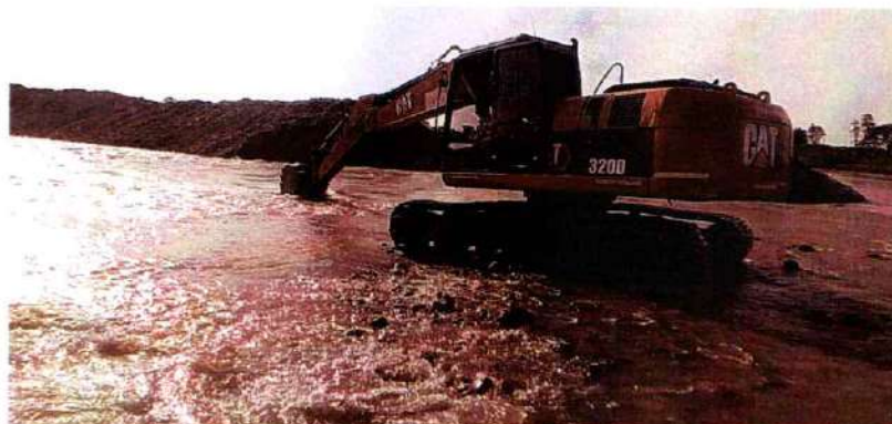
Imagen 593. Excavadora Caterpillar 320D #7 realizando actividades de canalización
