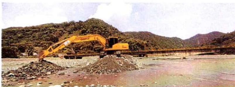
Imagen 467. Excavadora Shantui 220LC #1 realizando actividades de canalización y conformación de Jarillón
