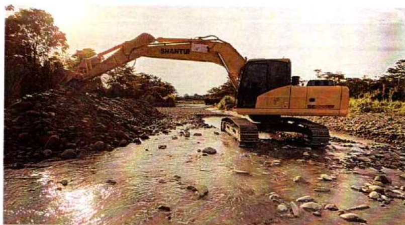
Imagen 559. Excavadora Shantui 220LC #2 realizando actividades de canalización y conformación de jarillón
