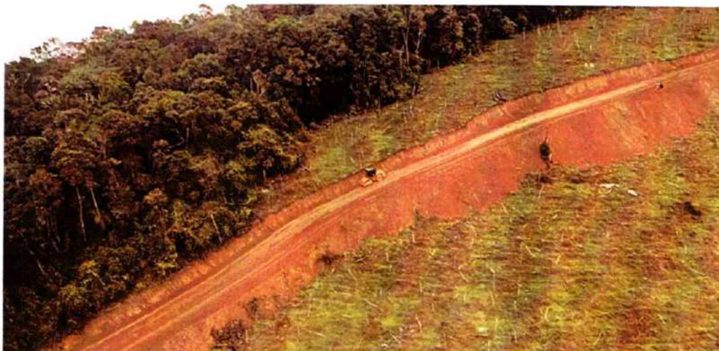
Imagen 612. Avance de la rehabilitación de la vía El Clavario - Monfort
