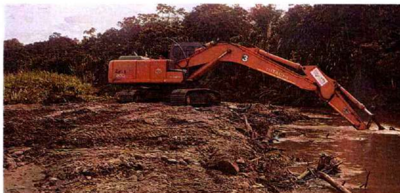
Imagen 436. Excavadora Hitachi 200 #4 realizando actividades de conformación de jarillón
