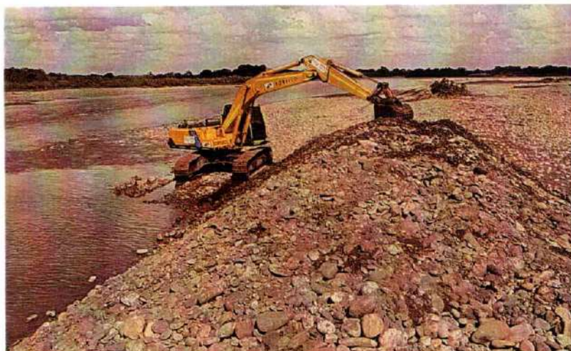
Imagen 334. Excavadora Kobelco SK200 #1 realizando actividades de conformación de jarillón
