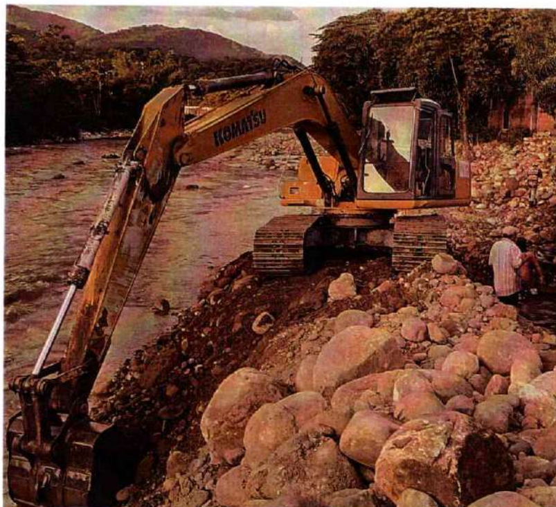
Imagen 394. Excavadora Oruga Komatsu 200 #2 realizando actividades de canalización y conformación de Jarillón
