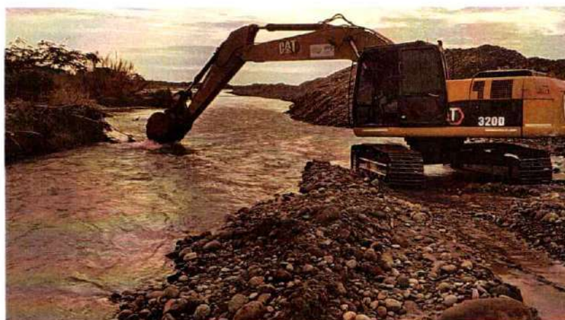
Imagen 592. Excavadora Caterpillar 320D #7 realizando actividades de canalización
