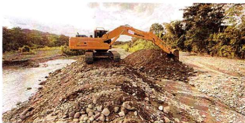
Imagen 560. Excavadora Shantui 220LC #2 realizando actividades de canalización y conformación de jarillón
