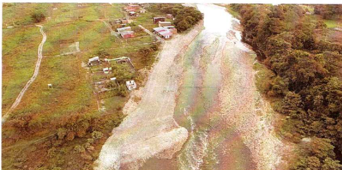
Imagen 423. Posterior a la intervención, Villavicencio – Villa Isabela II, Rio Ocoa
