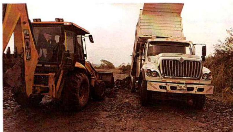
Imagen 309. Volqueta doble troque TSR 726 realizando actividades de transporte y descargue de material
