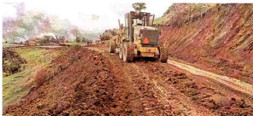
Imagen 635. Motoniveladora champion #4 realizando labores de extendido de material
