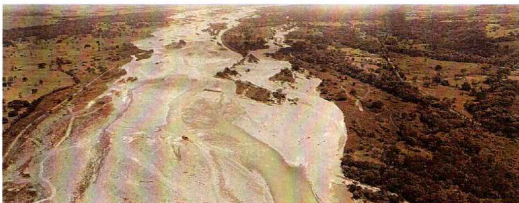
Imagen 503. Antes de la Intervención, Rio Ariari - Margen Derecha Puente La Amistad
