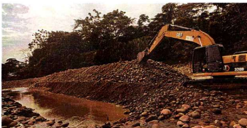
Imagen 381. Excavadora Caterpillar 320D #7 realizando actividades de canalización
