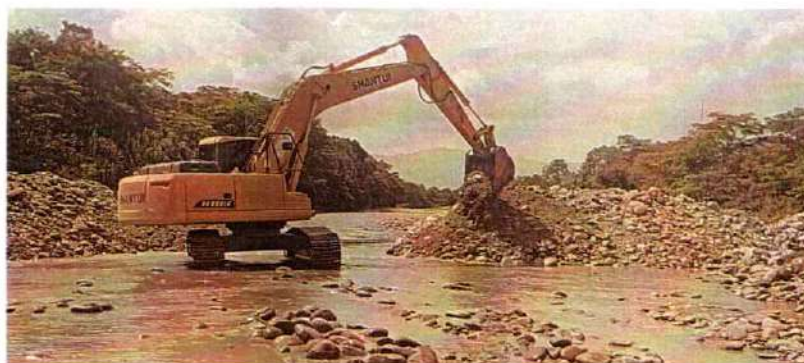
Imagen 425. Excavadora Shantui 220 #5 realizando actividades de canalización y conformación de jarillón
