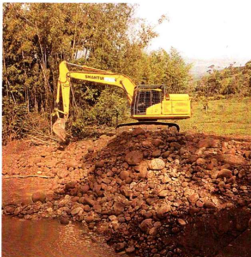
Imagen 567. Excavadora Shantui 220 #3 realizando actividades de canalización y protección del aproche del puente
