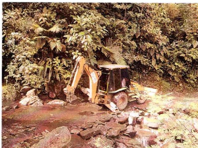
Imagen 499. Retroexcavadora Caterpillar 420D realizando actividades de mejoramiento de vía y limpieza de derribes
