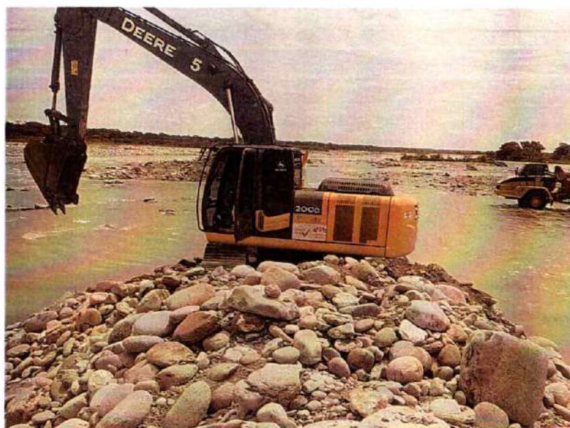
Imagen 514. Excavadora Jhon Deere 200LC realizando actividades de canalización y conformación de Jarillón
