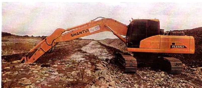
Imagen 582. Excavadora Shantui 220LC #4 realizando actividades de canalización
