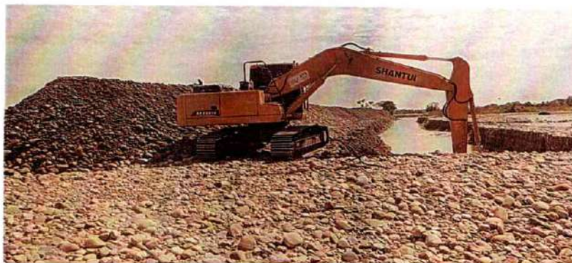
Imagen 606. Excavadora Shantui 220 #5 realizando actividades de excavación y conformación de jarillón
