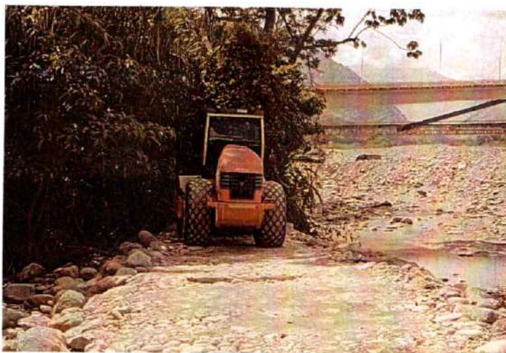
Imagen 531. Vibrocompactador Hamm #3 realizando actividades de compactación de jarillón
