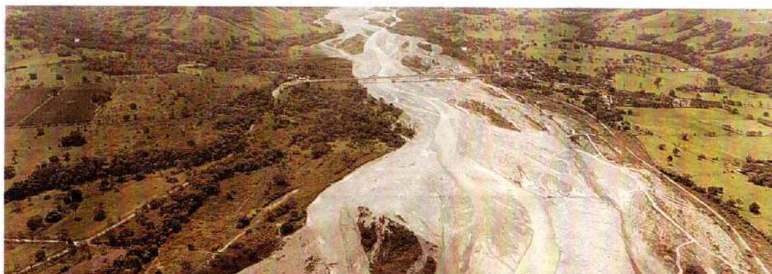
Imagen 505. Antes de la Intervención, Rio Ariari - Margen Derecha Puente La Amistad
