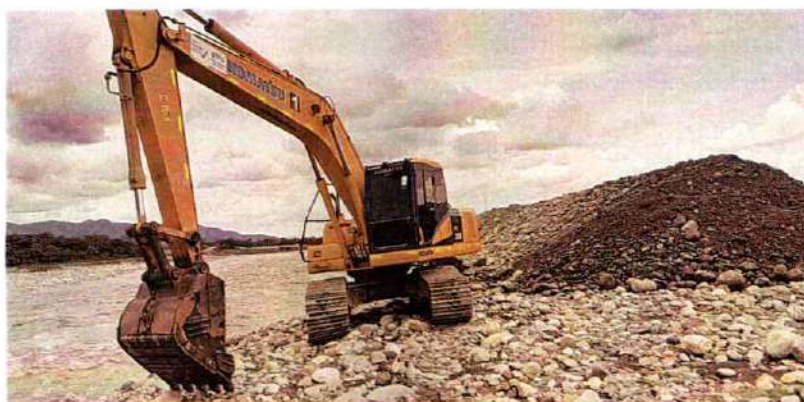
Imagen 492. Excavadora Komatsu PC 200LC #4 realizando actividades de extracción de material y conformación de jarillón
