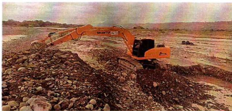
Imagen 579. Excavadora Shantui 220LC #4 realizando actividades de canalización
