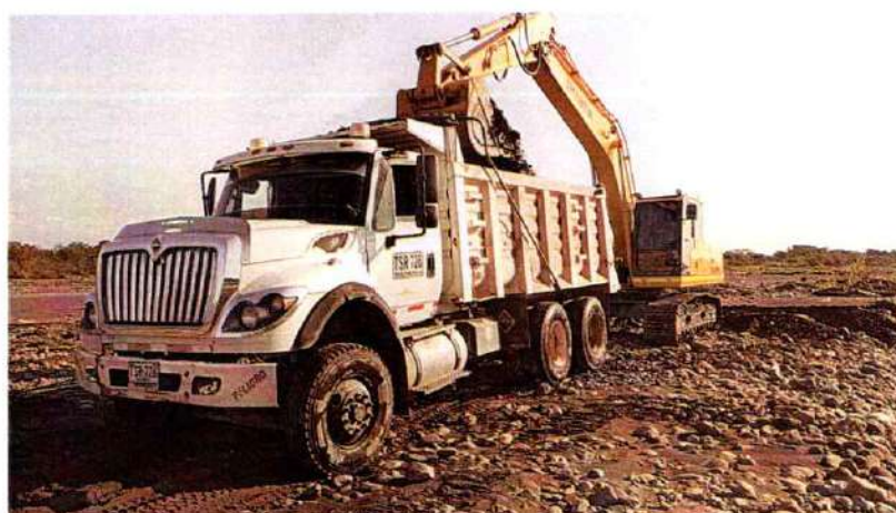
Imagen 308. Volqueta doble troque TSR 726 realizando actividades de transporte y descargue de material
