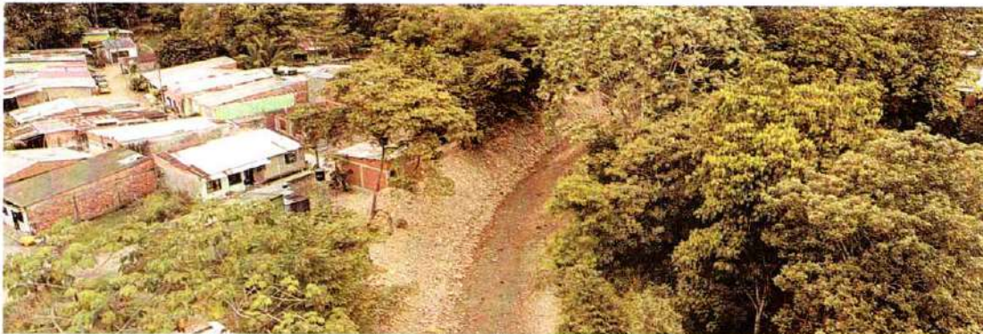
Imagen 409. Posterior a intervención, Villavicencio –Villa Del Paraíso, Rio Ocoa
