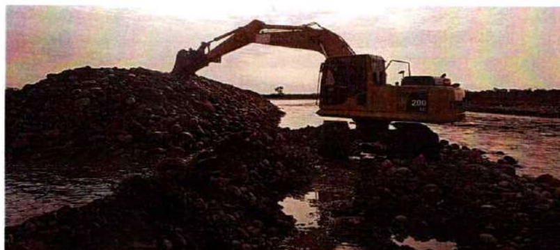
Imagen 483. Excavadora Orugada Komatsu PC200LC - 8 #3 realizando actividades de canalización
