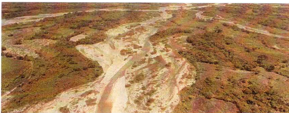
Imagen 536. Intervención realizada, El Castillo – Vereda La Unión, Rio Guape – Jarillón #1
