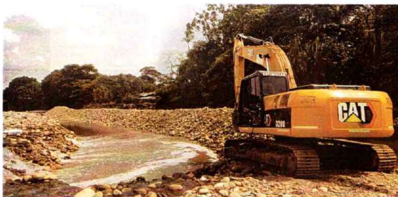
Imagen 380. Excavadora Caterpillar 320D #7 realizando actividades de canalización
