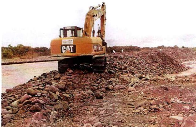
Imagen 322. Excavadora Caterpillar 320C #6 realizando excavación de canal
