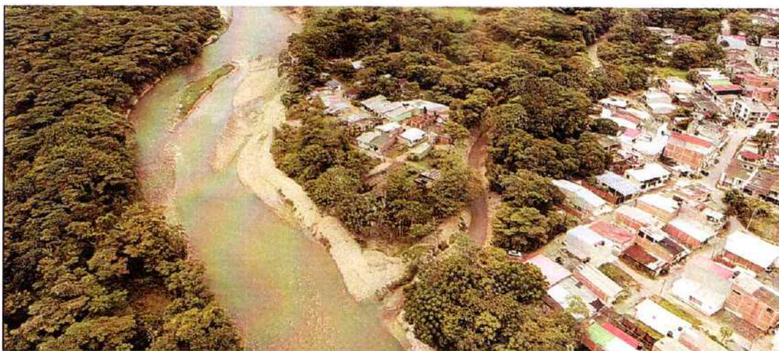
Imagen 411. Posterior a intervención, Villavicencio –Villa Del Paraíso, Rio Ocoa
