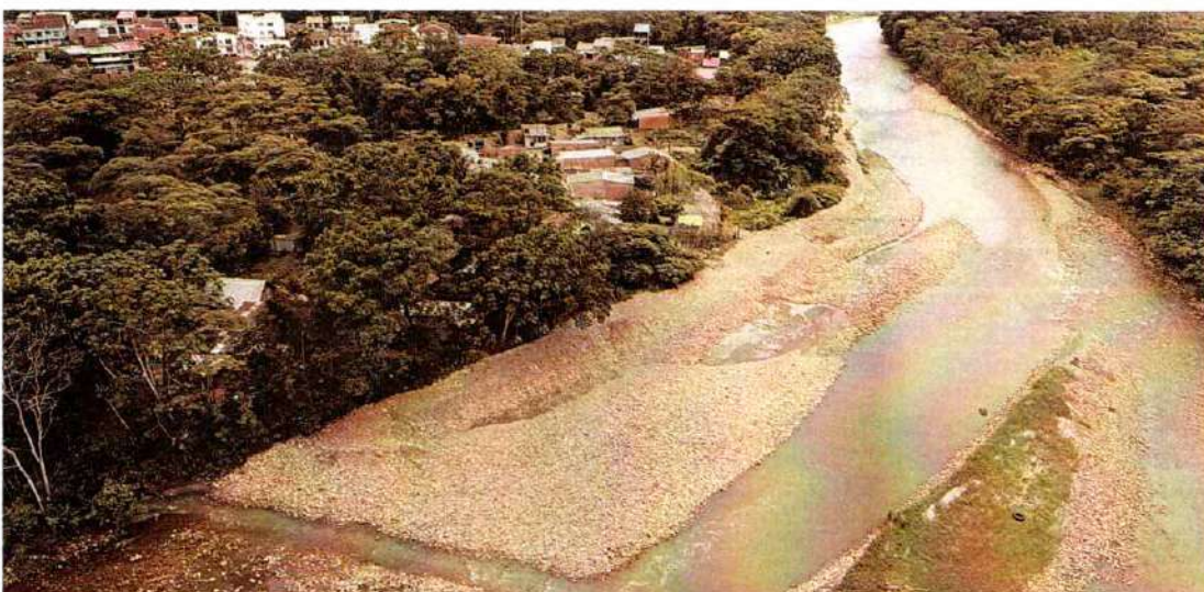
Imagen 412. Posterior a intervención, Villavicencio –Villa Del Paraíso, Rio Ocoa
