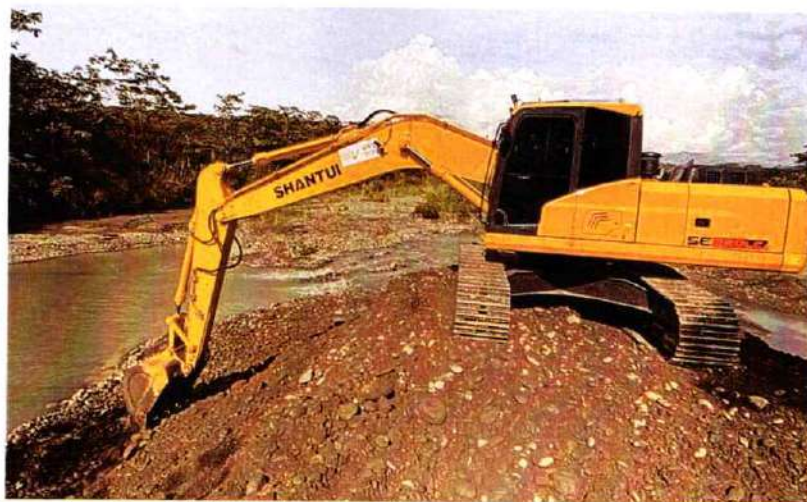
Imagen 558. Excavadora Shantui 220LC #2 realizando actividades de canalización y conformación de jarillón
