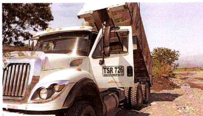
Imagen 306. Volqueta doble troque TSR 726 realizando actividades de transporte y descargue de material
