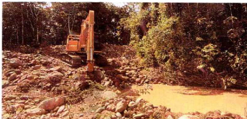
Imagen 570. Excavadora Shantui 220 #3 realizando actividades de canalización y protección del aproche del puente
