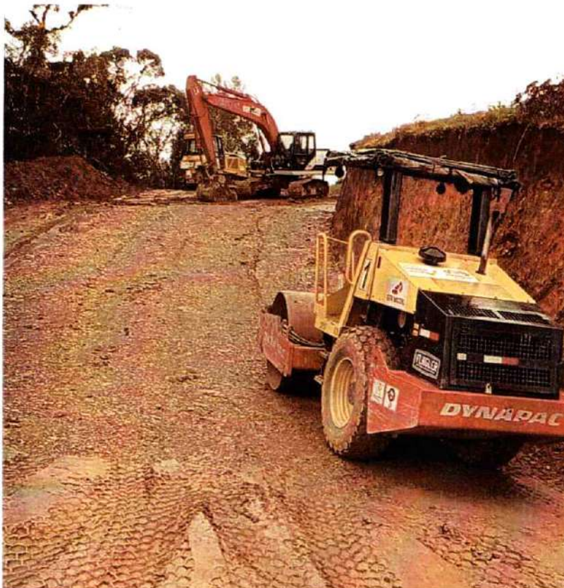
Imagen 633. Vibro compactador dynapac #1 realizando labores de compactación a la vía
