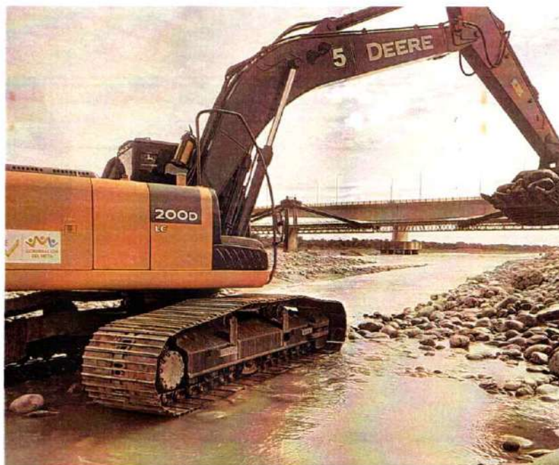
Imagen 512. Excavadora Jhon Deere 200LC realizando actividades de canalización y conformación de Jarillón
