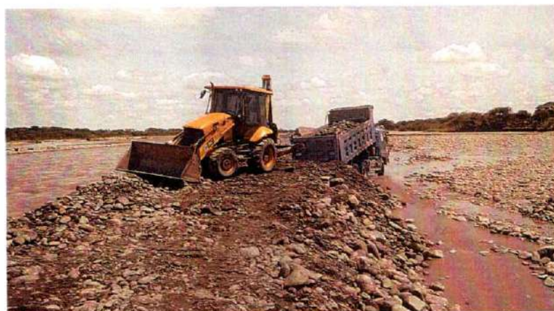
Imagen 311. Retroexcavadora JCB 3C realizando actividades de extendido de material para conformación de Jarillón
