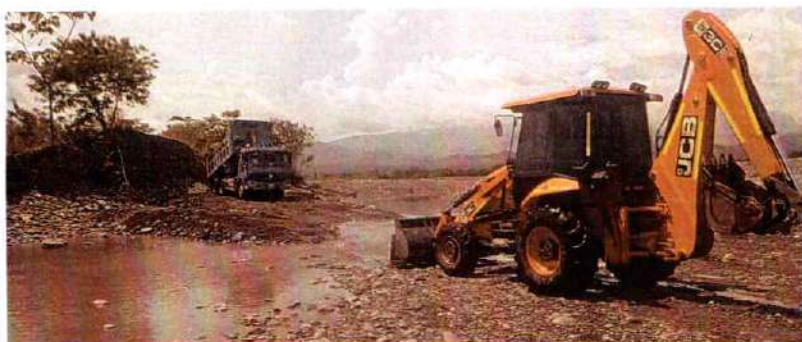
Imagen 310. Retroexcavadora JCB 3C realizando actividades de extendido de material para conformación de Jarillón
