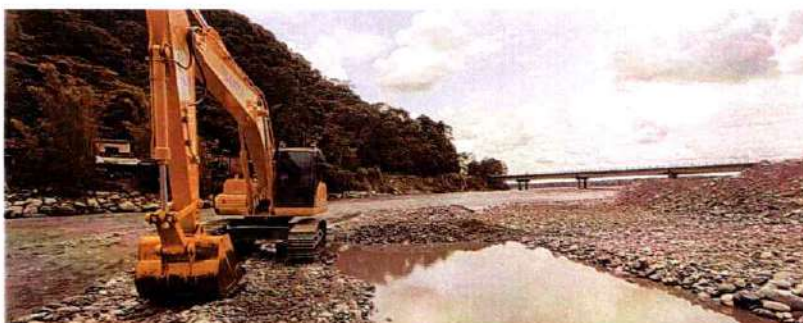
Imagen 468. Excavadora Shantui 220LC #1 realizando actividades de canalización y conformación de Jarillón
