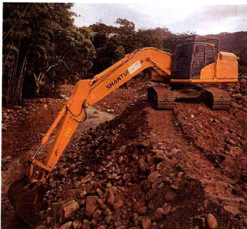
Imagen 568. Excavadora Shantui 220 #3 realizando actividades de canalización y protección del aproche del puente
