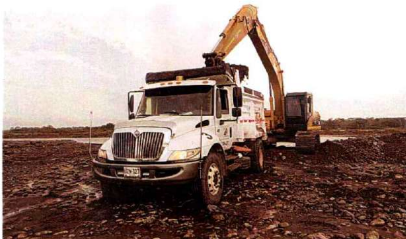
Imagen 362. Volqueta UZN 327 Realizando actividades de transporte y descarga de material
