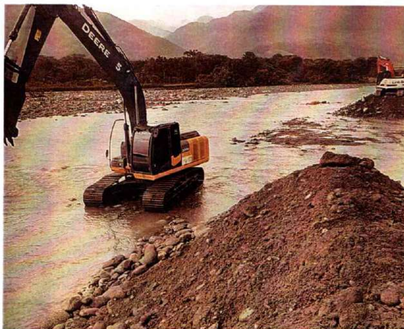
Imagen 513. Excavadora Jhon Deere 200LC realizando actividades de canalización y conformación de Jarillón
