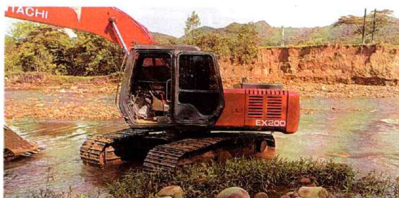
Imagen 400. Excavadora Hitachi 200 #3 realizando actividades de canalización y conformación de Jarillón
