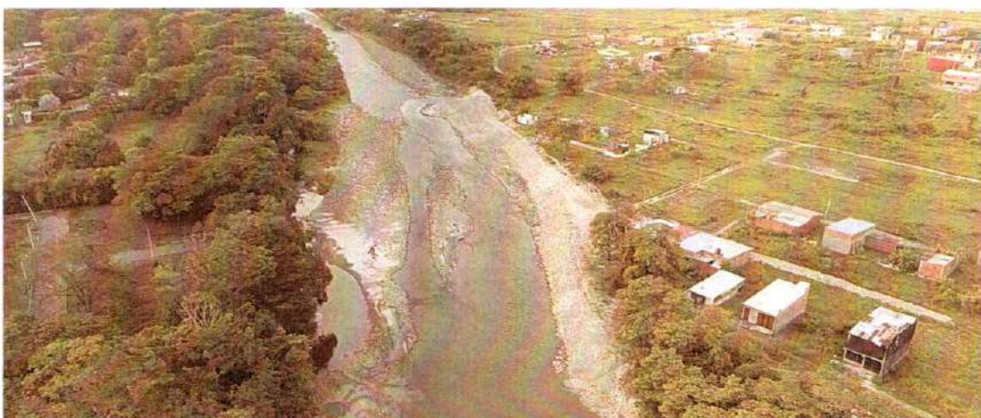
Imagen 422. Posterior a la intervención, Villavicencio – Villa Isabela II, Rio Ocoa
