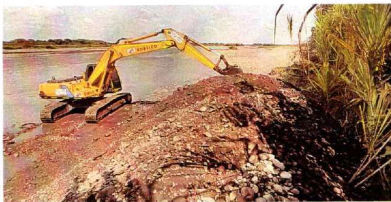
Imagen 331. Excavadora Kobelco SK200 #1 realizando actividades de conformación de jarillón
