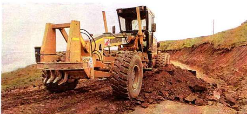
Imagen 637. Motoniveladora champion #4 realizando labores de extendido de material
