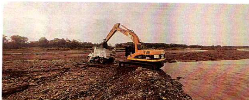
Imagen 356. Excavadora Caterpillar 320CL #5 realizando actividades de canalización y cargue de volquetas
