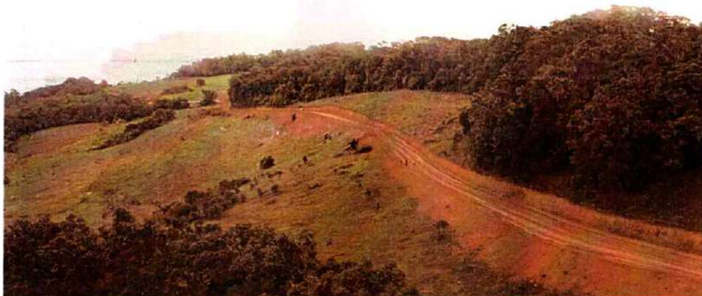
Imagen 613. Avance de la rehabilitación de la vía El Clavario - Monfort
