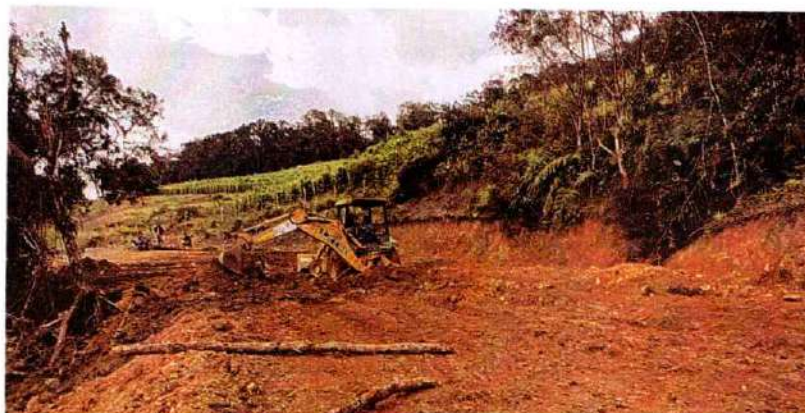
Imagen 630. Retroexcavadora John deere 310G realizando actividades de remoción de material y conformación de vía
