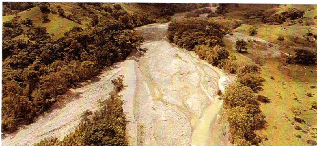
Imagen 546. Intervención realizada, El Castillo – Medellín Del Ariari, Rio Cumaral
