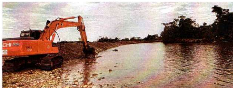
Imagen 439. Excavadora Hitachi 200 #4 realizando actividades de conformación de jarillón
