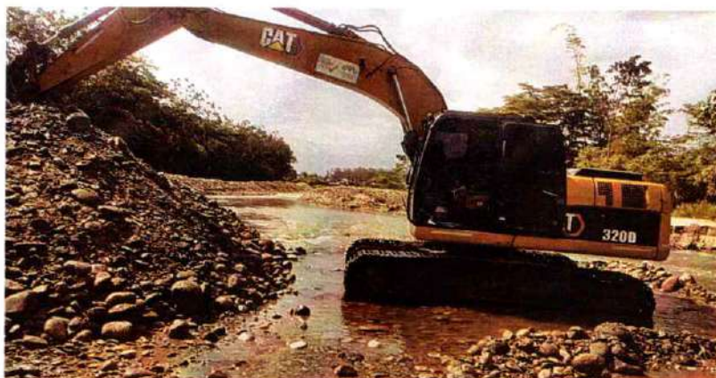
Imagen 382. Excavadora Caterpillar 320D #7 realizando actividades de canalización
