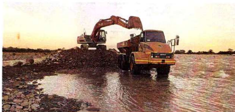
Imagen 523. Dumper Caterpillar 730 #1 realizando actividades de transporte y descargue de material
