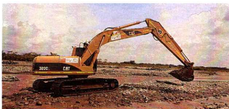
Imagen 354. Excavadora Caterpillar 320CL #5 realizando actividades de canalización y cargue de volquetas
