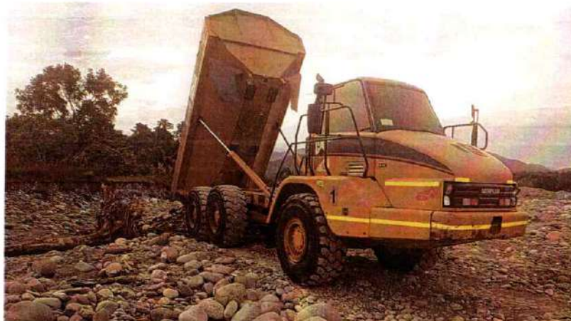
Imagen 520. Dumper Caterpillar 730 #1 realizando actividades de transporte y descargue de material
