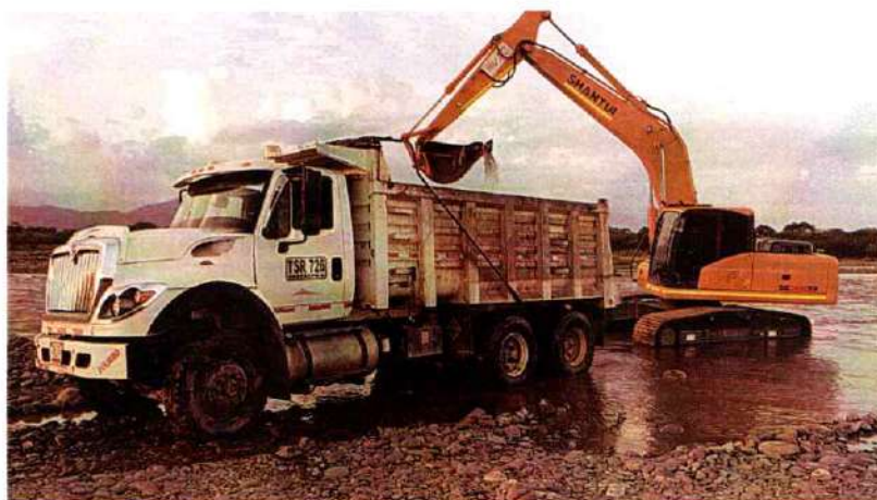
Imagen 307. Volqueta doble troque TSR 726 realizando actividades de transporte y descargue de material
