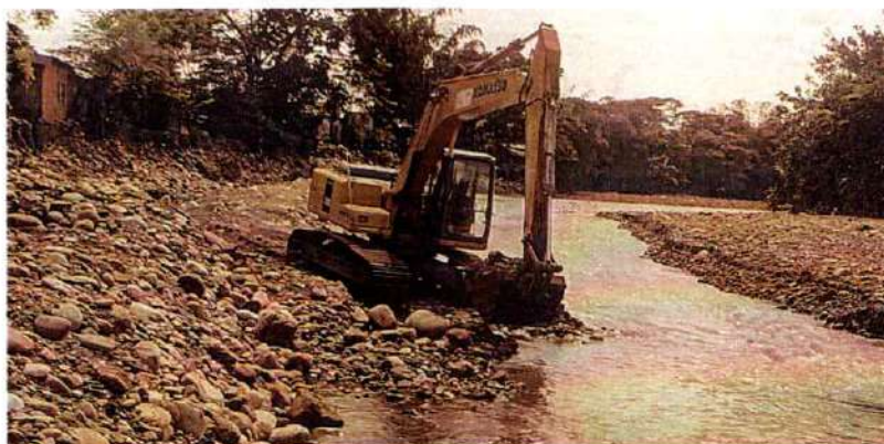
Imagen 392. Excavadora Oruga Komatsu 200 #2 realizando actividades de canalización y conformación de Jarillón
