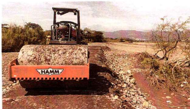
Imagen 315. Vibrocompactador Hamm #2 realizando actividades de compactación de jarillón
