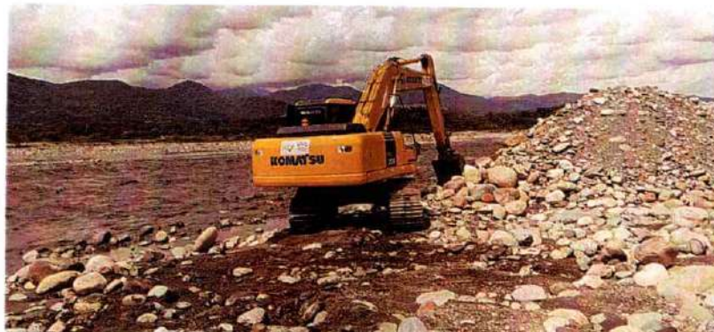
Imagen 493. Excavadora Komatsu PC 200LC #4 realizando actividades de extracción de material y conformación de jarillón
