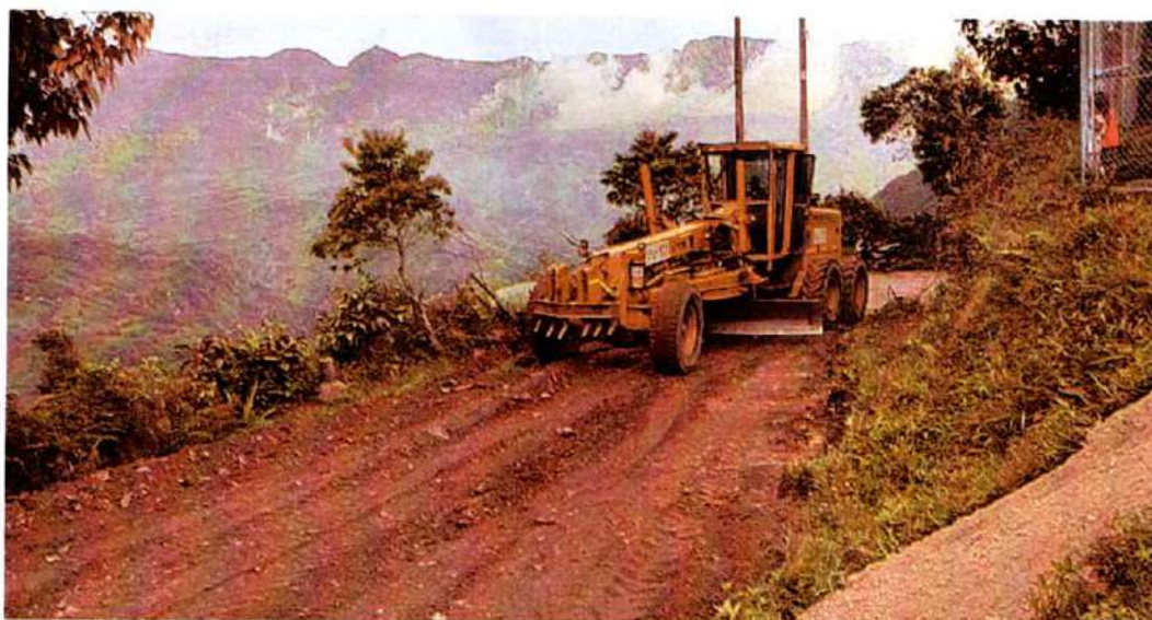
Imagen 641. Motoniveladora jhon deere #1 realizando labores de conformación y rehabilitación de vía
