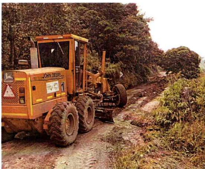
Imagen 640. Motoniveladora jhon deere #1 realizando labores de conformación y rehabilitación de vía
