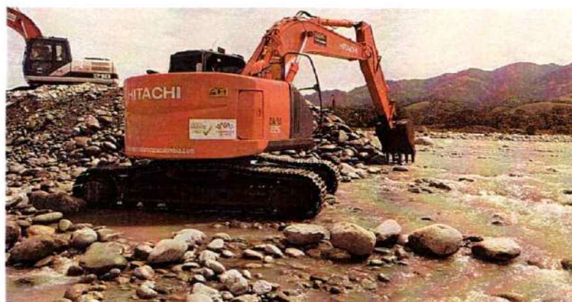
Imagen 519. Excavadora Hitachi 225 realizando actividades de canalización y conformación de jarillón
