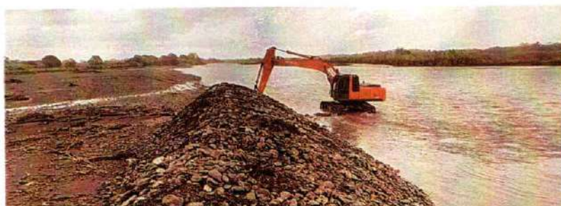
Imagen 335. Excavadora Hitachi Zaxis 200 #2 realizando actividades de conformación de jarillón
