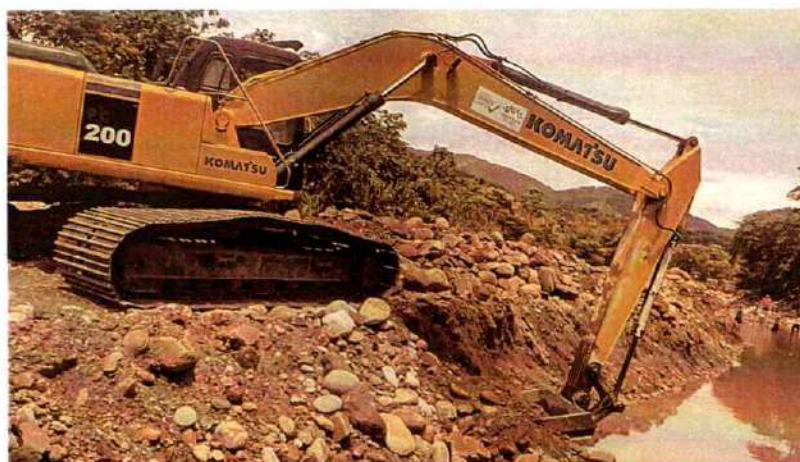
Imagen 393. Excavadora Oruga Komatsu 200 #2 realizando actividades de canalización y conformación de Jarillón
