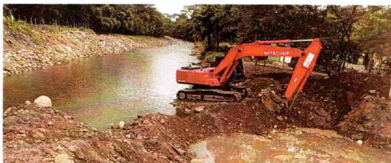
Imagen 401. Excavadora Hitachi 200 #3 realizando actividades de canalización y conformación de Jarillón
