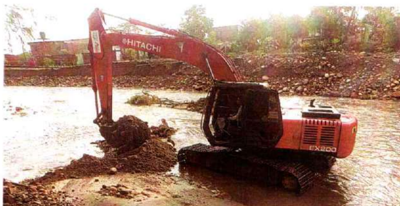
Imagen 402. Excavadora Hitachi 200 #3 realizando actividades de canalización y conformación de Jarillón
