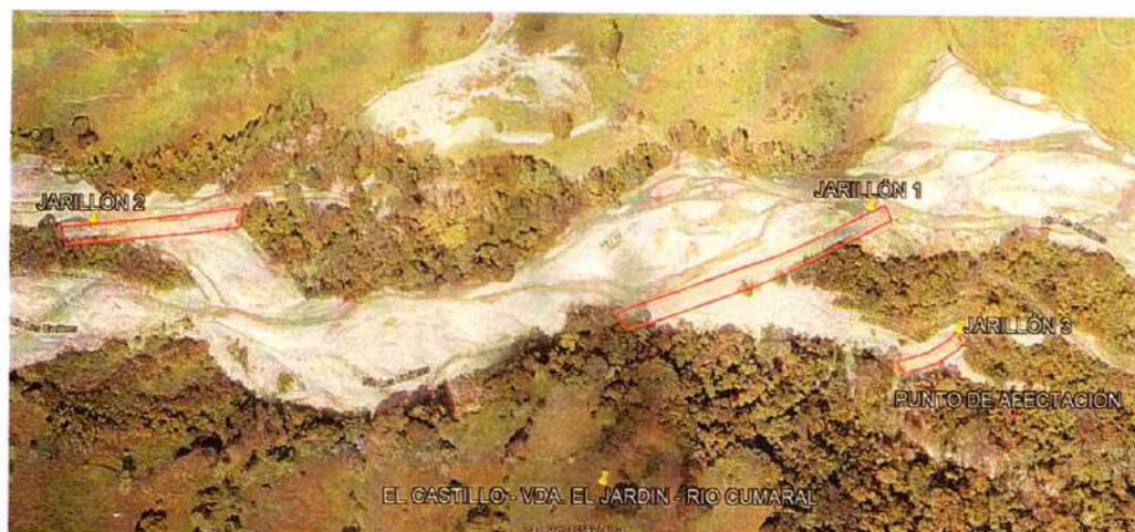
Imagen 544. Intervención realizada, El Castillo – Medellín Del Ariari, Rio Cumaral
