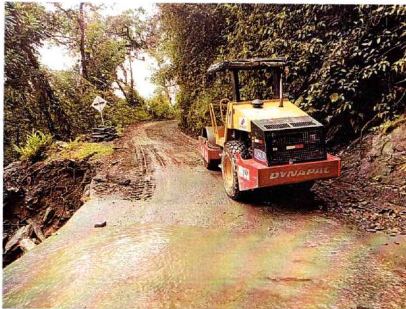
Imagen 632. Vibro compactador dynapac #1 realizando labores de compactación a la vía
