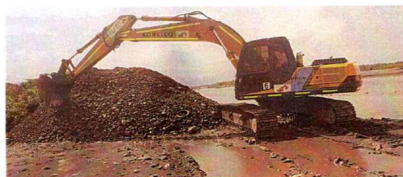
Imagen 333. Excavadora Kobelco SK200 #1 realizando actividades de conformación de jarillón
