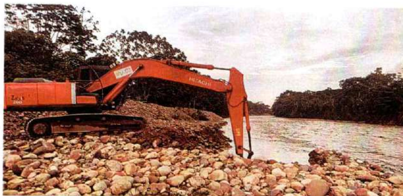
Imagen 417. Excavadora Hitachi 200 #2 realizando actividades de canalización y conformación de Jarillón
