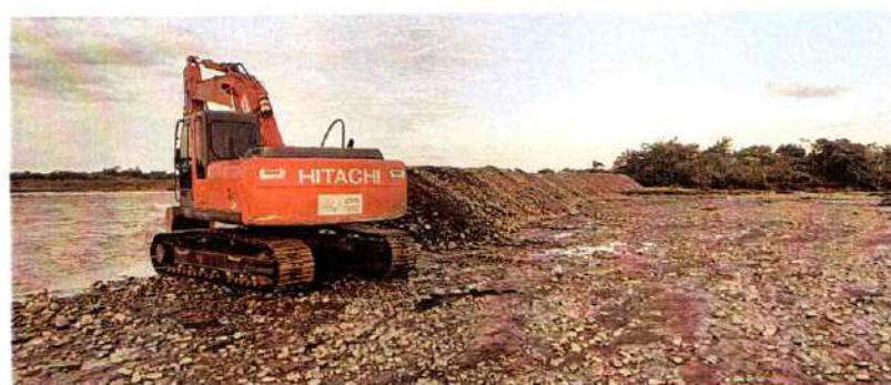
Imagen 336. Excavadora Hitachi Zaxis 200 #2 realizando actividades de conformación de jarillón
