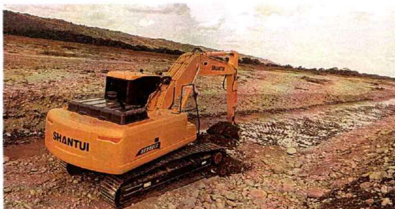
Imagen 581. Excavadora Shantui 220LC #4 realizando actividades de canalización
