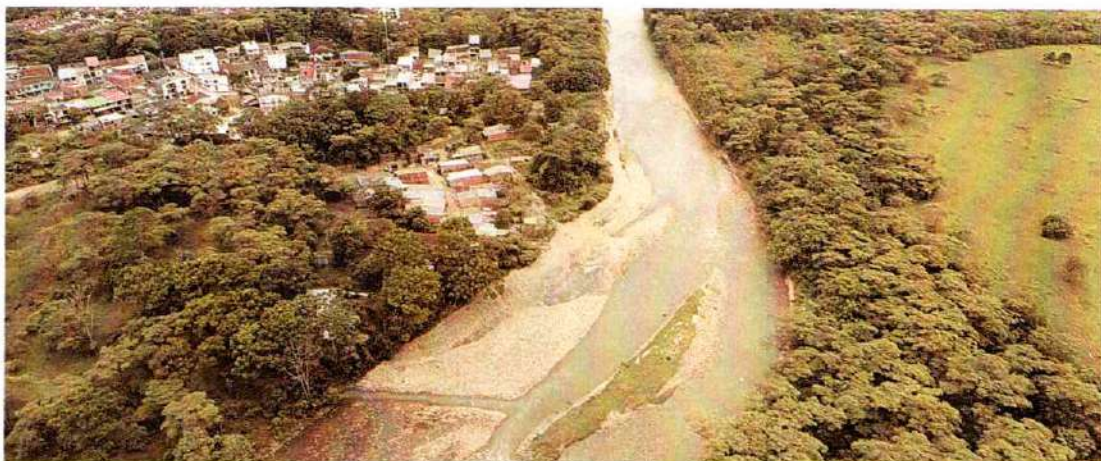
Imagen 410. Posterior a intervención, Villavicencio –Villa Del Paraíso, Rio Ocoa
