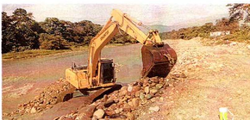
Imagen 428. Excavadora Shantui 220 #5 realizando actividades de canalización y conformación de jarillón
