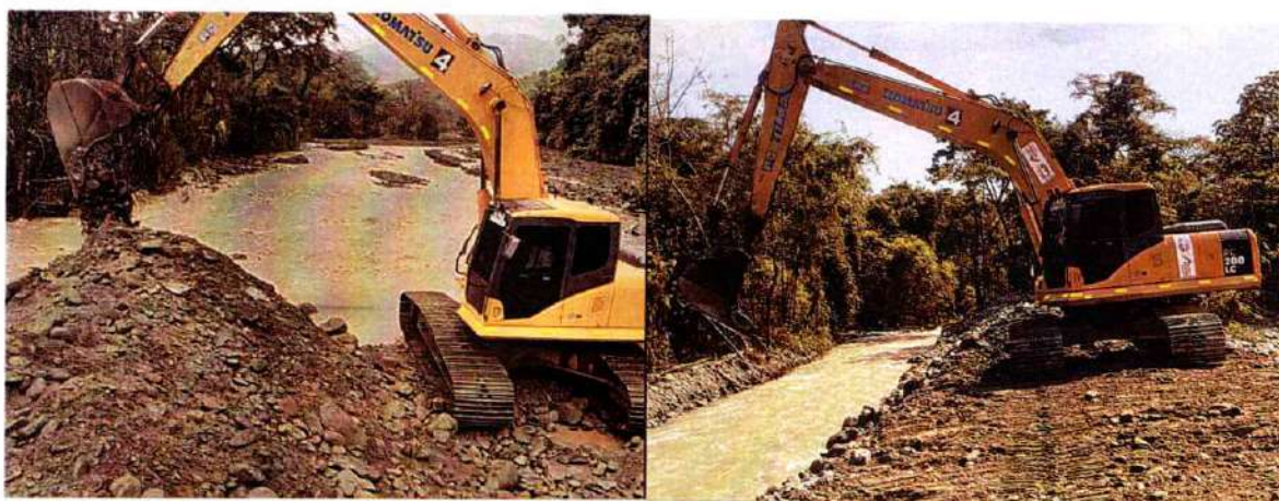
Imagen 549. Excavadora Komatsu #6 realizando actividades de excavación y conformación de jarillón
