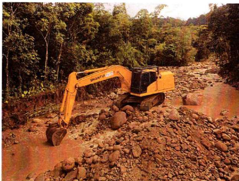
Imagen 569. Excavadora Shantui 220 #3 realizando actividades de canalización y protección del aproche del puente
