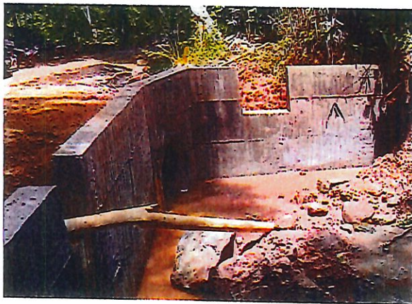
FOTO 17. FUNDICIÓN ALETAS, MURO PANTALLA Y BASE ENCOLE ALCANTARILLA No. 3
