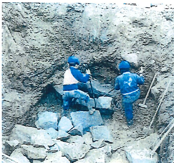
FOTO. EXCAVACION MANUAL DEL MURO
