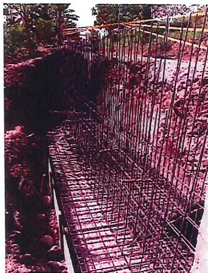
FOTO 17-18 INSTALACIÓN ACERO FIGURADO MURO No. 1
