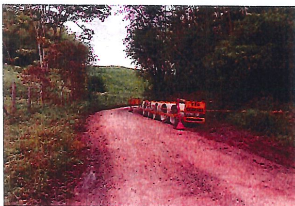
FOTO 3. ACOPIO DE TUBOS EN CONCRETO ALCANTARILLA No. 2
