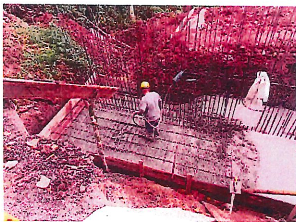
FOTO 23-24 FUNDICIÓN ESTRUCTURA BASE ALCANTARILLA No.2
