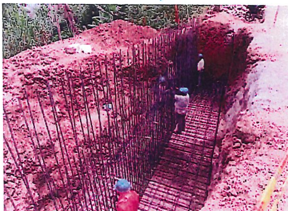
FOTO 17-18 INSTALACIÓN ACERO FIGURADO MURO No. 1
