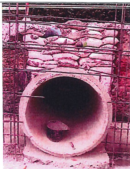
FOTO 25-26 INSTALACIÓN TUBERIA 36" ALCANTARILLADO No. 1
