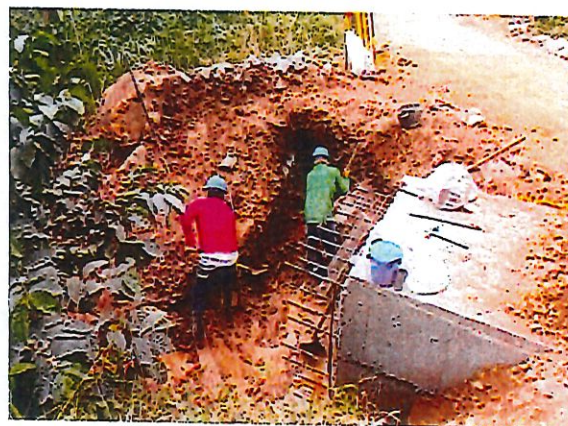
FOTO 2. EXCAVACIÓN MANUAL DESCOLE ALCANTARILLA No. 3
