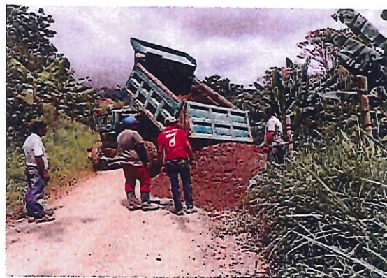
FOTO 4. DESCARGUE DE MATERIAL DE PLAYA
