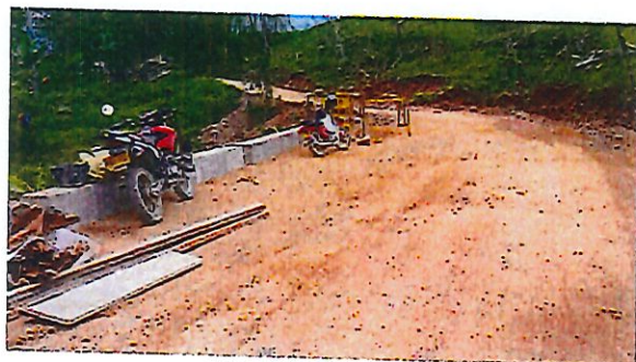
FOTO 21. CULMINACIÓN OBRA ALCANTARILLA No. 2
