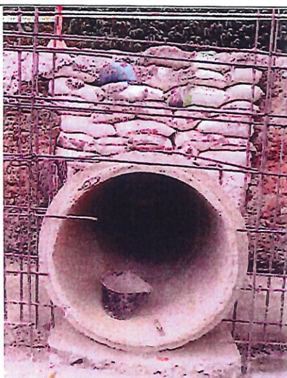
FOTO 25-26 INSTALACIÓN TUBERIA 36" ALCANTARILLADO No. 1
