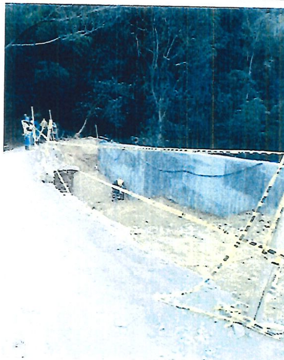
FOTO. CONCRETO DE 3000 PSI, PARA BASE DE ESTRUCTURA
