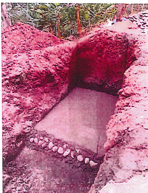
FOTO 13-14 FUNDICIÓN MEJORAMIENTO CICLOPEO MURO No. 1
