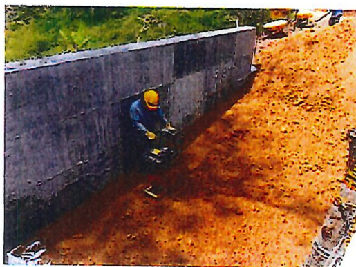
FOTO 7. RELLENO ALCANTARILLA No. 2
