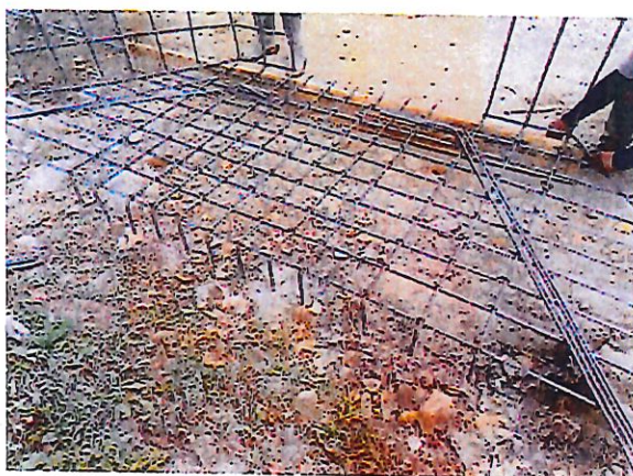
FOTO 1. FIGURACIÓN DE ACERO DESCOLE ALCANTARILLA No. 3
