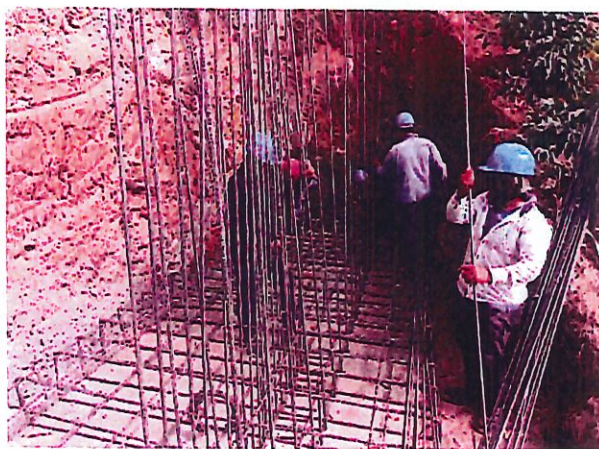
FOTO 19-20 INSTALACIÓN ACERO FIGURADO ALCANTARILLADO No. 1
