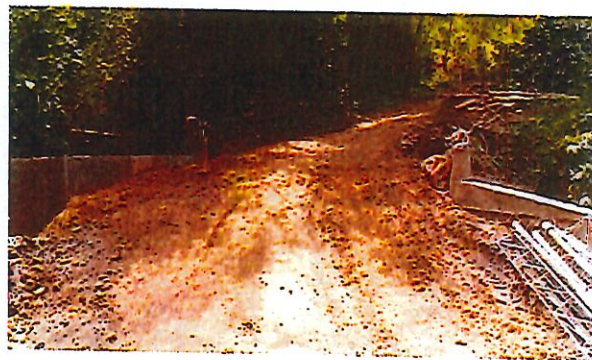
FOTO 18. RELLENO ALCANTARILLA No. 3
