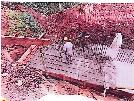
FOTO 23-24 FUNDICIÓN ESTRUCTURA BASE ALCANTARILLA No.2
