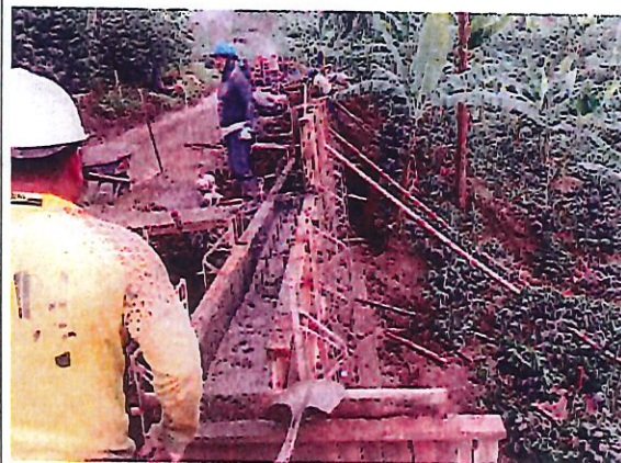
FOTO 28 FUNDICIÓN ESTRUCTURA ELEVADA MURO ALCANTARILLADO No. 1
