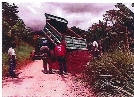
FOTO 4. DESCARGUE DE MATERIAL DE PLAYA
