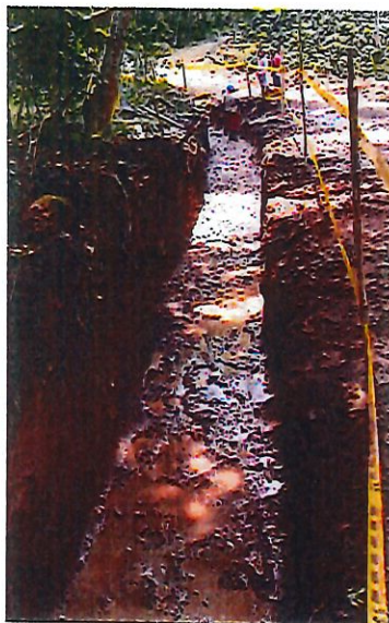
FOTO 11. EXCAVACIÓN MANUAL CANAL ALCANTARILLA No. 3
