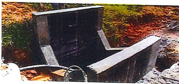
FOTO 19. FUNDICIÓN POCETA ALCANTARILLA No. 2
