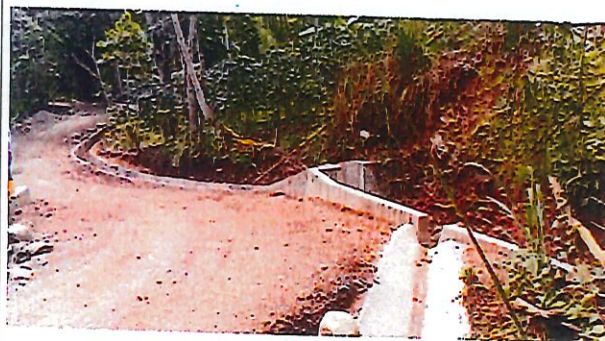
FOTO 22. CULMINACIÓN OBRA ALCANTARILLA No. 3
