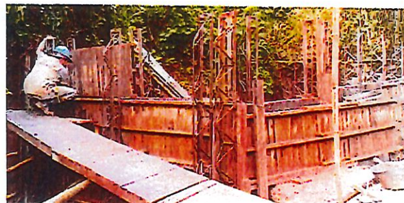
FOTO 14. ENCOFRADO ENCOLE ALCANTARILLA No. 3
