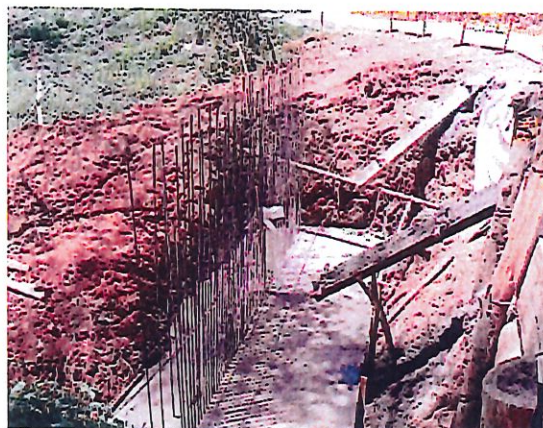
FOTO 23-24 FUNDICIÓN ESTRUCTURA BASE ALCANTARILLA No.2
