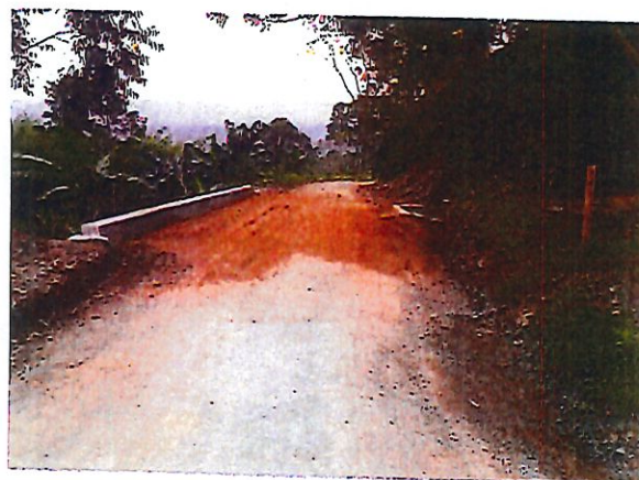
FOTO 22. CULMINACIÓN OBRA ALCANTARILLA No. 1
