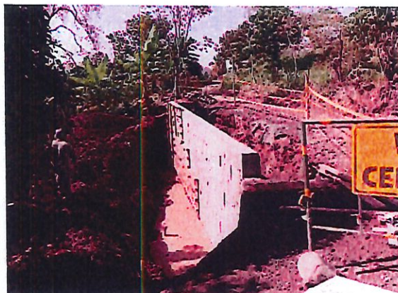
FOTO 31-32. FUNDICIÓN ESTRUCTURA ELEVADA POCETA MURO No. 1
