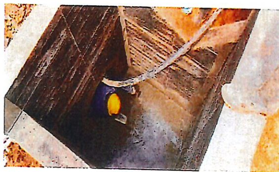
FOTO 20. FUNDICIÓN POCETA ALCANTARILLA No. 2
