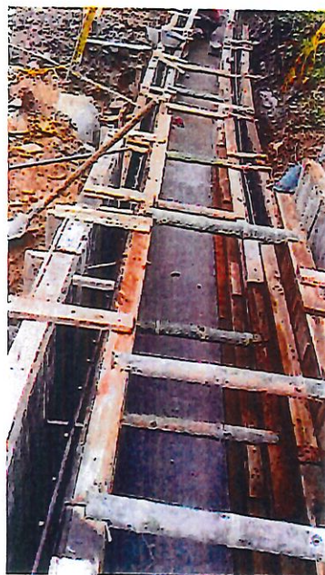
FOTO 15. ENCOFRADO CANAL ALCANTARILLA No. 3
