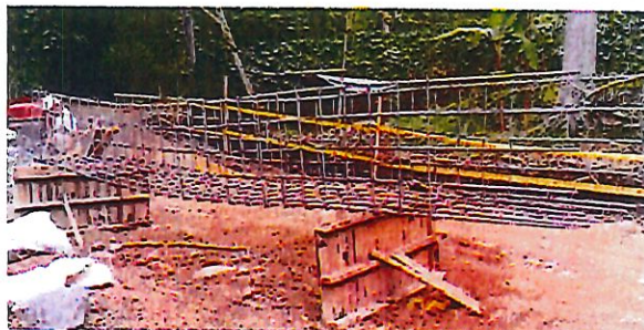
FOTO 13. FIGURACIÓN ACERO CANAL ALCANTARILLA No. 3
