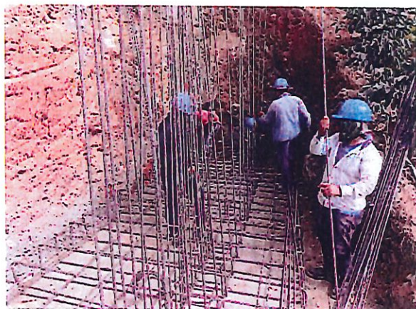
FOTO 19-20 INSTALACIÓN ACERO FIGURADO ALCANTARILLADO No. 1
