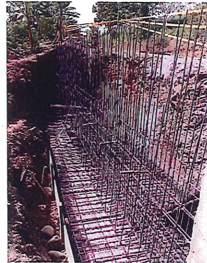
FOTO 17-18 INSTALACIÓN ACERO FIGURADO MURO No. 1
