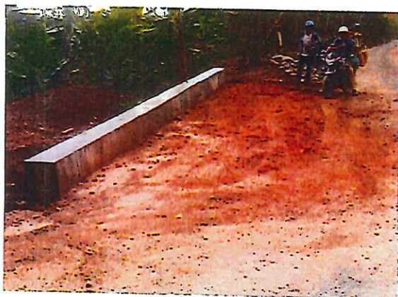
FOTO 21. CULMINACIÓN OBRA MURO No. 2
