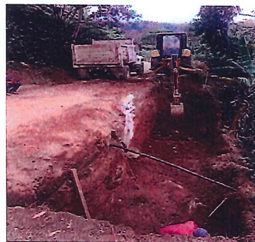
FOTO 9-10 EXCAVACIÓN ALCANTARILLADO No. 1
