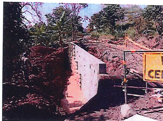
FOTO 31-32. FUNDICIÓN ESTRUCTURA ELEVADA POCETA MURO No. 1
