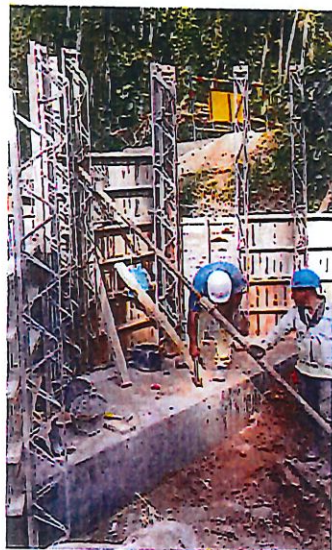
FOTO 3. ENCOFRADO DESCOLE ALCANTARILLA No. 3
