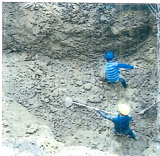
FOTO. EXCAVACION MANUAL DEL MURO
