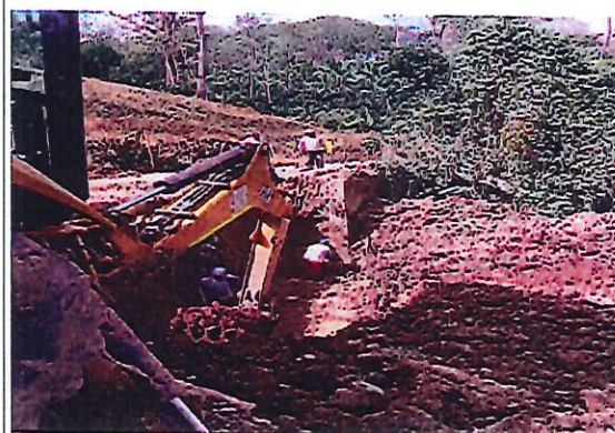
FOTO 7 - 8 EXCAVACION MURO No. 1
