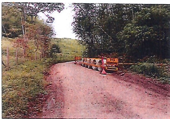
FOTO 3. ACOPIO DE TUBOS EN CONCRETO ALCANTARILLA No. 2
