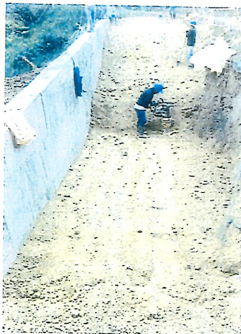
FOTO. CONCRETO DE 3000 PSI, PARA BASE DE ESTRUCTURA
