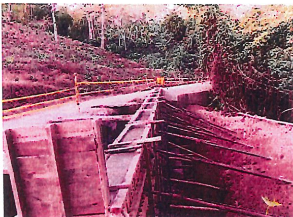
FOTO 31-32. FUNDICIÓN ESTRUCTURA ELEVADA POCETA MURO No. 1
