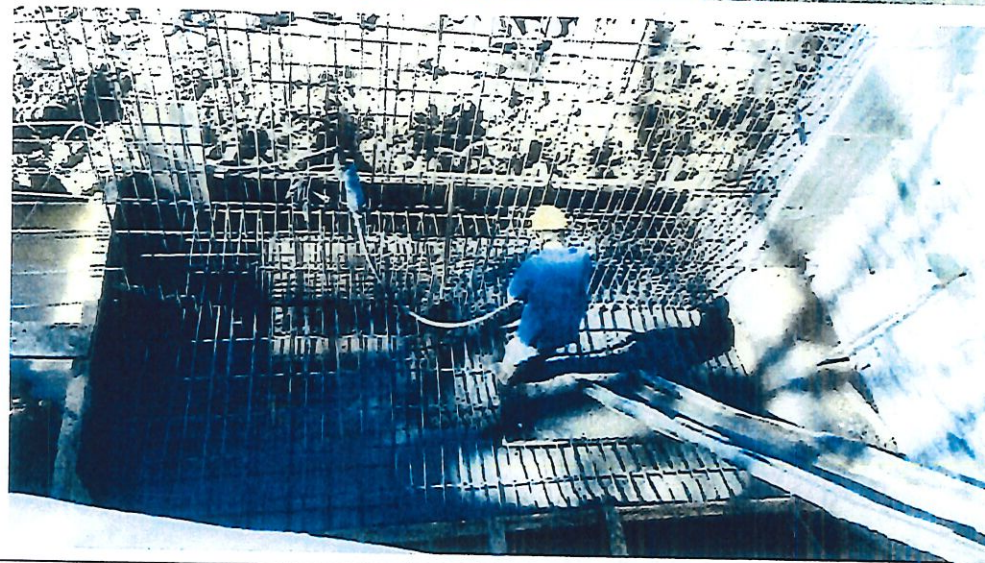
FOTO. AMARRE DE ACERO
