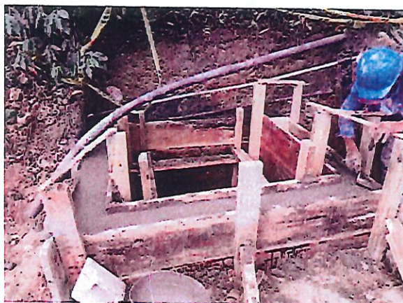
FOTO 27. FUNDICIÓN ESTRUCTURA ELEVADA POCETA ALCANTARILLADO No. 1
