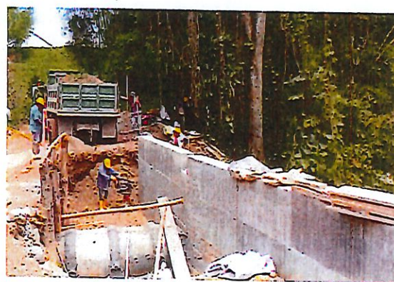
FOTO 8. RELLENO ALCANTARILLA No. 2
