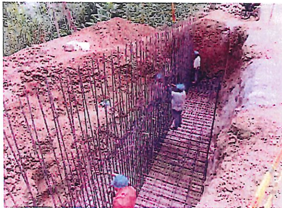
FOTO 17-18 INSTALACIÓN ACERO FIGURADO MURO No. 1
