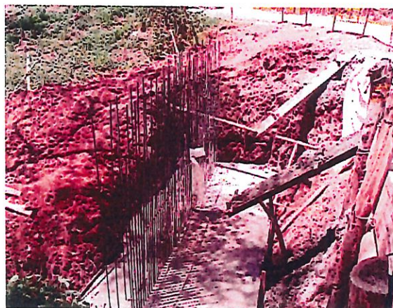
FOTO 23-24 FUNDICIÓN ESTRUCTURA BASE ALCANTARILLA No.2
