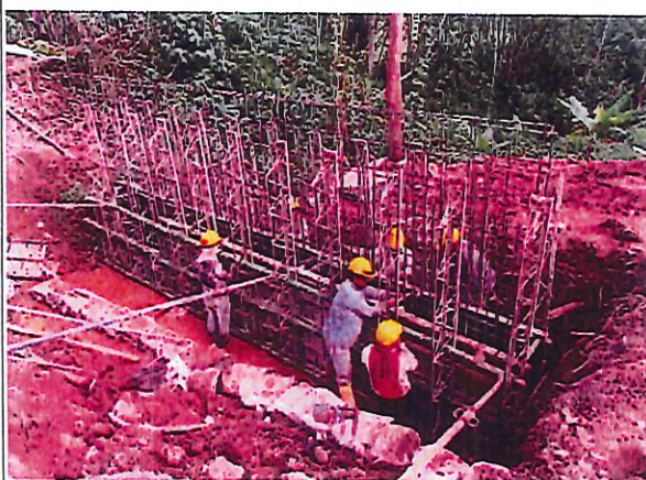
FOTO 29-30. FUNDICIÓN ESTRUCTURA ELEVADA ALCANTARILLADO No. 2
