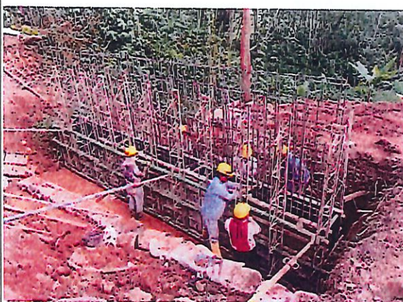
FOTO 29-30. FUNDICIÓN ESTRUCTURA ELEVADA ALCANTARILLADO No. 2
