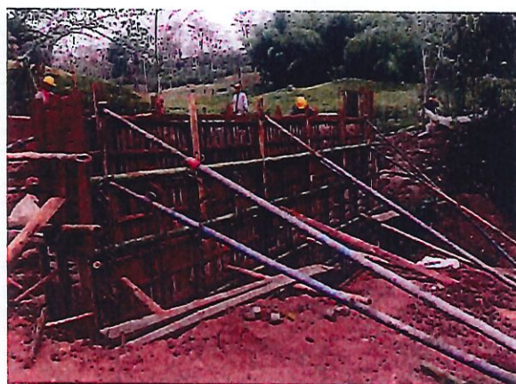
FOTO 29-30. FUNDICIÓN ESTRUCTURA ELEVADA ALCANTARILLADO No. 2
