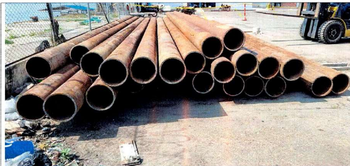
Descargue de tubería de pilotaje (30 de noviembre)
