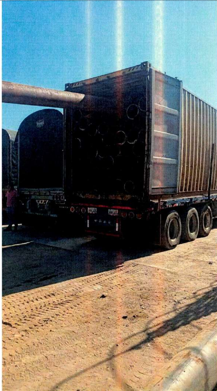
Descargue de tubería de pilotaje (20 de diciembre)
