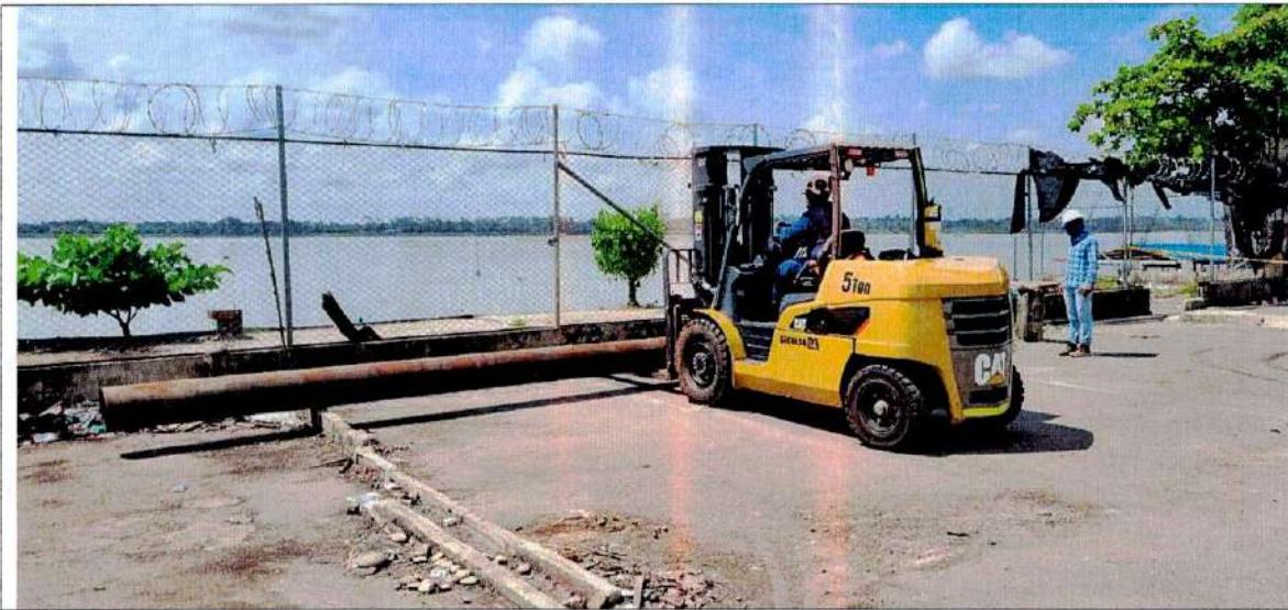
Descargue de tubería de pilotaje (30 de noviembre)
