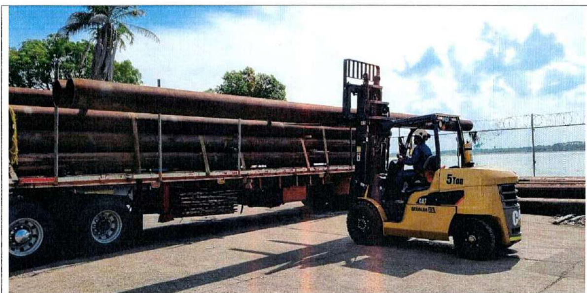
Descargue de tubería de pilotaje (30 de noviembre)
