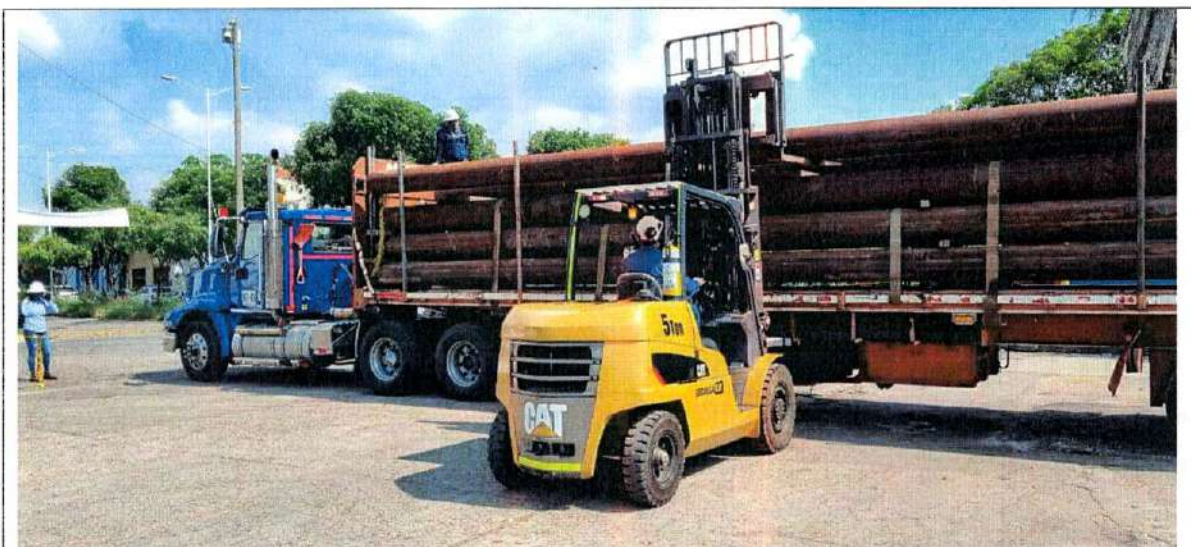
Descargue de tubería de pilotaje (30 de noviembre)
