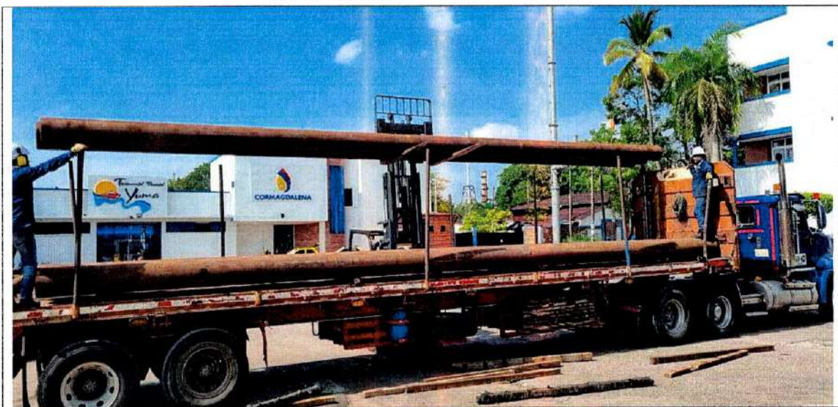
Descargue de tubería de pilotaje (30 de noviembre)
