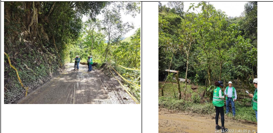
Recorridos por Obra con Interventoria
