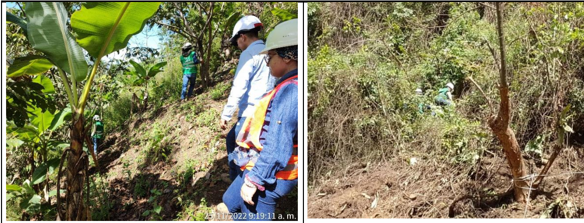
Recorrido en la parte alta del talud K3+435, para verificar cobertura vegetal de la zona alta
