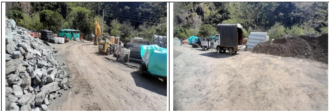
Patio de acopio de materiales e insumos
