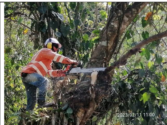
Tala de individuos dispuestos en cercos vivos K 6 + 060, para construcción de abovedado. Predio a la izquierda.
