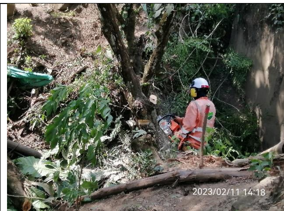
Tala de individuos dispuestos en cercos vivos K 6 + 060, para construcción de abovedado. Predio a la derecha.
