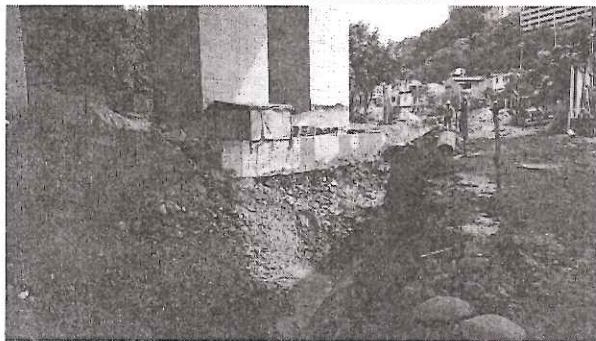
Figura 4. Vista de excavación exponiendo la pila del puente García Cadena y los taludes contiguos
