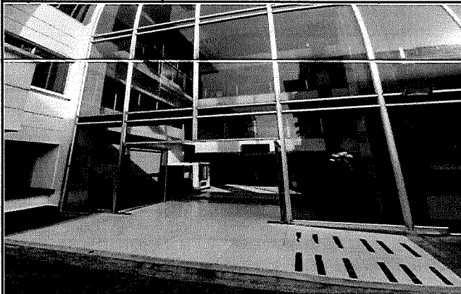
(Acceso Area donde esta ubicadas las maquinas )
