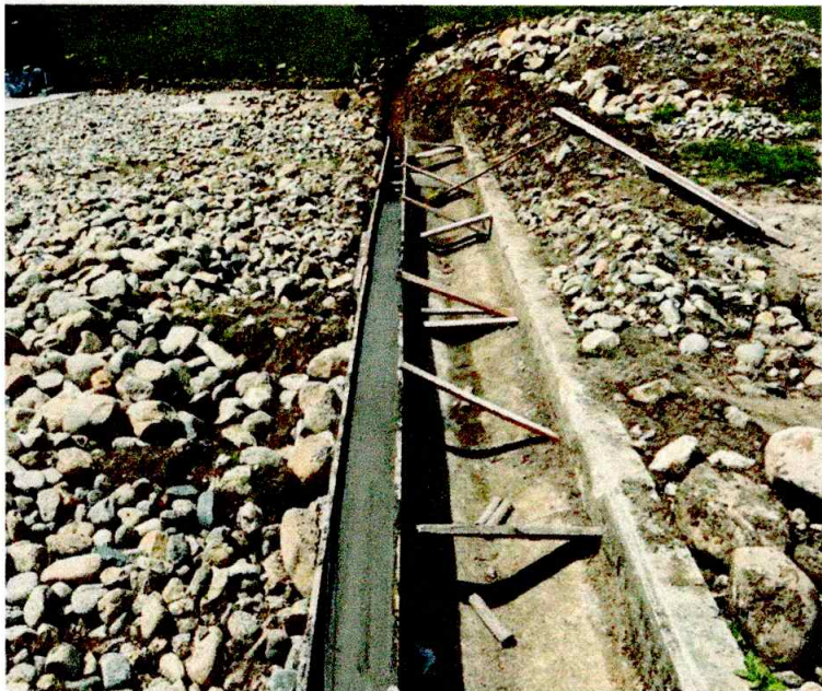
CONSTRUCCION DE CANCHA DE TEJO (VILLA OLIMPICA)
