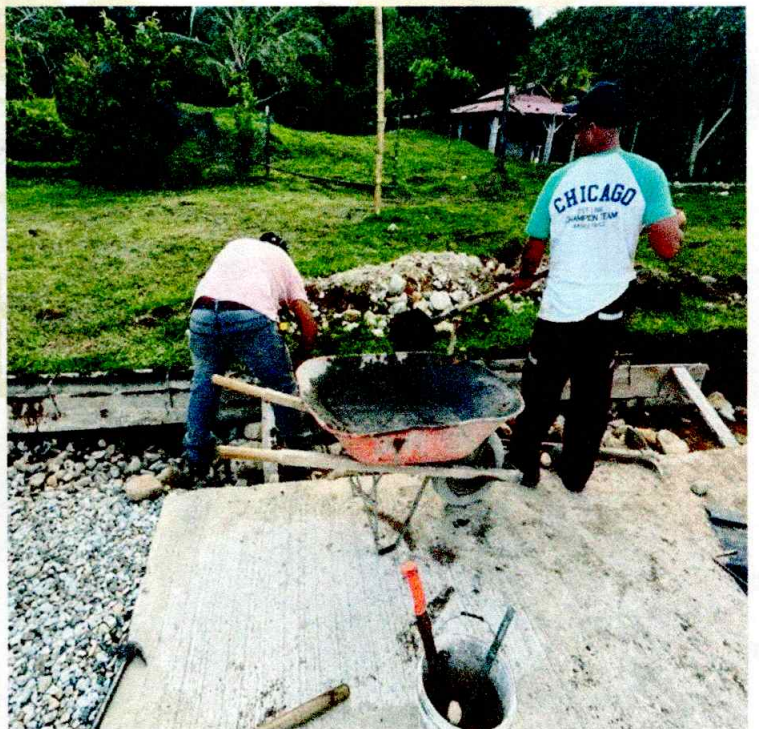
CONSTRUCCION DE CANCHA DE TEJO (VILLA OLIMPICA)
