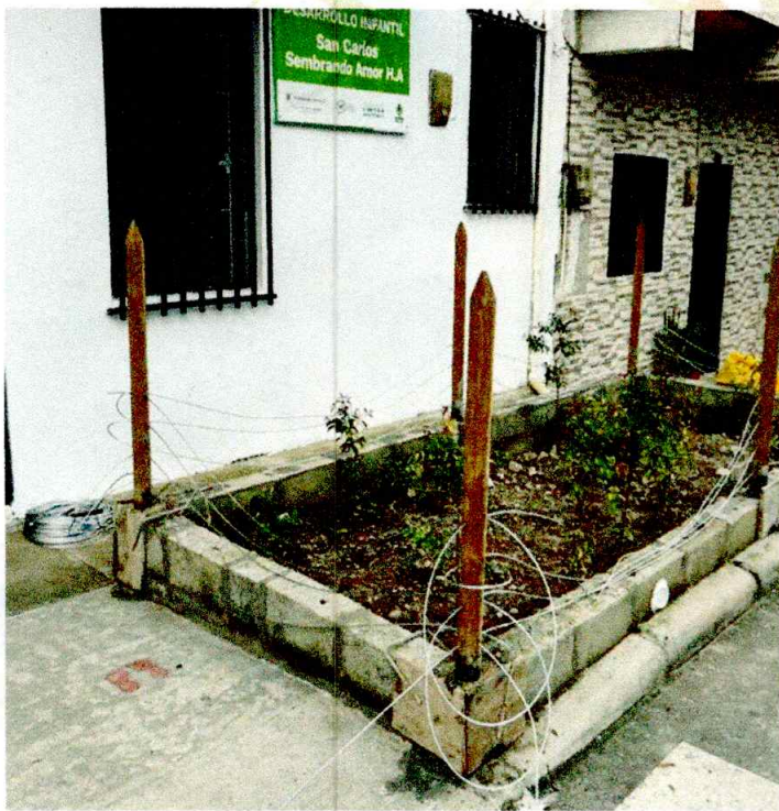
CONSTRUCCION DE CERRAMIENTO
