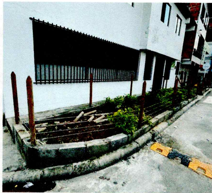
CONSTRUCCION DE CERRAMIENTO
