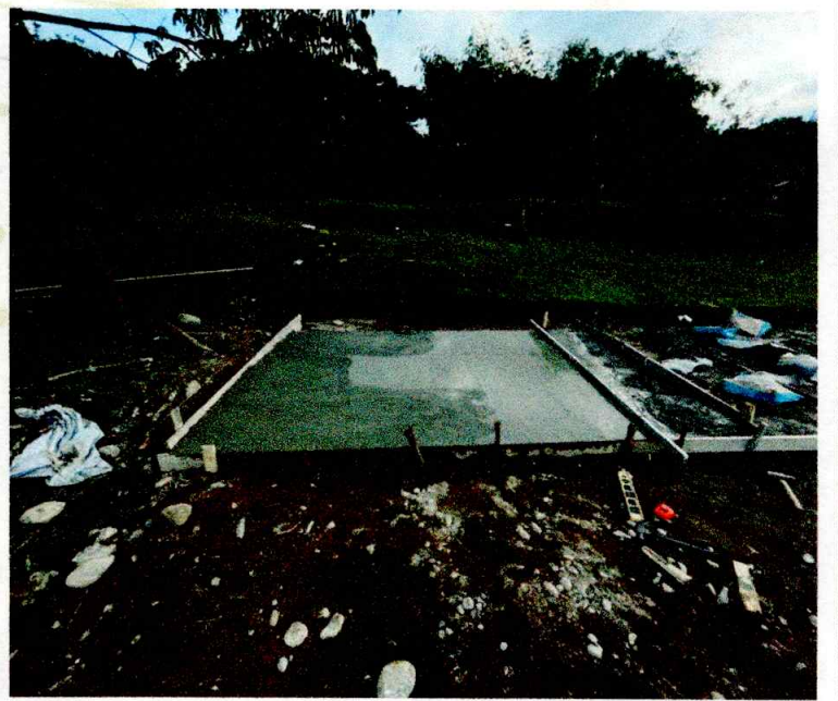
CONSTRUCCION DE CANCHA DE TEJO (VILLA OLIMPICA)
