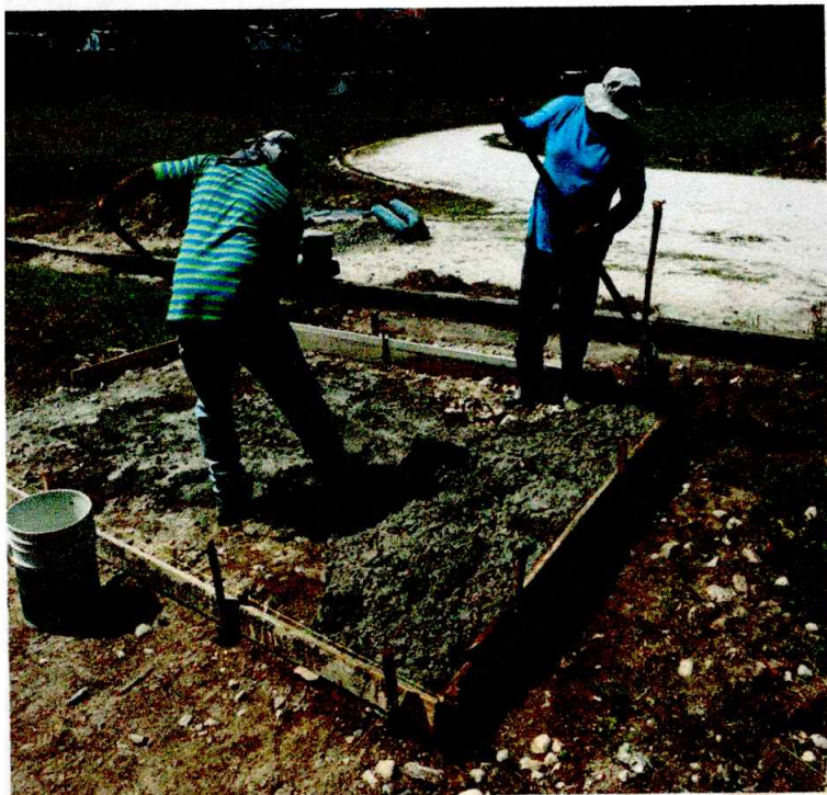
CONSTRUCCION DE CANCHA DE TEJO (VILLA OLIMPICA)
