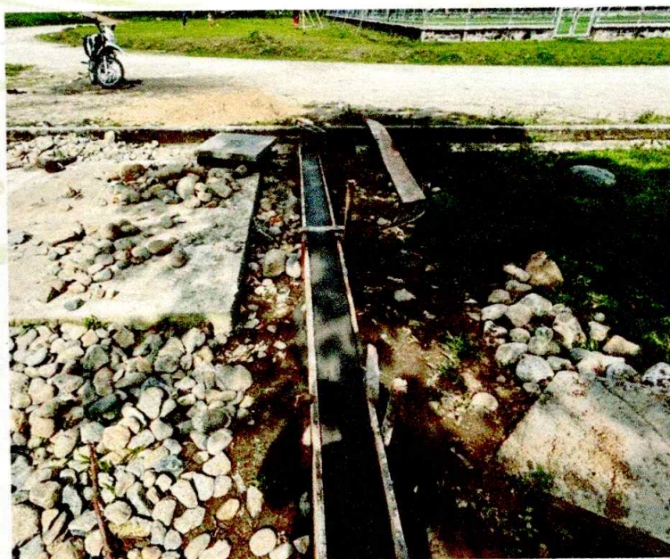
CONSTRUCCION DE CANCHA DE TEJO (VILLA OLIMPICA)
