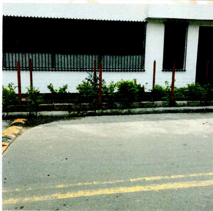
CONSTRUCCION DE CERRAMIENTO
