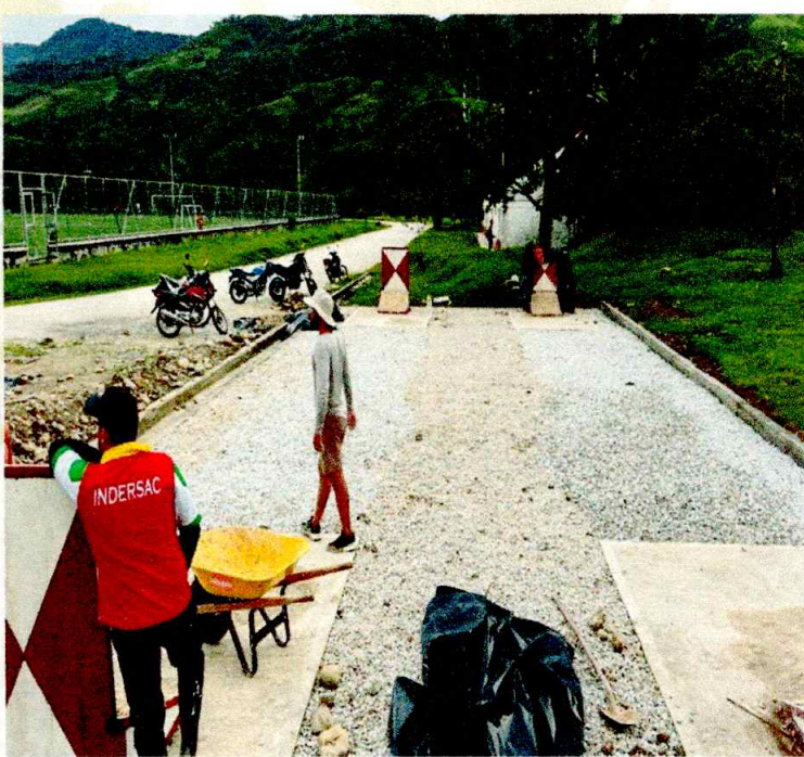
CONSTRUCCION DE CANCHA DE TEJO (VILLA OLIMPICA)
