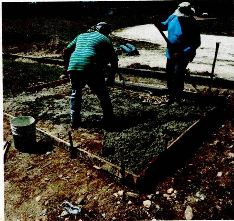
CONSTRUCCION DE CANCHA DE TEJO (VILLA OLIMPICA)
