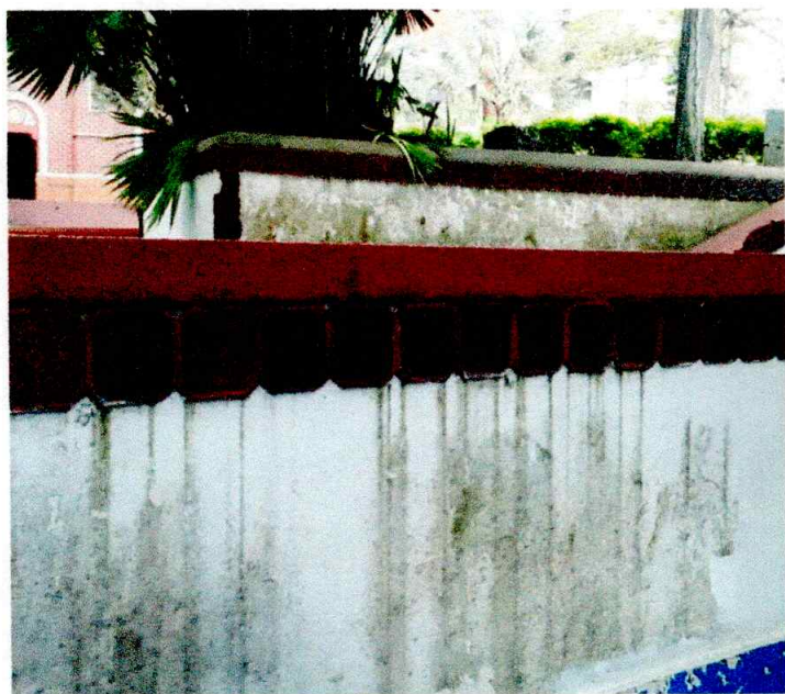
MANTENIMIENTO PARQUE PRINCIPAL
