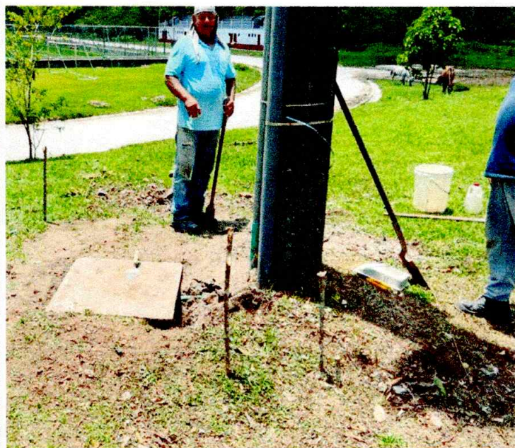
CONSTRUCCION DE CERRAMIENTO
