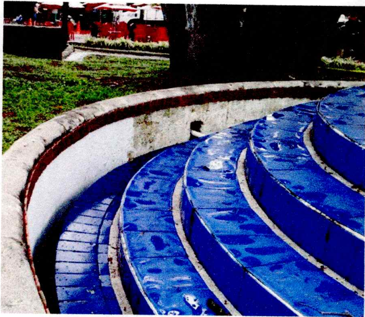
MANTENIMIENTO PARQUE PRINCIPAL
