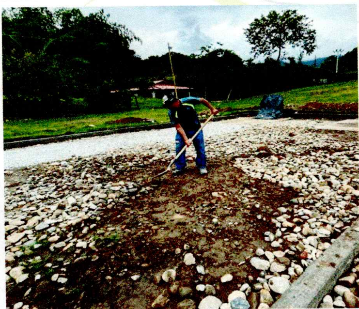
CONSTRUCCION DE CANCHA DE TEJO (VILLA OLIMPICA)
