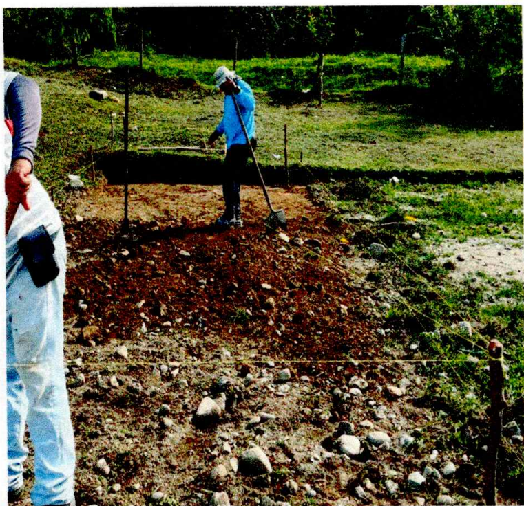
CONSTRUCCION DE CANCHA DE TEJO (VILLA OLIMPICA)
