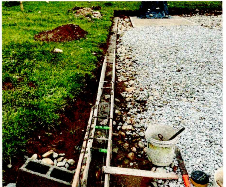
CONSTRUCCION DE CANCHA DE TEJO (VILLA OLIMPICA)
