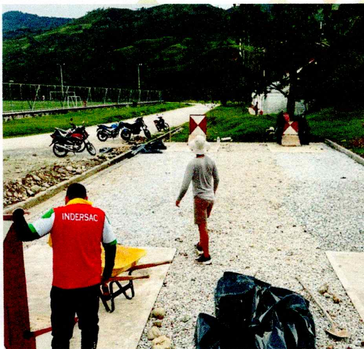
CONSTRUCCION DE CANCHA DE TEJO (VILLA OLIMPICA)
