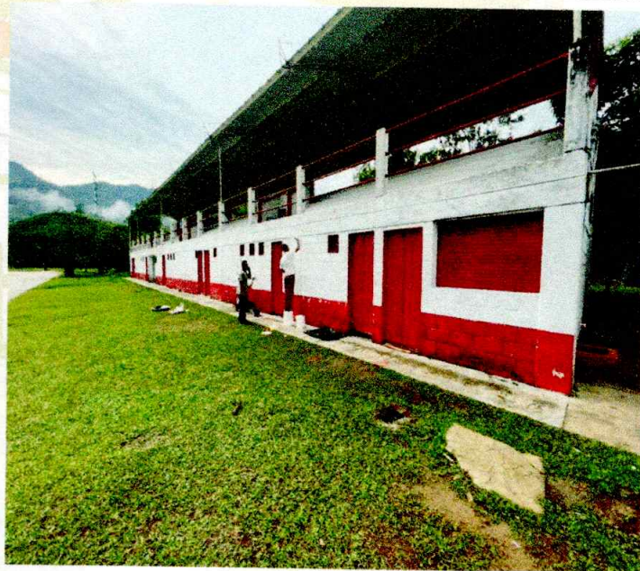
ADECUACIONES VILLA OLIMPICA
