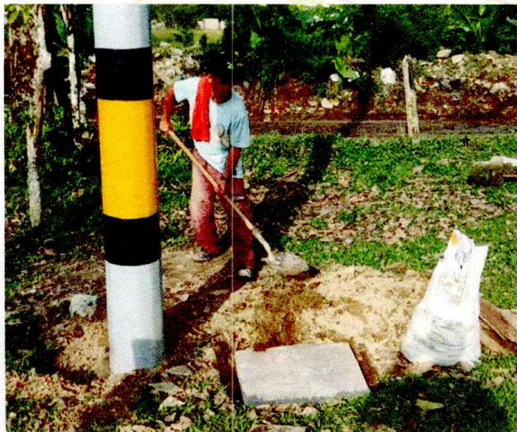
CONSTRUCCION DE TAPAS EN CONCRETO
