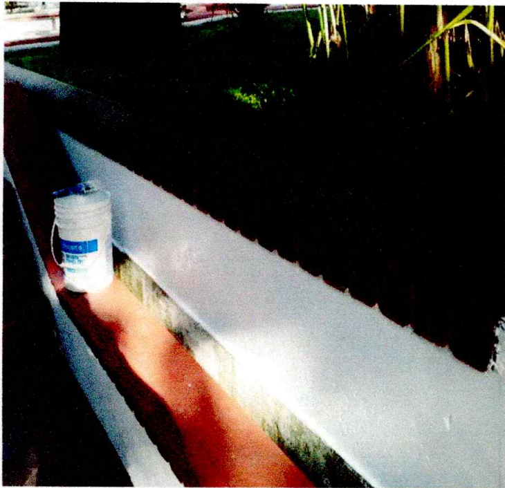
MANTENIMIENTO PARQUE PRINCIPAL
