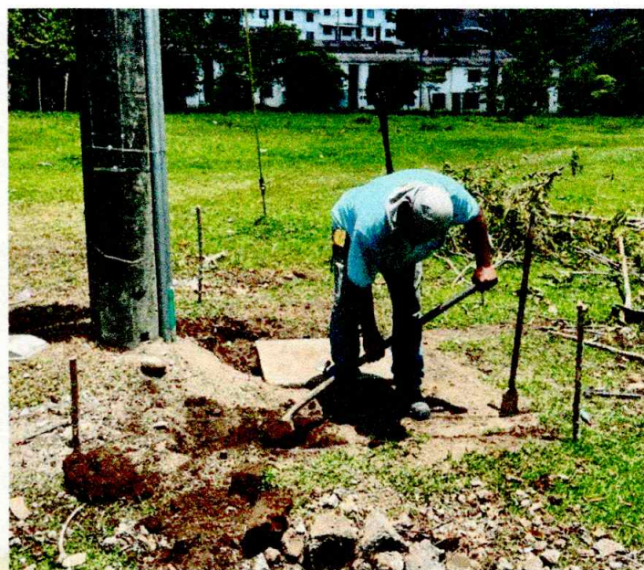
CONSTRUCCION DE CERRAMIENTO
