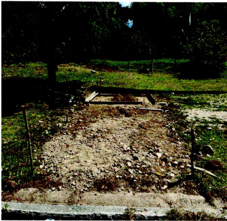
CONSTRUCCION DE CANCHA DE TEJO (VILLA OLIMPICA)
