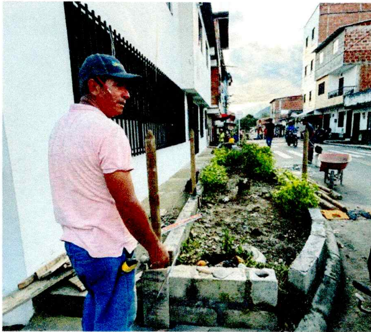
CONSTRUCCION DE CERRAMIENTO
