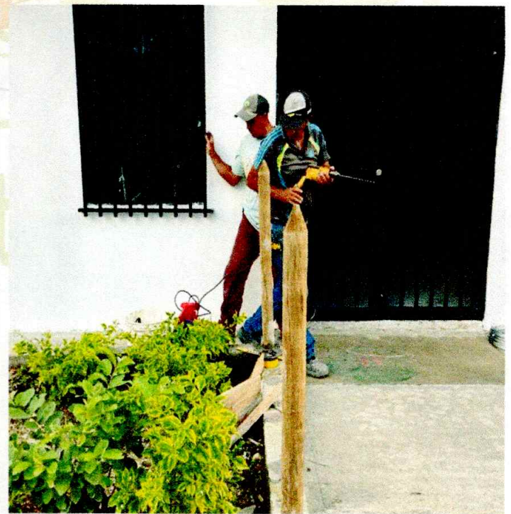
CONSTRUCCION DE CERRAMIENTO
