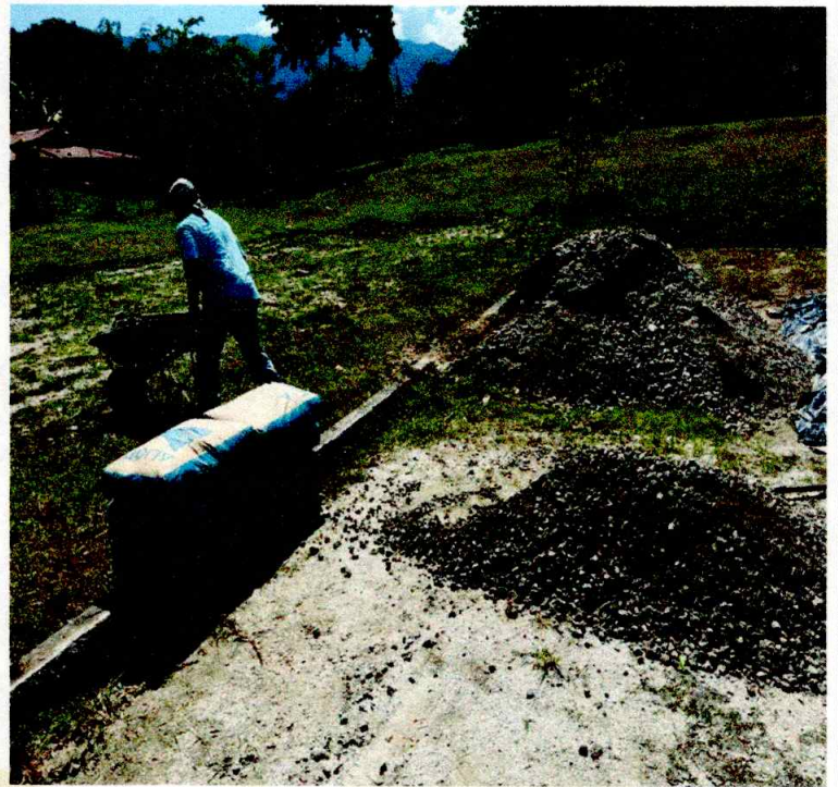
CONSTRUCCION DE CANCHA DE TEJO (VILLA OLIMPICA)
