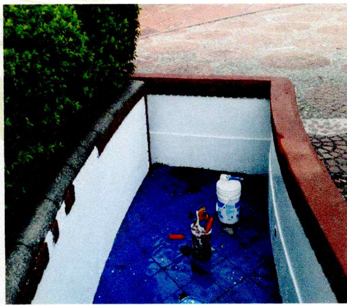
MANTENIMIENTO PARQUE PRINCIPAL
