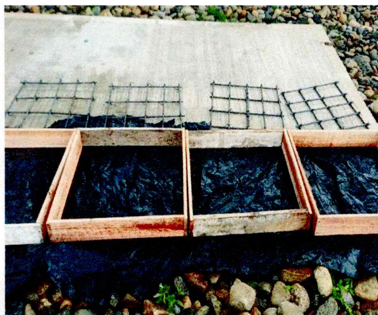
CONSTRUCCION DE TAPAS EN CONCRETO
