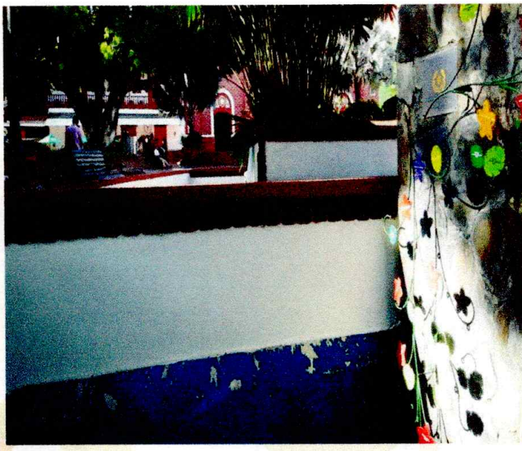
MANTENIMIENTO PARQUE PRINCIPAL
