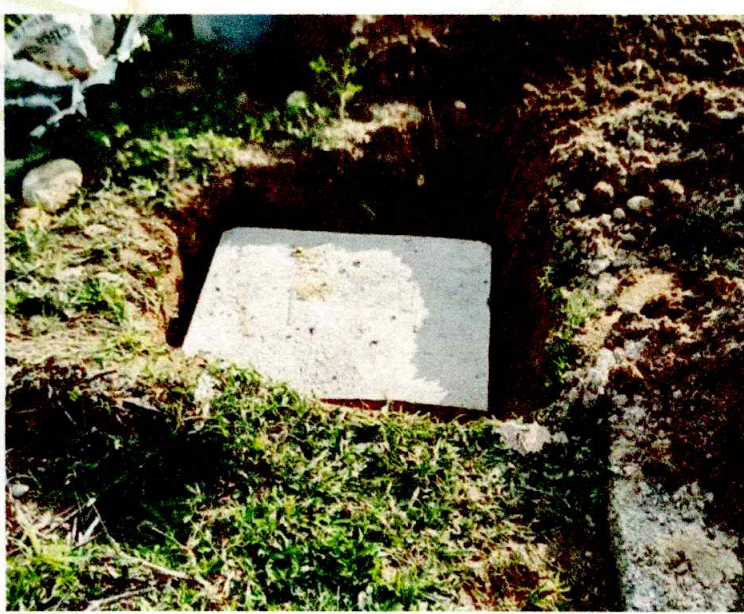
CONSTRUCCION DE TAPAS EN CONCRETO
