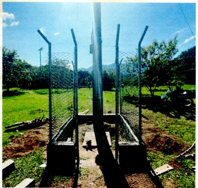
CONSTRUCCION DE CERRAMIENTO
