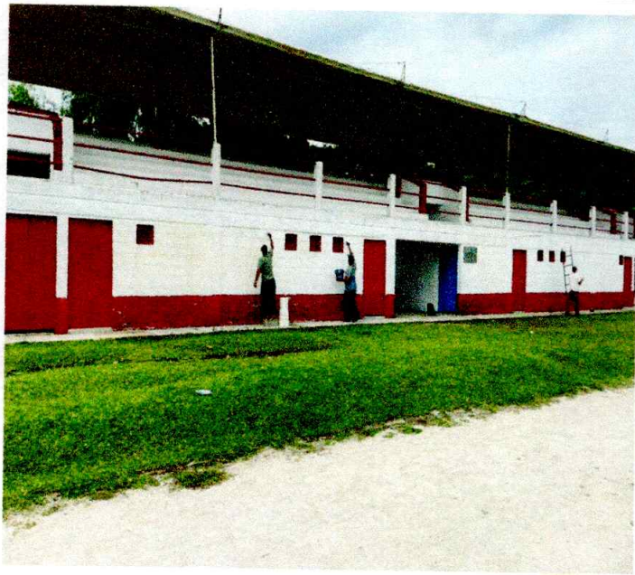
ADECUACIONES VILLA OLIMPICA
