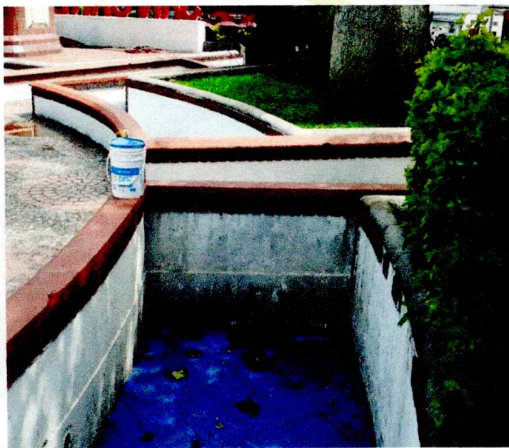
MANTENIMIENTO PARQUE PRINCIPAL
