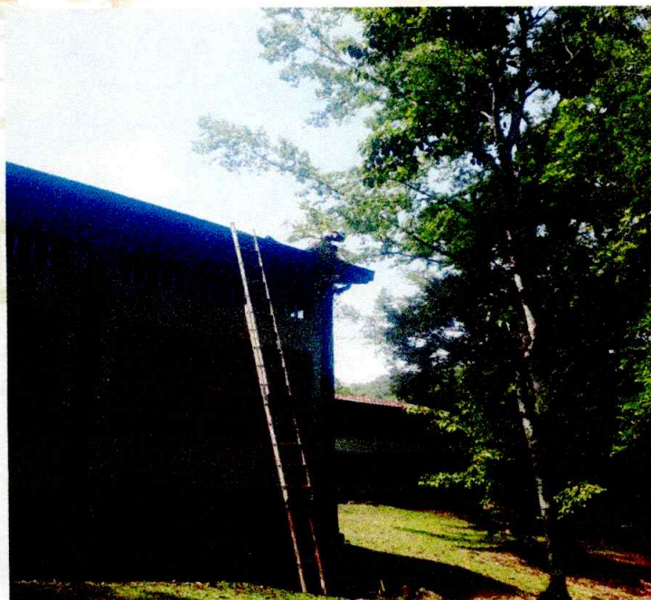
LIMPIEZA DE CUBIERTA
