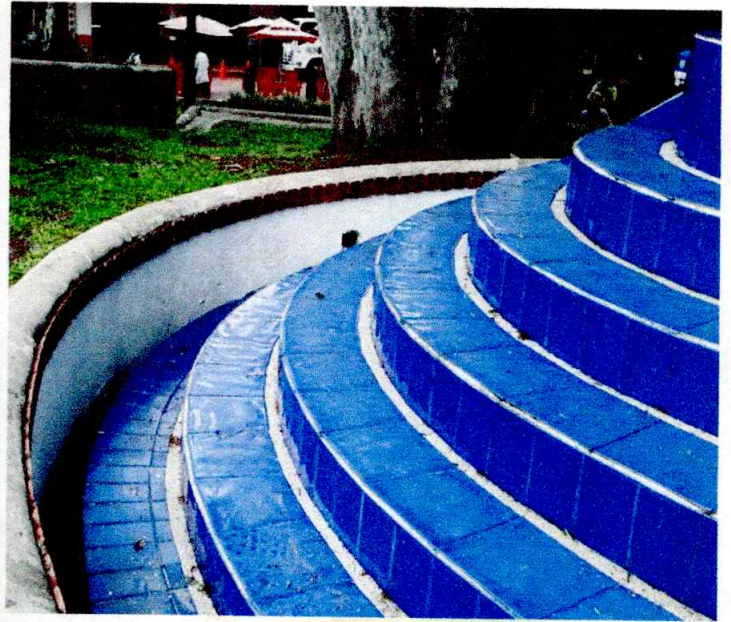
MANTENIMIENTO PARQUE PRINCIPAL
