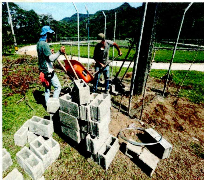
CONSTRUCCION DE CERRAMIENTO
