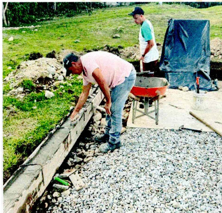
CONSTRUCCION DE CANCHA DE TEJO (VILLA OLIMPICA)
