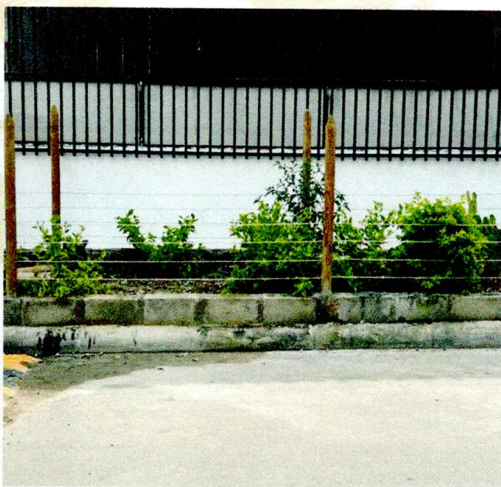
CONSTRUCCION DE CERRAMIENTO
