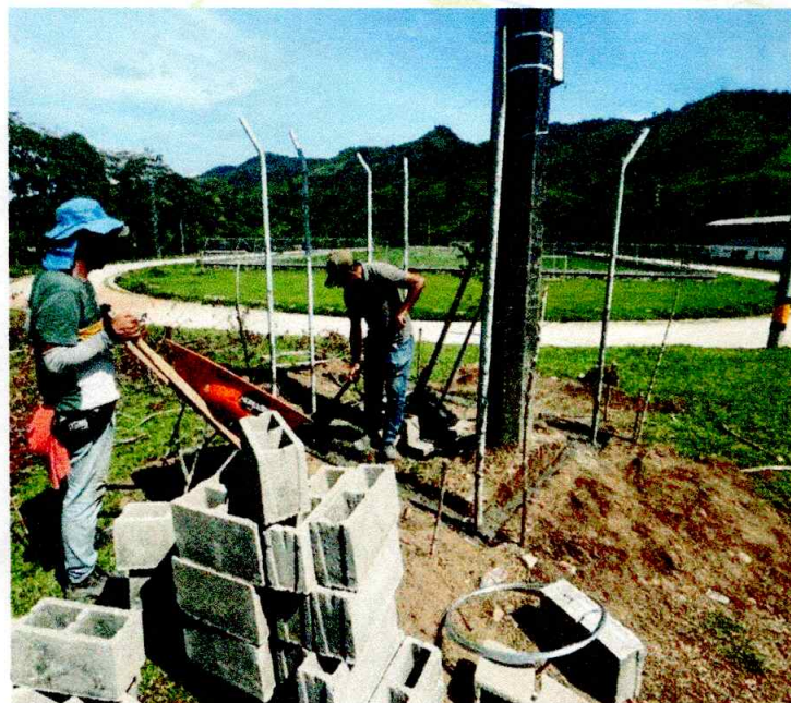
CONSTRUCCION DE CERRAMIENTO
