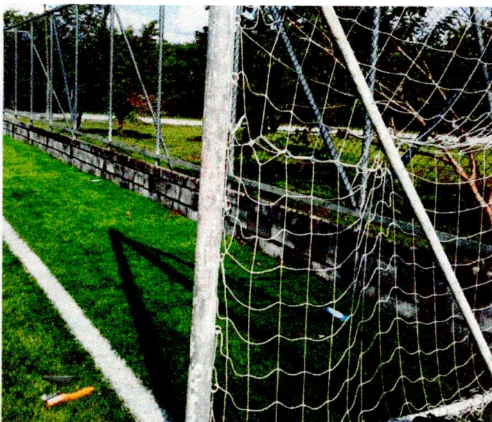
ADECUACIONES VILLA OLIMPICA
