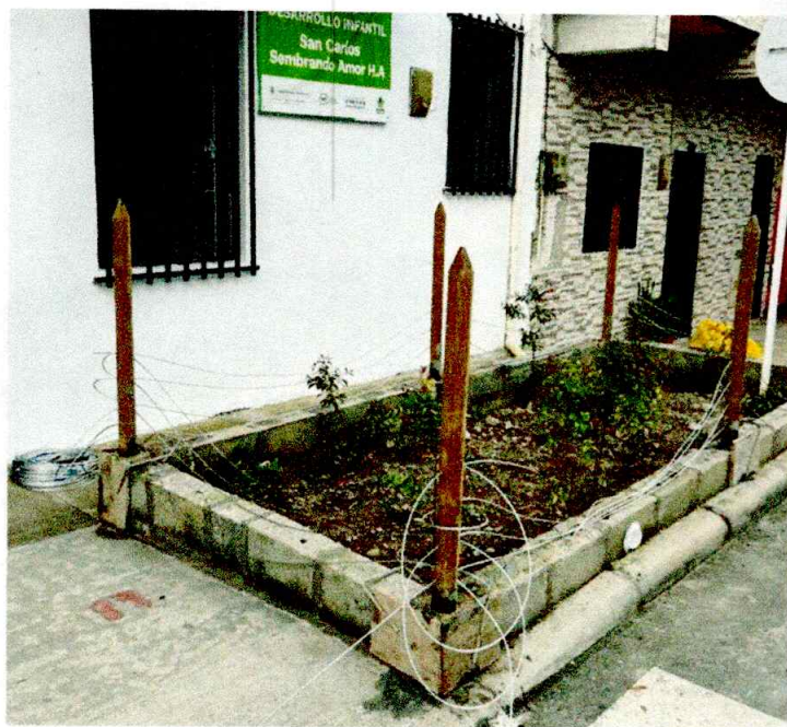
CONSTRUCCION DE CERRAMIENTO
