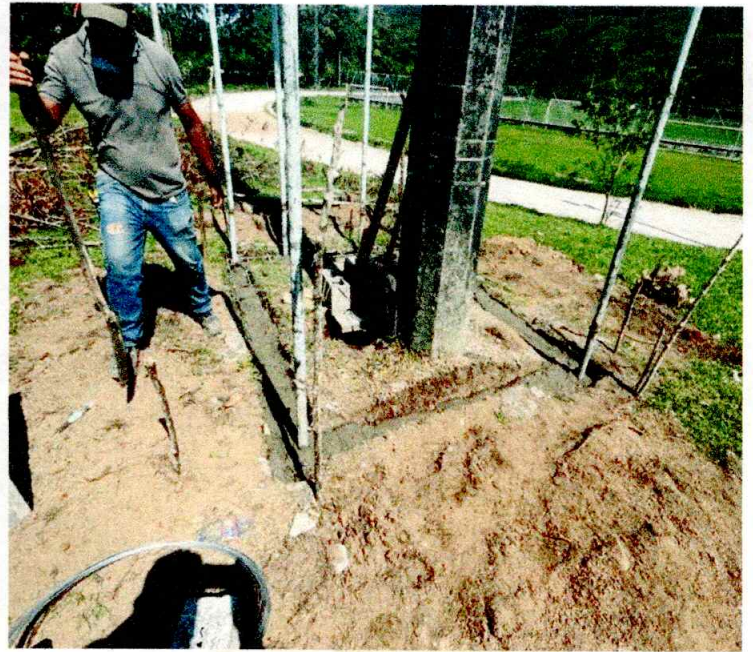
CONSTRUCCION DE CERRAMIENTO
