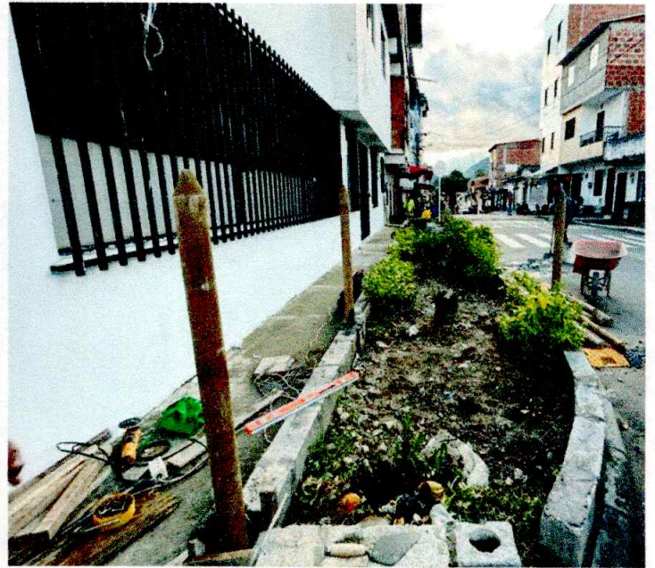
CONSTRUCCION DE CERRAMIENTO
