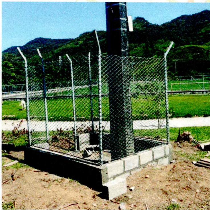
CONSTRUCCION DE CERRAMIENTO
