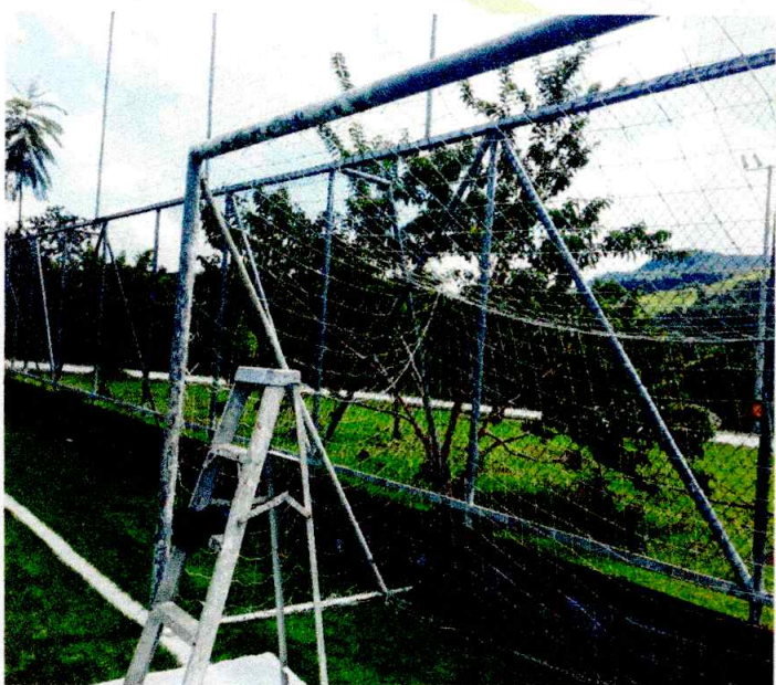
ADECUACIONES VILLA OLIMPICA
