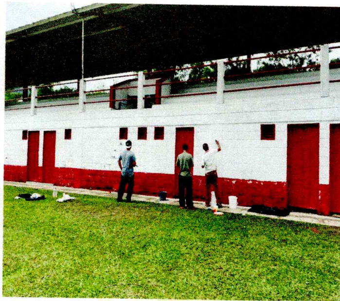
ADECUACIONES VILLA OLIMPICA
