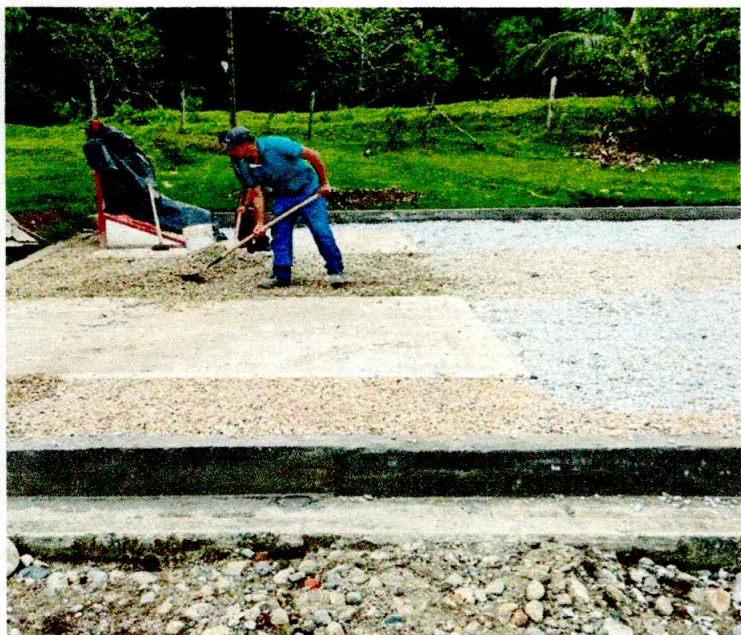
CONSTRUCCION DE CANCHA DE TEJO (VILLA OLIMPICA)
