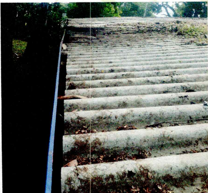
LIMPIEZA DE CUBIERTA
