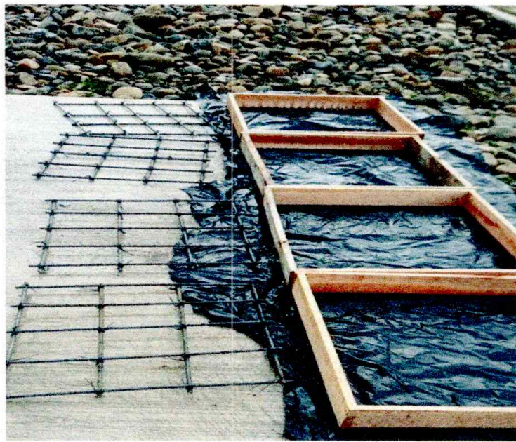
CONSTRUCCION DE TAPAS EN CONCRETO
