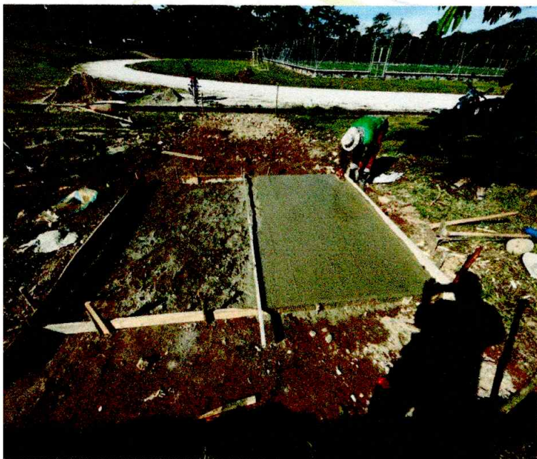
CONSTRUCCION DE CANCHA DE TEJO (VILLA OLIMPICA)
