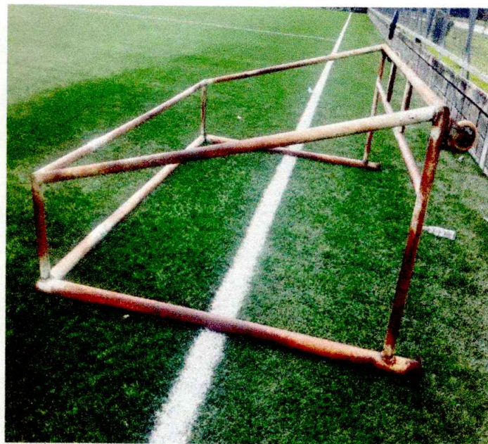
ADECUACIONES VILLA OLIMPICA
