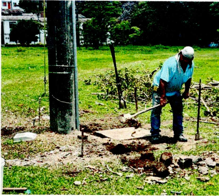
CONSTRUCCION DE CERRAMIENTO
