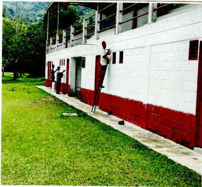
ADECUACIONES VILLA OLIMPICA
