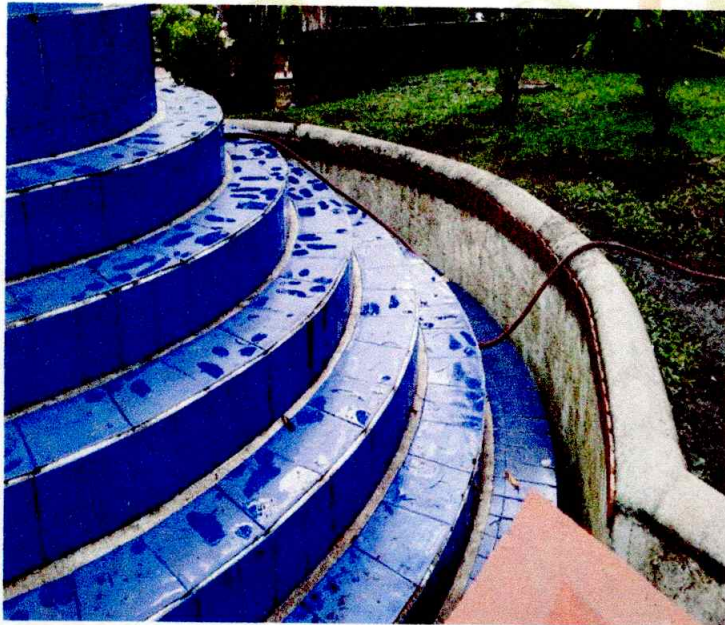
MANTENIMIENTO PARQUE PRINCIPAL
