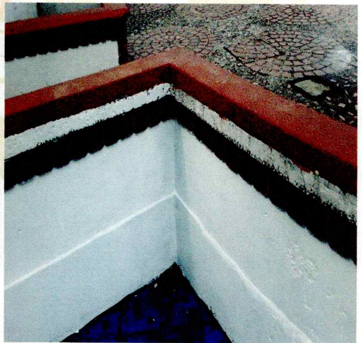
MANTENIMIENTO PARQUE PRINCIPAL
