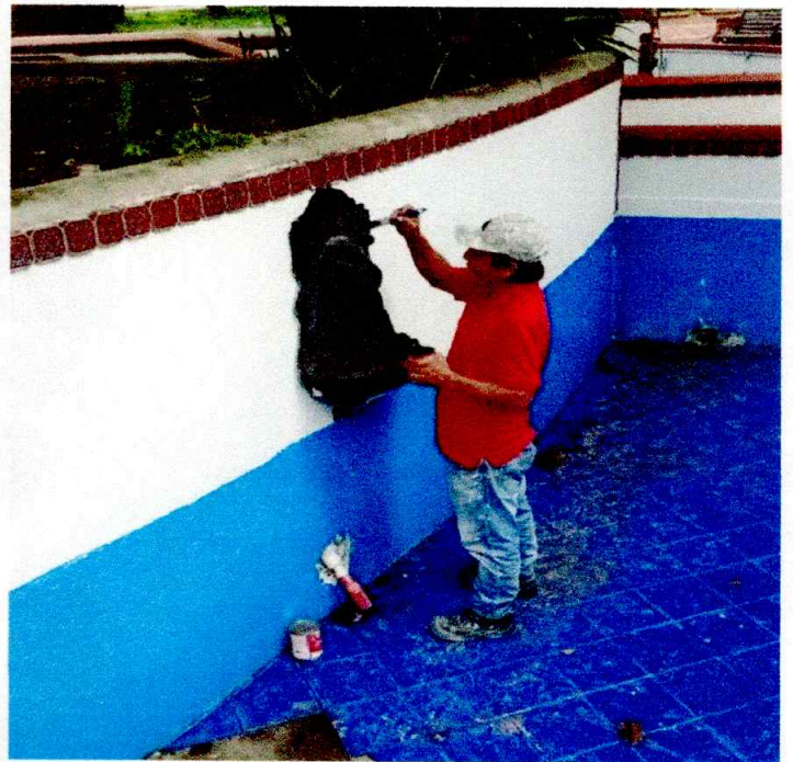
MANTENIMIENTO PARQUE PRINCIPAL
