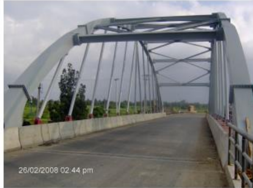
Calle 130A con Carrera 158A (vía Lisboa) – DESPUES
