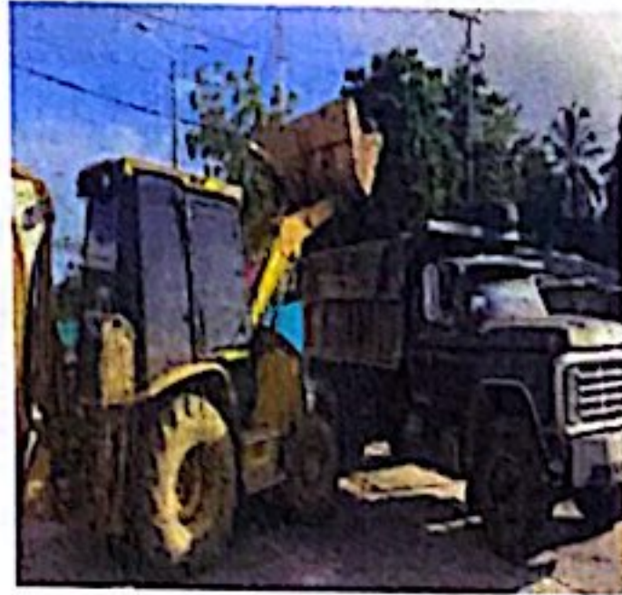
DEMOLICIÓN DE PAVIMENTO RÍGIDO CON LOS SIGUIENTES EQUIPOS: RETROEXCAVADORA 320
