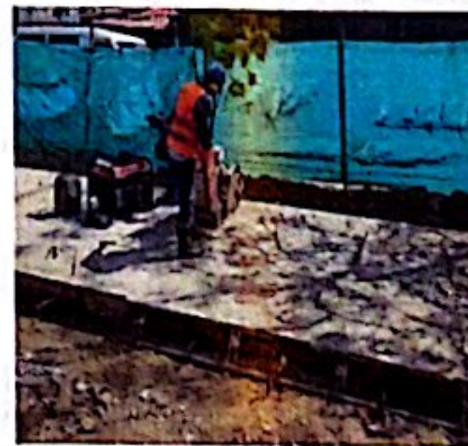
CORTE, DILATACIÓN Y SELLO DE JUNTAS EN CORDÓN DE POLIURETANO CON SELLO DE SILICONA
