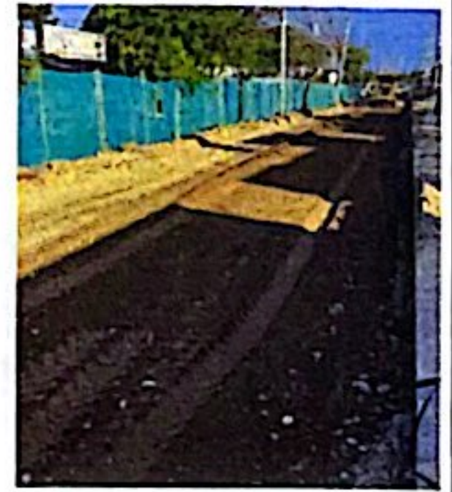
EXTENSION, HUMECTACIÓN, COMPACTACIÓN Y TOMA DE DENSIDADES EN MATERIAL DE SUBBASE TIPO INVÍAS CON EL EQUIPO MOTONIVELADORA
