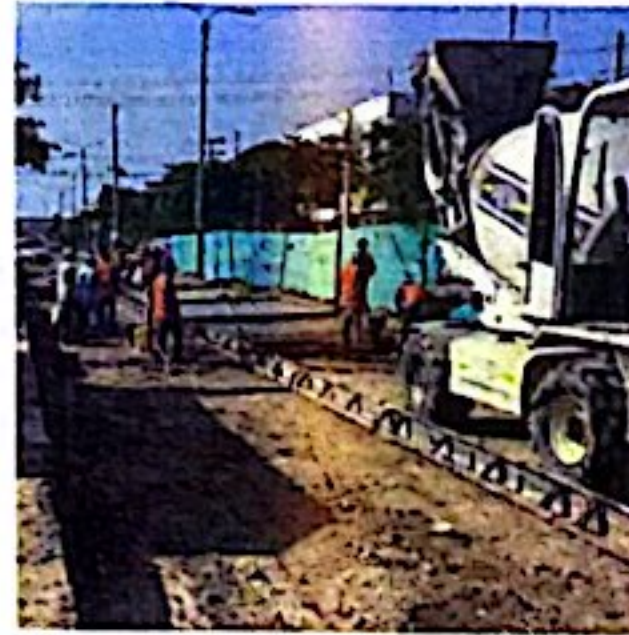
MEZCLA DE CONCRETO FABRICADO CON EQUIPO AUTOHORMIGONERA PARA COLOCACIÓN EN SITIO, VIBRADO, ALLANADO, TEXTURIZADO, Y CURADO CON ANTISOL PAVIMENTO EN CONCRETO e=0,25 mt y mor=4,2 Mpa
