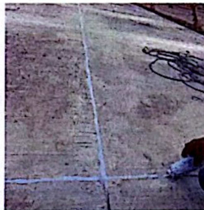
CORTE, DILATACIÓN Y SELLO DE JUNTAS EN CORDÓN DE POLIURETANO CON SELLO DE SILICONA
