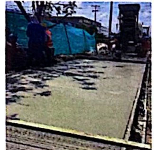
MEZCLA DE CONCRETO FABRICADO CON EQUIPO AUTOHORMIGONERA PARA COLOCACIÓN EN SITIO, VIBRADO, ALLANADO, TEXTURIZADO, Y CURADO CON ANTISOL PAVIMENTO EN CONCRETO e=0,25 mt y mor=4,2 Mpa
