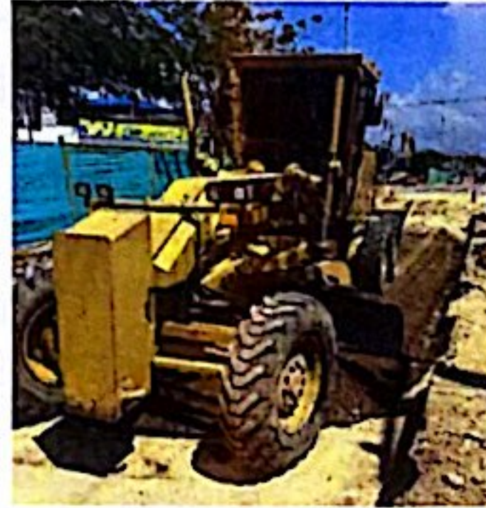
EXTENSION, HUMECTACIÓN, COMPACTACIÓN Y TOMA DE DENSIDADES EN MATERIAL DE SUBBASE TIPO INVÍAS CON EL EQUIPO MOTONIVELADORA
