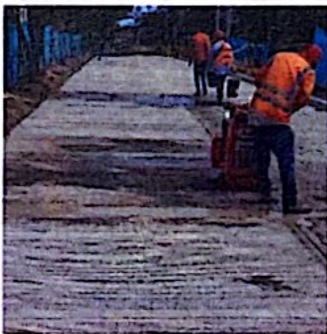
CORTE, DILATACIÓN Y SELLO DE JUNTAS EN CORDÓN DE POLIURETANO CON SELLO DE SILICONA
