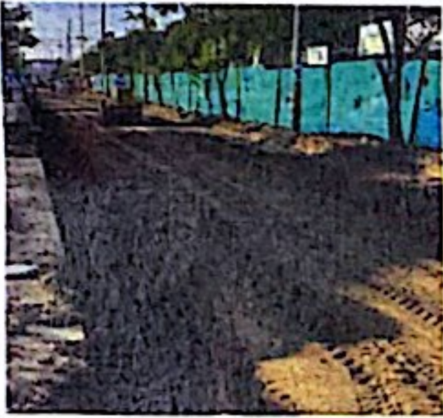
EXTENSIÓN, HUMECTACIÓN, COMPACTACIÓN Y TOMA DE DENSIDADES EN MATERIAL DE SUBBASE TIPO INVÍAS
