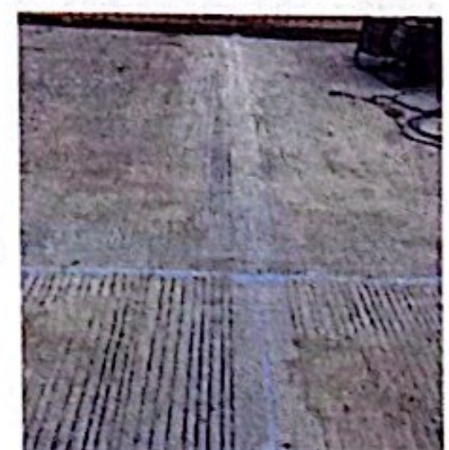
CORTE, DILATACIÓN Y SELLO DE JUNTAS EN CORDÓN DE POLIURETANO CON SELLO DE SILICONA
