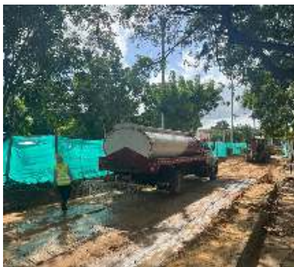
Registro Fotográfico 4: extensión, humectación, compactación y toma de densidades en material de sub base tipo invias con el equipo motoniveladora.
