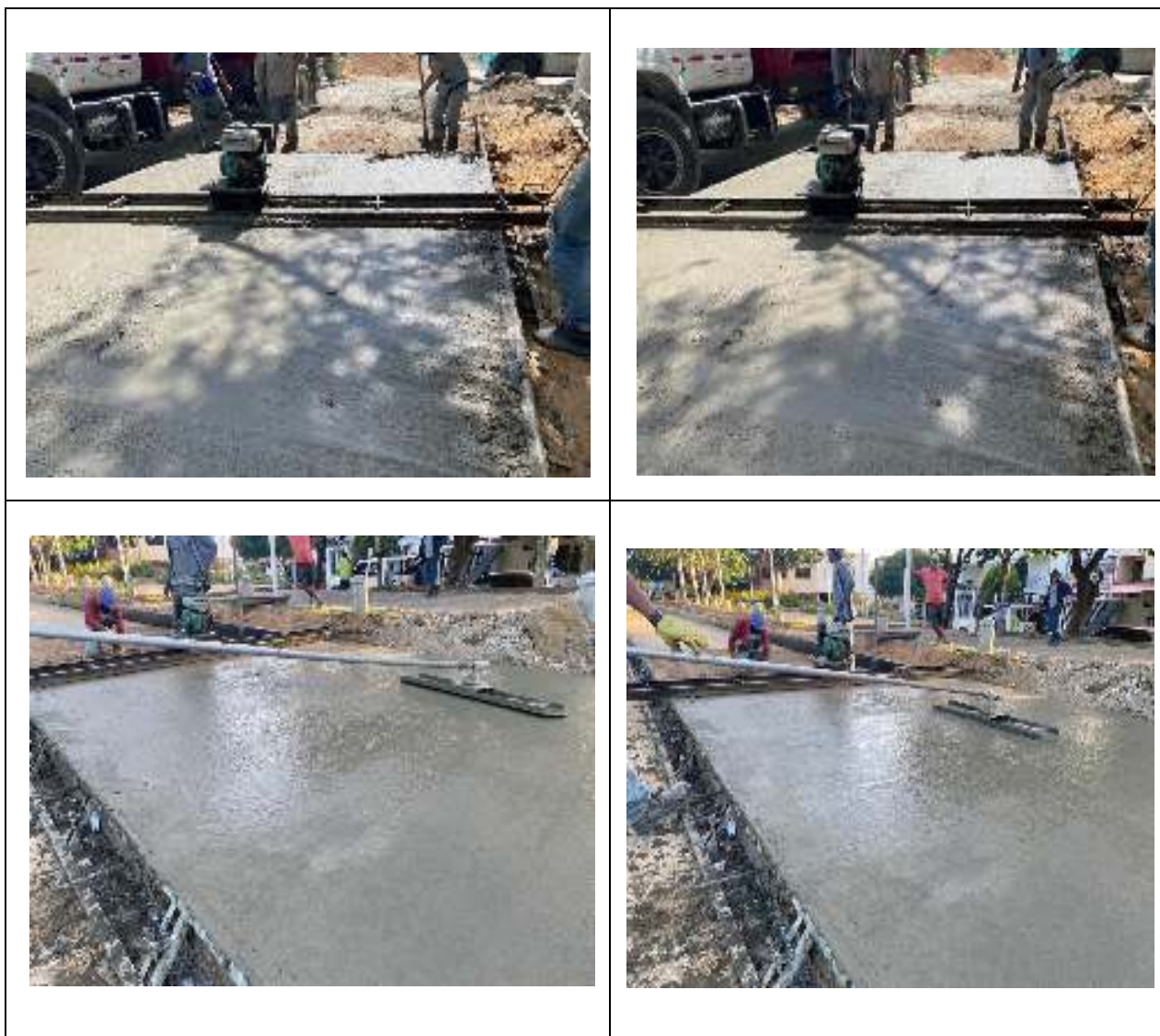
Registro Fotográfico 8: Mezcla de concreto fabricado con equipo autohormigonera para colocación en sitio, vibrado, allanado, texturizado y curado con antisol, pavimento en concreto e=0.25 mt y mor=4.2 mpa.
