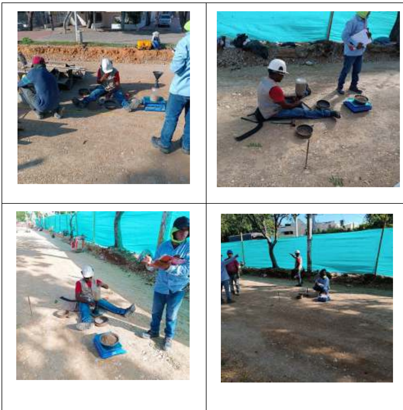
Registro Fotográfico 5: extensión, humectación, compactación y toma de densidades en material de sub base tipo invias con el equipo motoniveladora.
