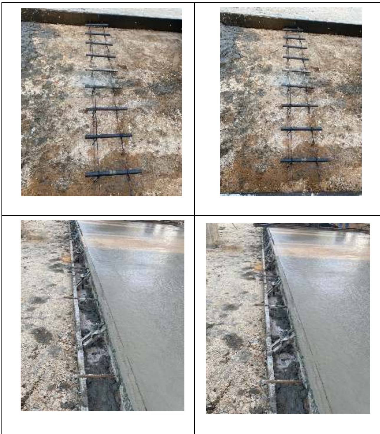
Registro Fotográfico 6: Acero de transferencia d=1/2" corrugado, acero liso de transferencia d=1 1/8" liso y canastilla soporte dovelas en acero de \phi 3/18" alambren.
