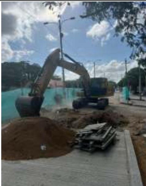
Registro Fotográfico 2: Corte de terreno con máquina retroexcavadora 320.
