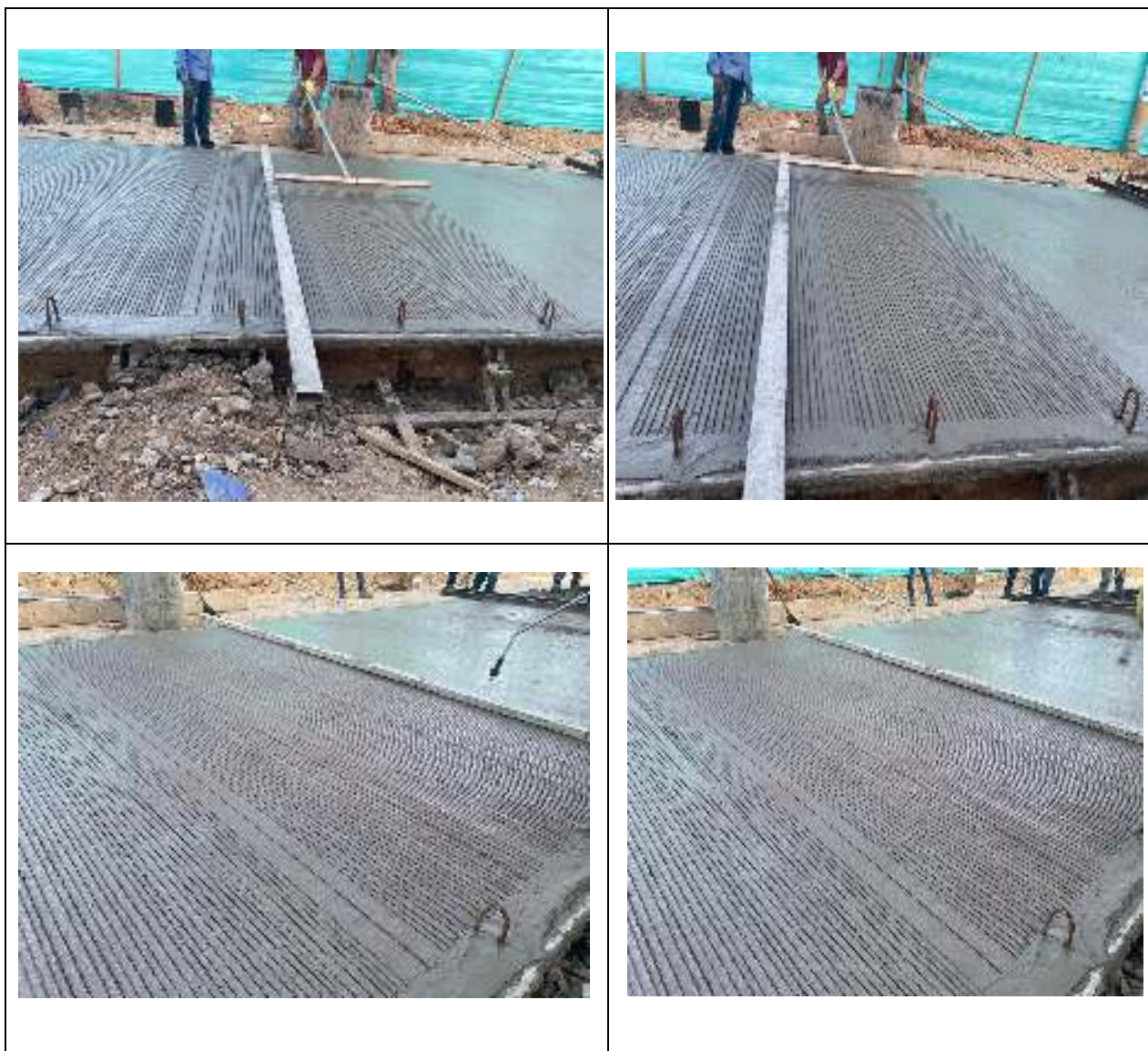
Registro Fotográfico 9: Mezcla de concreto fabricado con equipo autohormigonera para colocación en sitio, vibrado, allanado, texturizado y curado con antisol, pavimento en concreto e=0.25 mt y mor=4.2 mpa.
