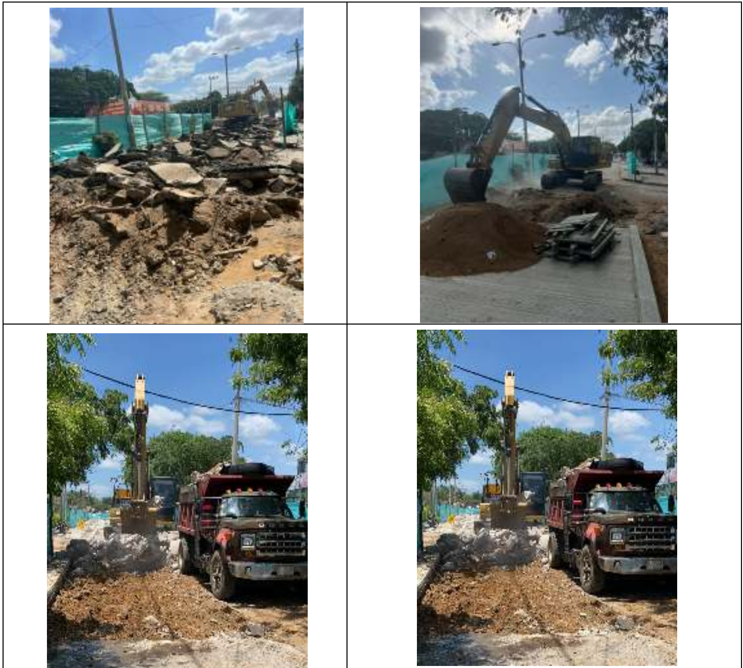
Registro Fotográfico 1: Demolición y retiro de pavimento rígido existente con maquinaria tipo retroexcavadora 320.
