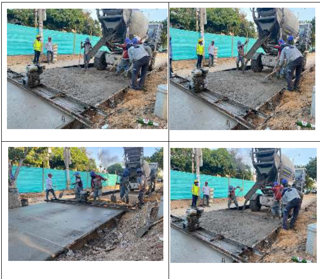
Registro Fotográfico 7: Mezcla de concreto fabricado con equipo autohormigonera para colocación en sitio, vibrado, allanado, texturizado y curado con antisol, pavimento en concreto e=0.25 mt y mor=4.2 mpa.
