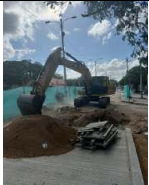
Registro Fotográfico 2: Corte de terreno con máquina retroexcavadora 320.
