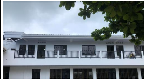
Instalacion de baranda , ventas y puertas.
