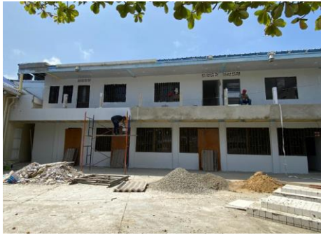
Aplicación de graniplast en fachada
