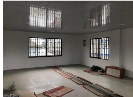
Enchape en segundo piso
