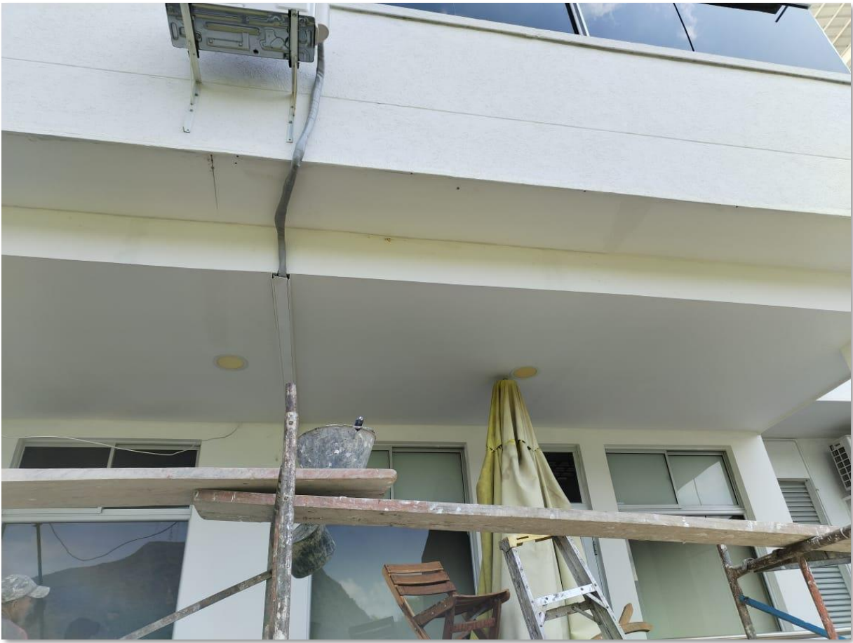
Imagen 5: Construcción de goteros y ajuste en cielo raso Drywall
