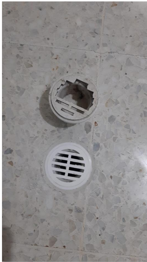
Imagen 12: Cambio y sustitución de rejillas sifones
