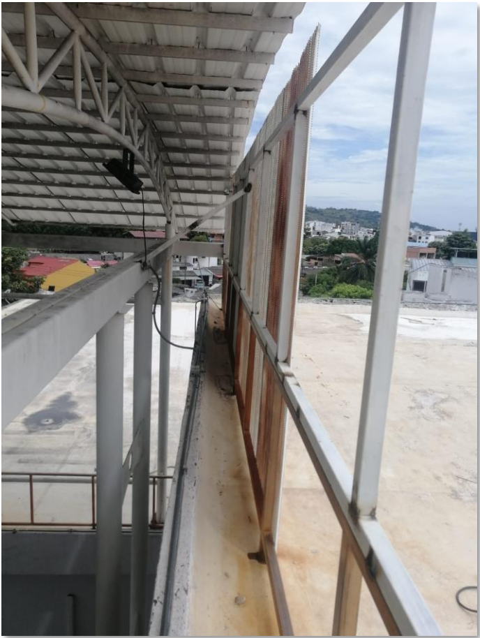
Imagen 3: Suministro e instalación lamina microperforada
