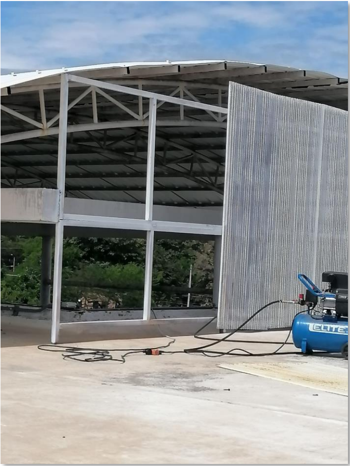
Imagen 4: Suministro e instalación lamina microperforada
