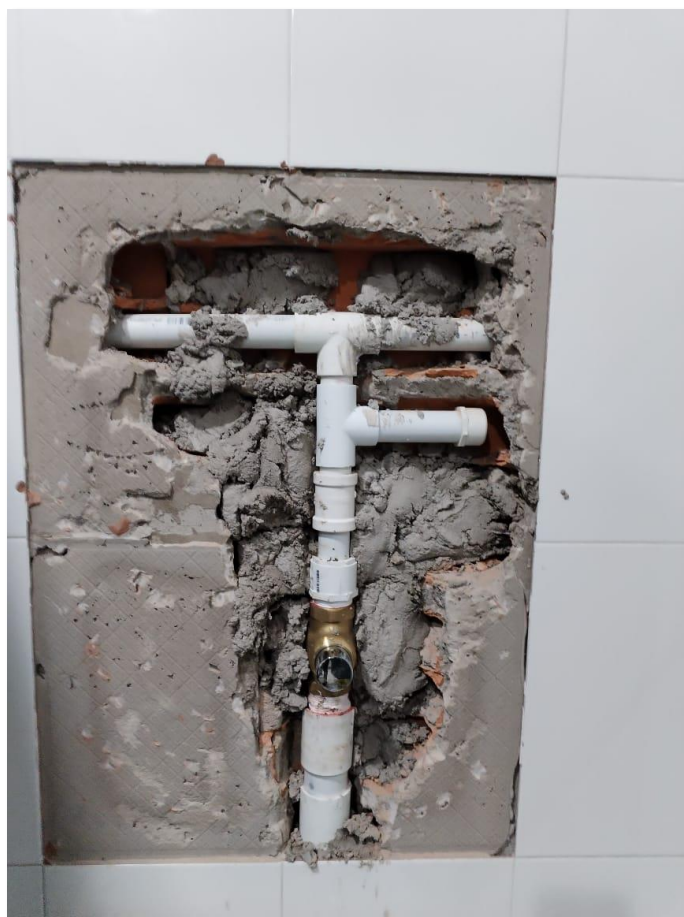
Imagen 7: Cambio de push sanitario (Fluxometro)
