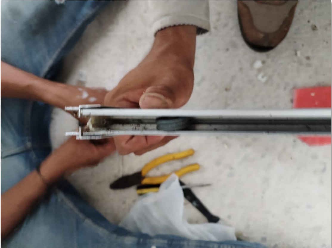
Imagen 1: Desmonte de ventanería y ajuste con cambio de rodamientos
