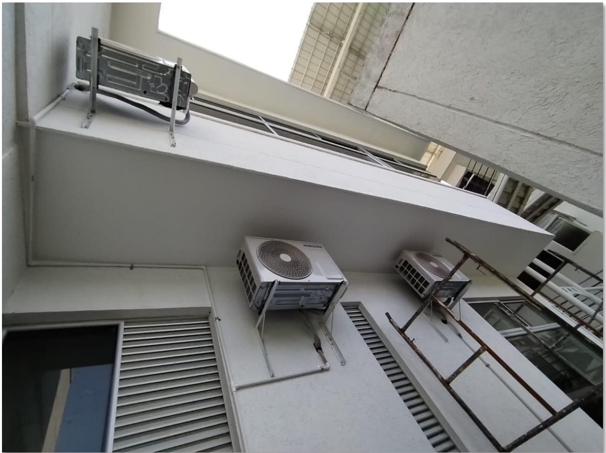
Imagen 6: Construcción de goteros y ajuste en cielo raso Drywall
