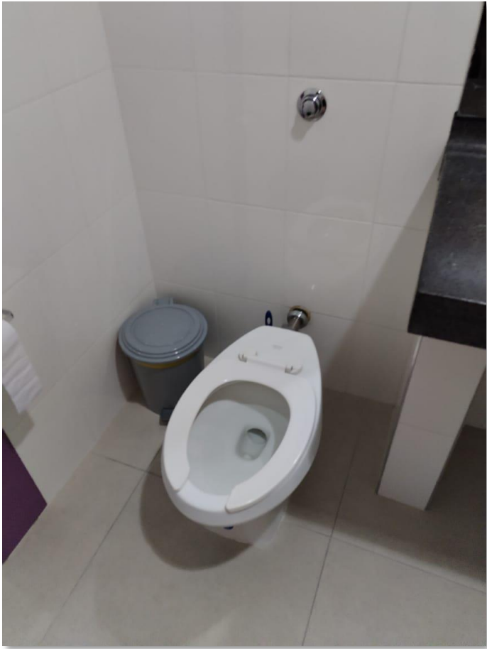
Imagen 10: Revisión de unidades sanitarias
