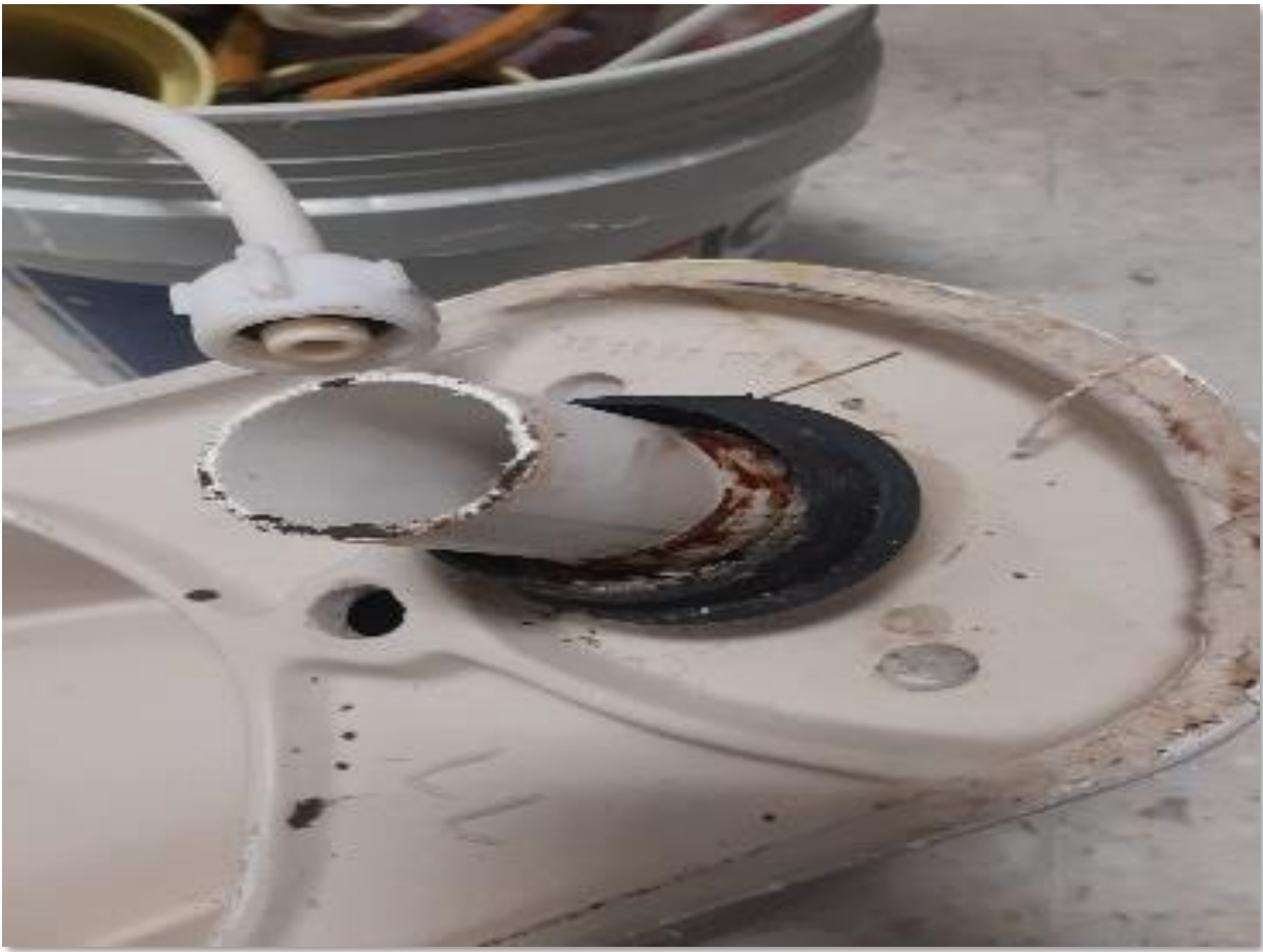
Imagen 11: Revisión de aparatos sanitarios a nivel general
