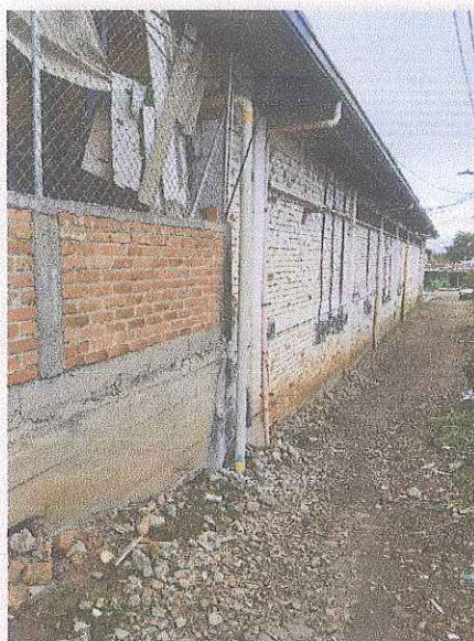
Ejecución: Limpieza de canales de cubierta y bajantes
