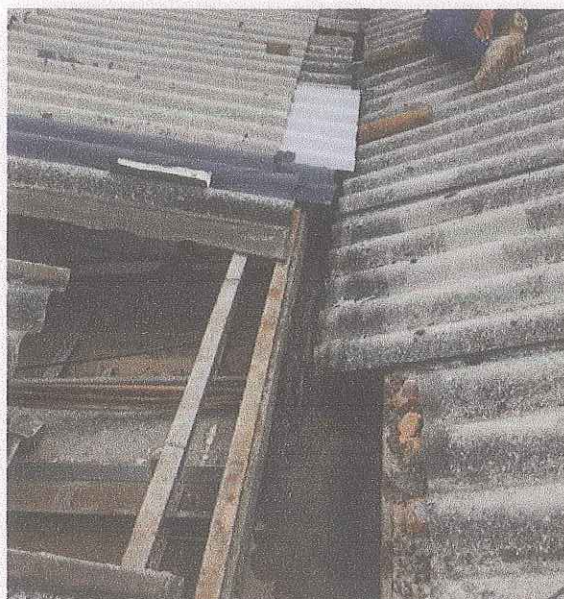
Ejecución: Suministro e instalación de teja de fibrocemento
