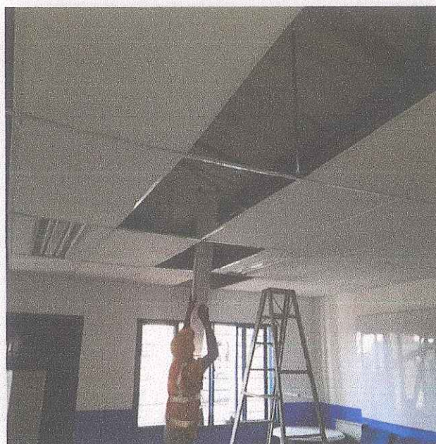
Ejecución: Instalación cielo falso existente
