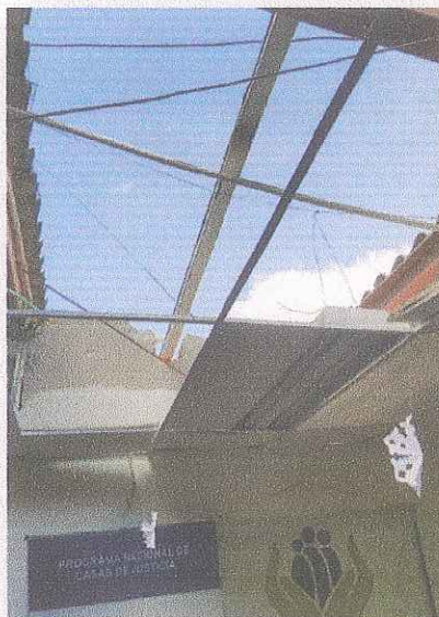
Ejecución: Suministro e instalación lamina cielo falso icopor poliestireno
