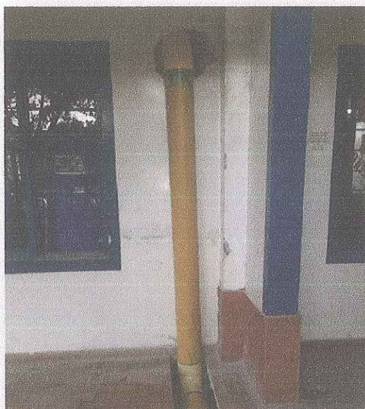
Ejecución: Bajante aguas lluvias pvc 6
