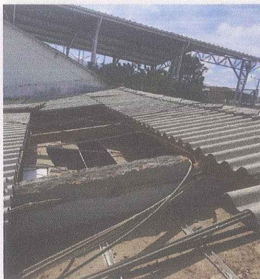
Ejecución: Desmonte cielo falso
