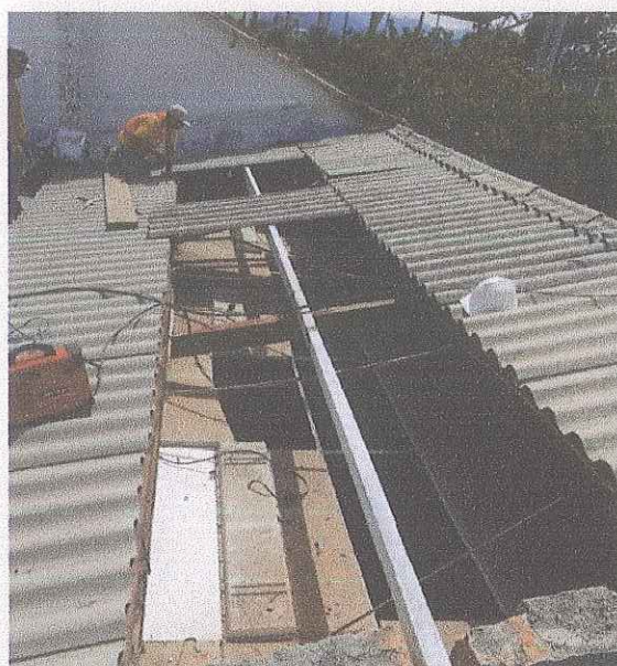
Ejecución: Perfil abierto ag c160x 60mm -2mm c.14
