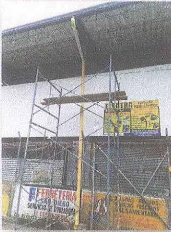
Ejecución: Suministro e Instalación tubería de 4"
