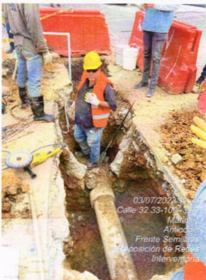
Imagen No.9 F. semillitas_Instalacion de Válvula de 10"
