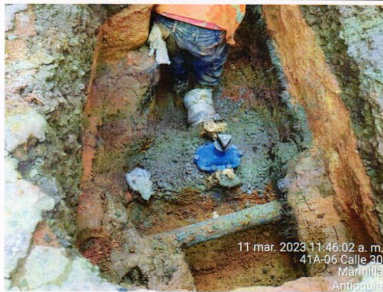
Imagen No.13 F. Maria Auxiliadora_ instalación de Válvula
