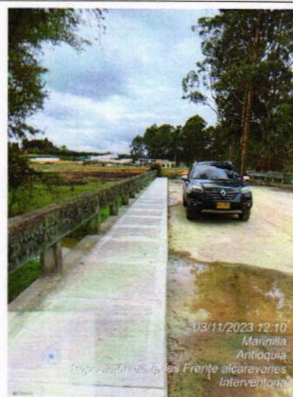
Imagen No.12 F. Alcaravanes Construcción anden
