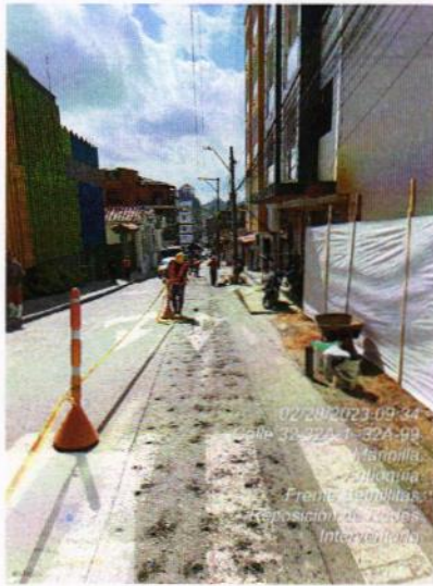
Imagen No.5 F. la Semillitas _Demolición de Pavimento
