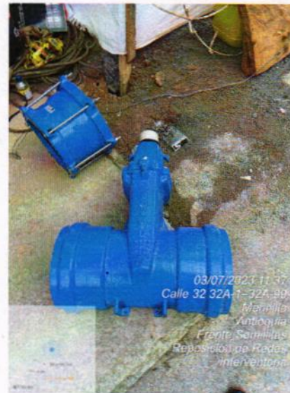
Imagen No.10 F. semillitas Instalacion de Válvula de 10"
