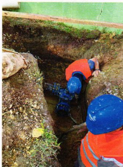
Imagen No.14 F. María Auxiliadora_ instalación de Válvula
