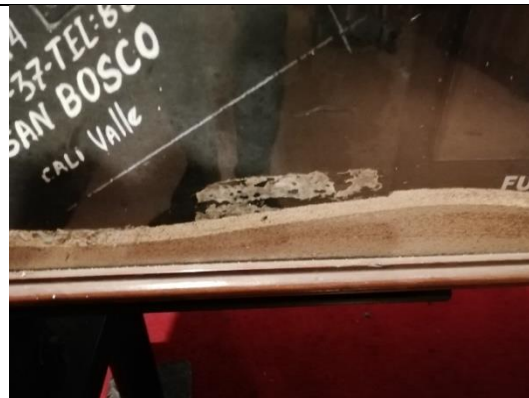
Fotografía 14. Detalle de la evidencia del deterioro producido por las termitas
