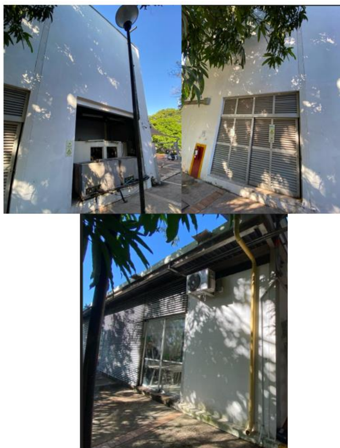
Ilustración 3. estado actual- fachada lateral izquierda
