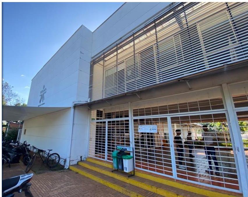
Ilustración 2. estado actual fachada entrada principal.
