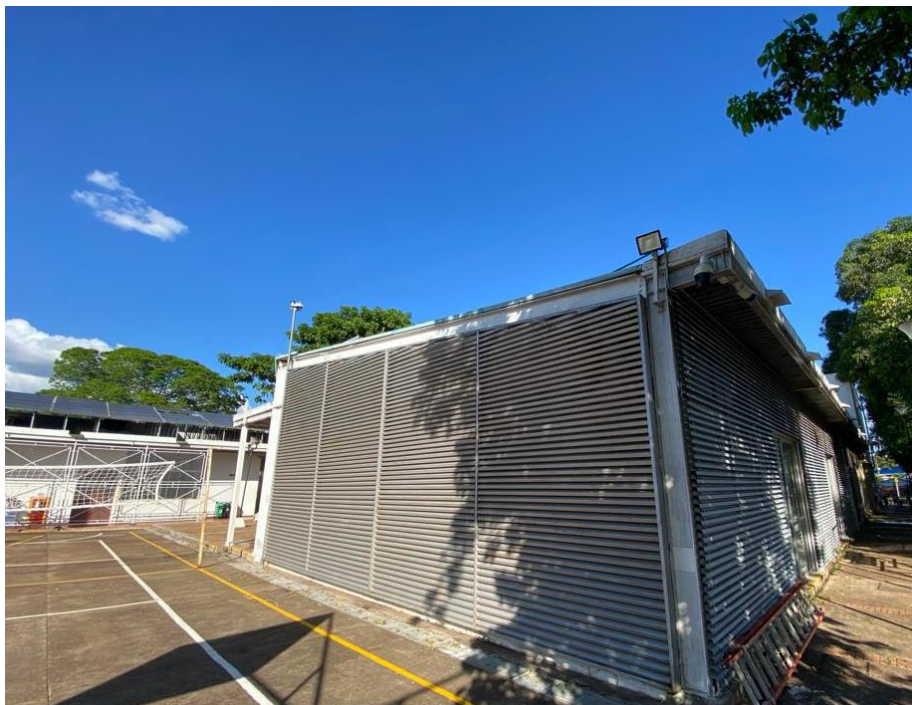
Ilustración 5. fachada posterior lateral izquierda.
