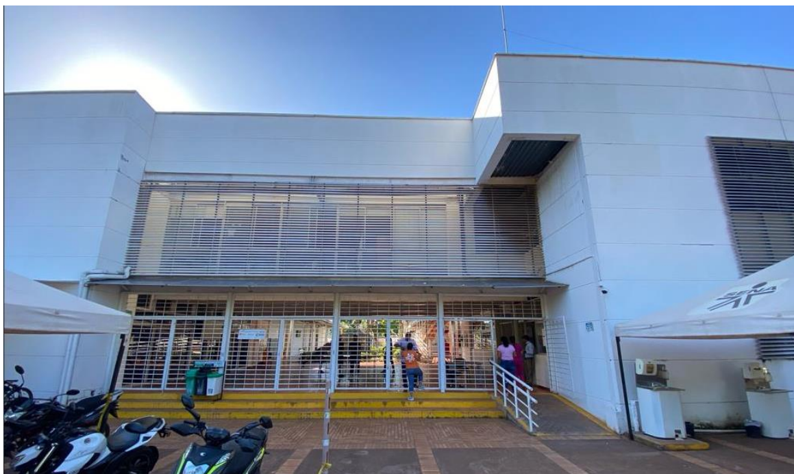
Ilustración 1. estado actual fachada entrada principal.
