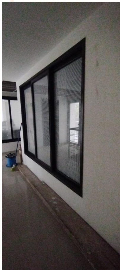
Fotografía 18. Fotografía 19. Se pinta los marcos generales y los marcos internos de las ventanas por fuera y por dentro.
