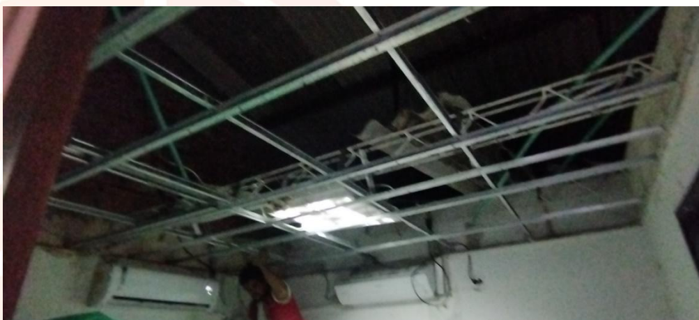
Fotografía 3. De desmonte y retiro de la estructura metálica de cielo raso existente, incluyendo cuelgas o templetes.
