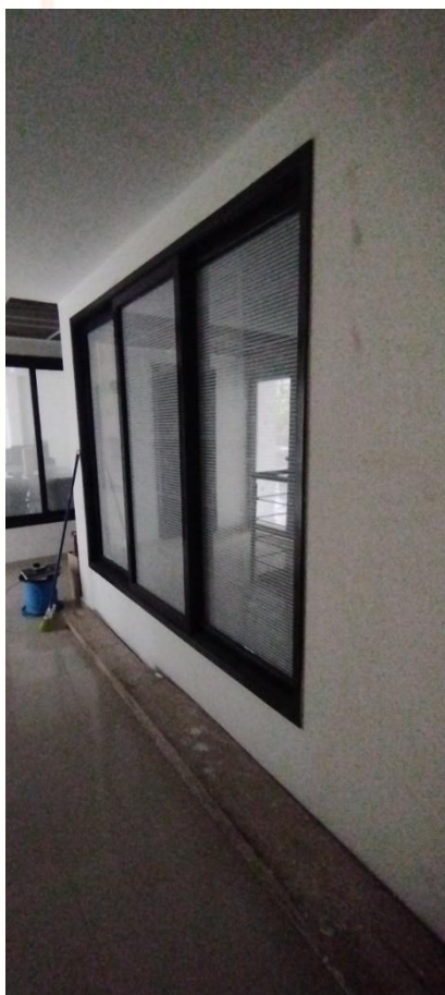
Fotografía 13. Fotografía 14. Se pinta los marcos generales y los marcos internos de las ventanas por fuera y por dentro.
