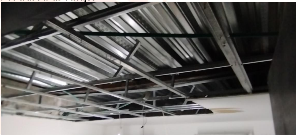
Fotografía 1. Desmonte de láminas de drywall en las oficinas que se ingresan, después de acondicionar las oficinas para trabajar.
