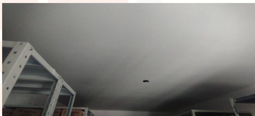
Fotografía 12. Aplicación de pintura blanca en vinilo tipo 1. En las placas de cielo raso de las oficina y áreas de circulación y atención al público.
