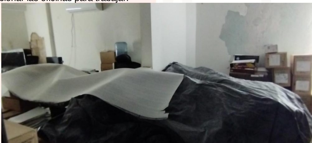
Fotografía 2. De desmonte y demolición de cielo raso existente en oficinas de segundo piso.
