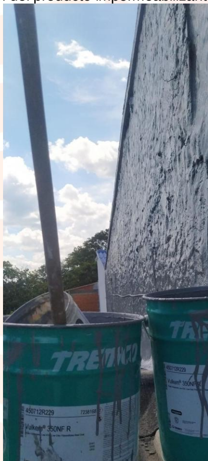
Fotografía 16. Fotografía 17. Aplicación del poliuretano vulkem 350 las culatas de la edificación. Como tratamiento impermeabilizante.
