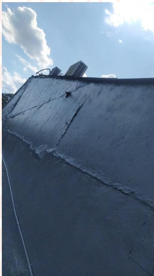
Fotografía 16. Fotografía 17. Aplicación del poliuretano vulkem 350 las culatas de la edificación. Como tratamiento impermeabilizante.
