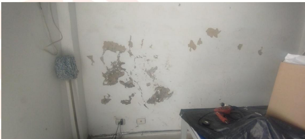
Fotografía 9. Resanes y repañetado de áreas afectadas por las humedades de culatas en la oficina de jurídica.
