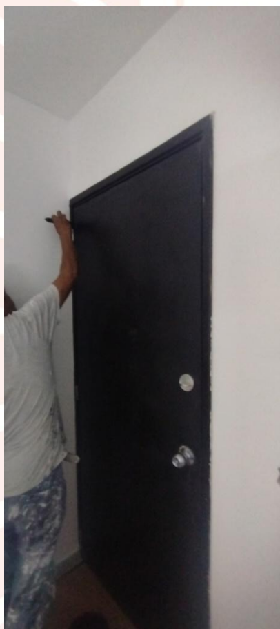
Fotografía 15. Pintura en esmalte sintético en color wengué en guarda luces, marcos y hojas de las puertas. De las oficinas de primer y segundo piso.
