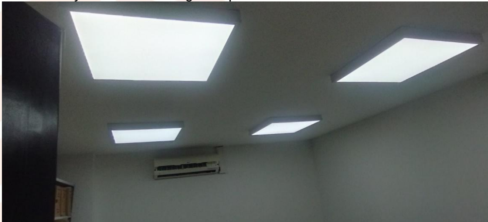
Fotografía 20. Instalación de paneles o láminas de superboard – en imágenes de las oficinas ya terminadas y con las lámparas ya instaladas.
