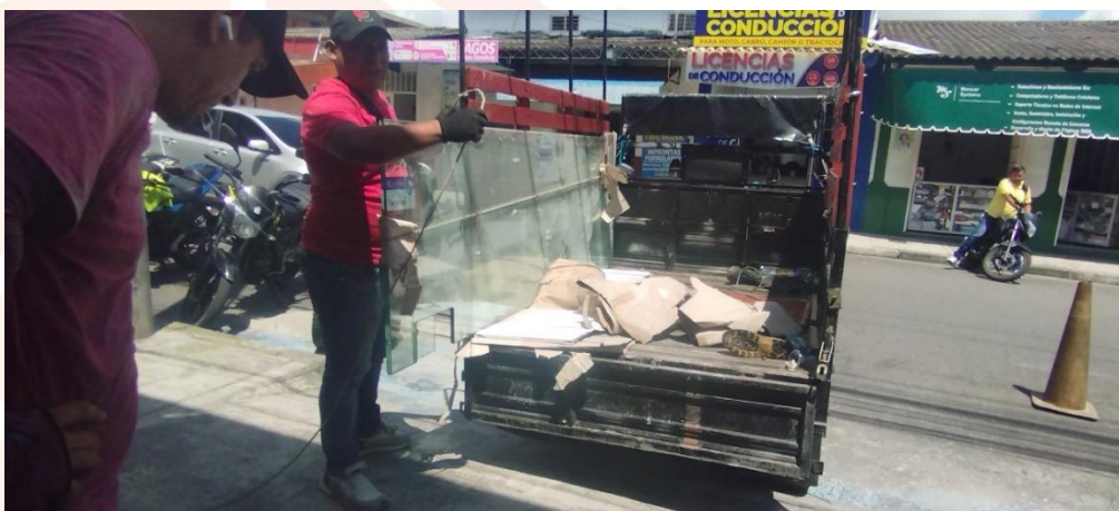
Fotografía 7. Retiro de material sobrante como fueron los vidrios de la reseción.
