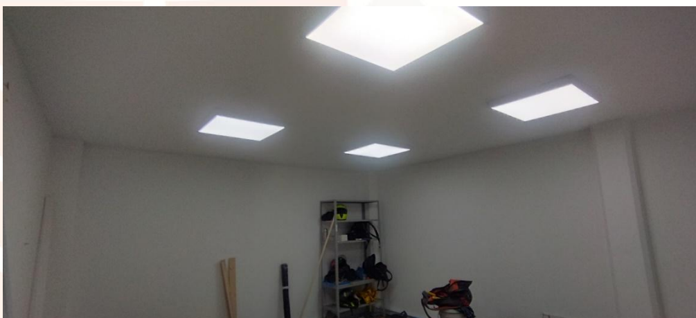
Fotografía 21. Panorámica de una de las oficinas ya terminada. Ya con la instalación de las lámparas.
