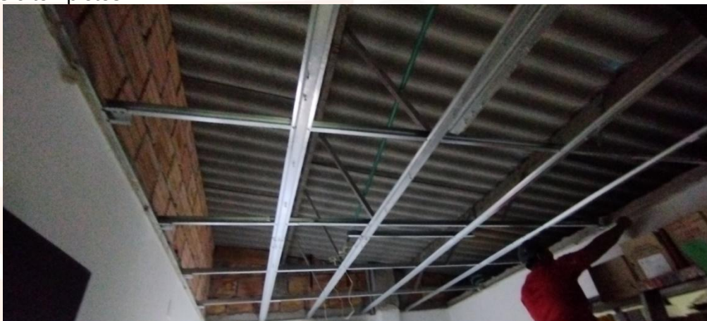
Fotografía 4. De desmonte y retiro de la estructura metálica de cielo raso existente y retirando los templetes que están anclados a la estructura de cubierta antigua.
