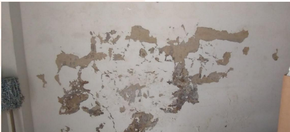
Fotografía 10. Resane, inducción y tratamiento en humedades, fisuras y desprendimiento de pintura, pañete y estuco.
