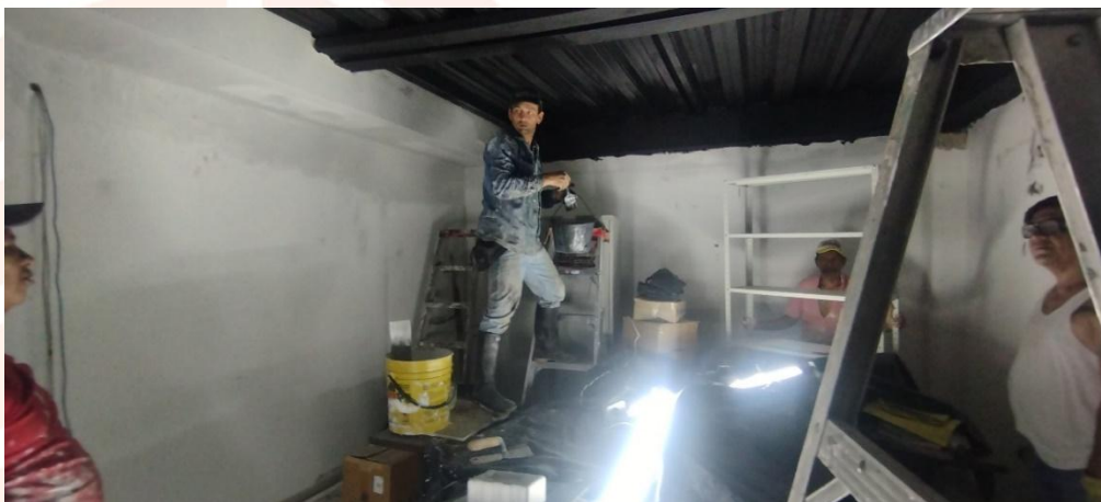
Fotografía 5. De desmonte de las lámparas dañadas se dieron de baja y botan. Suspendiendo las conexiones eléctricas existentes.
