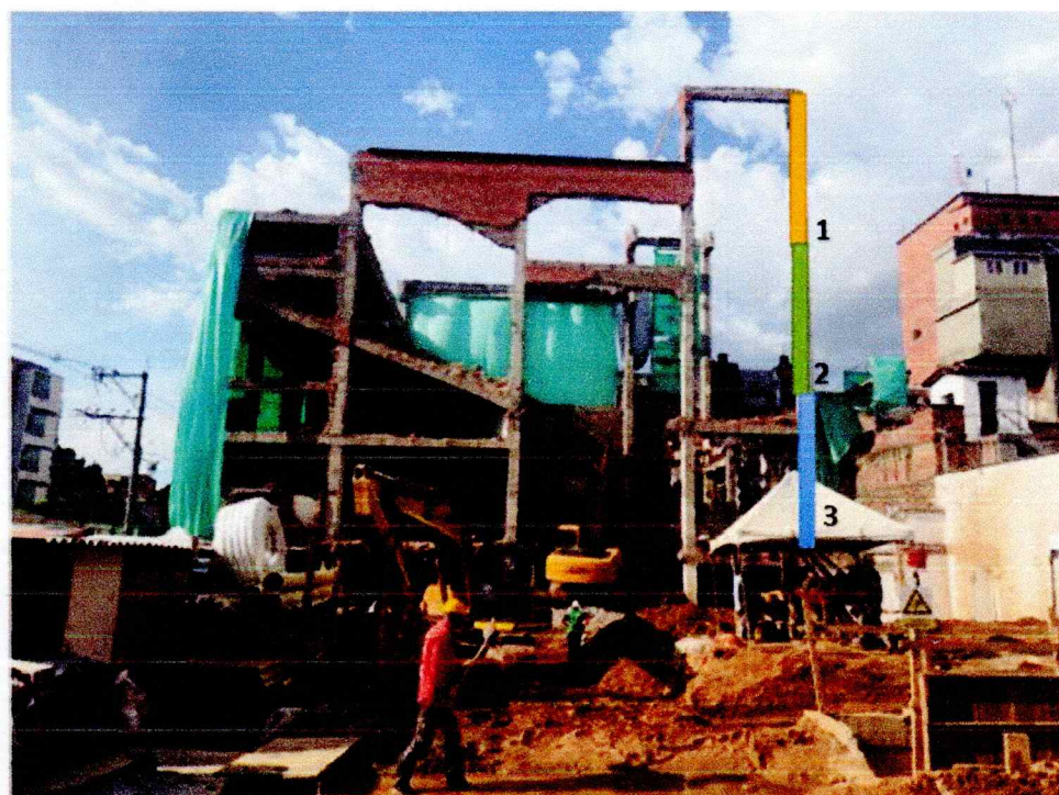
Imagen 2. Avance demolición elementos en concreto
