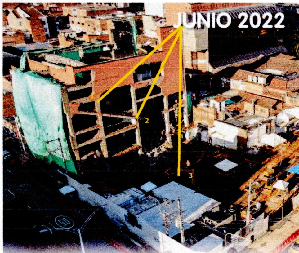
Imagen 1. Proceso demolición muros fachada, vigas y columnas
