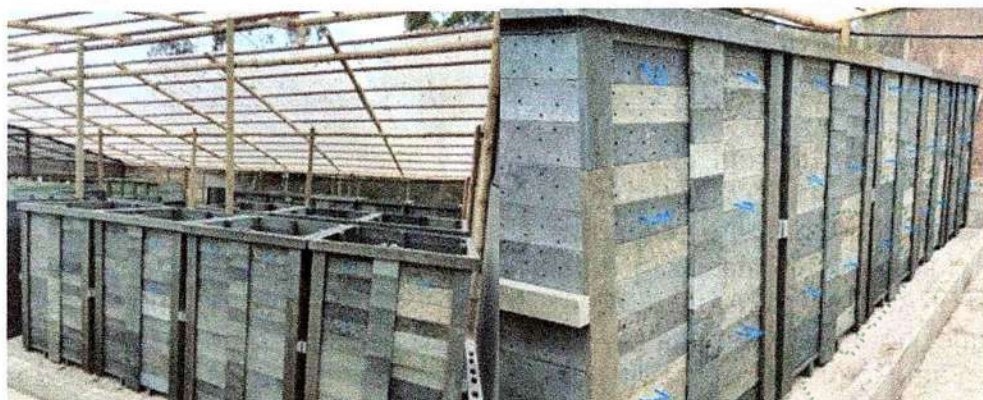
Imágenes 1 y 2. Instalación sistemas de compostaje municipio de La Unión.
