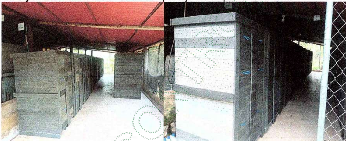
Imágenes 3 y 4. Instalación sistemas de compostaje municipio de San Roque
