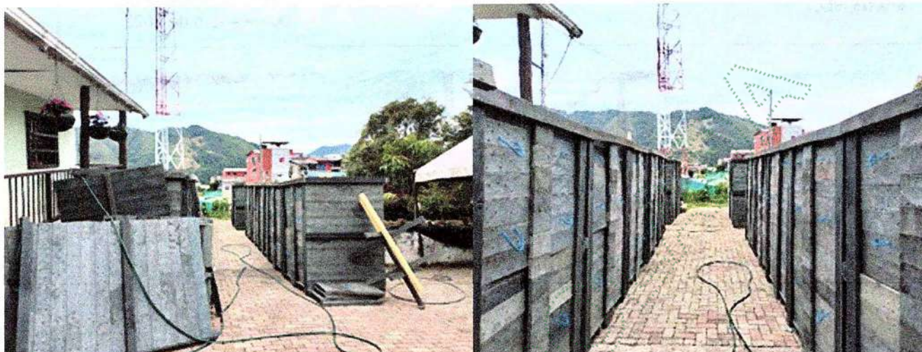
Imágenes 14 y 15. Instalación sistemas de compostaje municipio de San Luis
