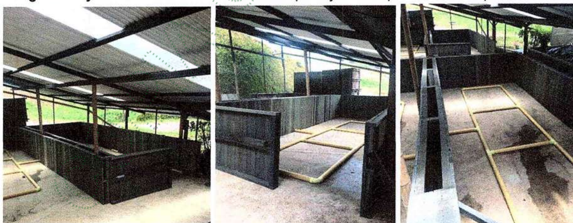
Imágenes 5, 6 y 7. Instalación sistemas de compostaje municipio de Marinilla
