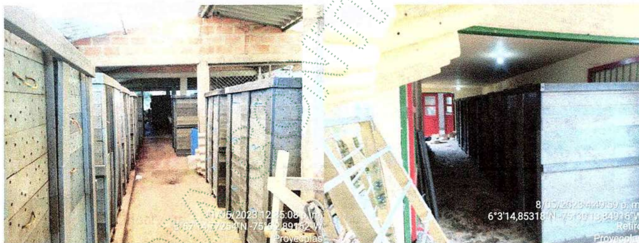
Imágenes 16 y 17. Instalación sistemas de compostaje en los municipios de el Retiro y San Francisco.
