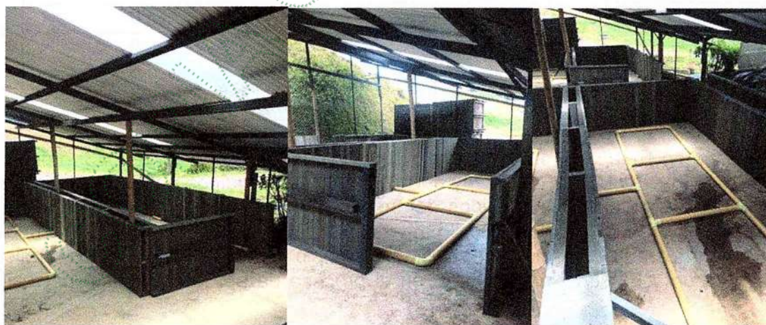
Imágenes 5, 6 y 7. Instalación sistemas de compostaje municipio de Marinilla
