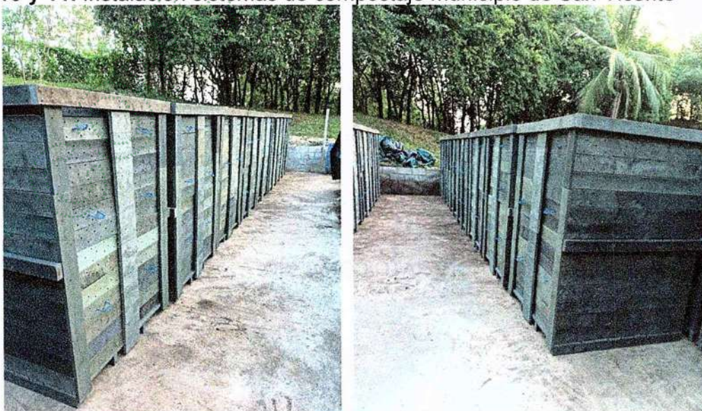
Imágenes 12 y 13. Instalación sistemas de compostaje municipio de Puerto Triunfo
