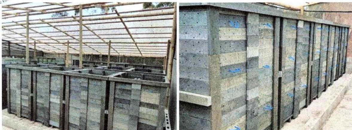
Imágenes 1 y 2. Instalación sistemas de compostaje municipio de La Unión.
