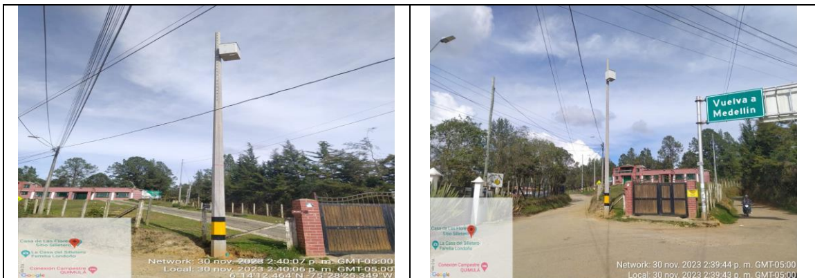
Registro Fotográfico 33 ID PTZ 2198 Instalación de gabinete.
