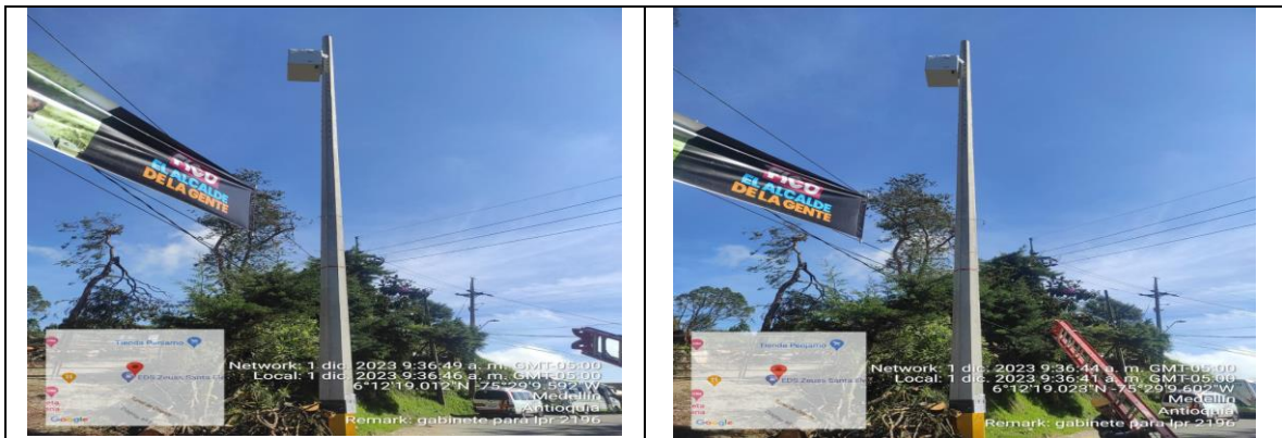
Registro Fotográfico 32 ID PTZ 2196 Instalación de gabinete.
