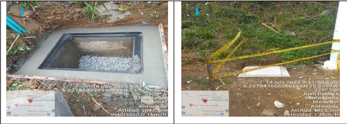
Registro Fotográfico 15 ID LPR 194 Colocación de triturado, marco y tapas.
