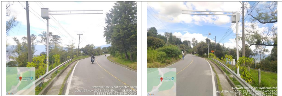
Registro Fotográfico 25 ID LPR 191-2 Instalación de gabinete, corona y tierra.
