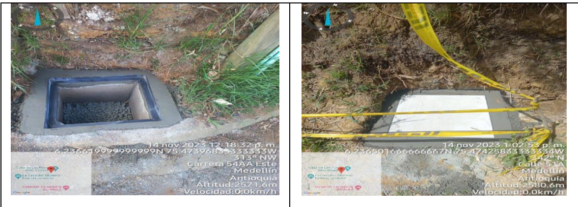
Registro Fotográfico 16 ID LPR 195 Colocación de triturado, marcos y tapas.
