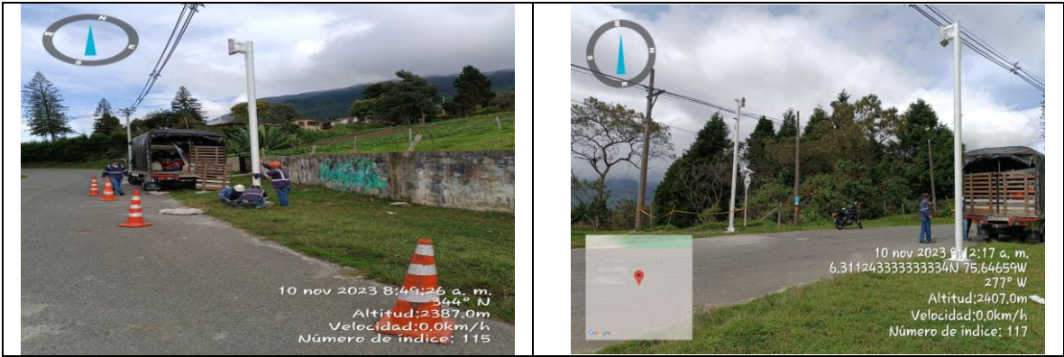
Registro Fotográfico 4 ID LPR 190 Instalación de mástiles.
