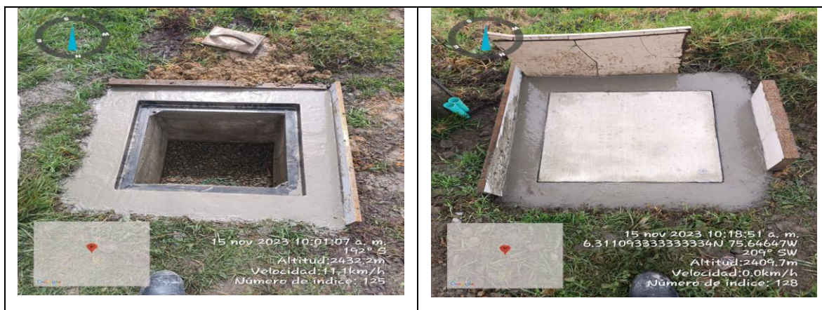
Registro Fotográfico 12 ID LPR 190 Colocación de triturado, marcos y tapas.
