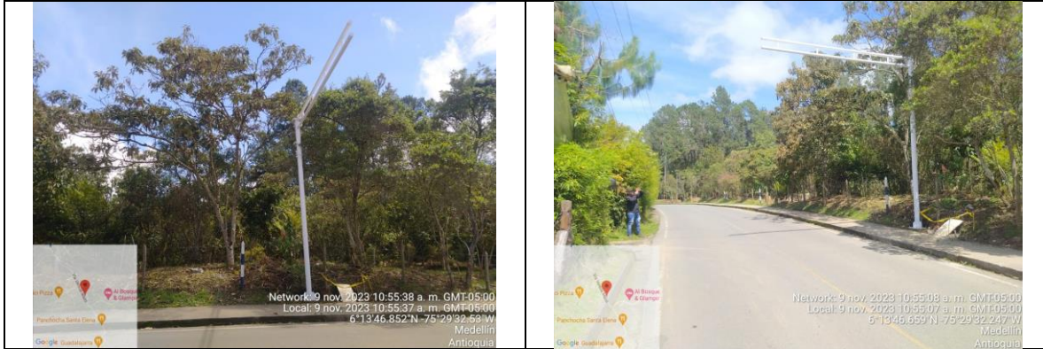
Registro Fotográfico 9 ID LPR 196 Instalación de brazo en mástil.
