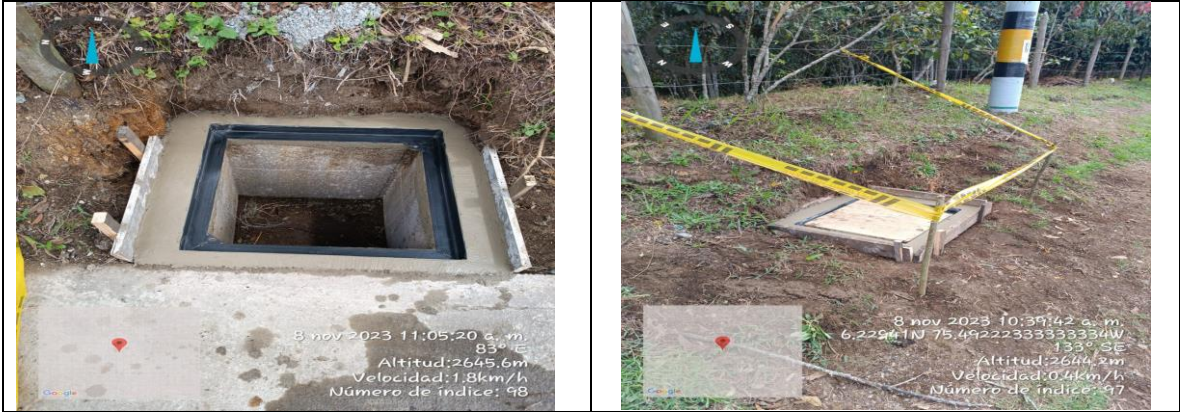
Registro Fotográfico 1 ID LPR 196 Instalación de marcos para cajas de paso.
