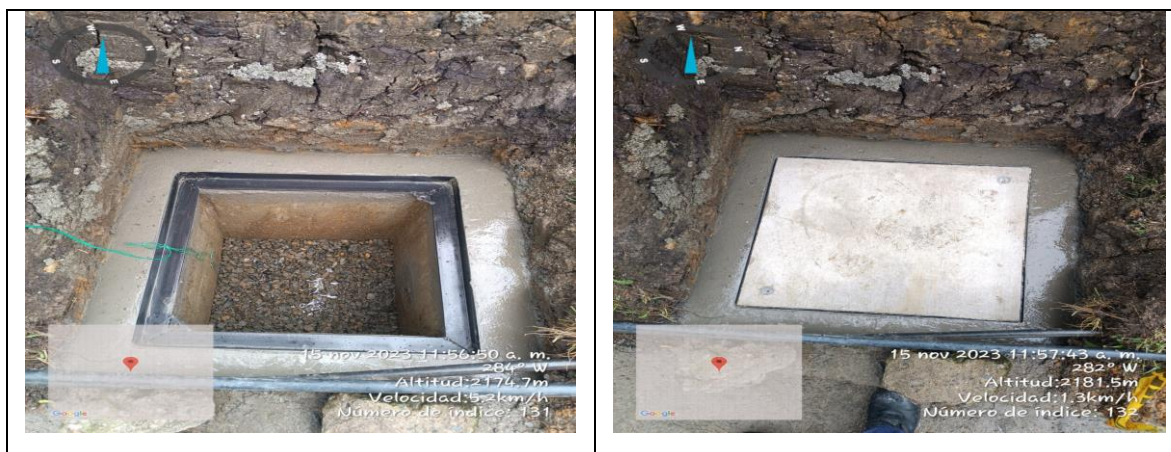
Registro Fotográfico 13 ID LPR 191-1 Colocación de triturado, marco y tapa.
