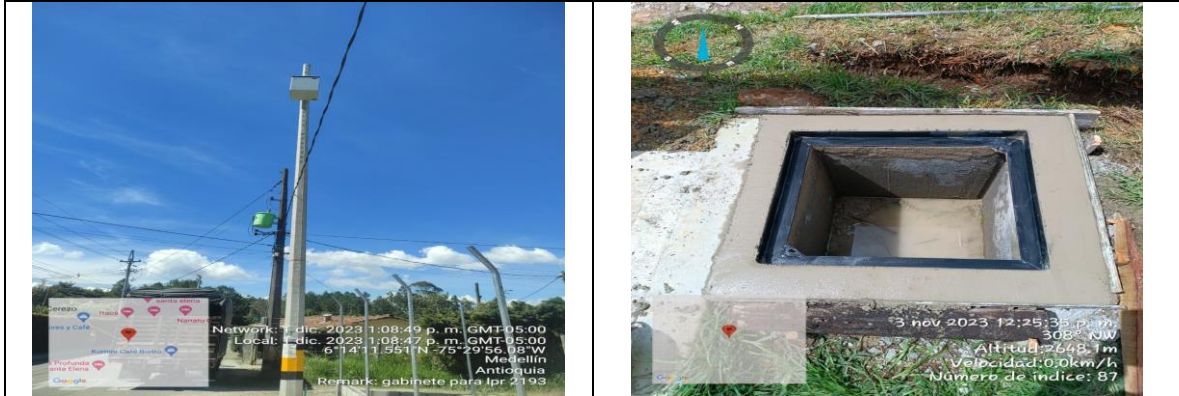
Registro Fotográfico 31 ID PTZ 2193 Instalación de gabinete.
