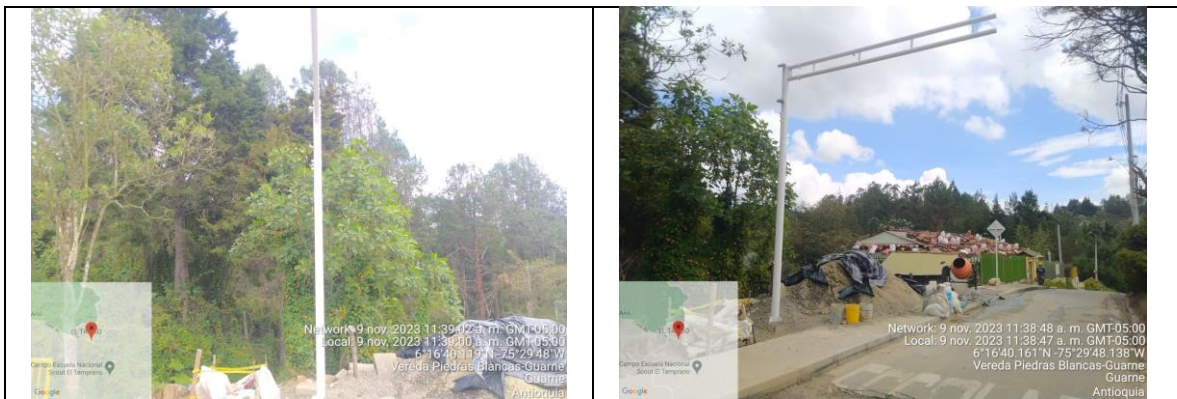
Registro Fotográfico 10 ID LPR 197 Instalación de brazo en mástil.
