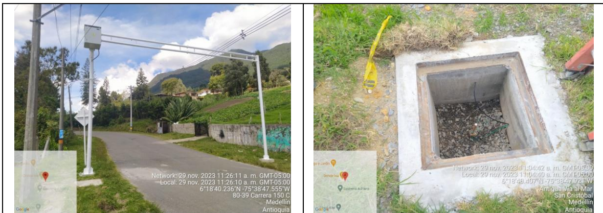
Registro Fotográfico 23 ID LPR 190 Instalación de gabinete, corona y tierra.
