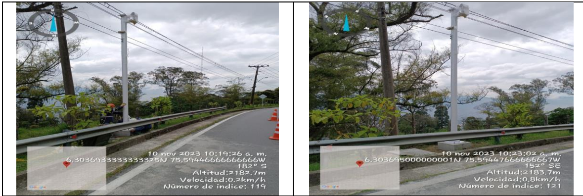
Registro Fotográfico 6 ID LPR 191-2 Instalación de mástil.
