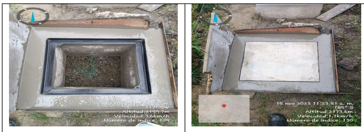
Registro Fotográfico 14 ID LPR 191-2 Colocación de triturado, marco y tapa.
