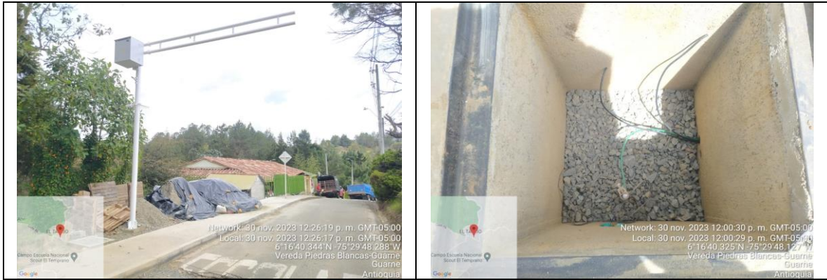
Registro Fotográfico 28 ID LPR 197 Instalación de gabinete, corona y tierra.
