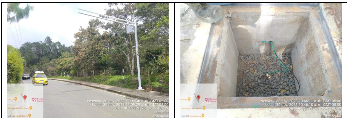
Registro Fotográfico 27 ID LPR 196 Instalación de gabinete, corona y tierra.
