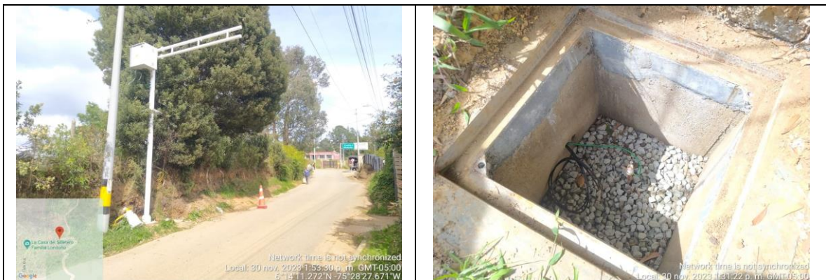
Registro Fotográfico 26 ID LPR 195 Instalación de gabinete, corona y tierra.
