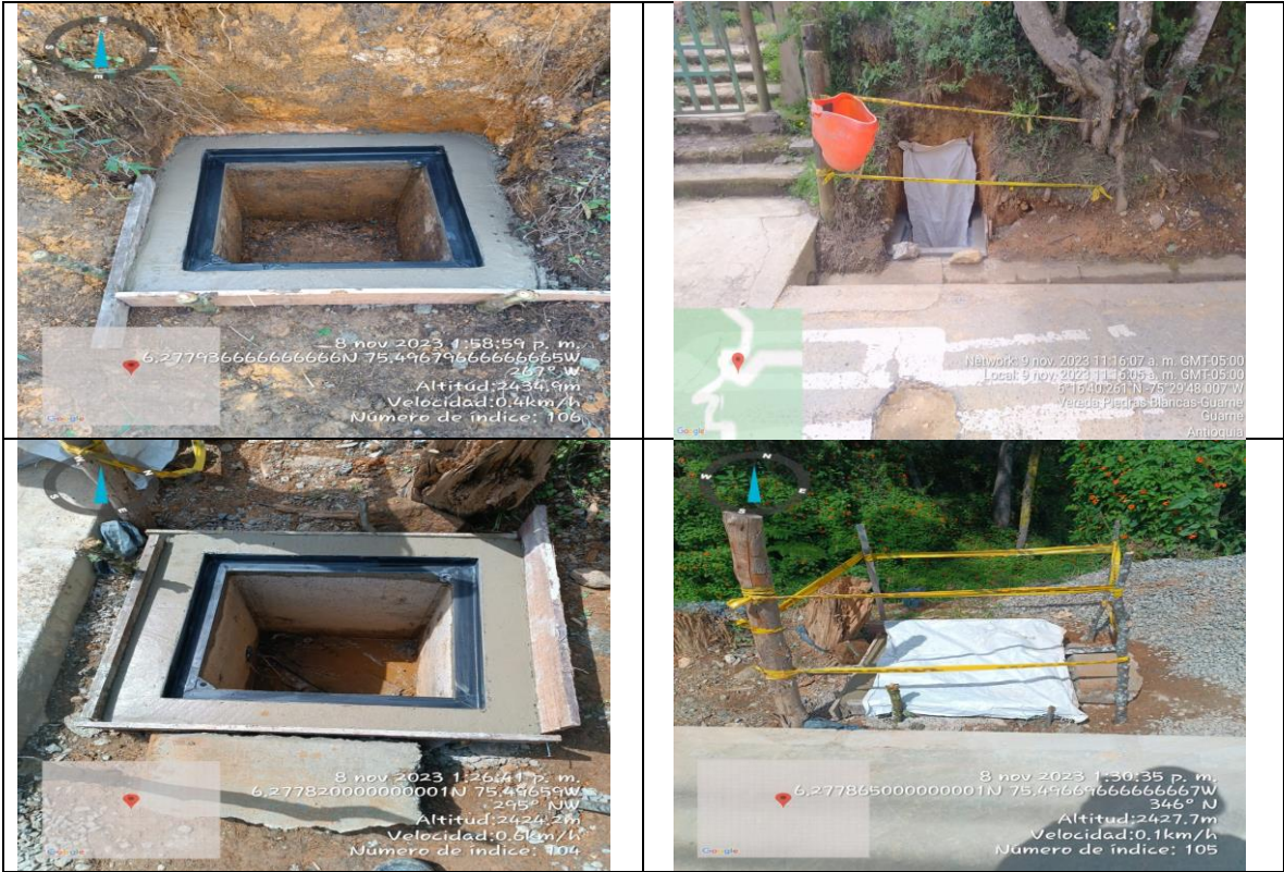
Registro Fotográfico 2 ID LPR 197 Instalación de marcos.
