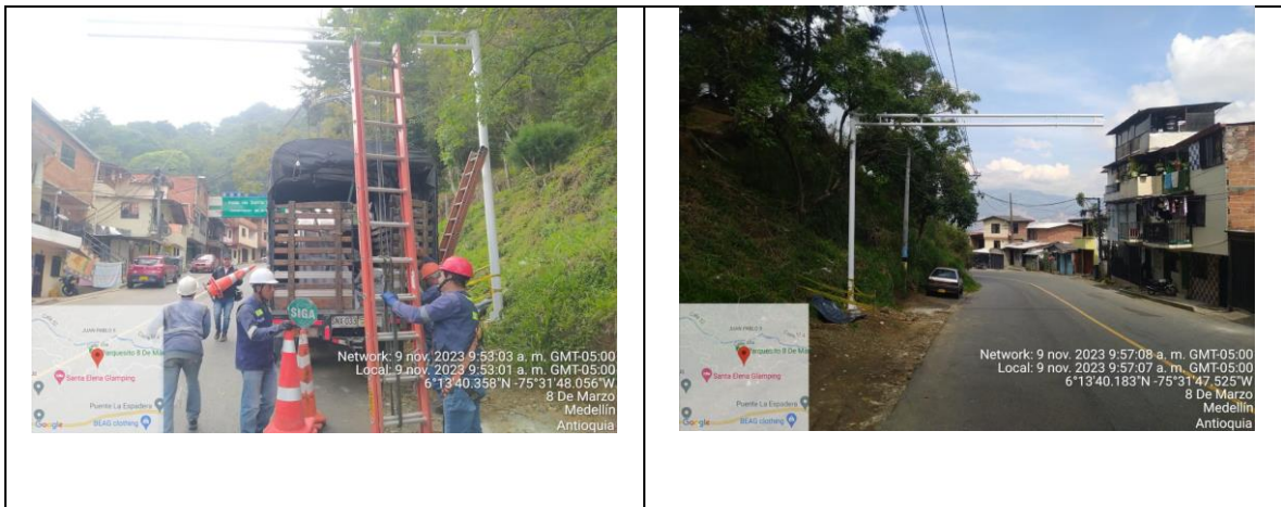
Registro Fotográfico 7 ID LPR 194 Instalación de brazo en mástil.
