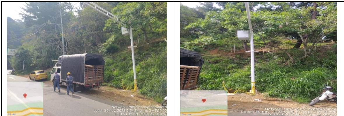
Registro Fotográfico 29 ID LPR 194 Instalación de gabinete y corona.
