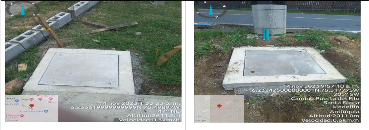
Registro Fotográfico 20 ID PTZ (2201 Y 2203) Colocación de tapa.
