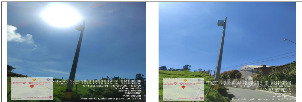
Registro Fotográfico 30 ID PTZ 2174 Instalación de gabinete.
