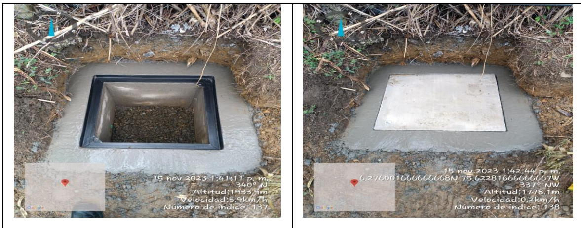
Registro Fotográfico 11 ID LPR 189 Colocación de triturado, marco y tapa.
