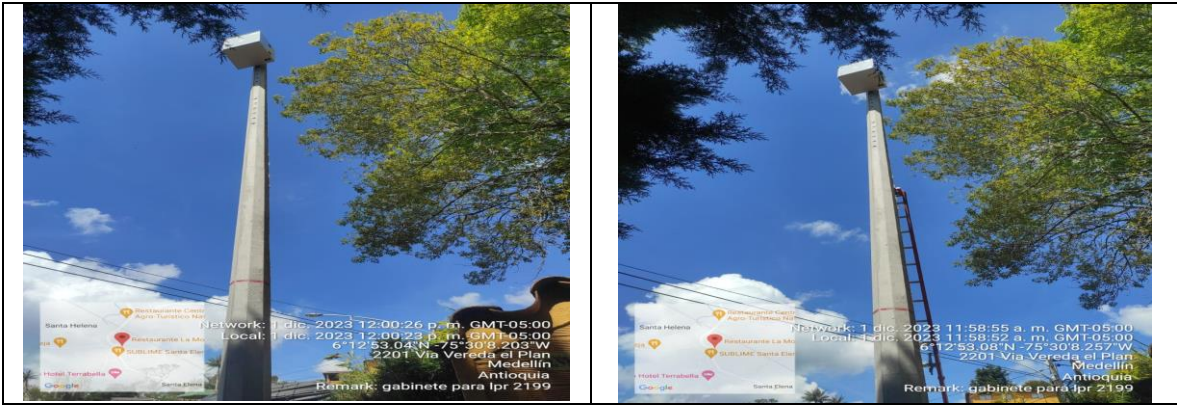
Registro Fotográfico 34 ID PTZ 2199 Instalación de gabinete.
