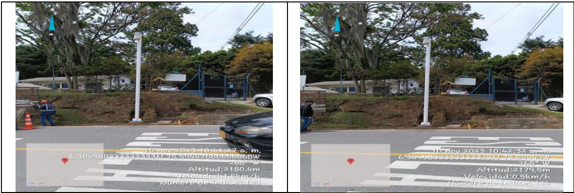
Registro Fotográfico 5 ID LPR 191-1 Instalación de mástil.
