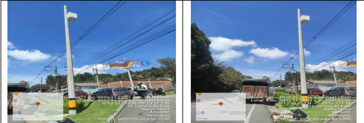
Registro Fotográfico 35 ID PTZ 2200 Instalación de gabinete.
