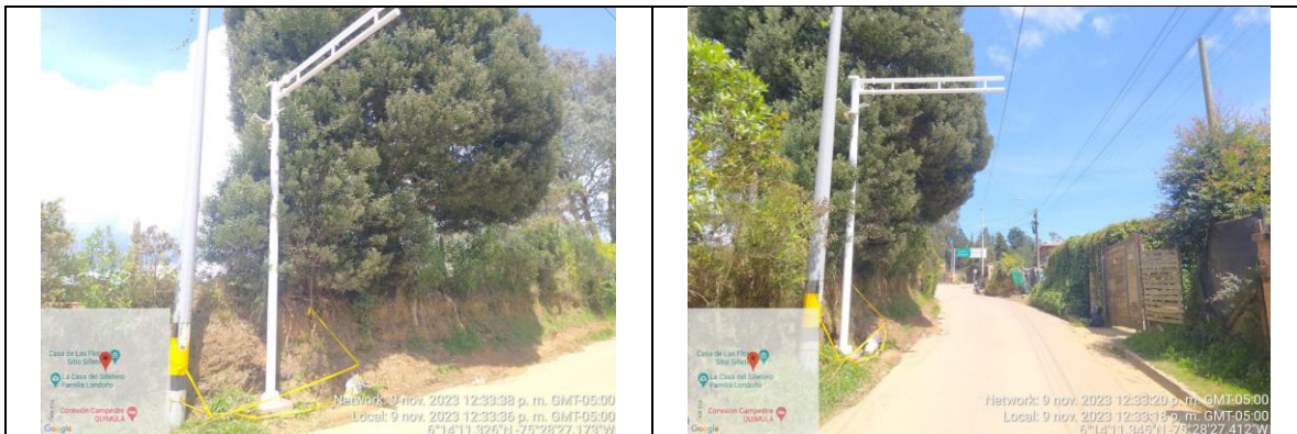
Registro Fotográfico 8 ID LPR 195 Instalación de brazo en mástil.
