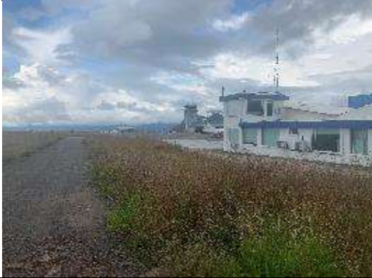
Figura 9. Cabecera 02 Sur. Vista hacia el norte, via servidumbre.
