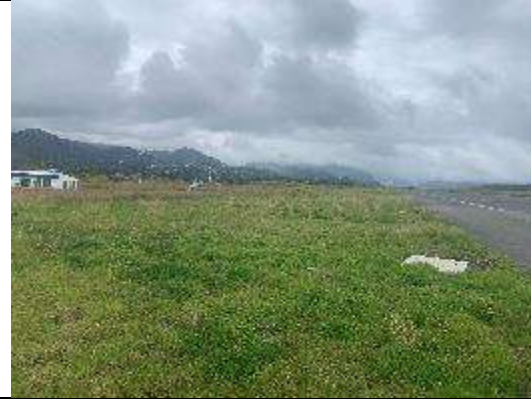
Figura 12. Cabecera 02 Sur. Vista hacia el sur. Franja de seguridad terminada a nivel de césped, observe la irregularidad de la superficie.
