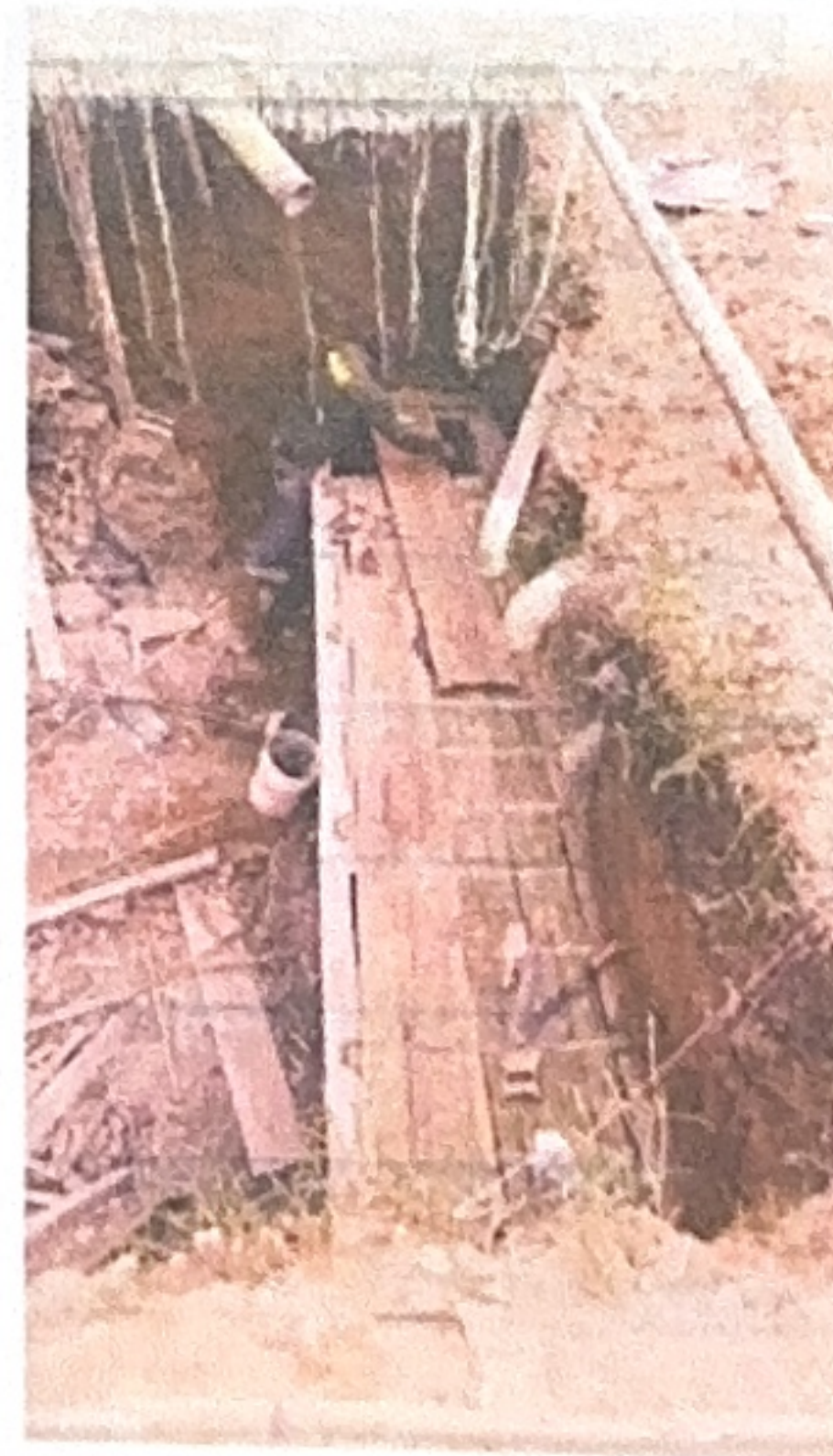
Construcción caja de salida humedal
