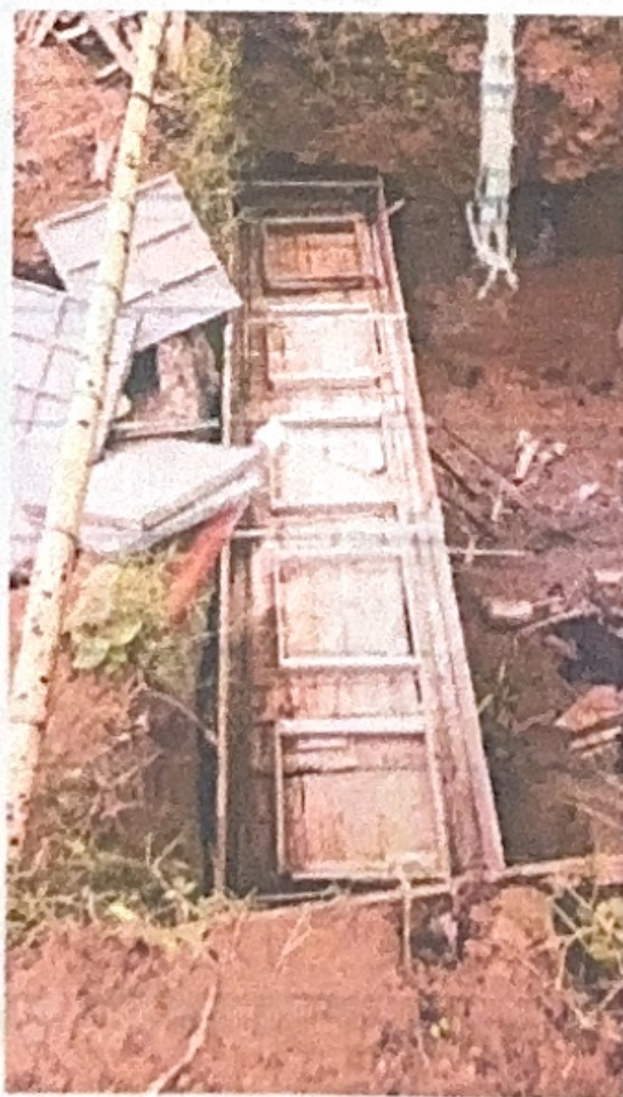
Construcción caja de entrada a humedal
