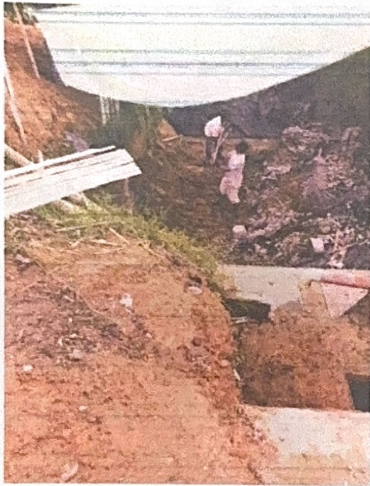
Excavación para humedal artificial
