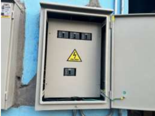
Montaje de Tablero de Conexión, frente muerto
