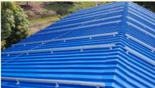
Instalación de Monturas SFV1 y SFV2
