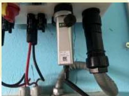
Inversor de 10 kW – Sistema Wifi – SFV1
