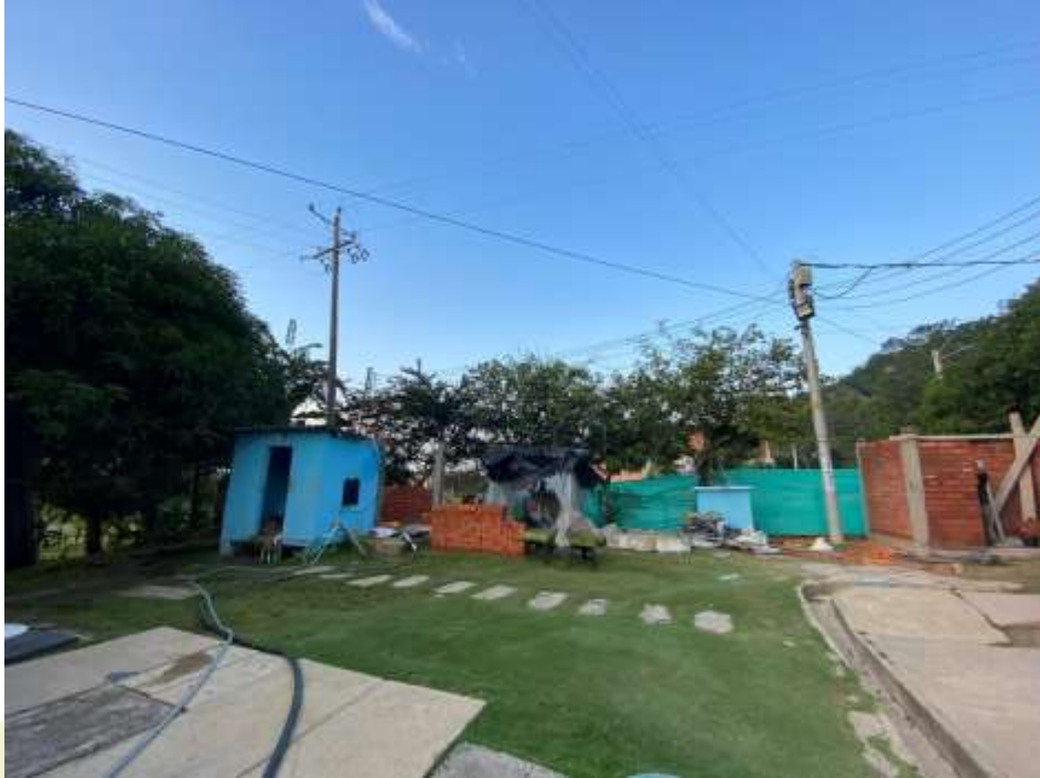
Foto 1: Intervención física en el medidor de cuenta No 713601 no es factible conectar (integrar) uno de los sistemas fotovoltaicos de 10 kWp.
