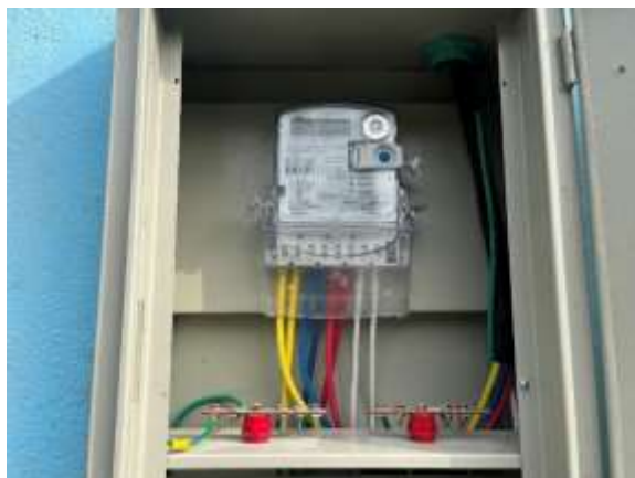
Medidor Bidireccional
