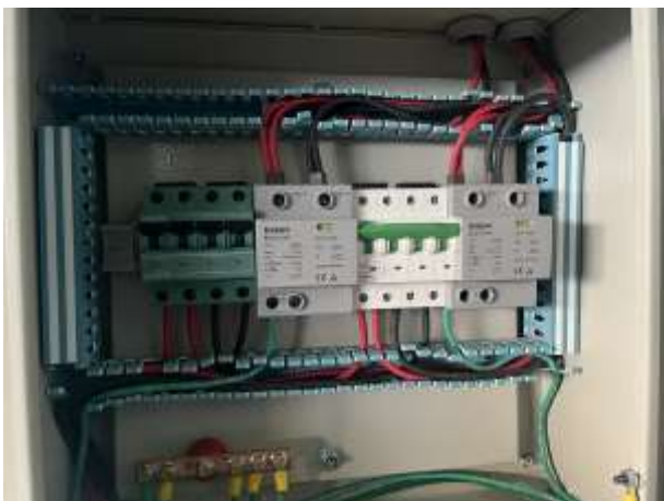
Protecciones DC Sobre corriente y sobre tensión – SFV1 - Cableados
