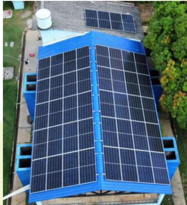
Instalación de 44 paneles de 550 w SFV1 y SFV2
