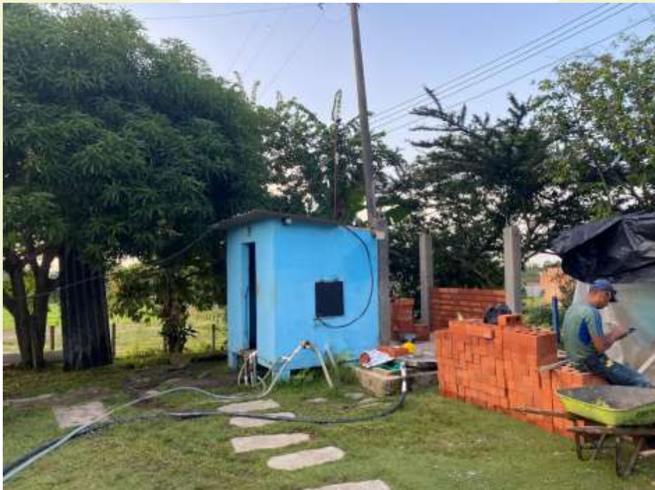
Foto 2: Intervención física en el medidor de cuenta No 713601 no es factible conectar (integrar) uno de los sistemas fotovoltaicos de 10 kWp.
