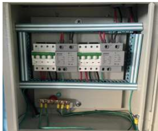
Protecciones DC Sobre corriente y sobre tensión – SFV2 - Cableados
