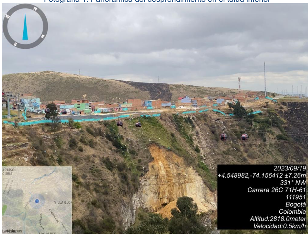
Fotografía 1. Panorámica del desprendimiento en el talud inferior
