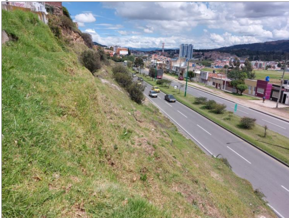
Figura 18. Talud en estudio
