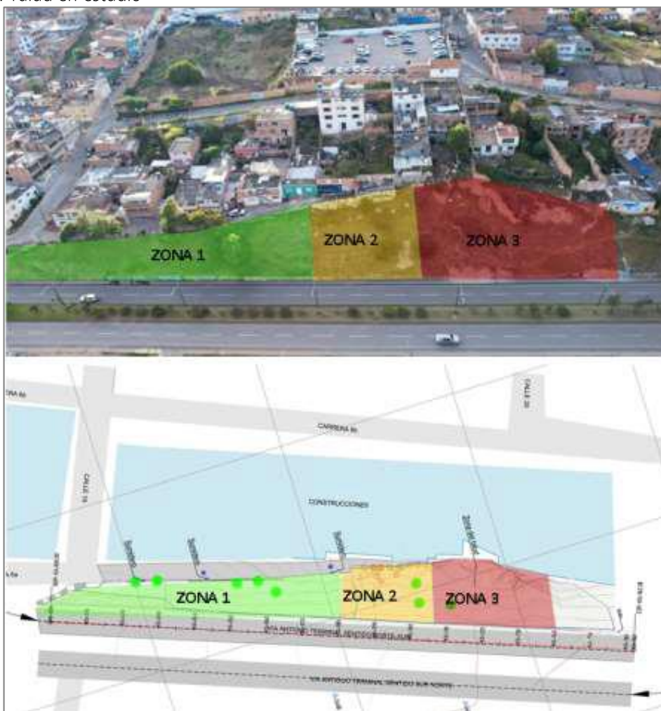
Figura 17. Talud en estudio
