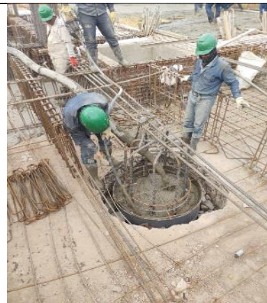
Adecuación dado pilote PL-13 Edificio B.
