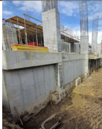
Muro de contención de concreto armado, de hasta 3 m de altura, realizado con concreto f'c=350 \text{ kg/cm}^2 (35 MPa), premezclado en planta. Precio No incluye el acero.
