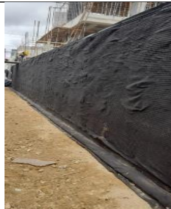
Geodren vial, incluye tubería perforada de 4".
