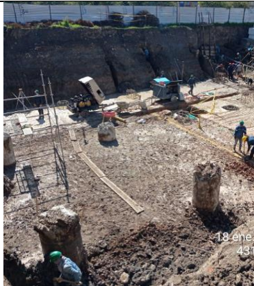
Conformación manual de subrasante.
