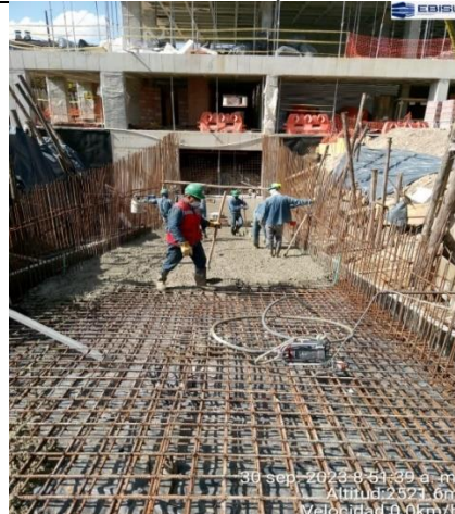
Construcción rampa vehicular e=30 cm.
