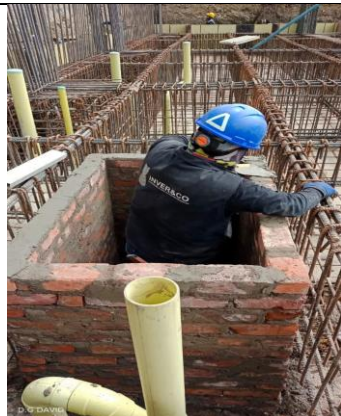
Construcción cajas de inspección.
