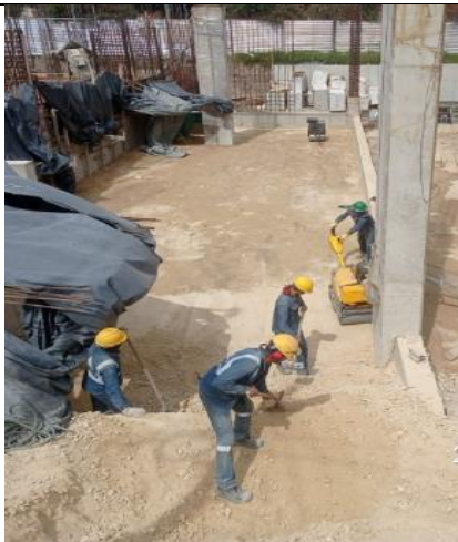
Relleno compactado con material importado.
