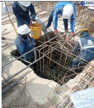
Adecuación dado pilote PL-46 Edificio A.
