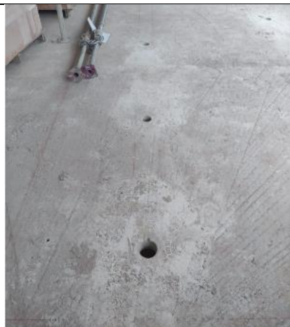
Perforación de placa con saca-núcleos.
