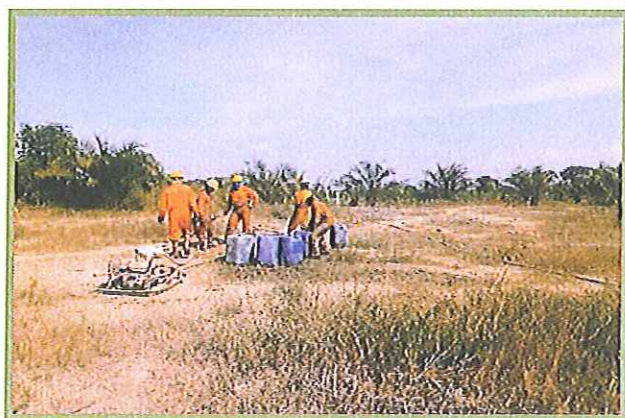
Fotografía 70. Trabajos de perforación en el Predio la España.
