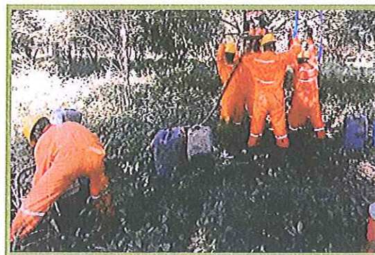
Fotografía 18. Inspección a cuadrilla de taladro.
