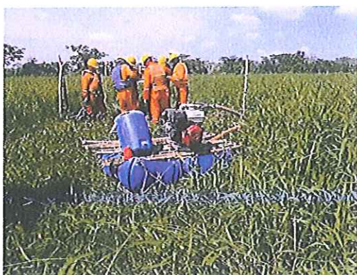
Foto. 14. Perforación en bajos pantanoso
