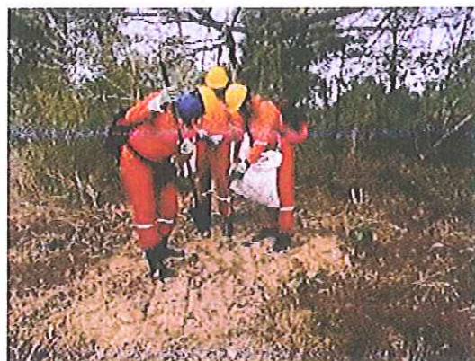
Foto. 43 Labores de restauración.
