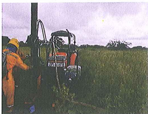
Foto. 13. Perforación con Tractor Drill
