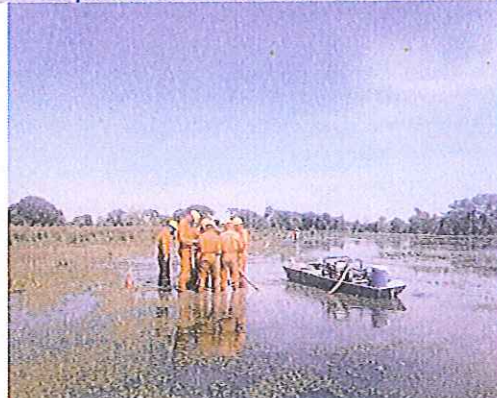
Foto. 15. Perforación en zonas de difícil acceso
