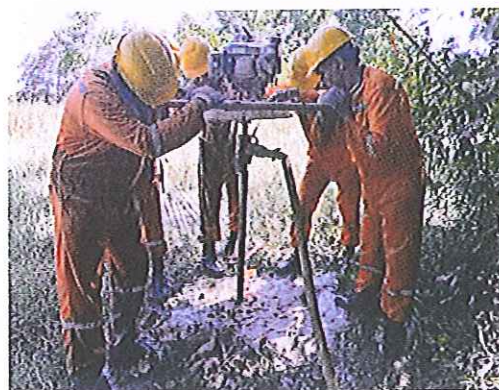
Foto. 10. Perforación con fluido agua
