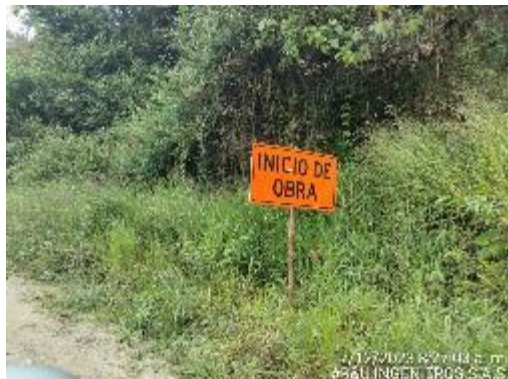
Fotografía 4: Instalación de señalización vertical en obra.
