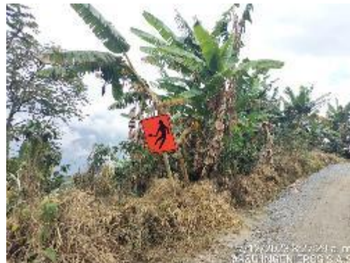
Fotografía 5: Instalación de señalización vertical en obra.
