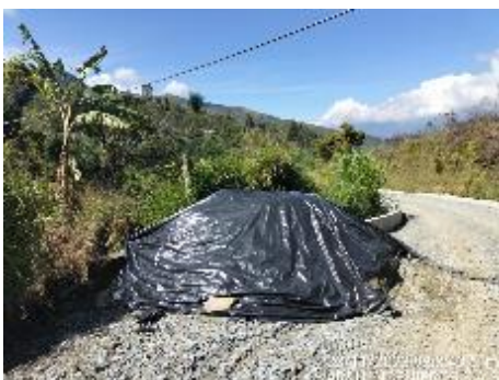
Fotografía 3: Acopio temporal de material pétreo.
