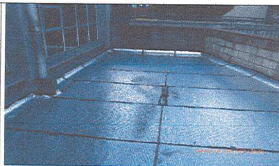
Fotografía No. 8: Zona terrazas- párvulos: instalación de manto foil aluminio
