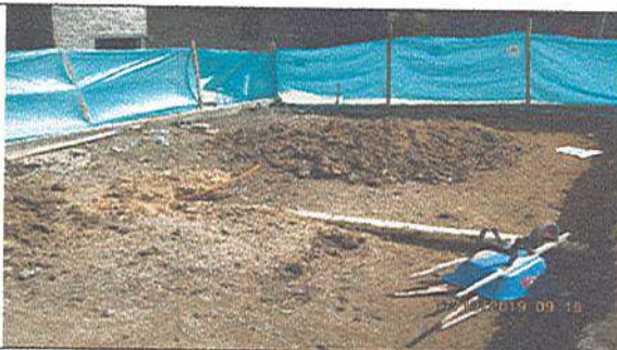
Fotografía No. 4: Remoción de suelo excavado para construir placa cocina móvil.
