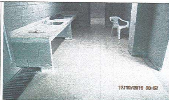
Fotografía No. 2: Pulida de tableta en granito y colocación de rejillas en cárcamo
