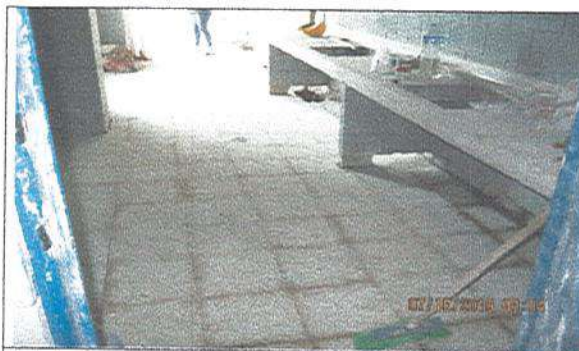
Fotografía No. 1: Salones de Arte - Instalación de tableta en granito
