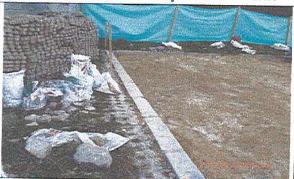
Fotografía No. 4: Zona juegos infantiles: alistado piso antes de fundir placa
