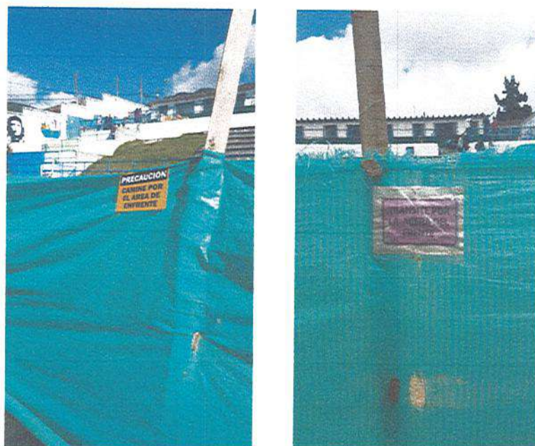
Fotografía 27. Señalización Colegio La Belleza Los Libertadores
