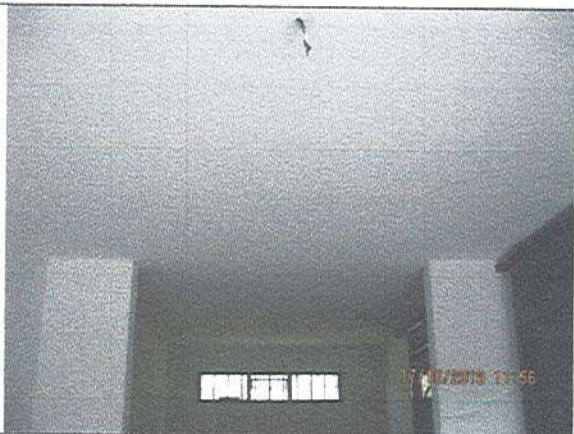
Fotografía No. 5: Instalación nuevo cielo raso cuarto emisora
