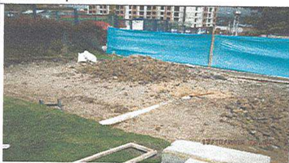
Fotografía No. 3: Excavación de zona para adecuar terreno
