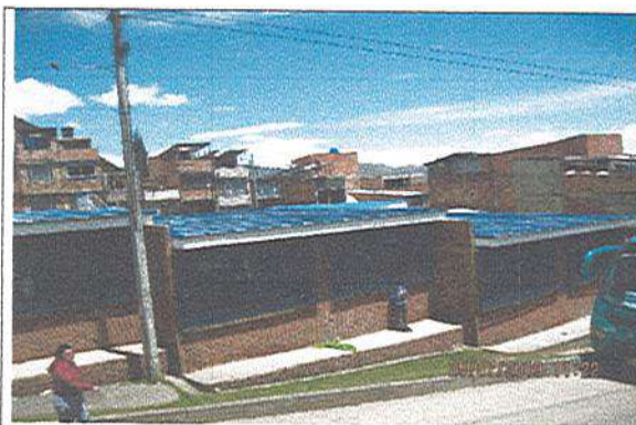
Fotografía No. 1: Fachada exterior - Cubierta
