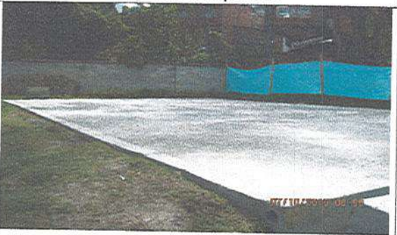
Fotografía No. 5: Zona juegos infantiles: presentación placa de concreto.
