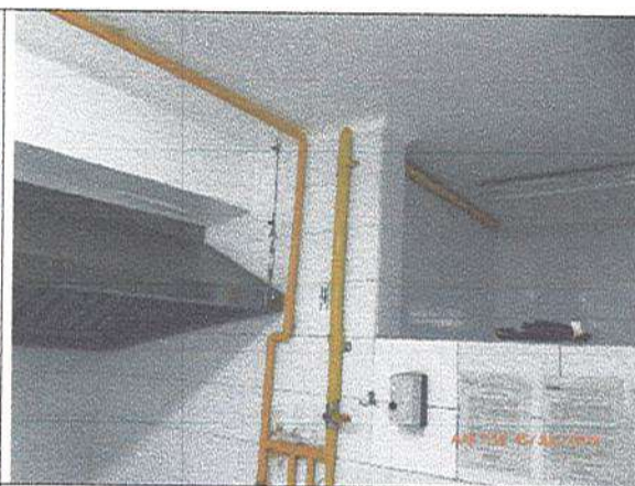
Fotografía No. 2: Segundo nivel cocinas - ampliación red gas
