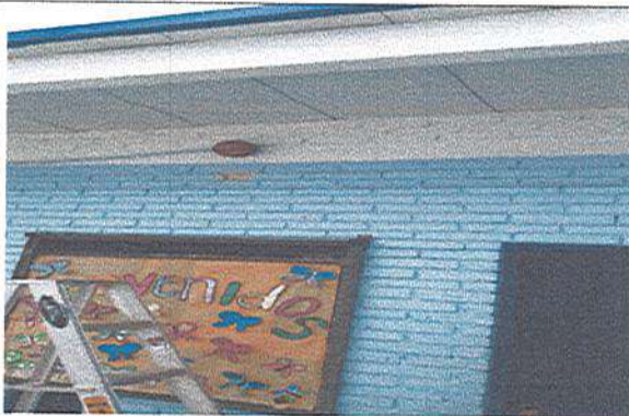
Fotografía No. 4: Instalación de timbre
