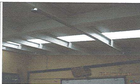
Fotografía No. 3: Montaje cubierta y nueva red eléctrica- salones
