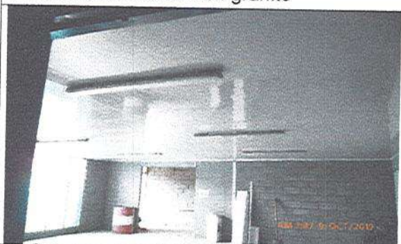
Fotografía No. 3: Terminación de cielo en PVC y colocación de lámparas.
