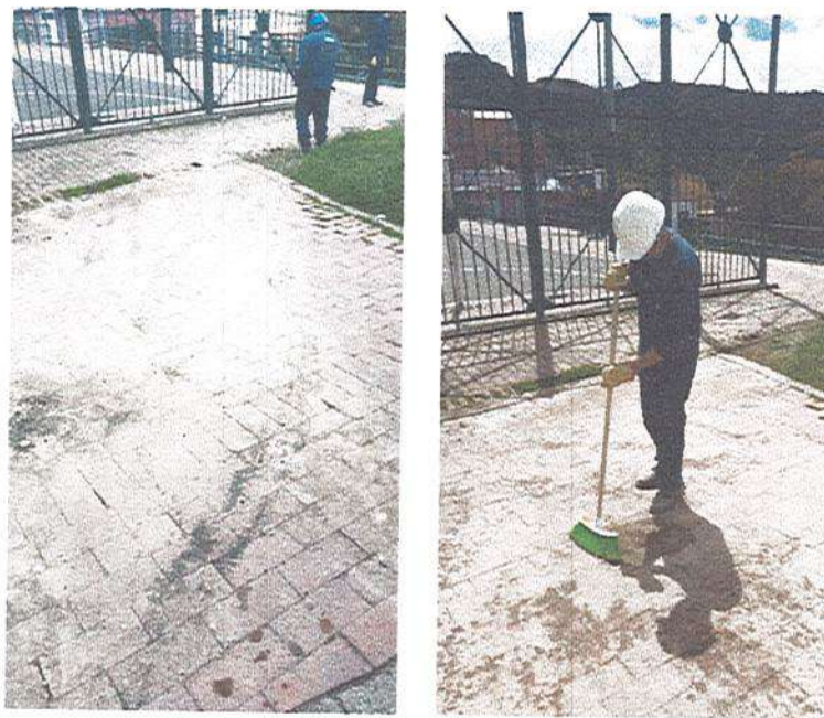
Fotografía 16. Orden y Aseo
