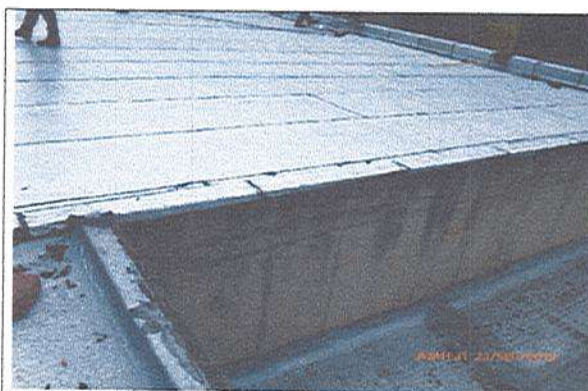
Fotografía No. 5: Nuevo- Manto edificio Administración
