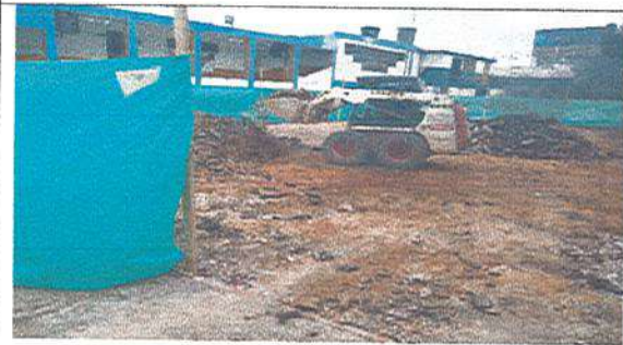
Fotografía No. 3: Retiro de asfalto con minicargador
