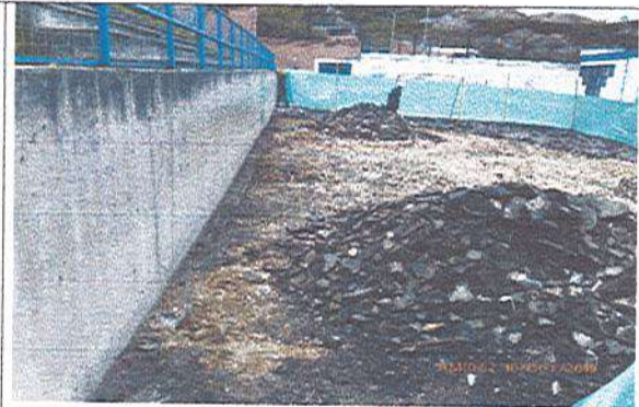
Fotografía No. 2: Demolición carpeta de asfalto
