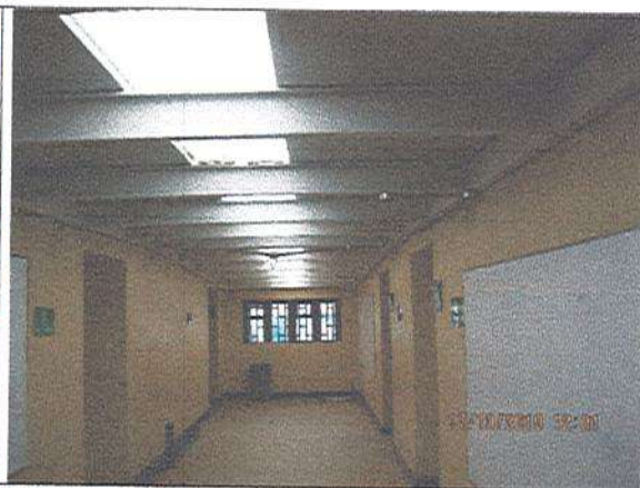
Fotografía No. 2: Cambio cubierta – interior pasillo
