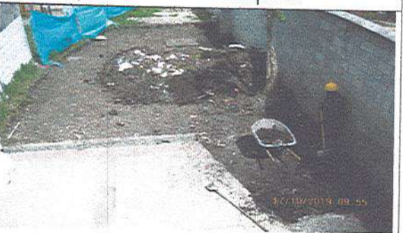
Fotografía No. 6: Zona externa salones Arte – descapote de suelo
