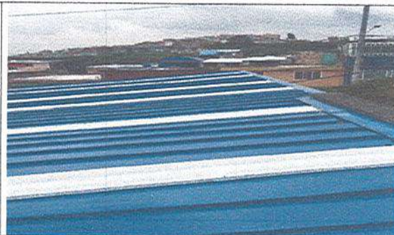
Fotografía No. 4: Panorámica cubierta ala oriental salones
