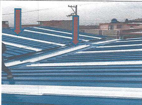
Fotografía No. 6: Panorámica cubierta pasillo central y ala occidental salones
