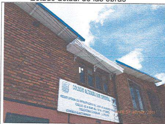
Fotografía No. 1: fachada - cambio de cubierta y canal en salones y pasillo
