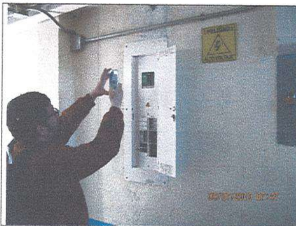
Fotografía No. 1: Tablero exterior inicial a cocina con sus tacos
