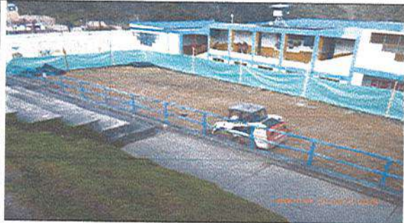
Fotografía No. 4: Área sin asfalto y conformada
