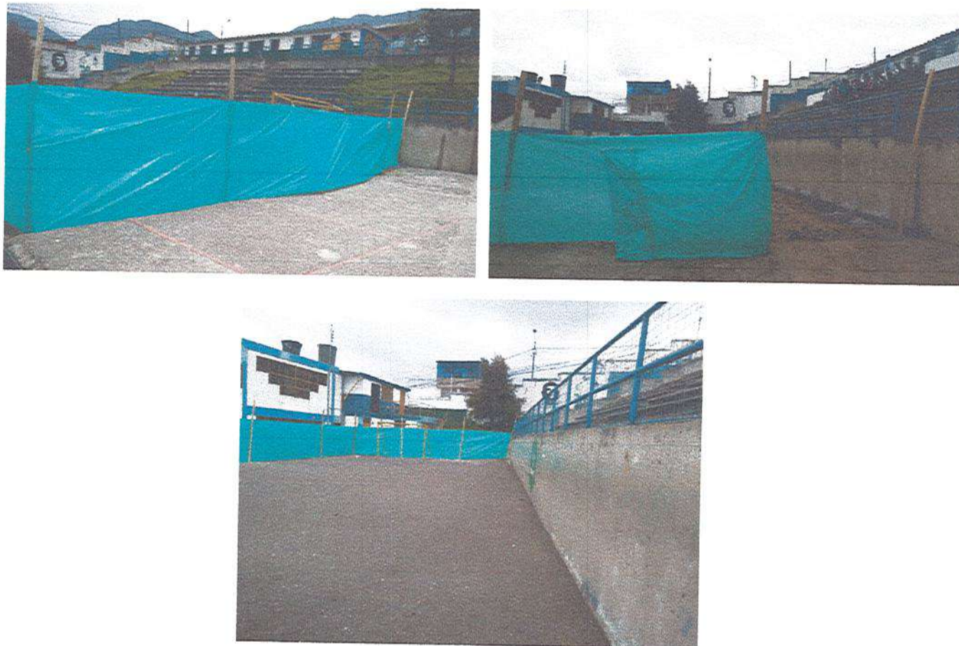
Fotografía 15. Cerramiento de la obra
