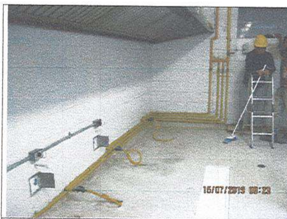
Fotografía No. 1: Segundo nivel - Ampliación red gas y eléctrica
