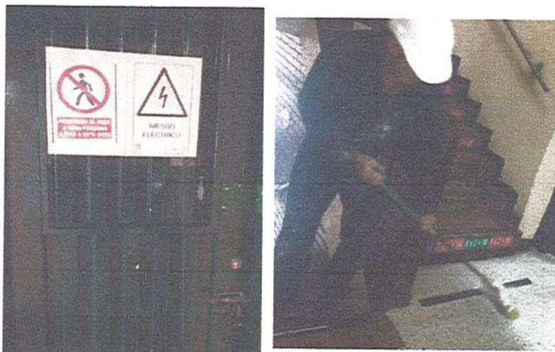
Fotografía 24. Orden y Aseo
