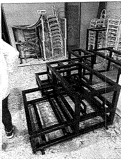
Estructura ME-07 JARDINERA METÁLICA Y
