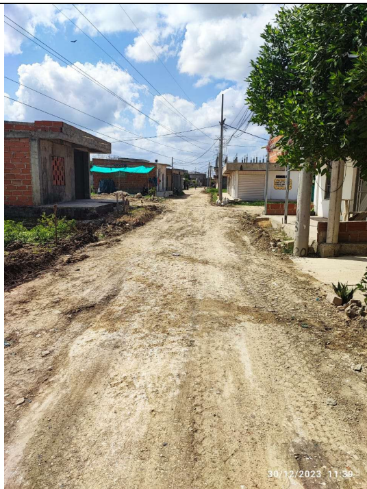
CONFORMACION DE CALZADA
