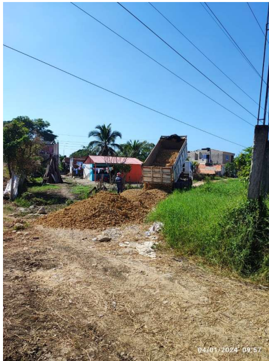
RELLENO CON ZAHORRA O MATERIAL SELECCIONADO
