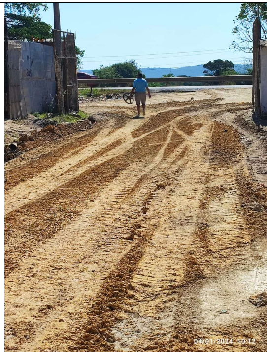
CONFORMACION DE CALZADA
