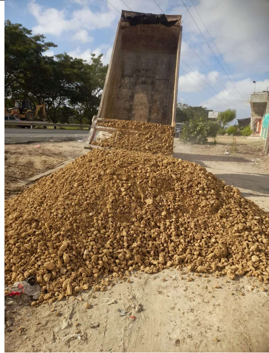
RELLENO CON ZAHORRA
