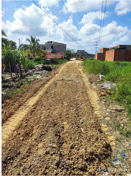
RELLENO CON ZAHORRA O MATERIAL SELECCIONADO
