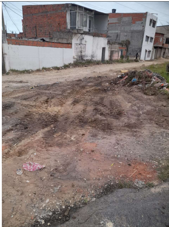
LIMPIEZA DE MATERIAL SOBRANTE A MAQUINA
