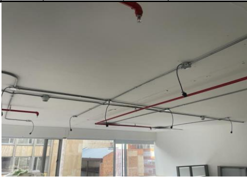
Desmonte de lámparas en el Piso 5 del edificio de la Bolsa
