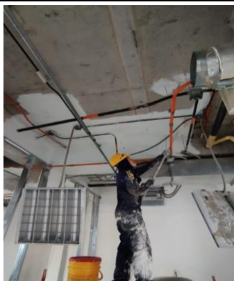
Desmonte de tubería galvanizada en el piso 3 del edificio DELCOP
