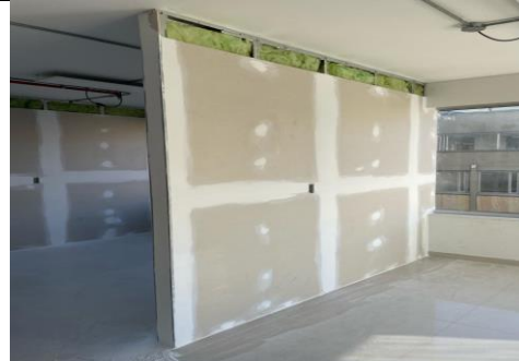
Instalación de el aislamiento termico en el Piso 6 del edificio de la Bolsa
