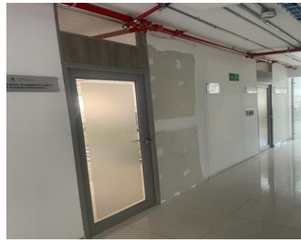
desmonte de puertas e instalación de puertas en el Piso 5 del edificio de la Bolsa
