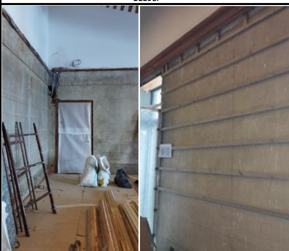
Se evidencio que se realizó el desmonte de enchape de paredes y superficies de mesas para restauración en sala plena corte constitucional
