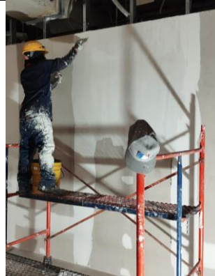
Aplicación de la pintura en los muros de super boards en el piso 3 del edificio DELCOP
