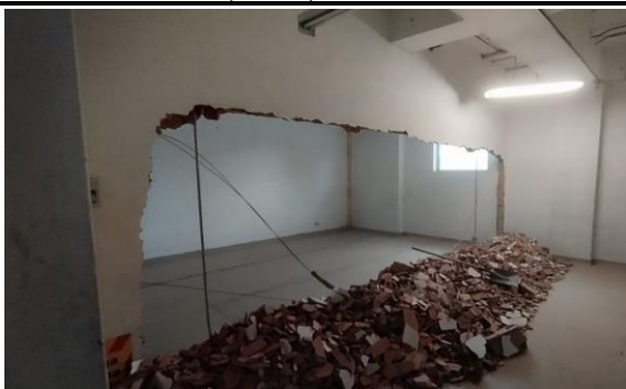
Desmonte de muro en mampostería en el piso 1 del edificio DELCOP
