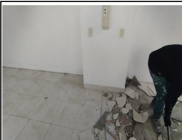
Demolición de enchape de piso existente en el piso 2 de consejo de estado en la habitación 202 de la secretaria sección tercera
