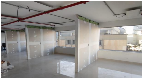
Instalación de los muros en drywall en el Piso 6 del edificio de la Bolsa
