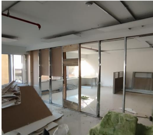
Instalacion de puntos electricos para interruptores en el Piso 6 del edificio de la Bolsa
