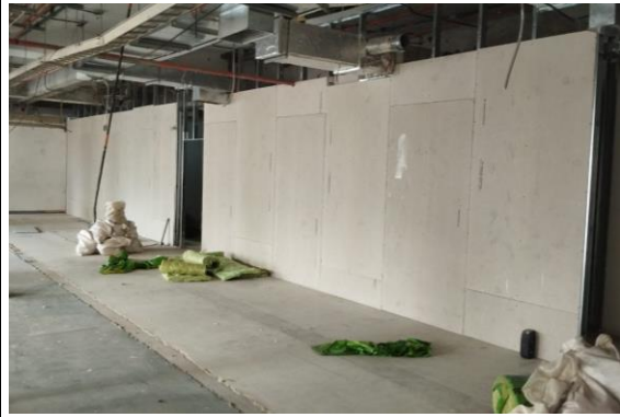
Instalación de las placas para los muros de super boards en el piso 3 del edificio DELCOP
