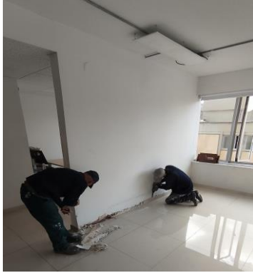
Desmonte de muro en drywall en el Piso 6 del edificio de la Bolsa
