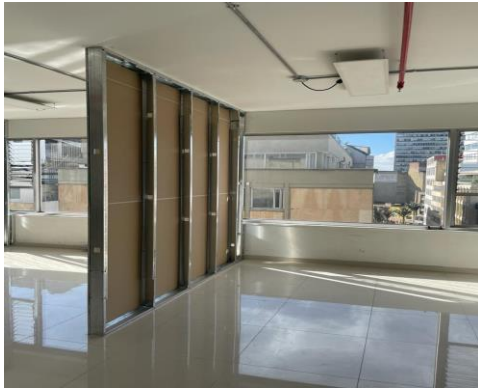
Demolición de muro en drywall en el piso 1 del edificio DELCOP
