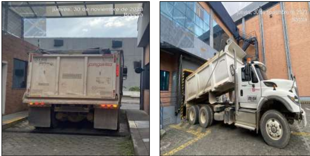
Fotografía 3. Retiro de RCD
