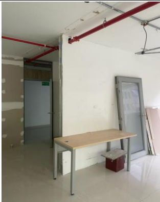
Macillado en los muros de Drywall en el Piso 5 del edificio de la Bolsa
