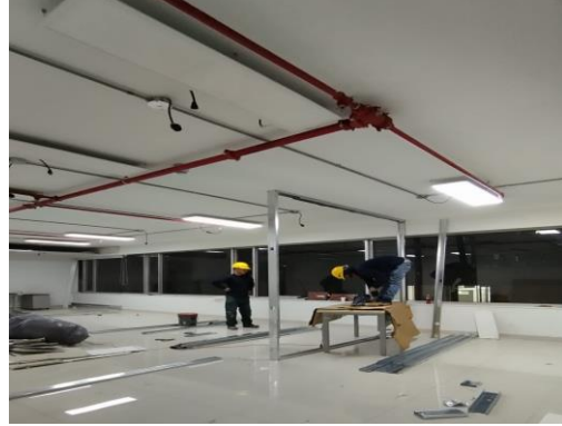
Montaje de estructura metalica para los muros en drywall en el Piso 6 del edificio de la Bolsa
