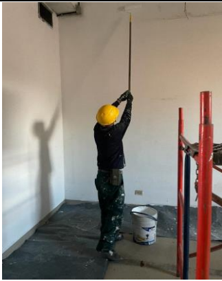
Aplicación de pintura en muros en mampostería en el piso 1 del edificio DELCOP
