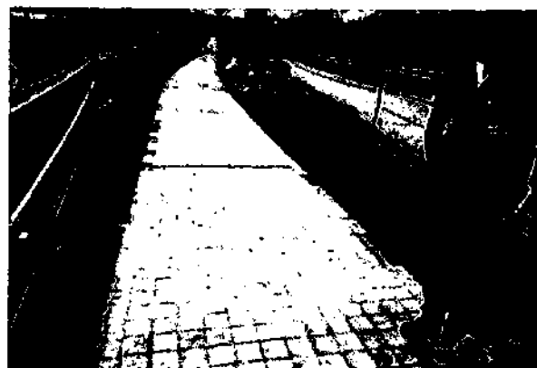
Fotografía 16 Instalación de adoquin.
