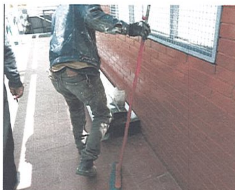
Fotografía 11: Orden y aseo en frente de trabajo Colegio Brisas del Diamante Orden y aseo en obra
