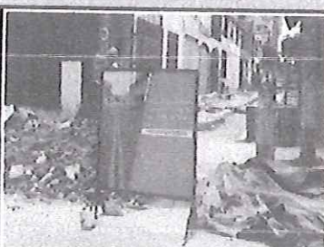
Instalación de valla informativa CIV 16004735 (Villa Inés)
