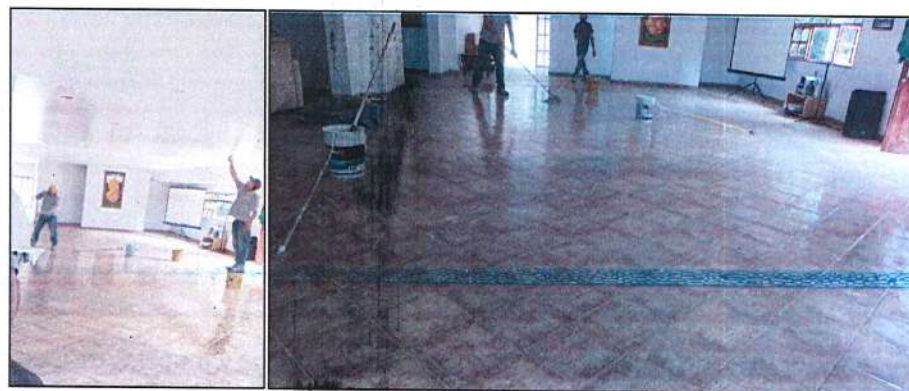
Imagen 42. Reposición de cielo raso en drywall y pintura interna.
