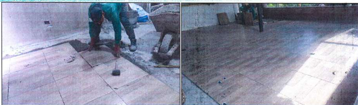
Imagen 49. instalación de cerámica de piso en área de cafetería.
