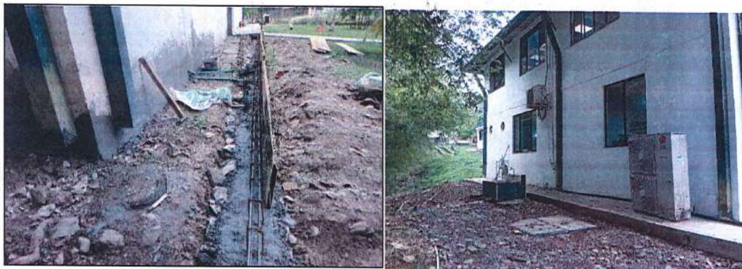
Imagen 70. Construcción de andén en concreto de 3000 PSI.
