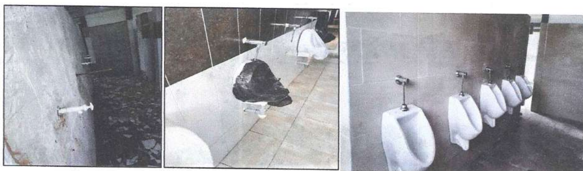
Imagen 113. reposición de orinales de baño con grifería tipo push.
