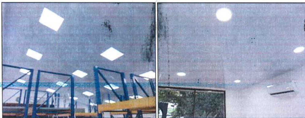
Imagen 66. Instalación de cielo raso en e iluminación en planeación.
