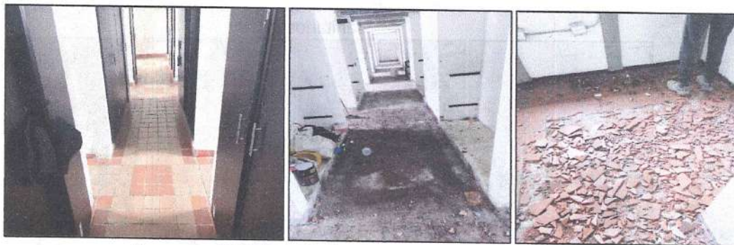
Imagen 106. Demolición de piso existente Alojamiento 5.
