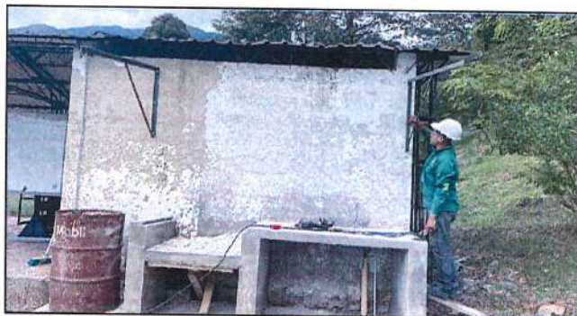
Imagen 21. Mesón de concreto, área adyacente a polígono.
