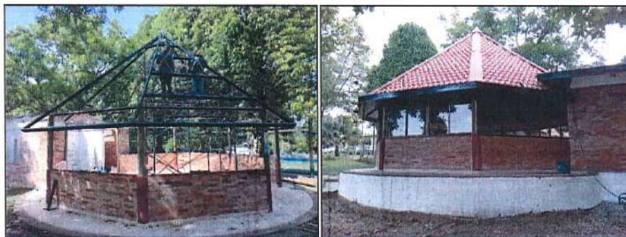
Imagen 77. Estructura metálica de cubierta y cubierta tipo española - estéreo.
