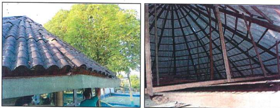
Imagen 76. Cubierta y estructura de cubierta en madera.
