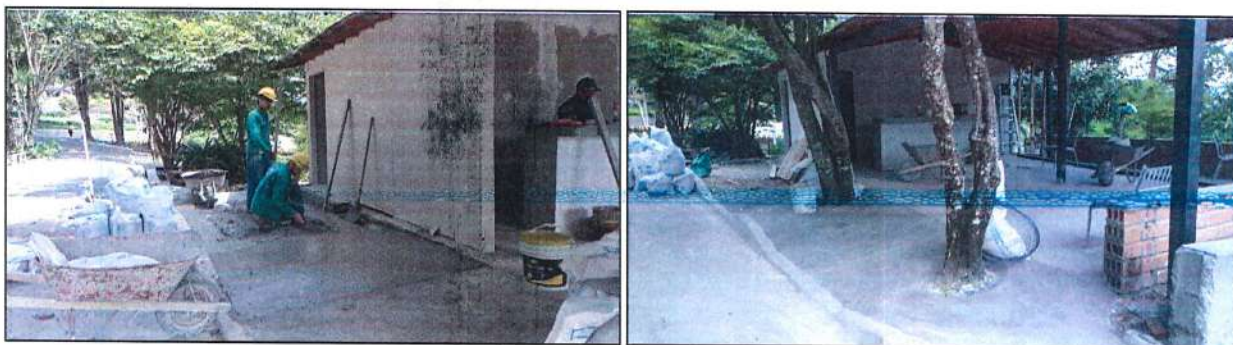
Imagen 48. Terminación de alistado de piso.
