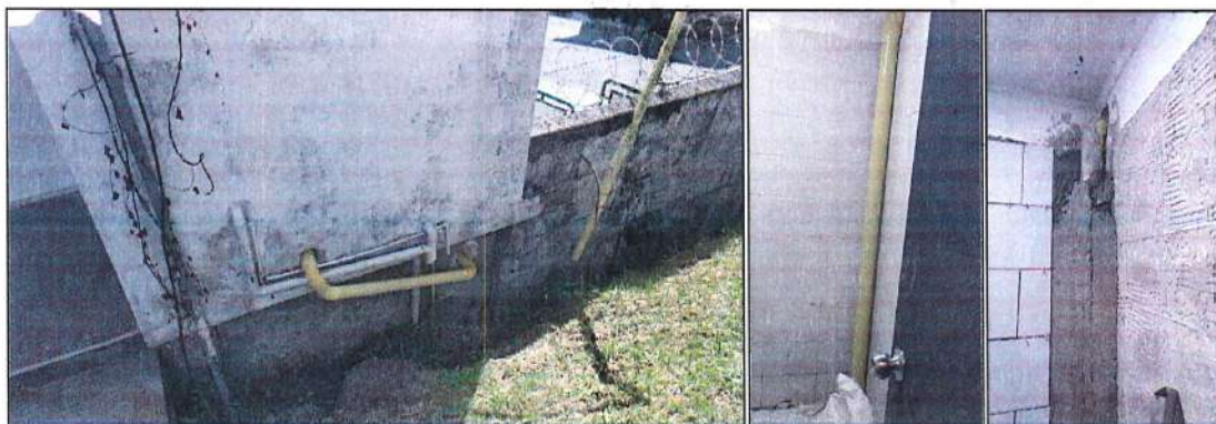
Imagen 38. Instalación de tubería sanitaria y bajante.
