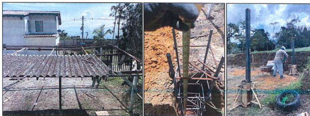
Imagen 2. Actividades de desmonte, excavación y fundición de columna en concreto
