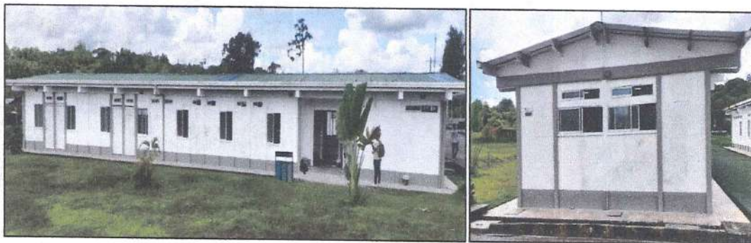
Imagen 105. Adecuación de fachadas. Pintura exterior de alta resistencia.
