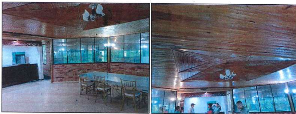
Imagen 74. Cielo raso existente en madera.
