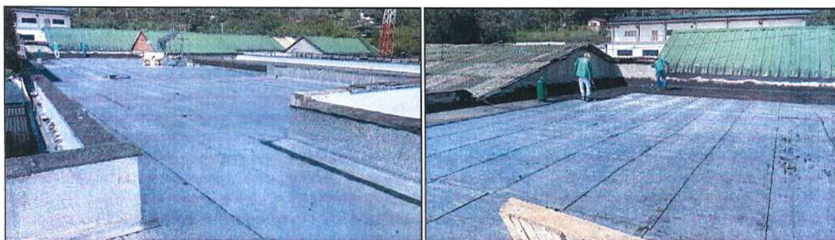
Imagen 6. Instalación de mortero impermeabilizado de 8 cm
