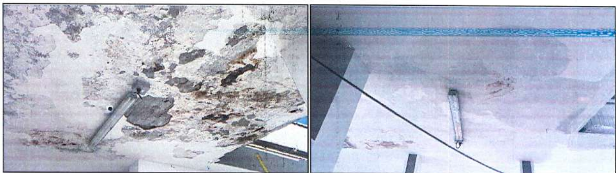
Imagen 9. Raspado de áreas deterioradas, limpieza y estucado.
