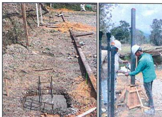
Imagen 3. Fundición de columnas e instalación de columna metálica.
