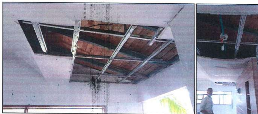
Imagen 41. Desmonte de cielo raso en drywall afectado por humedad.
