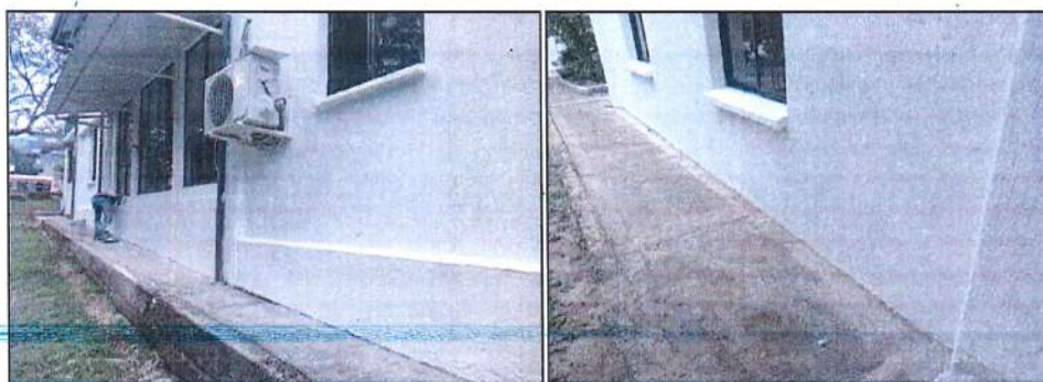
Imagen 90. Mantenimiento de fachada, incluye pintura exterior de alta resistencia.
