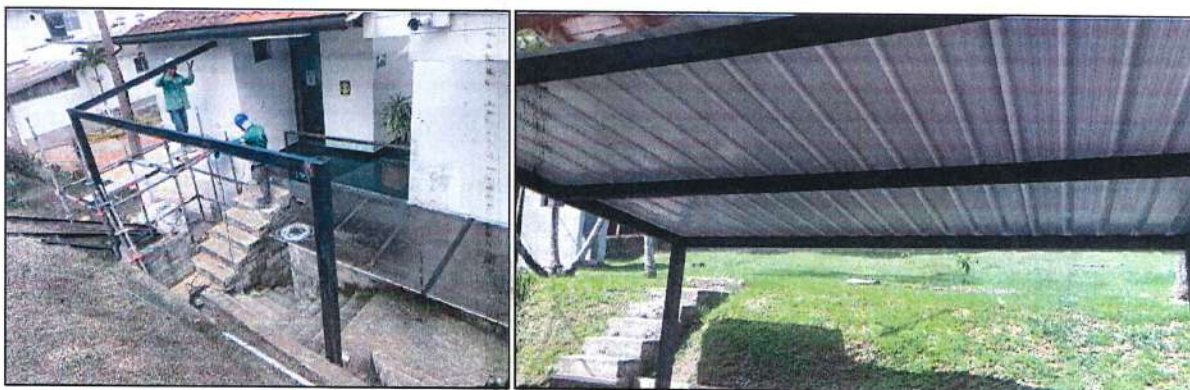
Imagen 36. Instalación de estructura metálica de cubierta y cubierta en PVC.
