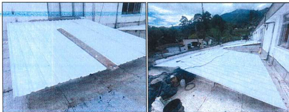
Imagen 26. Instalación de cubierta en PVC.
