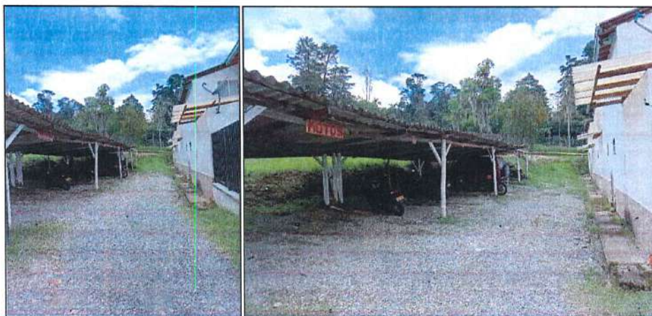
Imagen 1. Parqueadero antes de intervención.
