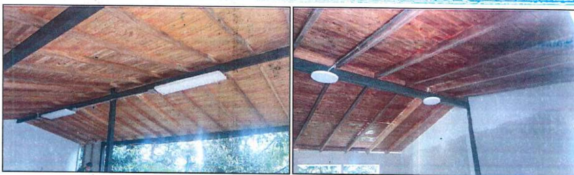
Imagen 53. Instalación de luminarias.
