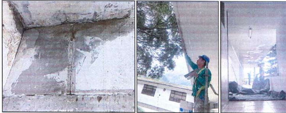
Imagen 8. adecuación de áreas afectadas por humedad en placa existentes.
