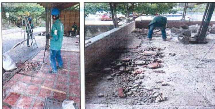
Imagen 45. Desmonte de cerámica de piso y alistado.
