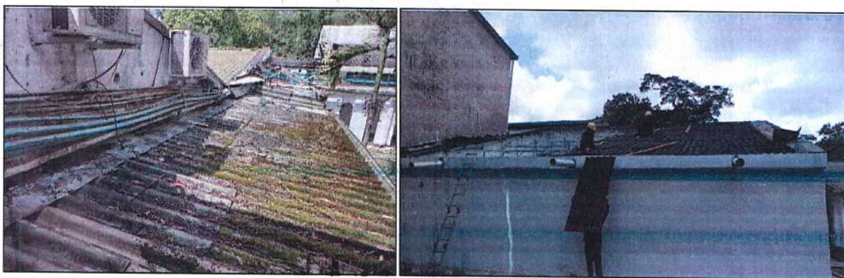
Imagen 63. Desmonte de cubierta área administrativa.
