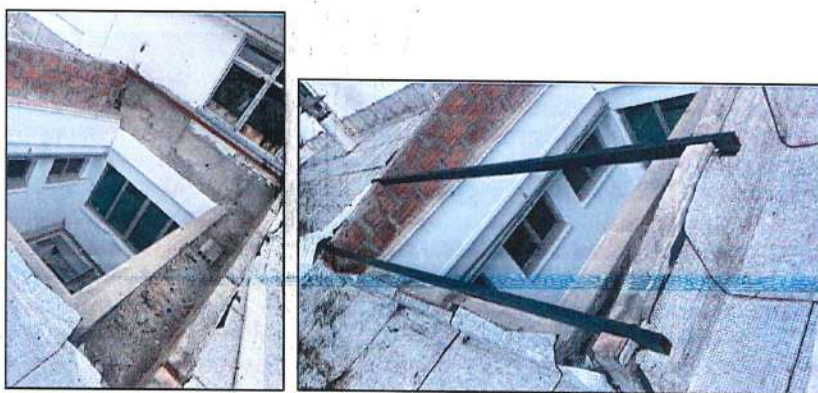
Imagen 25. Desmonte de cubierta existente e instalación de estructura metálica de cubierta.
