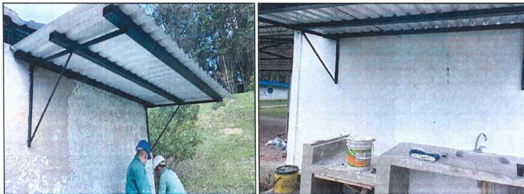
Imagen 22. Cubierta para mesón en concreto.
