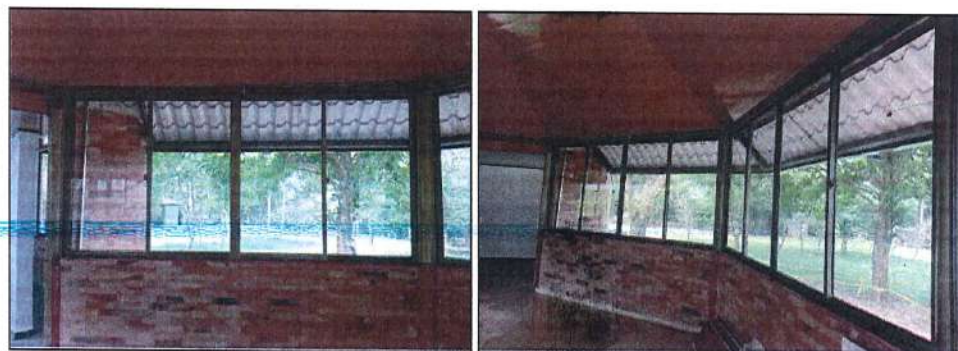
Imagen 83. Instalación de ventanas corredizas en aluminio - Estéreo.
