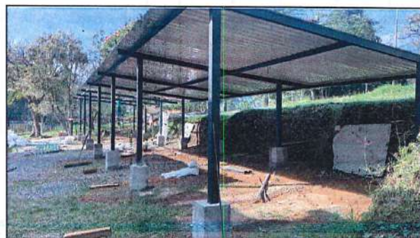
Imagen 4. Terminación de parqueadero de casas fiscales.
