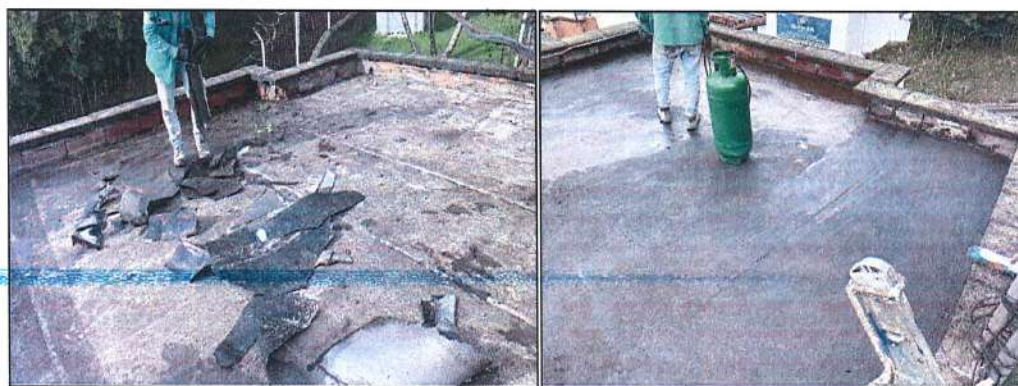
Imagen 33. Desmonte de manto asfáltico existente y limpieza.
