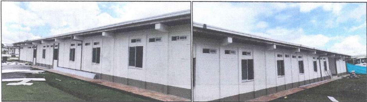
Imagen 115. Fachada, instalación de pintura exterior de alta calidad.
