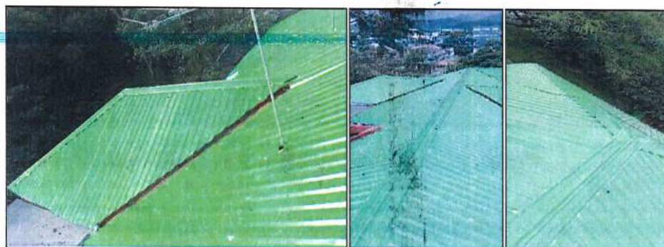
Imagen 85. Instalación de cubierta galvanizada y caballetes.
