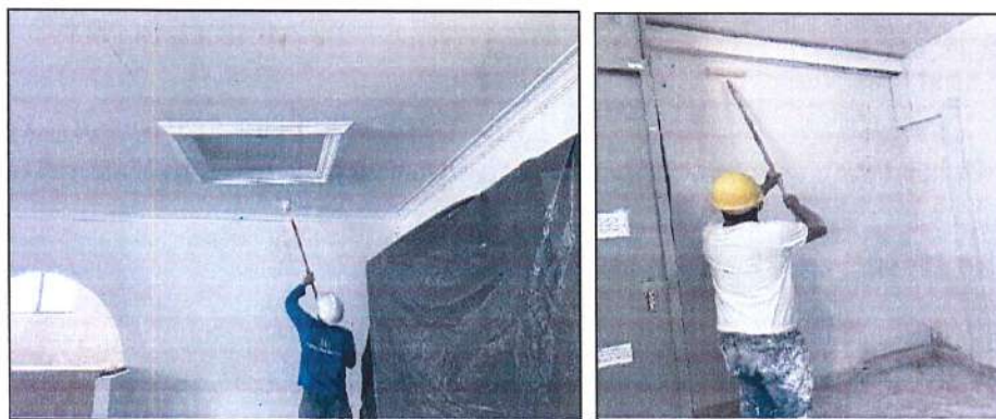
Imagen 12. Pintura interna de cuarto Armerillo.
