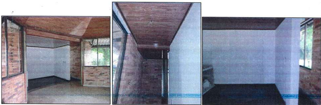
Imagen 82. Adecuación muros internos, estuco y pintura.
