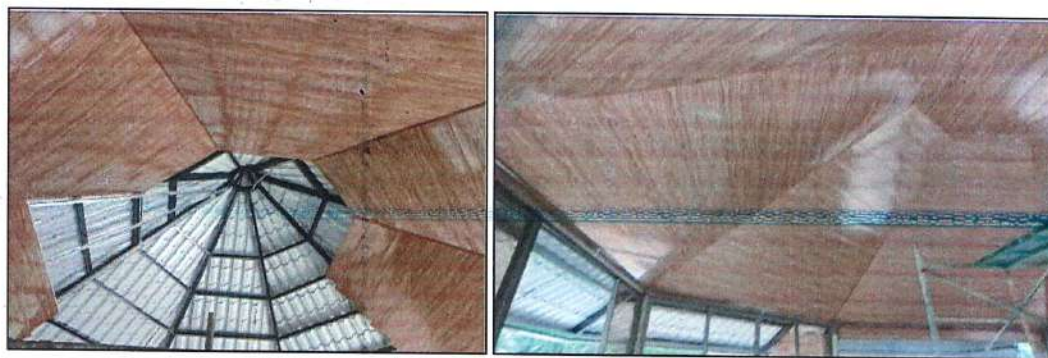
Imagen 75. Instalación de cielo raso en PVC - Estero. Diseño en profundidad.
