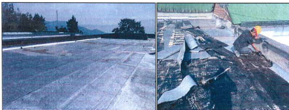
Imagen 5. Desmonte de manto asfáltico existente.
