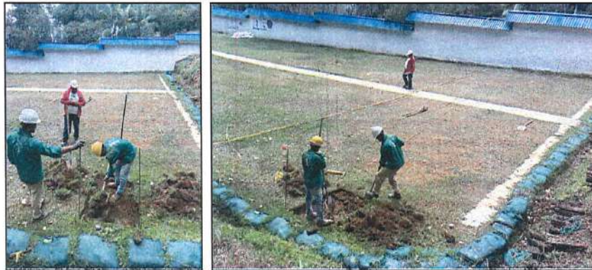
Imagen 16. Replanteo y excavación para instalación de Anden en concreto.
