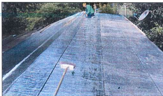
Imagen 51. Instalación de manto sobre tablilla de cubierta para protección de esta.
