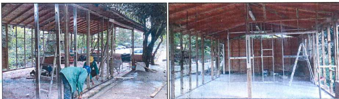
Imagen 44. Desmonte de externo e interno de muros, pisos y muebles de madera, entre otros.
