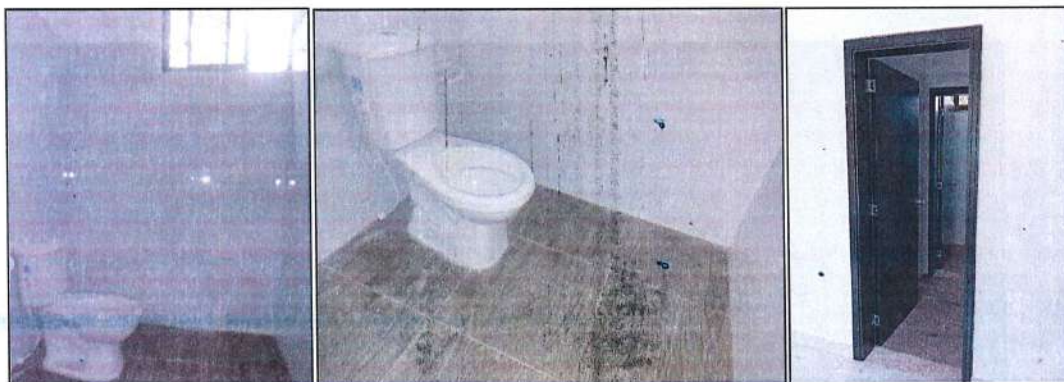
Imagen 60. Terminación de baños social y planeación.
