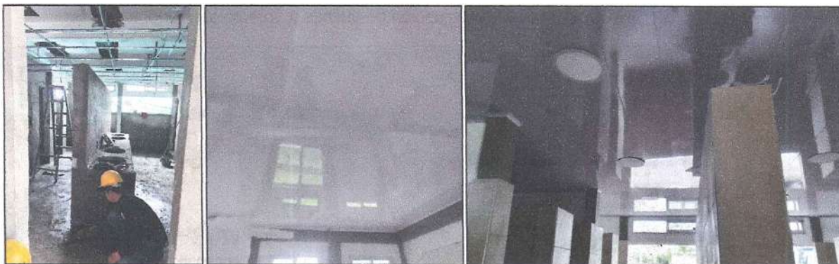
Imagen 107. Desmante de enchape y cielo raso - Instalación de cielo raso e iluminación.
