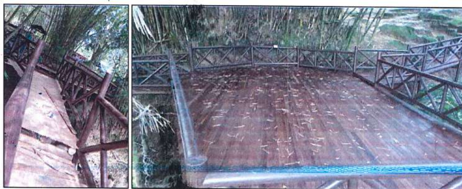
Imagen 31. Instalación de tablilla para piso en madera - >muelle.
