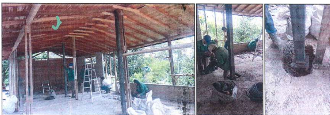
Imagen 50. Instalación de columnas en perfiles estructural para reforzamiento de cubierta.
