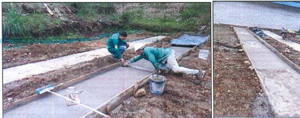
Imagen 17. Fundición de anden en concreto de 3000 PSI
