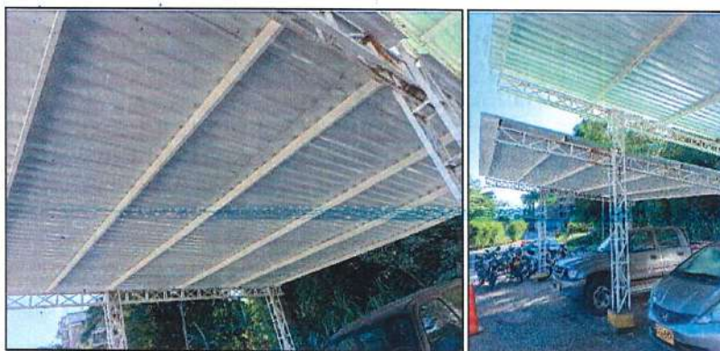
Imagen 99. Instalación de estructura metálica para cubierta e instalación de cubierta arquitectónica prepintada – Hangar parqueadero.
