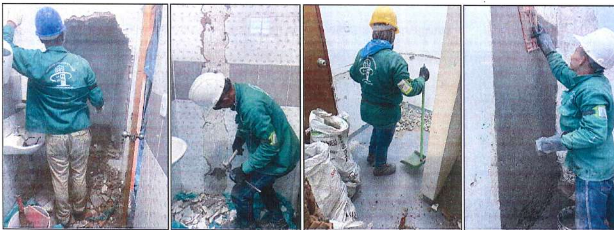
Imagen 11. Demolición de enchape y muro.
