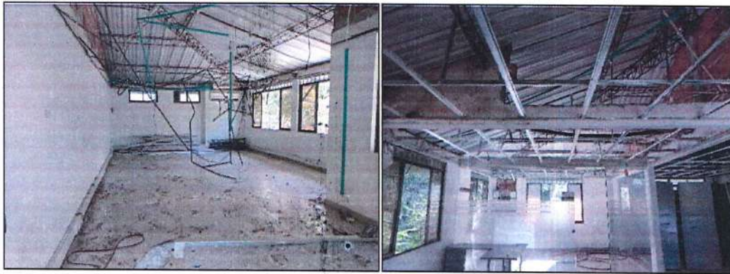
Imagen 68. Desmonte de luminarias y cielo raso existente.
