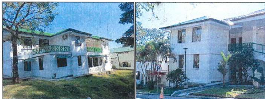
Imagen 89. Instalación de canal galvanizado y fachada casino de suboficiales.
