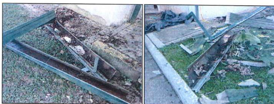
Imagen 88. Desmontes de canales galvanizados deteriorados.
