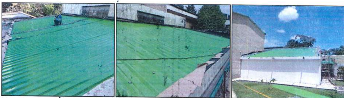
Imagen 64. Instalación de cubierta galvanizada prepintada en área administrativa.
