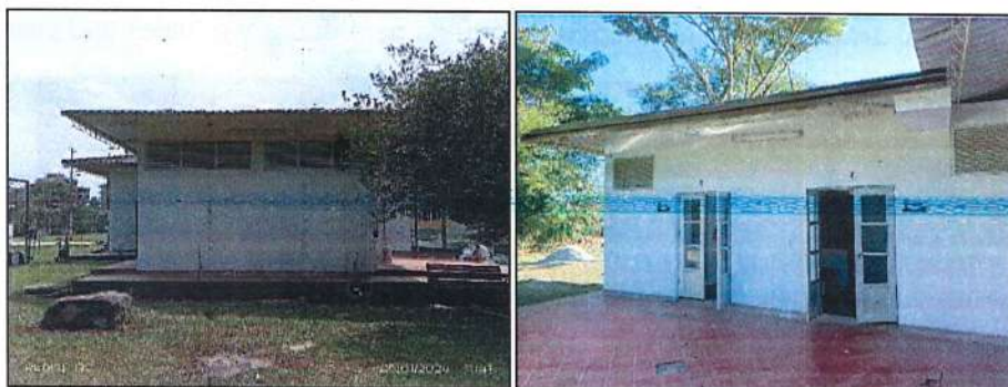
Imagen 94. Pintura externa de alta resistencia en fachada de baños.
