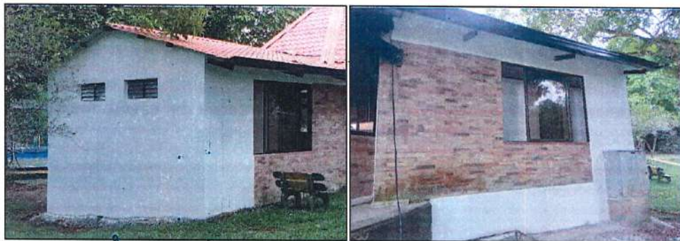
Imagen 81. Adecuación de muros externos, impermeabilización y pintura exterior.
