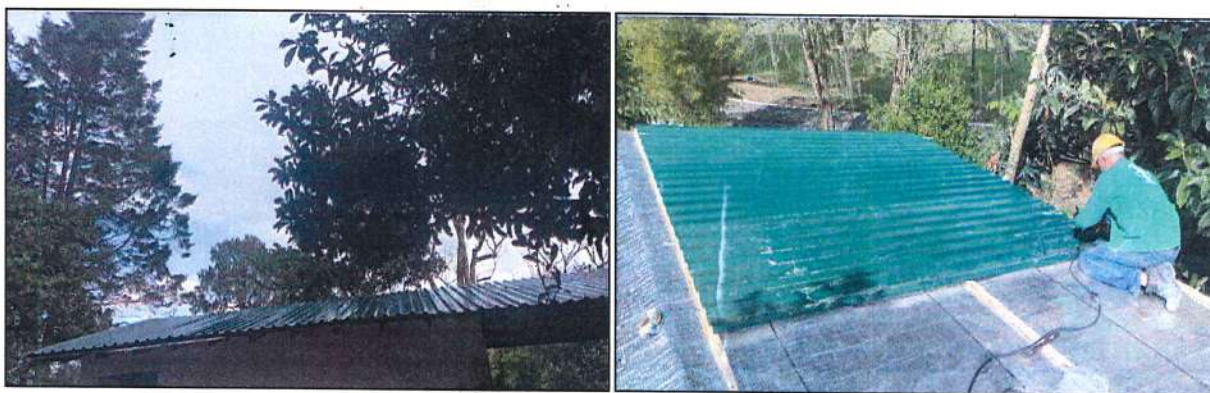
Imagen 52. instalación de cubierta en lámina galvanizada prepintada.
