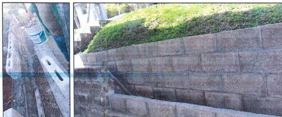
Imagen 39. Instalación de muro área de escaleras para protección del talud e impedir paso de agua lluvia.
