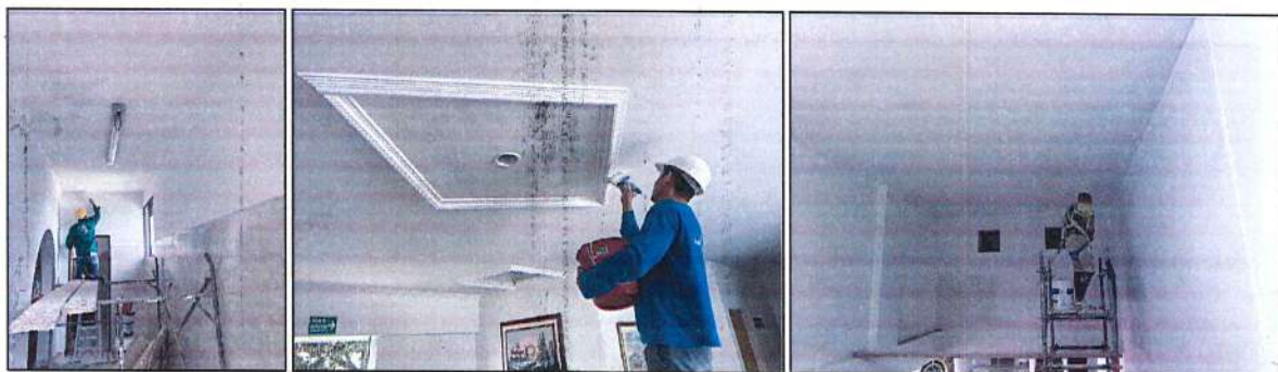
Imagen 10. Estuco y pintura interna de placa cubierta y muros.
