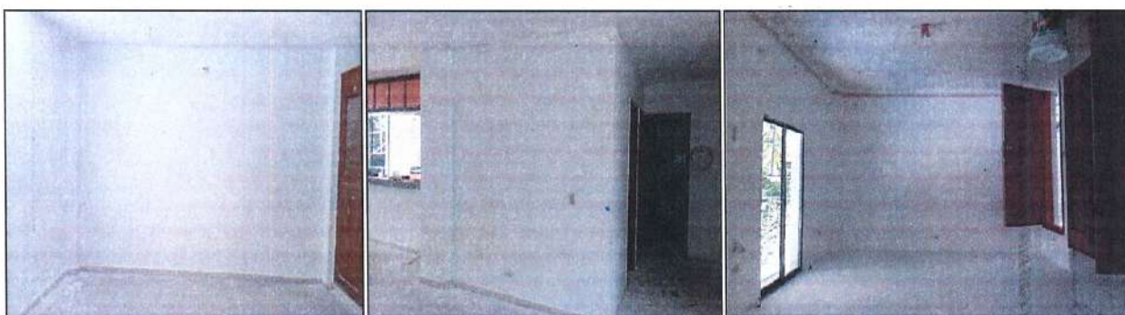
Imagen 91. Mantenimiento de muros interno, incluye estuco y pintura.
