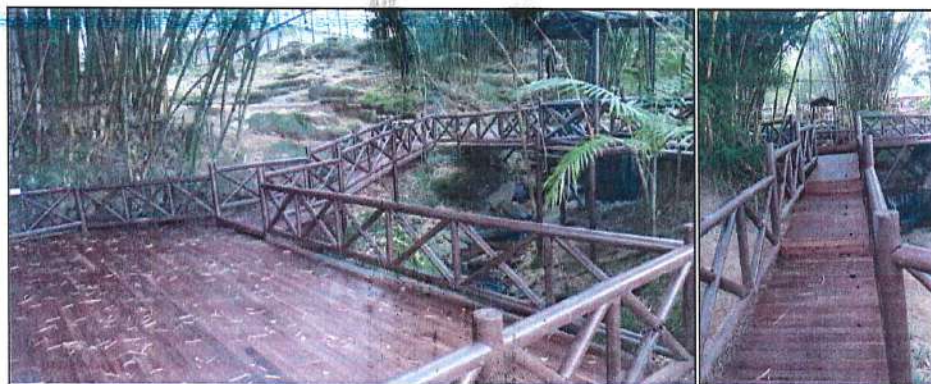
Imagen 32. Aplicación de inmunizante, tinte e impermeabilizante - terminación de acabado de muelle
