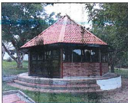
Imagen 78. Terminación de cubierta y canal galvanizado perimetral.
