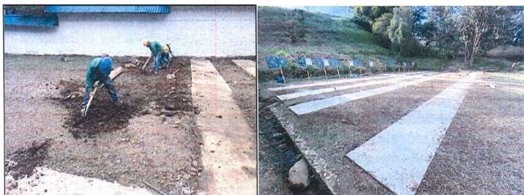
Imagen 18. Replanteo y excavación para continuación de fundición de anden.
