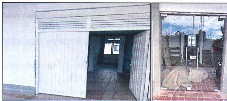
Imagen 102. Instalación de puerta principal del alojamiento.
