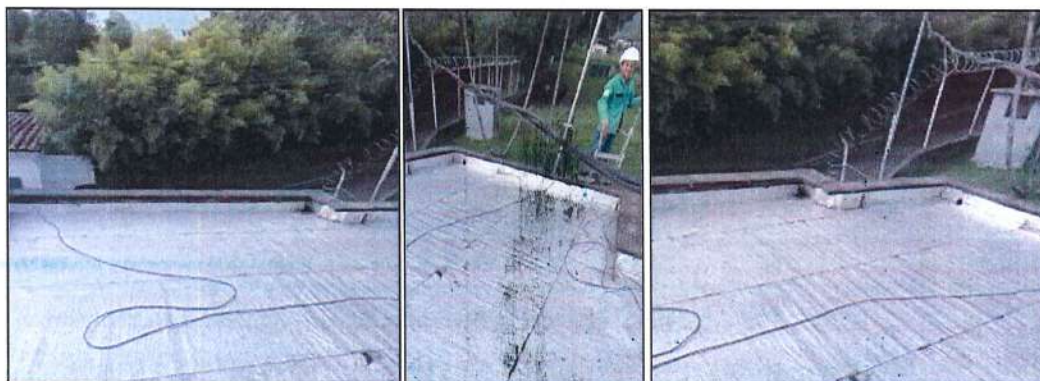
Imagen 34. Instalación de manto asfáltico.
