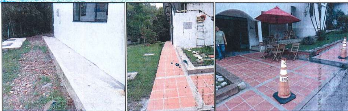
Imagen 71. Instalación de andén en concreto e instalación de piso en gres entrada de área académica.
