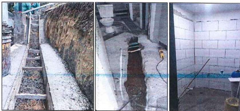
Imagen 35. Varios - Canal en concreto, tubería sanitaria de baño, enchape de baño.
