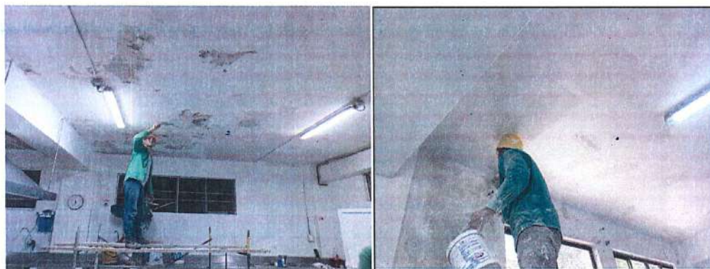
Imagen 27. Raspado de placa humedad, limpieza y aplicación de estuco.
