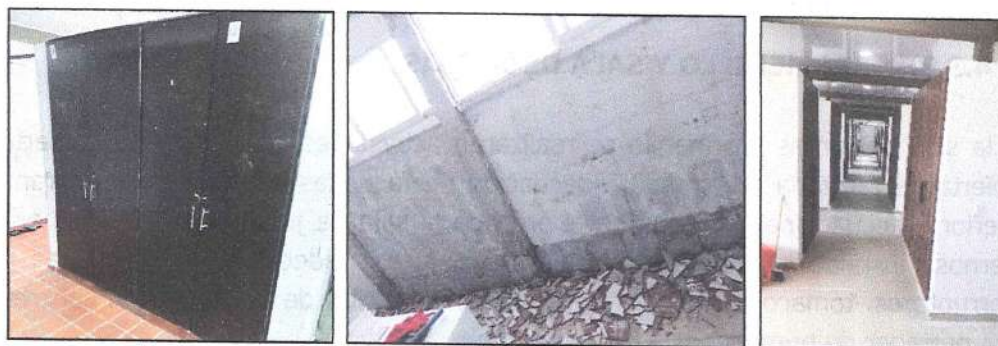
Imagen 112. Adecuación de alojamiento, instalación de closet.
