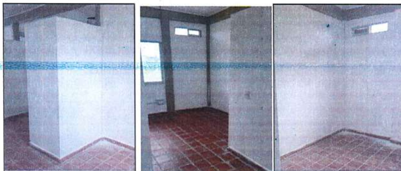
Imagen 103. Mejoramiento de acabado de muros internos. Instalación de estuco y pintura interna.
