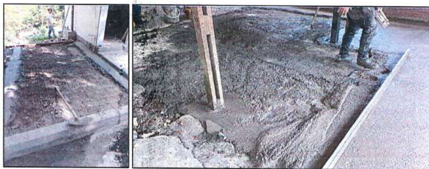
Imagen 47. Instalación de alistado de piso en cafetería.
