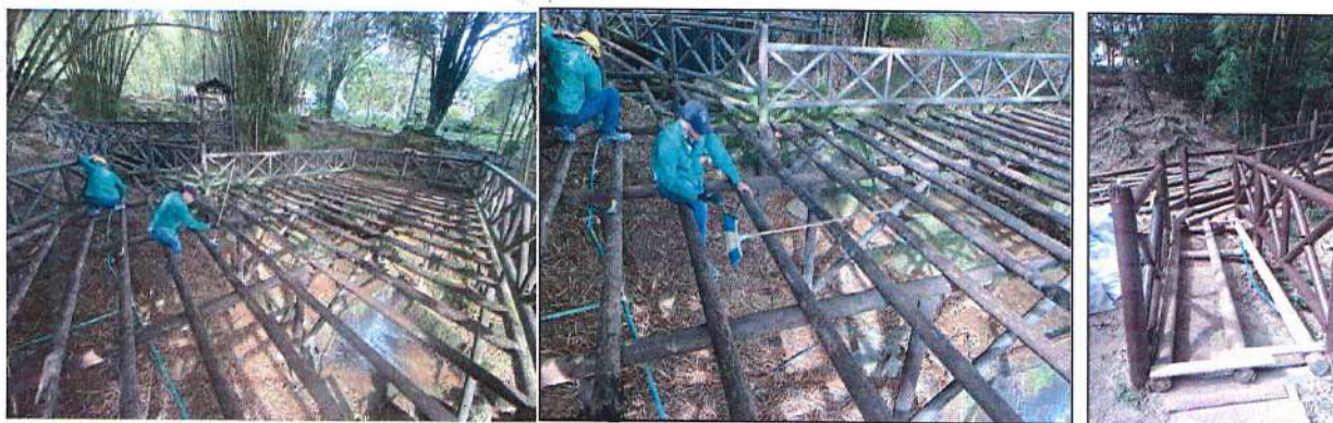
Imagen 30. Desmonte de piso en madera - Muelle
