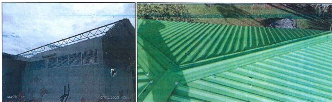
Imagen 92. Desmonte e instalación de cubierta galvanizada.
