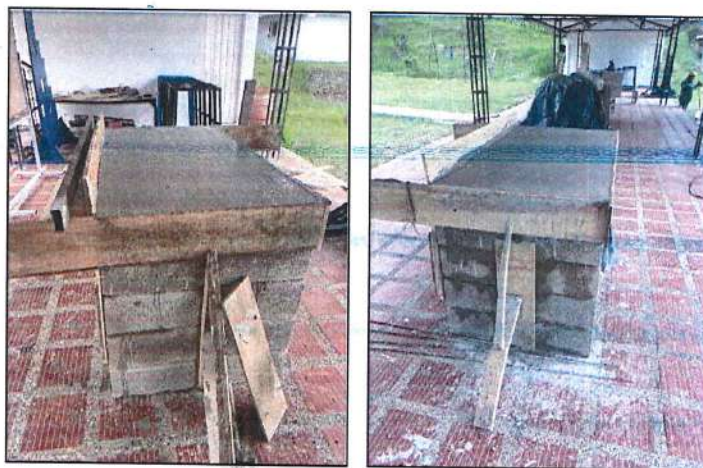
Imagen 20. Construcción de mesón en concreto área de polígono.
