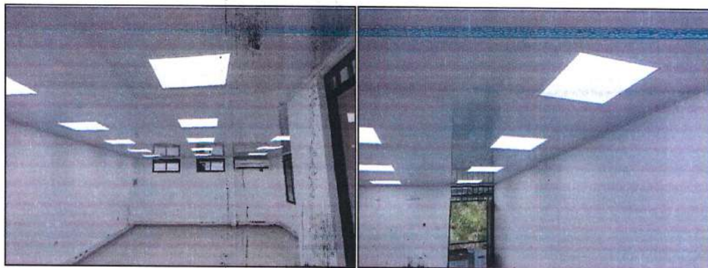
Imagen 69. Instalación de cielo raso en PVC y luminarias internas.
