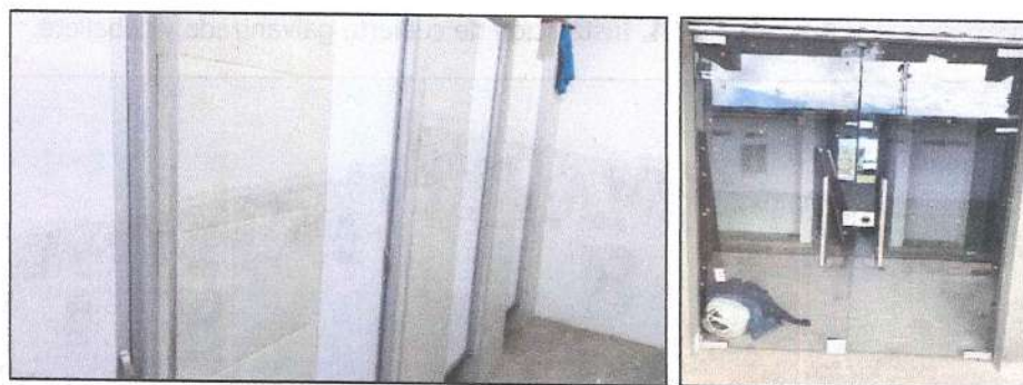
Imagen 111. instalación de puerta principal del alojamiento.
