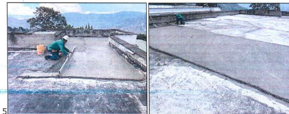
Imagen 6. Instalación de mortero impermeabilizado de 8 cm
