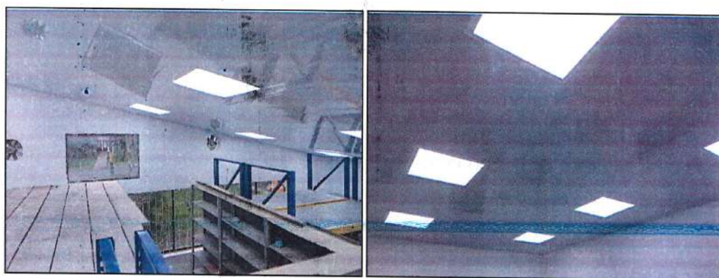
Imagen 65. Instalación de cielo raso en PVC y luminarias.
