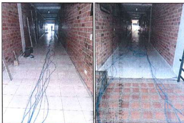
Imagen 56. Cable UTP 6A en cobre para redes de voz y datos.
