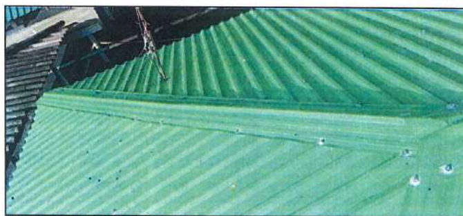
Imagen 93. Instalación de caballetes galvanizados prepintados.
