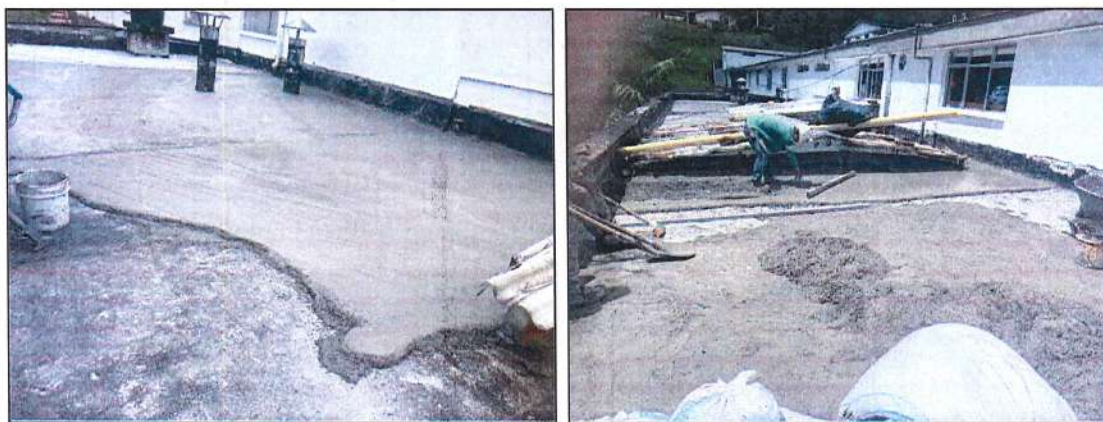
Imagen 23. Instalación de mortero impermeabilizado de 8cm de espesor.
