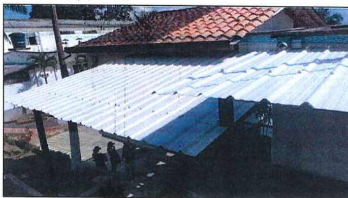
Imagen 37. Instalación de cubierta en acceso a Guardia
