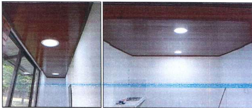
Imagen 80. Instalación de cielo raso en PVC pasillos y luminarias.
