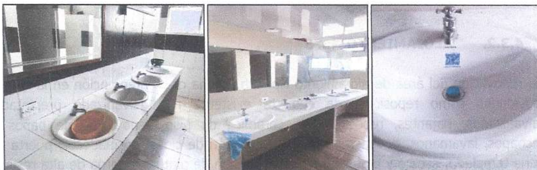
Imagen 108. Acabado de baño zona de lavamanos.
