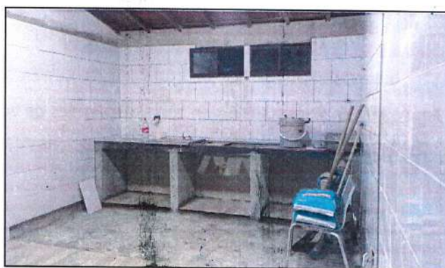
Imagen 54. instalación de enchape interno en cocina, mesones en concreto y ventanas.
