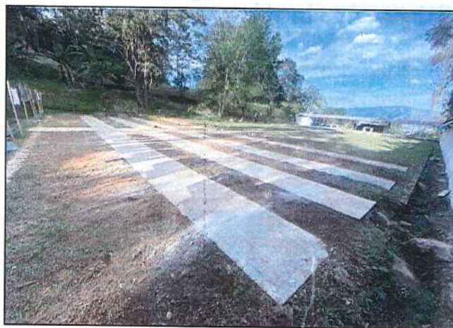
Imagen 19. Terminación de andén en concreto área polígono.
