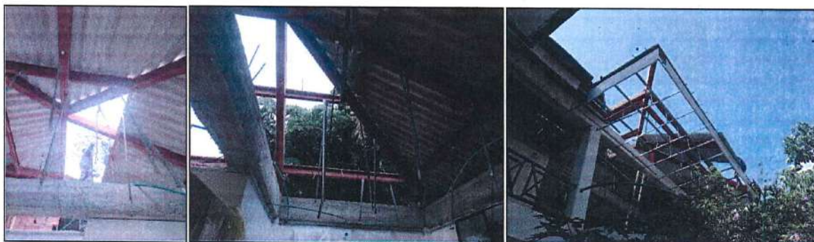
Imagen 84. Desmonte de cielo raso y cubierta existente.
