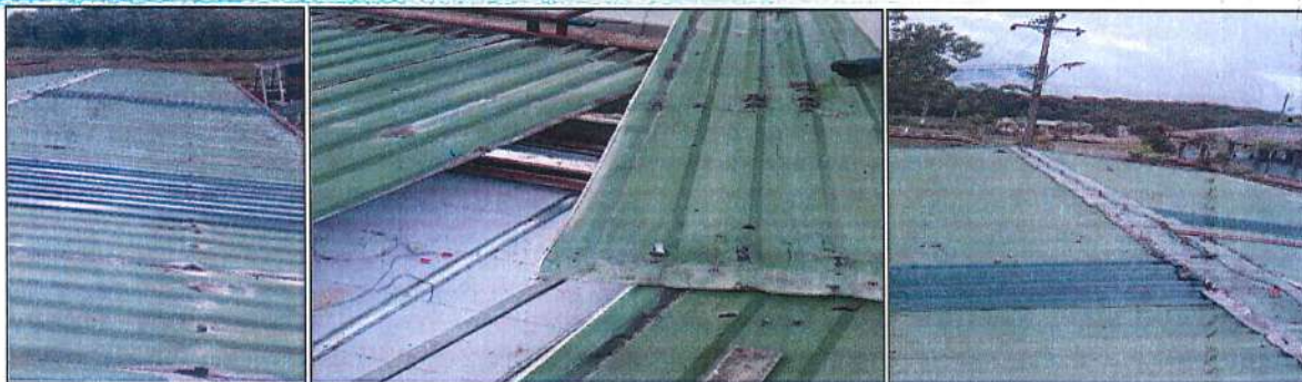
Imagen 101. Recorrido de cubierta, sellado de tornillería, cambio tejas en mal estado.
