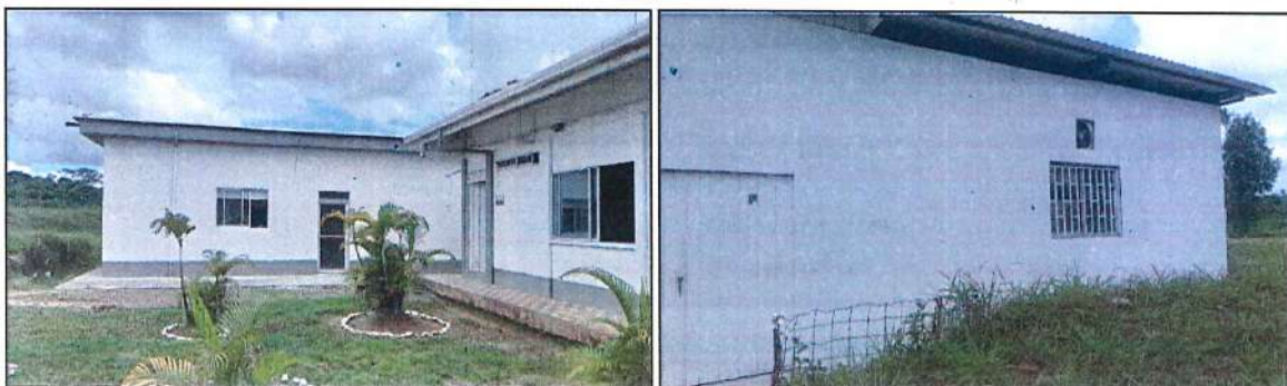
Imagen 120. Terminación de fachada de sala de juntas
