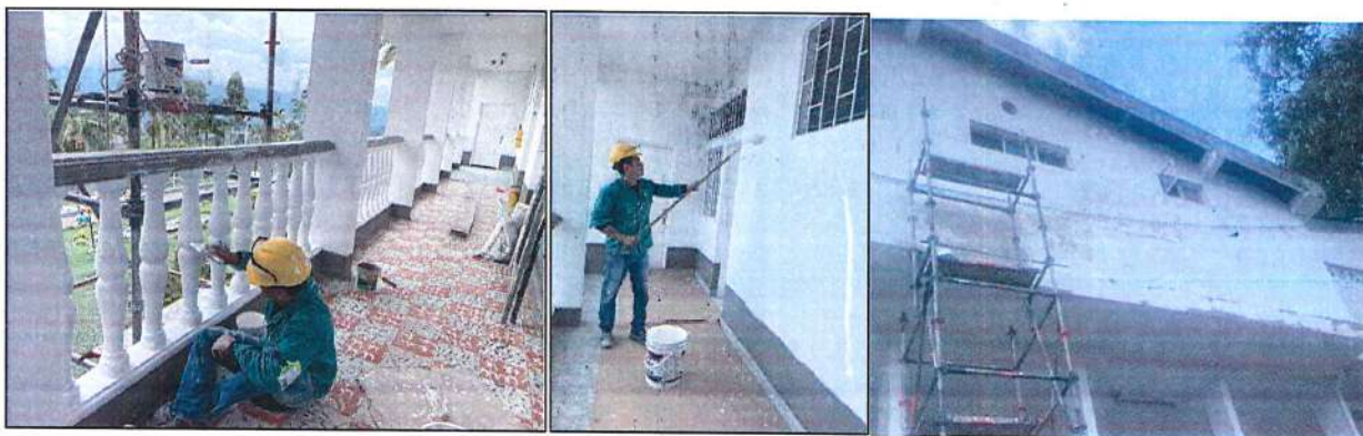
Imagen 14. Adecuación de muros exteriores de edificio Armerillo.
