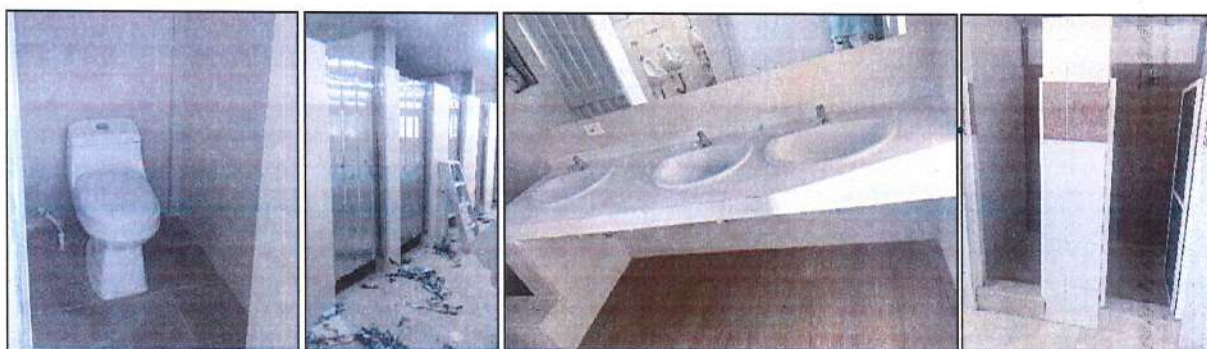
Imagen 122. terminación de baño de estudiantes. Reinstalación de puertas.
