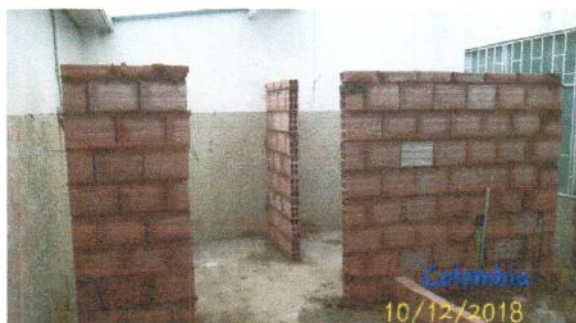
Foto 15: Construccion de mamposteria para dividir zonas
