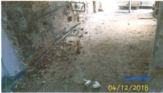
Foto 3: Demolicion y limpieza en la zona de neveras
