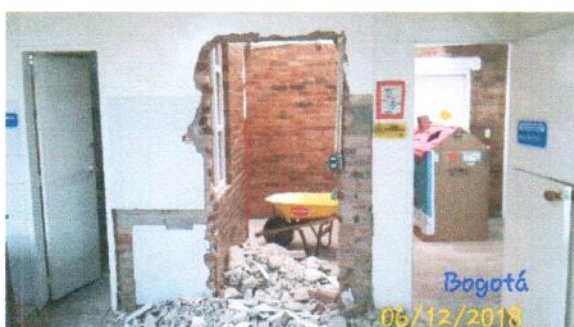
Foto 9: Demolicion de mamposteria para intalar puerta
