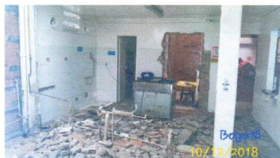
Foto 12: Retiro de ventana y recoleccion de parte de escombros
