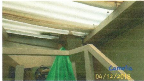
Foto 4: Se sugiere cambiar algunas tejas
