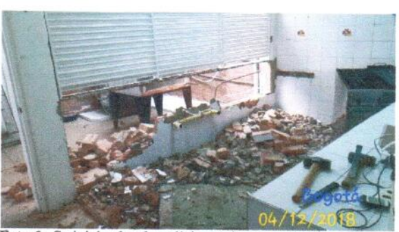
Foto 6: Se inician las demoliciones de mampostería
