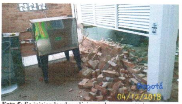
Foto 5: Se inician las demoliciones de mampostería
