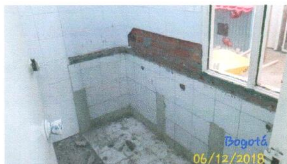
Foto 8: Demolicion de mcsones en concreto en despensa
