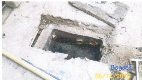
Foto 7: Se sondeo la red sanitaria y limpieza de caja sanitaria
