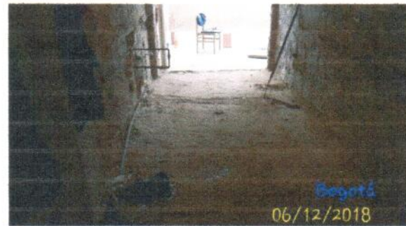
Foto 8: Aseo general de la obra y recoleccion de escombros
