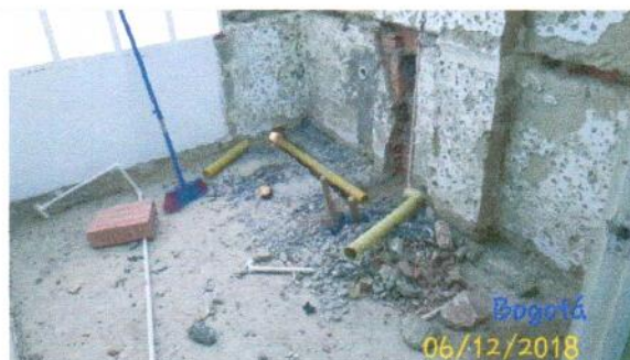
Foto 12: Demolicion en zona amiga y regatas para red sanitaria
