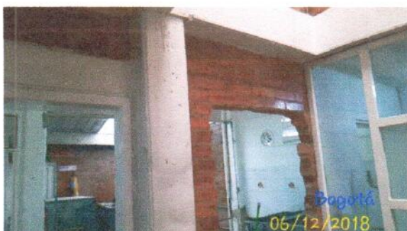
Foto 7: Se realizo la demolicion para puerta a instalar
