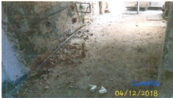
Foto 5: Demolicion y limpieza en la zona de neveras
