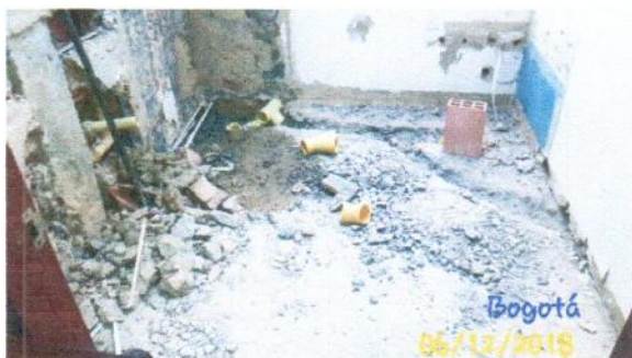
Foto 11: Demolicion en zona bañeras y regatas para red sanitaria
