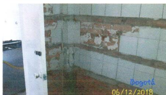
Foto 10: Demolicion de mesones en concreto en zona despensa
