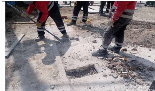
Fotografía N°15. PARQUE LISBOA. COD - 11-091. Se verifica por parte de Interventoría, la excavación de los dados de concreto para la instalación de las canchas prefabricadas M-31 en la zona de los biosaludables según las especificaciones del INSTITUTO DISTRITAL DE RECREACION Y DEPORTE (IDRD).
