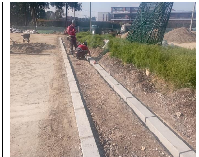
Fotografía N°5. PARQUE SABANA DE TIBABUYES. COD - II-246. Se verifica por parte de Interventoría ARQUITECTURA URBANA LTDA, el emboquille de los bordillos A-80 garantizando una junta máximo de 1.5 cm de acuerdo a las especificaciones técnicas del INSTITUTO DISTRITAL DE RECREACION Y DEPORTE (IDRD).
