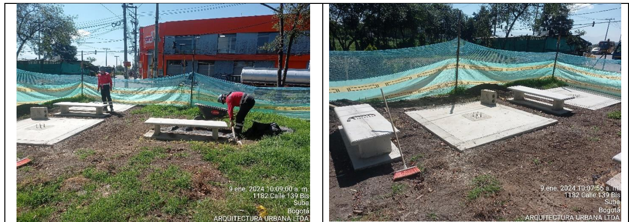
Fotografía N°19. PARQUE URB. PUERTA DEL SOL. COD – II-552. Se realiza jornada de orden y aseo por parte del CONSORCIO BOGOTÁ en la zona intervenida. Previamente se realizó la instalación de bancas de concreto M-31 sobre zona verde. Fotografía N°20. PARQUE URB. PUERTA DEL SOL. COD – II-552. Se realiza jornada de orden y aseo por parte del CONSORCIO BOGOTÁ en la zona intervenida. Previamente se realizó la instalación de bancas de concreto M-31 sobre zona verde.
