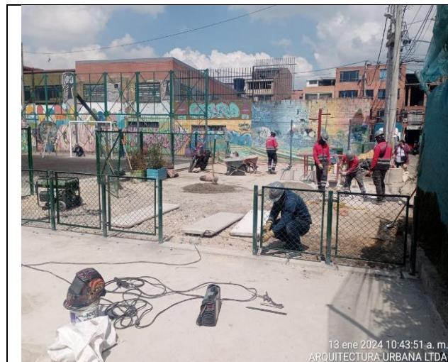
Fotografía N°11. PARQUE LISBOA. COD – II-091. Se verifica por parte de Interventoría ARQUITECTURA URBANA LTDA, la instalación de los módulos complementarios de la baranda M-83, módulos elaborados en malla eslabonada calibre 10 y con ángulos de 3/4" de acuerdo a las especificaciones técnicas del INSTITUTO DISTRITAL DE RECREACION Y DEPORTE (IDRD).
