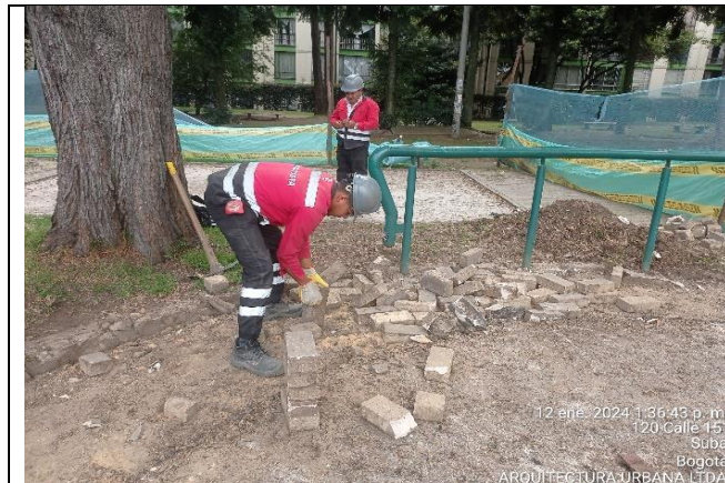
Fotografía N°27. PARQUE LAS FLORES. COD - II-677. Se verifica por parte de Interventoría ARQUITECTURA URBANA LTDA la actividad de desmonte de adoquín en concreto el cual se encontraba en una de las zonas de juegos infantiles.
