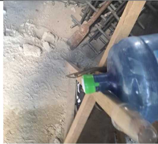
Fotografía N°4 PUNTO DE HIDRATACION PARQUE TIBABUYES – COD 111-246 Se verifica por parte de la Interventoría ARQUITECTURA URBANA LTDA que el consorcio Bogotá disponga de Punto de hidratación para el personal de obra.
