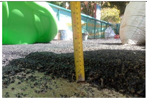
Fotografía N°24. PARQUE SOTAVENTO. COD – 11-965. Se verifica por parte de Interventoría ARQUITECTURA URBANA LTDA, el espesor de la capa de SBR instalada en la zona de seguridad del juego infantil el cual tiene una altura de caída de 1.4m, por lo que el espesor del SBR es de 4cm y 1cm de EPDM, como lo establecido en las especificaciones técnicas del IDRD.
