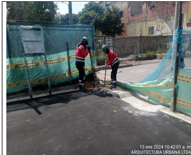
Fotografía N°9. PARQUE LISBOA. COD - II-091. Se verifica por parte de Interventoría ARQUITECTURA URBANA LTDA, la excavación de 0.20m X 0.20m X 0.60m de profundidad para la instalación de la estructura de la señal IDGS, la cual va embebida en un dado de concreto de 3000 psi de acuerdo a las especificaciones del INSTITUTO DISTRITAL DE RECREACION Y DEPORTE (IDRD).
