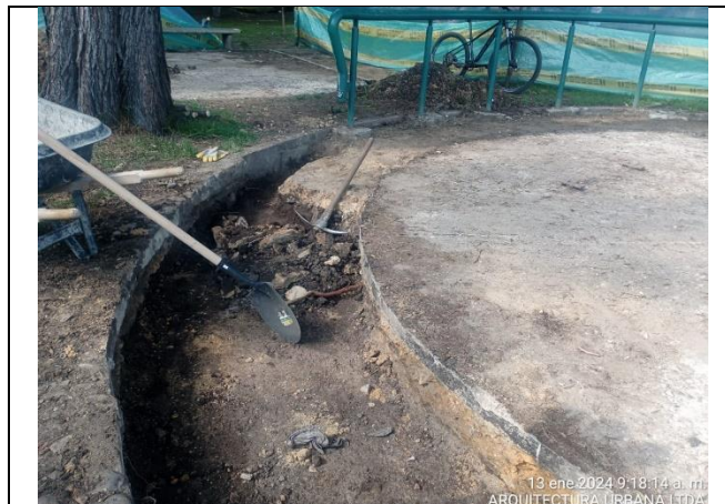
Fotografía N°29. PARQUE LAS FLORES. COD - II-677. Se verifica por parte de Interventoría ARQUITECTURA URBANA LTDA la actividad de excavación manual para la conformación de la estructura y construcción de la placa de contrapiso para la zona de juegos infantiles.
