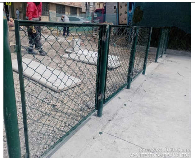
Fotografía N°12. PARQUE LISBOA. COD – II-091. Se verifica por parte de Interventoría ARQUITECTURA URBANA LTDA, la instalación de los módulos complementarios de la baranda M-83, utilizando soldadura E-6013 de acuerdo a las especificaciones técnicas del INSTITUTO DISTRITAL DE RECREACION Y DEPORTE (IDRD).
