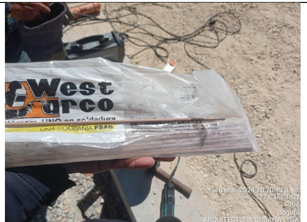
Fotografía N°8. PARQUE SABANA DE TIBABUYES. COD - II-246. Se verifica por parte de Interventoría ARQUITECTURA URBANA LTDA, los electrodos para la actividad de soldadura E-6013 el cual es usada en la instalación de parales principales de acuerdo a las especificaciones técnicas del INSTITUTO DISTRITAL DE RECREACION Y DEPORTE (IDRD).
