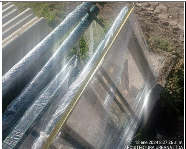
Fotografía N°6. PARQUE SABANA DE TIBABUYES. COD - II-246. Se verifica por parte de Interventoría ARQUITECTURA URBANA LTDA, las dimensiones de 60 cm x 70 cm de las señales IDGS dispuestas en obra para su posterior instalación en los diferentes parques.
