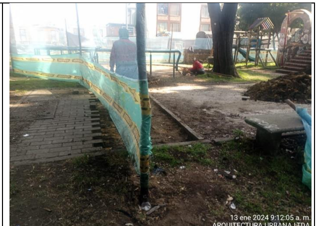
Fotografía N°30. PARQUE LAS FLORES. COD - II-677. Se verifica por parte de Interventoría ARQUITECTURA URBANA LTDA. El desmonte de adoquín existente para la ampliación de las placas y garantizar las áreas de seguridad de los juegos infantiles a instalar.
