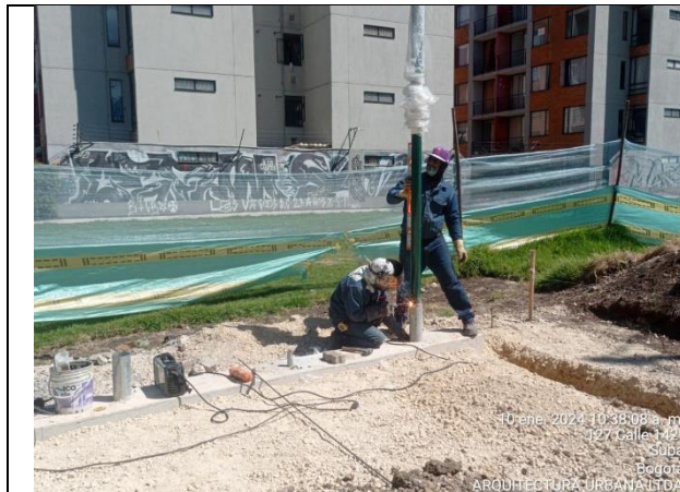
Fotografía N°7. PARQUE SABANA DE TIBABUYES. COD - II-246. Se verifica por parte de Interventoría ARQUITECTURA URBANA LTDA, la instalación y posterior soldada de tubería ASTM-A500 galvanizada 3" embebidas en camisas de diámetro 4" verificando los plomos de acuerdo a las especificaciones técnicas del INSTITUTO DISTRITAL DE RECREACION Y DEPORTE (IDRD).
