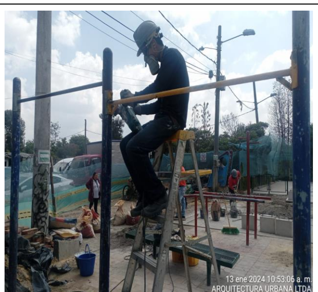
Fotografía N°14. PARQUE LISBOA. COD – II-091. Se verifica por parte de Interventoría ARQUITECTURA URBANA LTDA el mantenimiento de los elementos de la RUTA DE LA VIDA realizando previamente el lijado, posteriormente aplicación de anticorrosivo y finalmente la aplicación de pintura alquídica tipo esmalte para exteriores.
