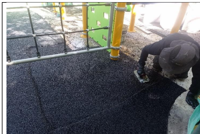
Fotografía N°25. PARQUE SOTAVENTO. COD – 11-965. Se verifica por parte de Interventoría ARQUITECTURA URBANA LTDA, la instalación de la capa de SBR (piso de caucho reciclado) en la zona de seguridad del juego y en la zona de transición de la zona infantil, como lo establecido en las especificaciones técnicas del INSTITUTO DISTRITAL DE RECREACION Y DEPORTE (IDRD).
