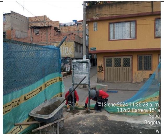
Fotografía N°10. PARQUE LISBOA. COD - II-091. Se verifica por parte de Interventoría ARQUITECTURA URBANA LTDA, la instalación de la señal IDGS, la cual va embebida en un dado de concreto de 3000 psi a 50 cm de acuerdo a las especificaciones técnicas del INSTITUTO DISTRITAL DE RECREACION Y DEPORTE.
