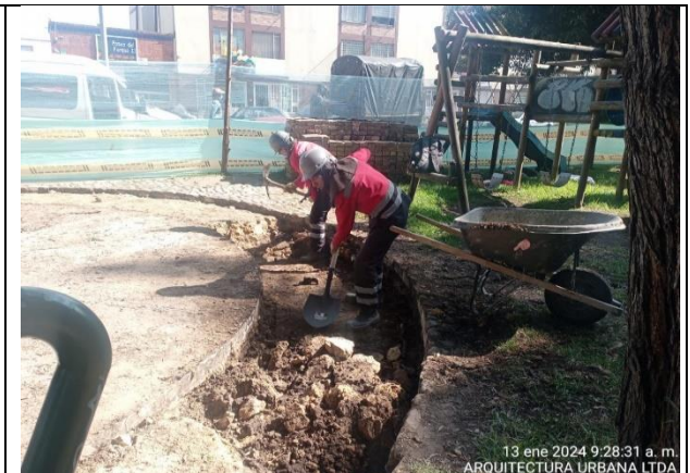
Fotografía N°28. PARQUE LAS FLORES. COD - II-677. Se verifica por parte de Interventoría ARQUITECTURA URBANA LTDA la actividad de excavación manual para la conformación de la estructura y construcción de la placa de contrapiso para la zona de juegos infantiles.
