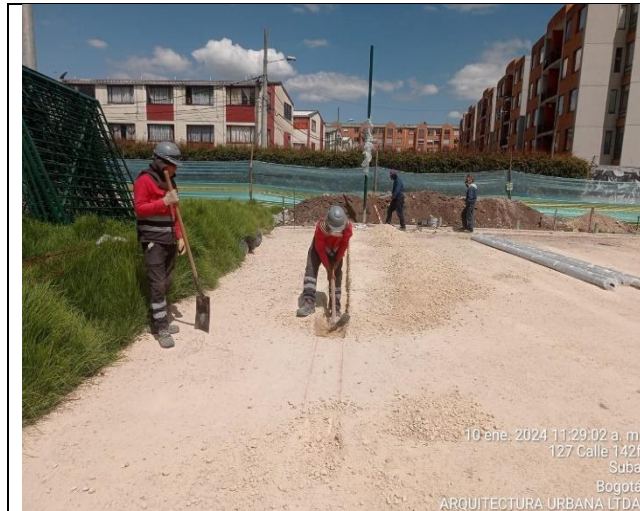
Fotografía N°3. PARQUE SABANA DE TIBABUYES. COD - II-246. Se verifica por parte de Interventoría ARQUITECTURA URBANA LTDA, el replanteo y posteriormente las excavaciones sobre la zona del atraque para la instalación de bordillo A-80, de acuerdo a las especificaciones técnicas del INSTITUTO DISTRITAL DE RECREACION Y DEPORTE (IDRD).
