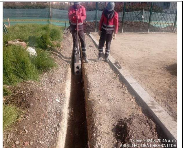
Fotografía N°4. PARQUE SABANA DE TIBABUYES. COD - II-246. Se verifica por parte de Interventoría ARQUITECTURA URBANA LTDA, la instalación de bordillo A-80, el cual va instalado sobre mortero de cemento y arena de río, de acuerdo a las especificaciones técnicas del INSTITUTO DISTRITAL DE RECREACION Y DEPORTE (IDRD).
