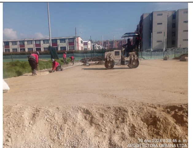
Fotografía N°2. PARQUE SABANA DE TIBABUYES. COD – II-246. Se verifica por parte de Interventoría ARQUITECTURA URBANA LTDA, la compactación con Vibrocompactador de la capa de 20cm de base granular tipo IDRD en la zona de la cancha de microfútbol de acuerdo a las especificaciones técnicas del INSTITUTO DISTRITAL DE RECREACION Y DEPORTE (IDRD).
