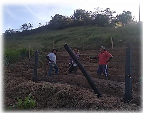
Juan Carlos Porras Zapata cc: 98534025 -3017571147 Coordenada: -75°13'16.572"; 6° 20'59.85"
