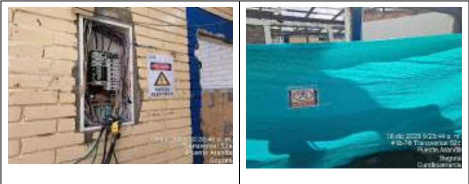
Fotografía 13. Señalización prohibitiva, de obligación y salvamento en obra IED Luis Carlos Galán
