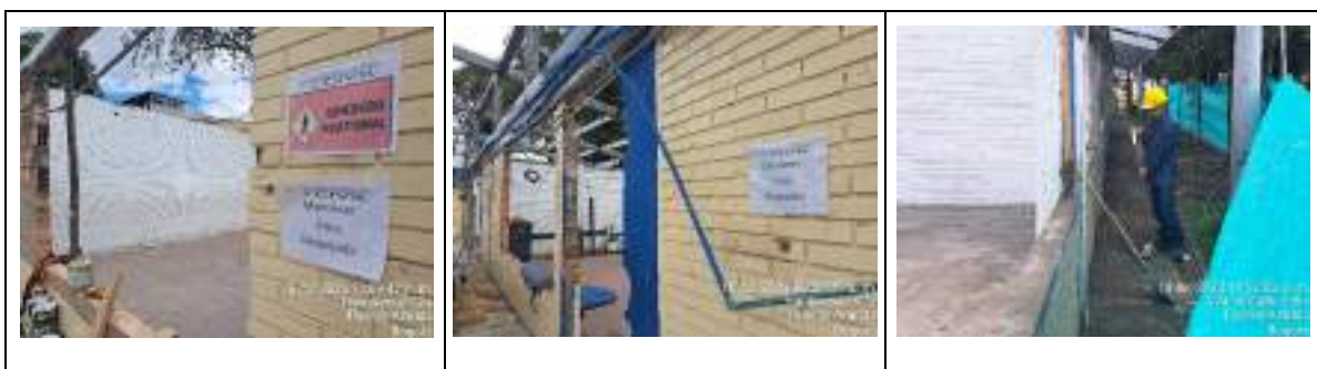
Fotografía 16. Señalización y áreas destinadas para la movilidad en obra IED Luis Carlos Galán
