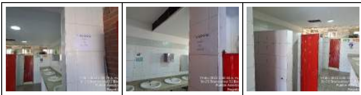
Fotografía 33. Batería de Baño IED Luis Carlos Galan
