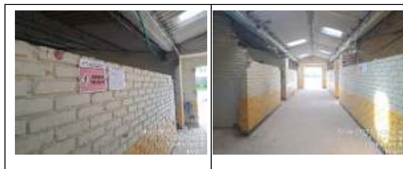
Fotografía 18. Señalización áreas destinadas para la movilidad en obra IED José Joaquín Casas
