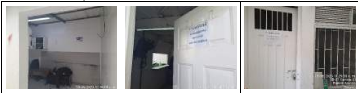
Fotografía 31. Instalaciones Provisionales IED Silveria Espinosa
