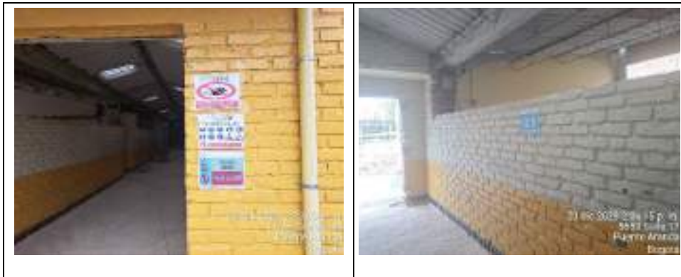
Fotografía 15. Señalización prohibitiva, de obligación y salvamento en obra IED José Joaquín Casas
