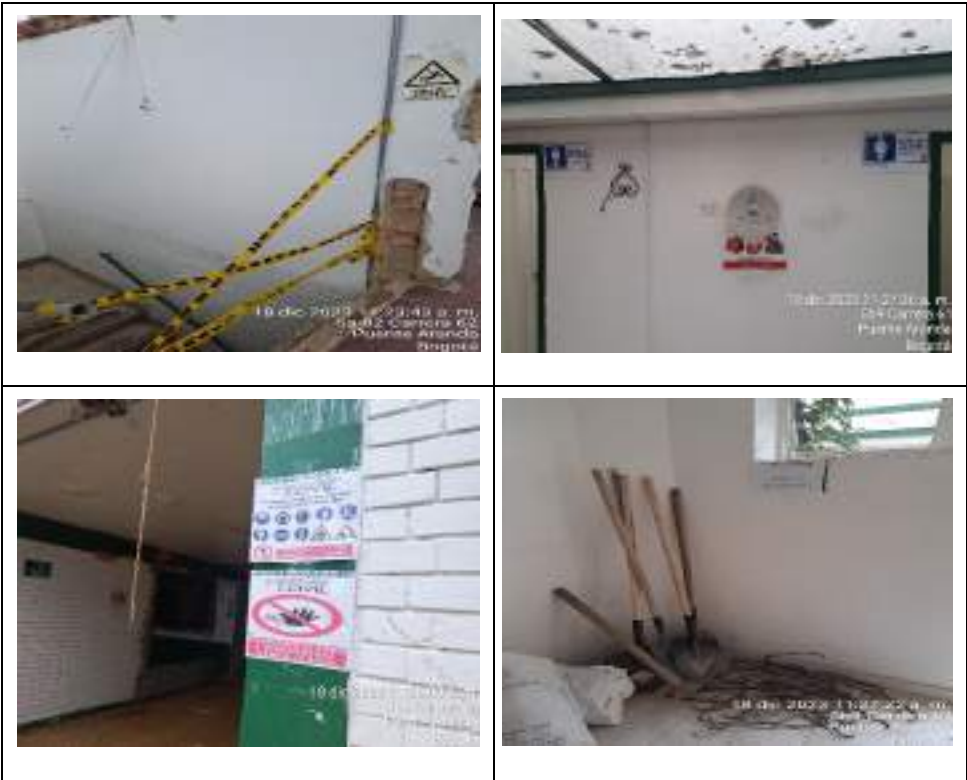
Fotografía 14. Señalización prohibitiva, de obligación y salvamento en obra IED Silveria Espinosa
