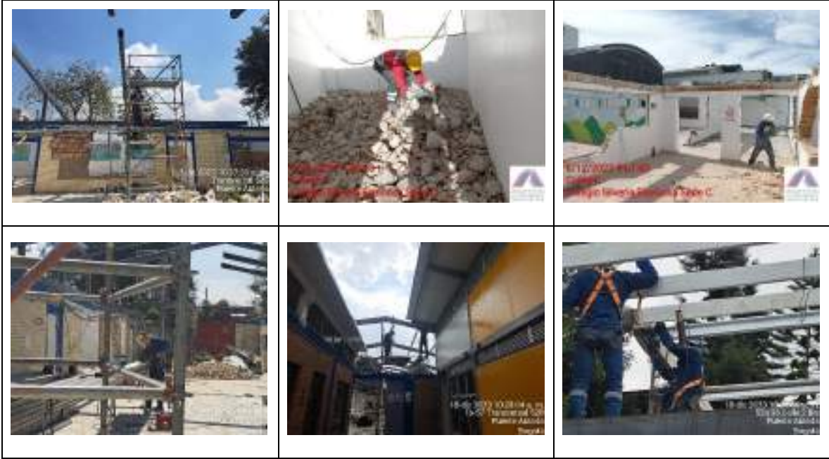
Fotografía 26. Actividades de alto riesgo en obra
