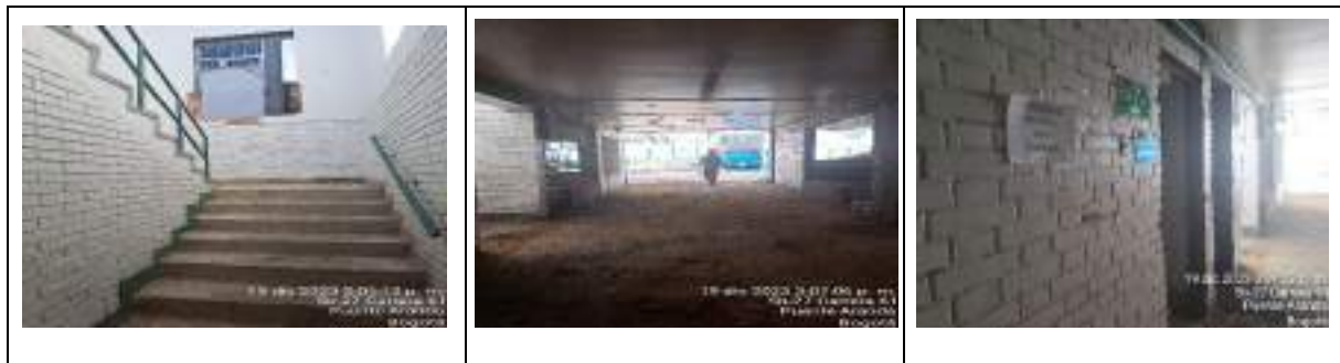
Fotografía 17. Señalización áreas destinadas para la movilidad en obra IED Silveria Espinosa
