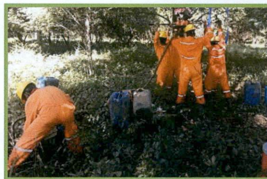
Fotografía 18. Inspección a cuadrilla de taladro.
