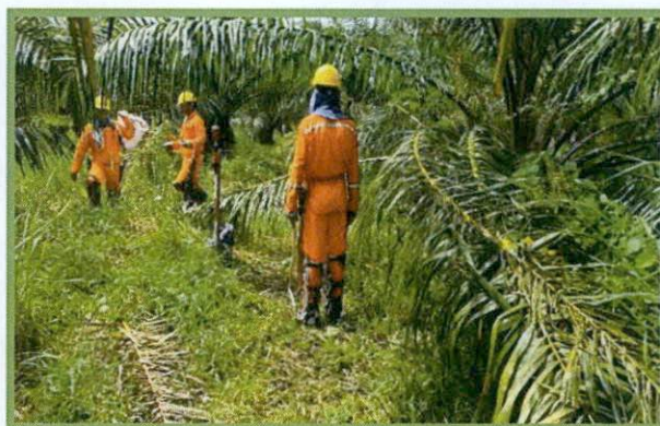
Fotografía 41. Acompañamiento a cuadrillas de topografía para validación de sp's.
