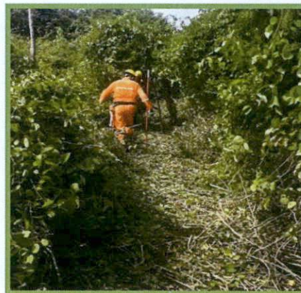
Fotografía 4. Trocha realizada por topografía.
