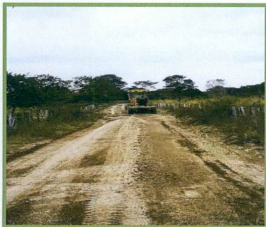
Fotografía 47. Adecuación de puntos críticos, vía Estación Villa-Nueva Idea.
