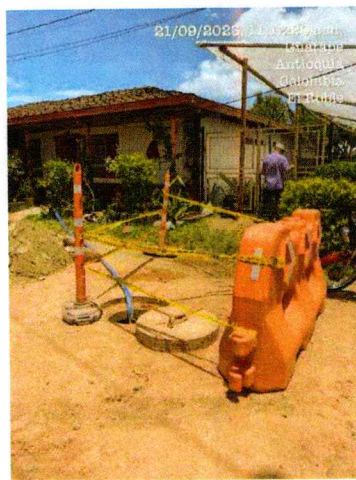
Foto 1 Cerramiento de la vía - 1
