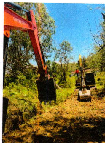
Foto 24 Conformación de la vía alterna – 2
