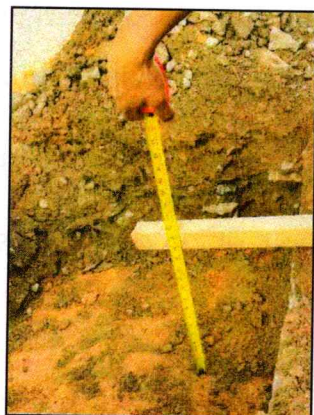
Foto 21 Relleno final con base – 1
