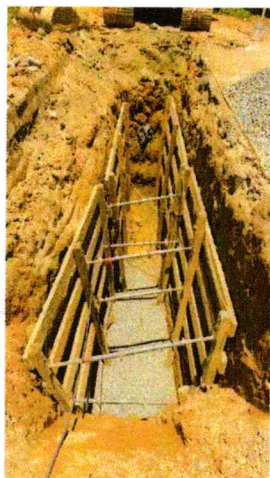
Foto 13 Encamado con triturado - 1
