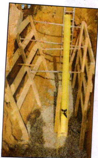
Foto 18 Atraque de tubería con triturado
