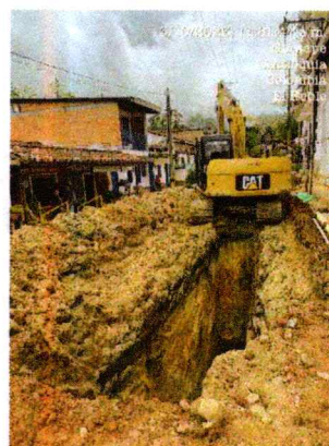
Foto 9 Excavación de tierras - 3
