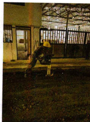
Foto 22 Relleno final con base – 2
