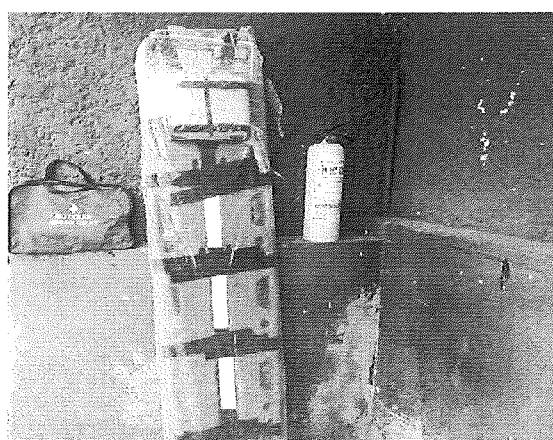
Foto 1. Camilla y Botiquín de primeros Auxilios instalado y dotado en caso de emergencia.
