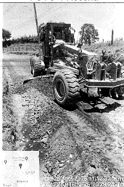
FOTO 6 Conformación de la calzada
