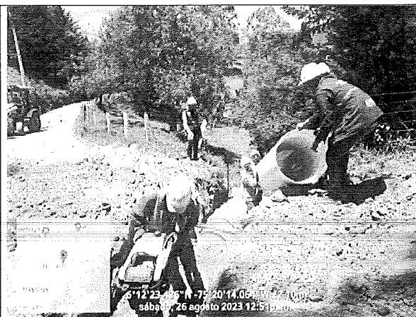
FOTO 78 Instalación de tubería
