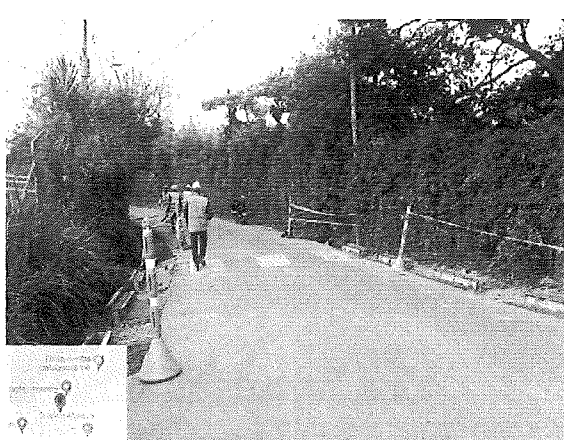
Foto 2. Señalización en obra.
