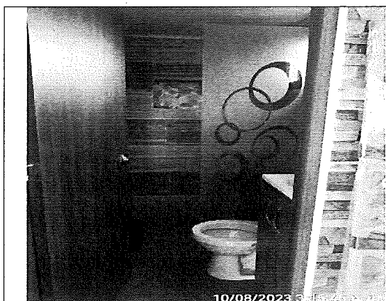
FOTO 57 Se evidencia baños en el campamento
