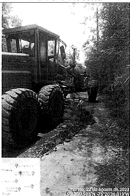
FOTO 5 Conformación de la calzada
