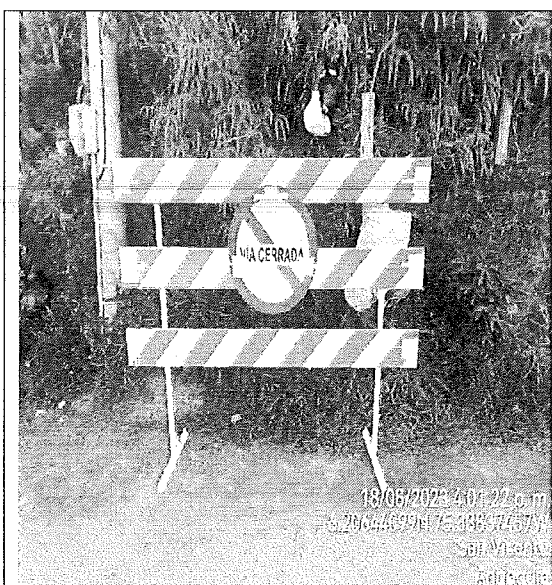
FOTO 70 Se evidencia frente de obra señalizado y demarcado.
