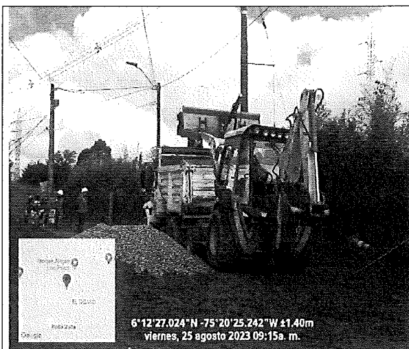
FOTO 75 Nivelación de terreno
