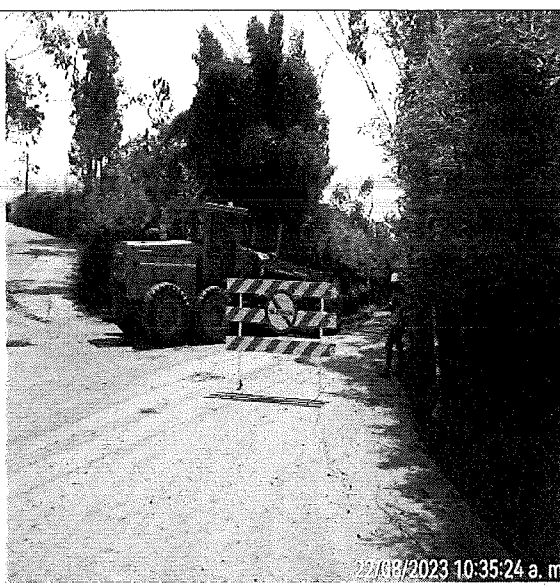
FOTO 71 Frente de obra señalizado y demarcado.
